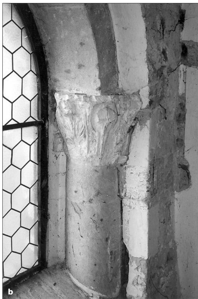
Obr. 26: Záboří nad Labem, kostel sv. Prokopa: a – průčelí kostela, pravá strana. Šipka označuje místo, kde je uvnitř hlavice (stav v roce 2002); b – okení hlavice uvnitř kostela. Kalich hlavice není půlkulatý, ale pouze čtvrtinový (stav v roce 2002); c – otvor v cihelném zdivu pro stahovací táhlo na zavěšování boků archivoly u pravého okna průčelí. Vzádu viditelná kamenná ploška, která je boční stranou čtvrtinové románské hlavice (stav v roce 2004).
