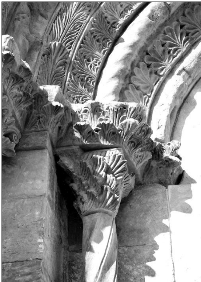
Obr. 17: Záboří nad Labem, kostel sv. Prokopa. Levá vnitřní hlavice sloupu. Uprostřed kalichu hlavice viditelné zářezy, které zvyšují její plasticitu. Viditelné jsou hluboké prořezávané rýhy v akantových listech (stav po restaurování v roce 2005).
