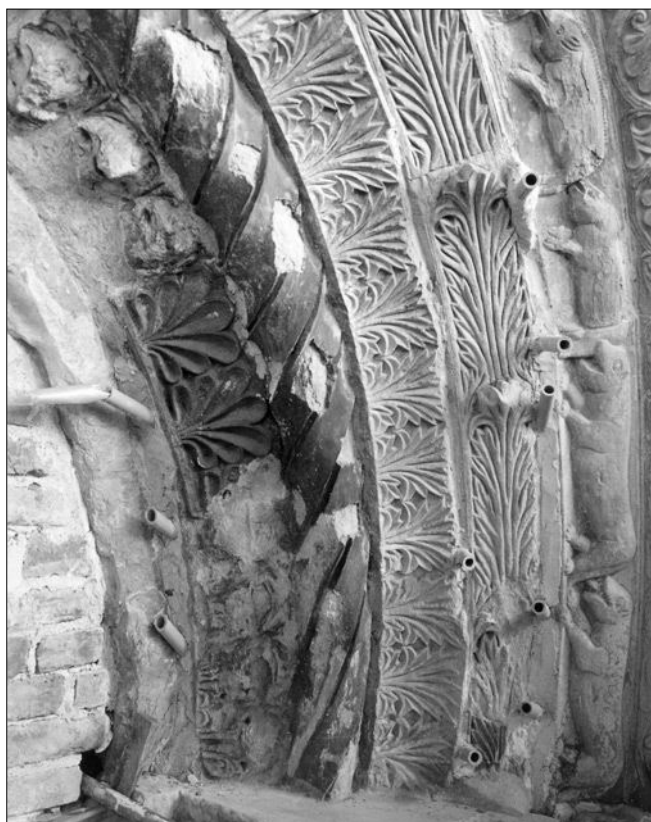
Obr. 9: Záboreň nad Labem, kostel sv. Prokopa. Pravá strana archivoly, stav během restaurování v roce 2003. Částečná plastická retuš. Ve spárách zatmelené trubky pro hloubkové injektování.
