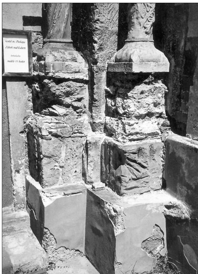
Obr. 20: Zábोří nad Labem, kostel sv. Prokopa. Pravá spodní část portálu. Pod patkami sloupů fragmenty plastické výzdoby soklů (stav před restaurováním v roce 2002).
