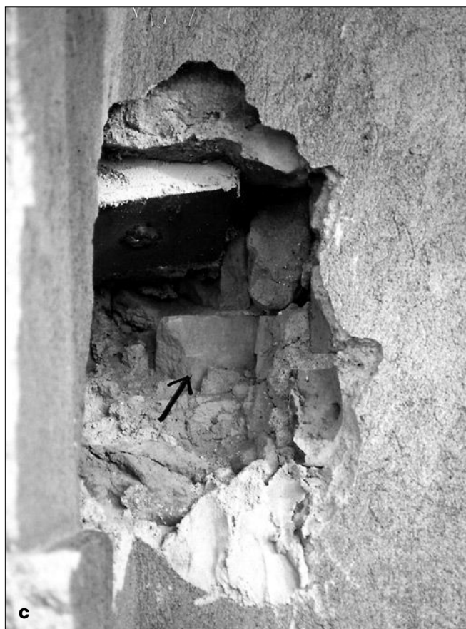
Obr. 26: Záboří nad Labem, kostel sv. Prokopa: a – průčelí kostela, pravá strana. Šipka označuje místo, kde je uvnitř hlavice (stav v roce 2002); b – okení hlavice uvnitř kostela. Kalich hlavice není půlkulatý, ale pouze čtvrtinový (stav v roce 2002); c – otvor v cihelném zdivu pro stahovací táhlo na zavěšování boků archivoly u pravého okna průčelí. Vzádu viditelná kamenná ploška, která je boční stranou čtvrtinové románské hlavice (stav v roce 2004).
