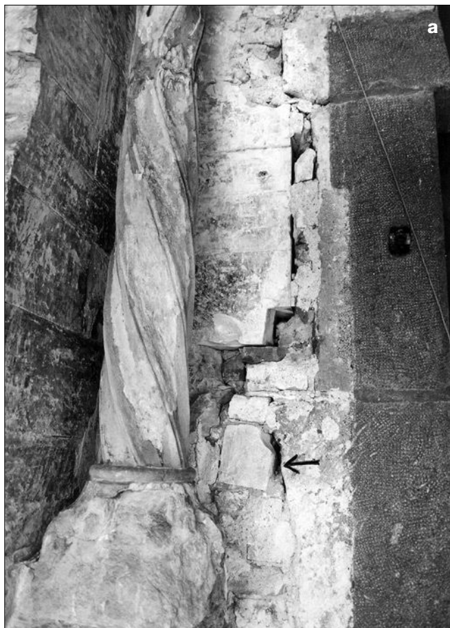
Obr. 19: Zábोří nad Labem, kostel sv. Prokopa: a – levá střední část portálu. Fragment kvádříku s narysovanou konstrukcí kružnic (stav po sejmutí druhotných omítek v roce 2002); b – část kvádříku s fragmentem vyryté konstrukce kružnic (stav před opětujícím osazením v roce 2003).
