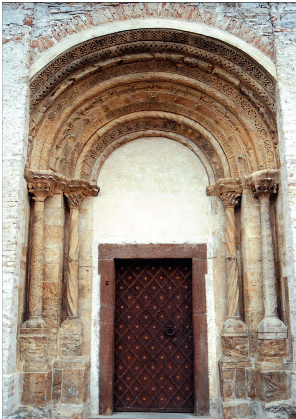
Obr. 3: Zábřeh nad Labem, kostel sv. Prokopa. Stav románského portálu po dokončení restaurování v roce 2005.
