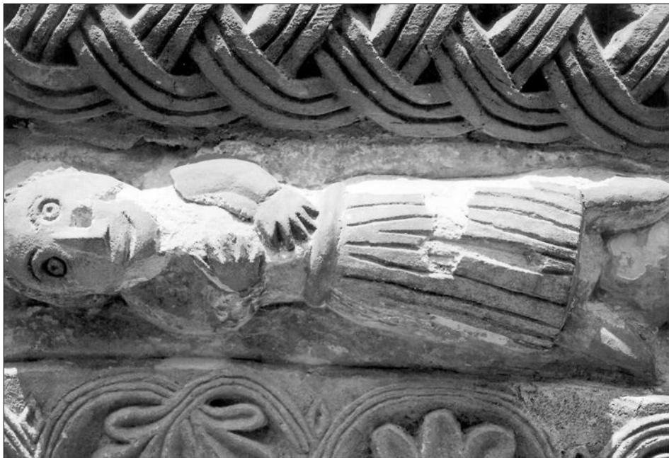
Obr. 10: Zábory nad Labem, kostel sv. Prokopa. Horní část archivoly uprostřed, mužská postava v dlouhém šatě. Průzkumové sondy v druhotné cementové povrchové krustě (stav v roce 2004).
