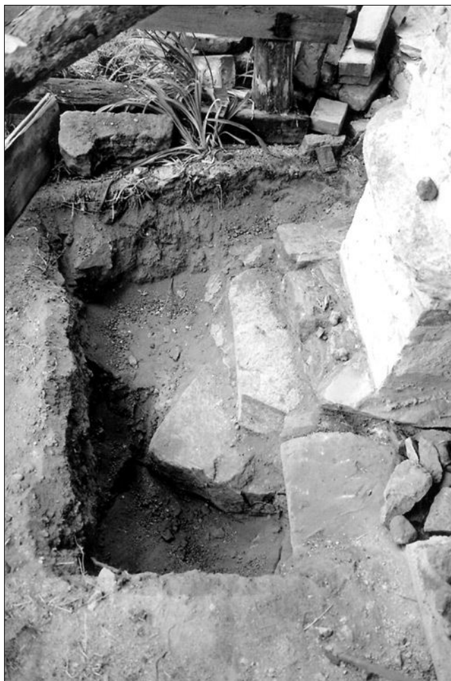
Obr. 23: Záboří nad Labem, kostel sv. Prokopa. Až předimenzovaný základ pod levou stranou portálu (archeologická sonda v roce 2003).
