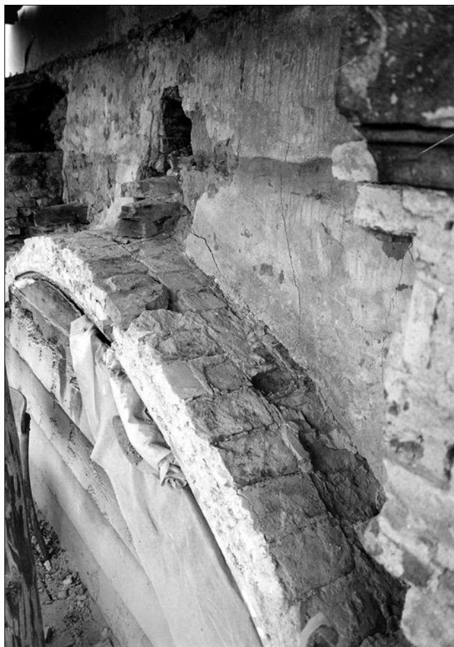
Obr. 14: Záborech nad Labem, kostel sv. Prokopa. Horní plocha portálu během dočasného odhalení při rekonstrukci druhotného zdiva (stav v roce 2004).
