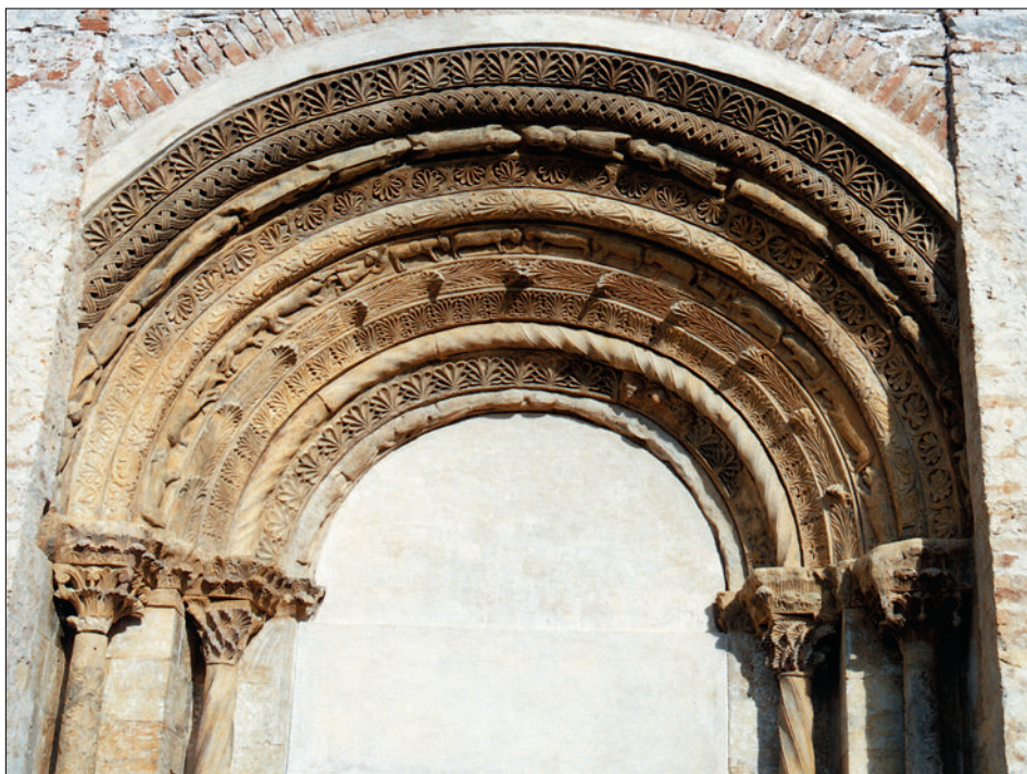
Obr. 5: Záboří nad Labem, kostel sv. Prokopa. Stav archivoly po dokončení restaurování v roce 2005.
