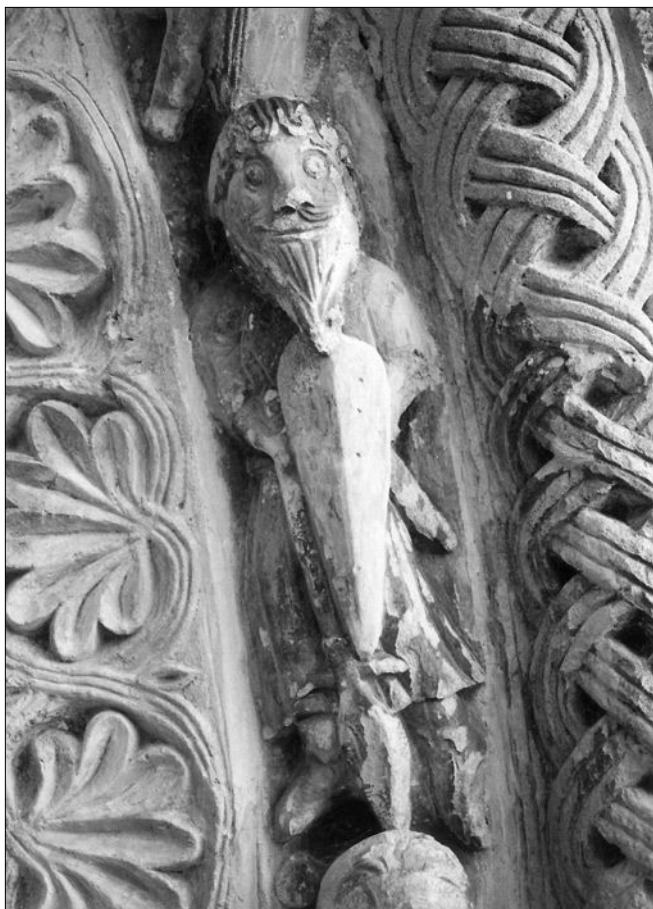
Obr. 11: Zábory nad Labem, kostel sv. Prokopa. Pravá část archivoly, postava ozbrojence, na pletenci vpravo viditelné druhotné doplňky z betonu (stav během restaurování v roce 2005).
