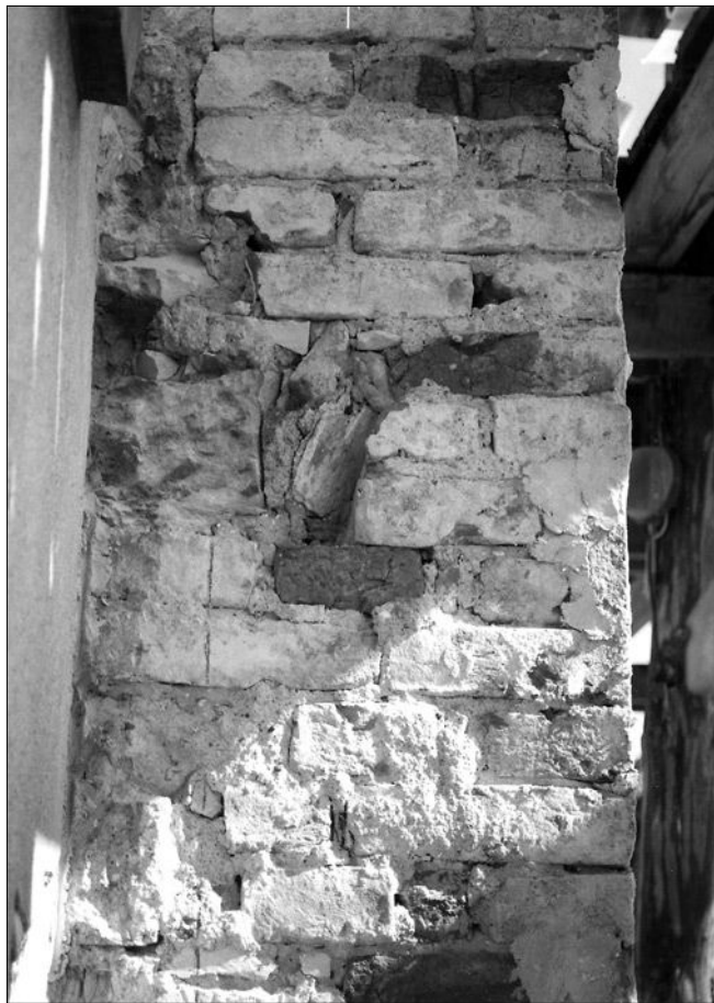
Obr. 18: Záboří nad Labem, kostel sv. Prokopa. Fragment hlavice levého vnějšího sloupku zachovalý v druhotném cihelném pilíři (stav během restaurování v roce 2004).
