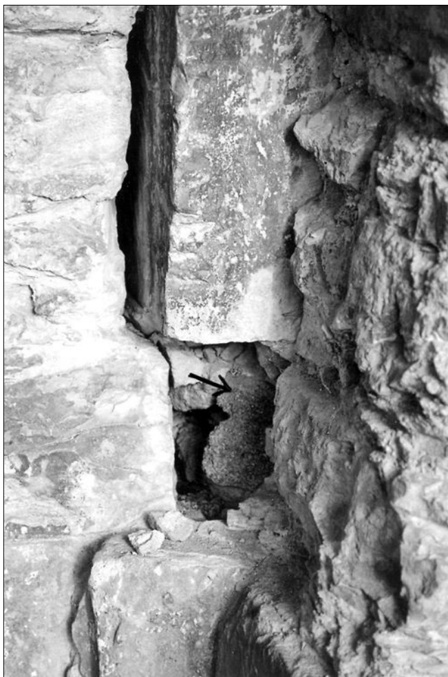
Obr. 22: Záboří nad Labem, kostel sv. Prokopa. Pravá spodní část portálu, stav zdiva po vyčištění spár v roce 2003. V otvoru uvnitř zdiva červený pískovec, ze kterého jsou sloupky arkádových oken, vpravo siréna.
