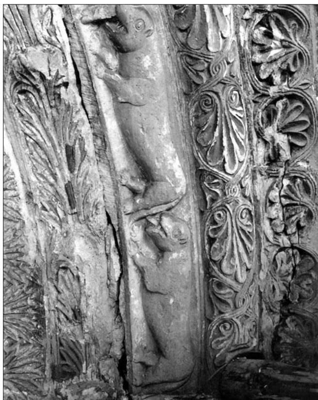
Obr. 8: Záboreň nad Labem, kostel sv. Prokopa. Pravá strana archivoly, stav na počátku restaurování v roce 2003. Díl s reliéfy psů má nejlépe zachovaný povrch. Vlevo v rozjeté spáře viditelné seký dláta. Vpravo od psů není spára – dva pasy jsou zde z jednoho kusu kamene.
