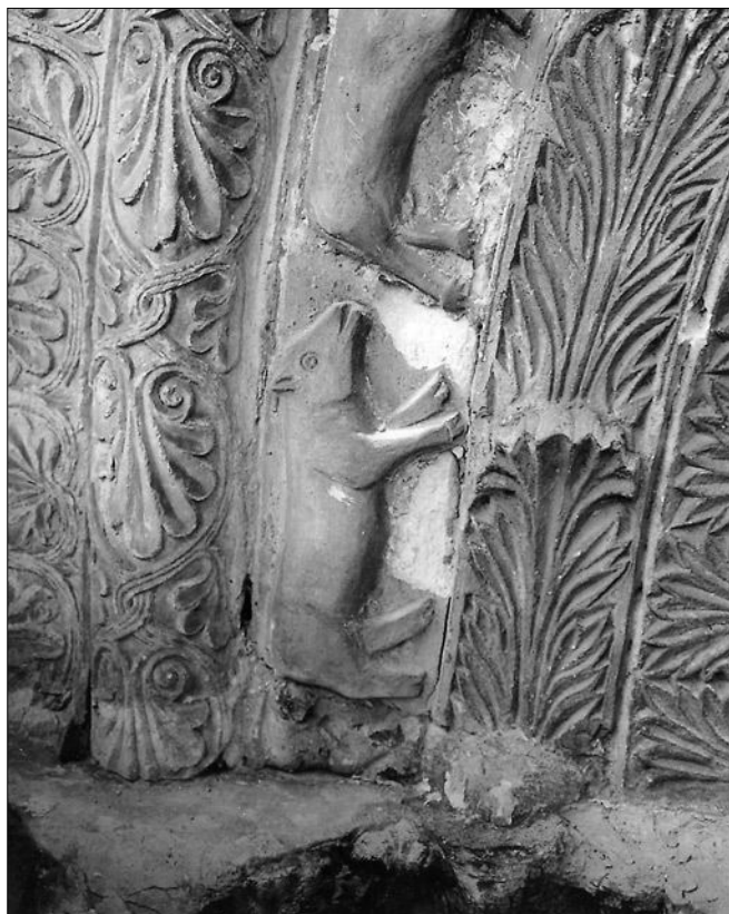
Obr. 6: Záboreň nad Labem, kostel sv. Prokopa. Levá strana archivoly, stav během restaurování v roce 2003. Pod cementovým zvířetem dole u hlavičky fragment původního menšího zvířete z opuky. Pod dolní svislou palmetou nad hlavičkou patka – drápek. Tyto drápky ukončují pouze pasy, které jsou nad nárožními spodní architektury.
