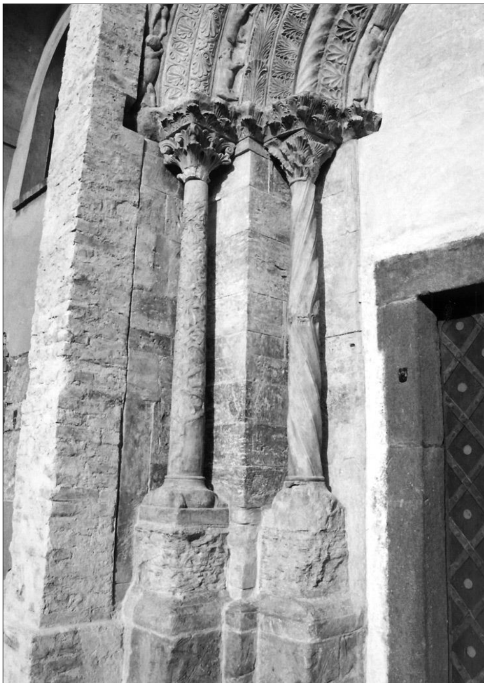
Obr. 16: Záboří nad Labem, kostel sv. Prokopa. Levá střední část portálu. Vpravo viditelná hrana průchodu portálu. Vlevo cihelný pilíř, který nahrazuje třetí sloupek, vymezený spárou (stav po restaurování v roce 2005).
