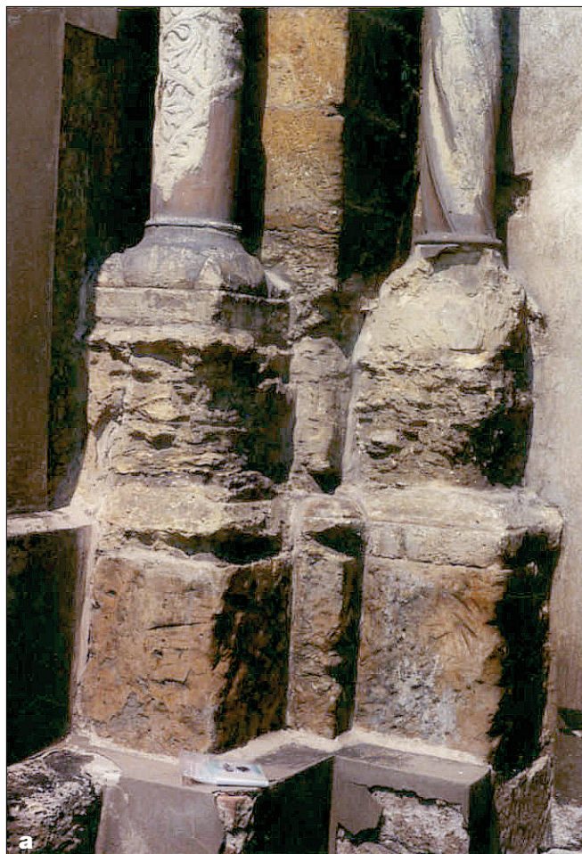
Obr. 5: Zábřeh nad Labem, kostel sv. Prokopa; a – destrukce prachovitých vápenců v nadloží pískovcových bloků západní strany; b – destrukce prachovitých vápenců v nadloží pískovcových bloků východní strany.
