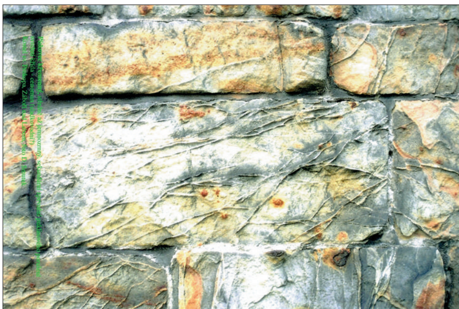
Obr. 4: Záboří nad Labem, kostel sv. Prokopa, pískovec křemenný, středně až jemnozrnný, sekundární zpevnění puklinového porušení, vrchní křída – cenoman (sladkovodní?) (foto D. Smutek).
