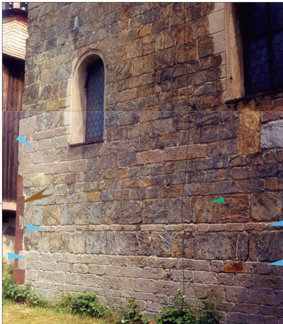
Obr. 2: Záboří nad Labem, kostel sv. Prokopa, materiálová skladba kamene západní stěny.
