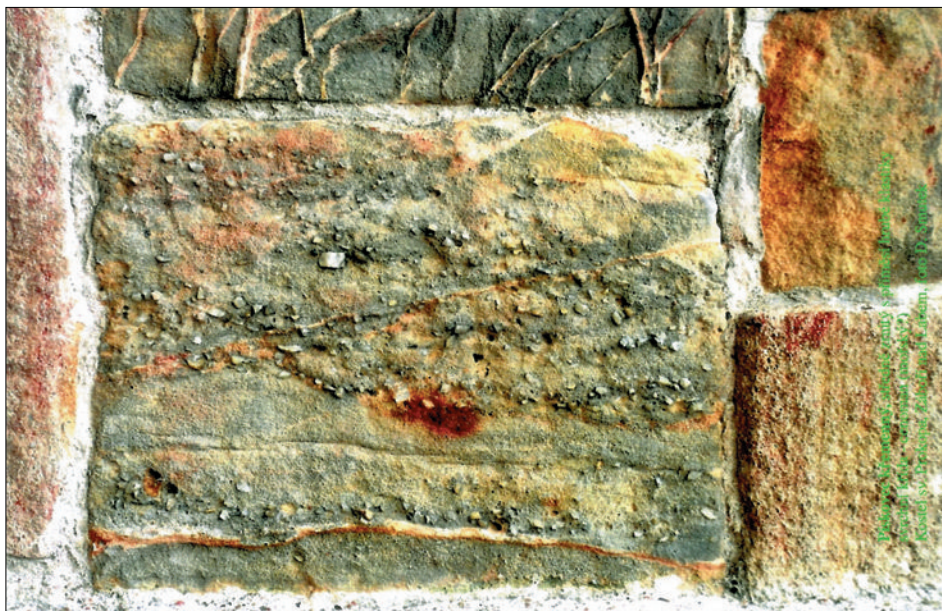
Obr. 3: Záboří nad Labem, kostel sv. Prokopa, pískovec křemenný, stejně zrnitý s příměsí hrubé klastiky, vrchní křída – cenoman (mořský?) (foto D. Smutek).
