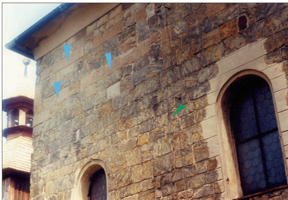
Obr. 1: Záběří nad Labem, kostel sv. Prokopa, materiálová skladba kamene západní stěny (všechny snímky autor, není-li uvedeno jinak).
