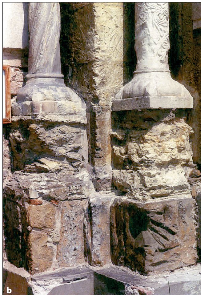
Obr. 5: Zábřeh nad Labem, kostel sv. Prokopa; a – destrukce prachovitých vápenců v nadloží pískovcových bloků západní strany; b – destrukce prachovitých vápenců v nadloží pískovcových bloků východní strany.
