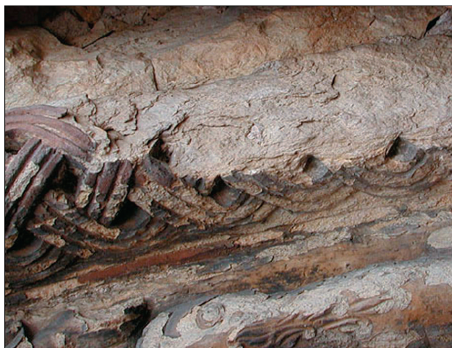
Obr. 1: Zábore nad Labem, kostel sv. Prokopa, portál. Šupinovitý rozpad horniny – ornamenty na archivoltách (všechny snímky autoři).
