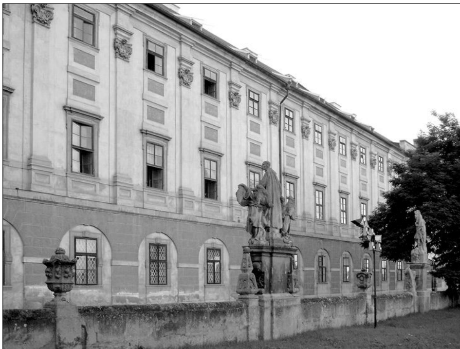
Obr. 10: Jezuitská kolej v Kutné Hoře. Pohled od severozápadu na severní část hlavního průčelí (foto P. Uličný, 2005).
