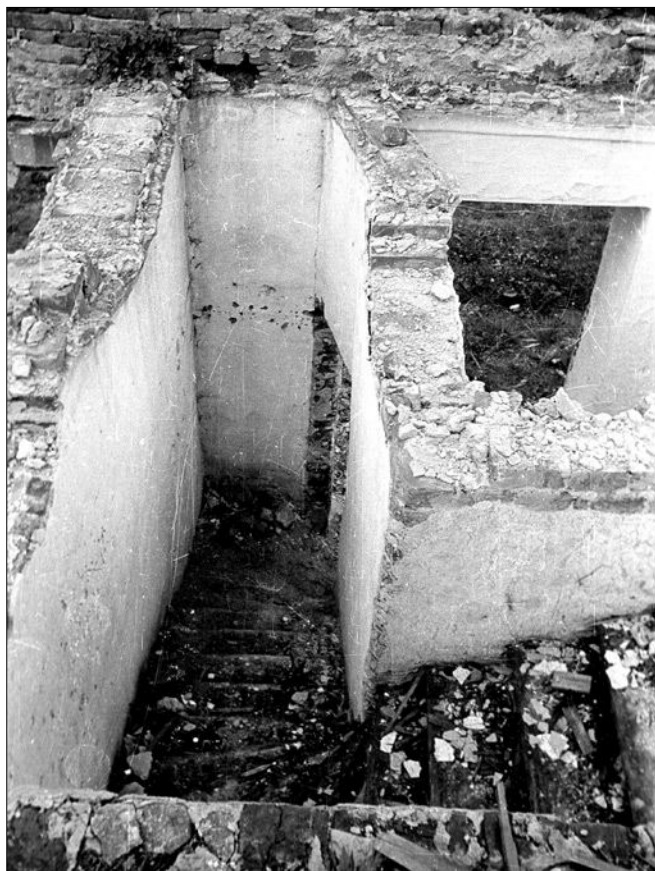
Obr. 11: Nákle, zalomené schodiště vedoucí na půdu (originál fotografie z roku 1958 uložen v Archivu Akademie věd ČR).
