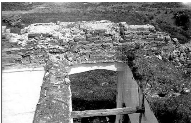
Obr. 8: Nákle, chodba 03 s příčným trámem, který zbyl z dřevěné přčky (originál fotografie z roku 1958 uložen v Archivu Akademie věd ČR).
