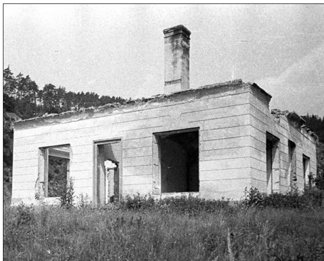
Obr. 15: Nákle, torzo zámku zbavené střechy před demolicí, stav v roce 1958 (originál uložen v Archivu Akademie věd ČR).
