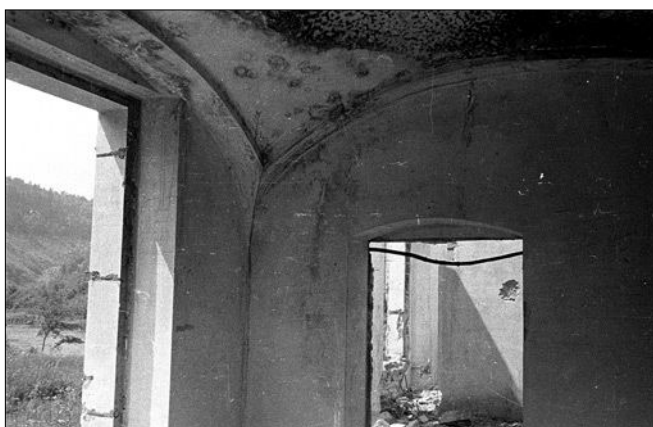
Obr. 9: Nákle, komora zaklenutá českou placou (originál fotografie z roku 1958 uložen v Archivu Akademie věd ČR).
