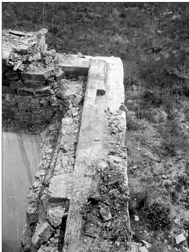
Obr. 12: Nákle, koruna obvodového zdi s pozednicí. Originál fotografie z roku 1958 uložen v Archivu Akademie věd ČR.
