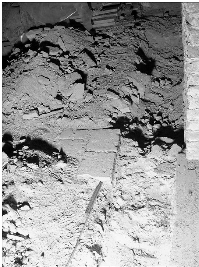
Obr. 7: Praha, Jilská ul. 234/I. Světnice v 1. patře, zbytek dlahby z cihelných dlahdic, náležející k renesanční přestavbě 1601. Poloha viz též řez LL' na obr. 6.
