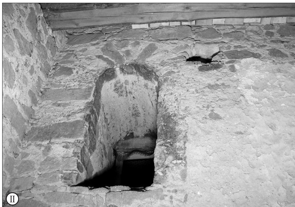
Obr. 22: Kestřany (okres Písek), dolní tvrz. Detaily topeniště a světnice.
