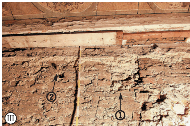
Obr. 5: Praha, Jilská ul. čp. 234/1, detaily výdřevy.
