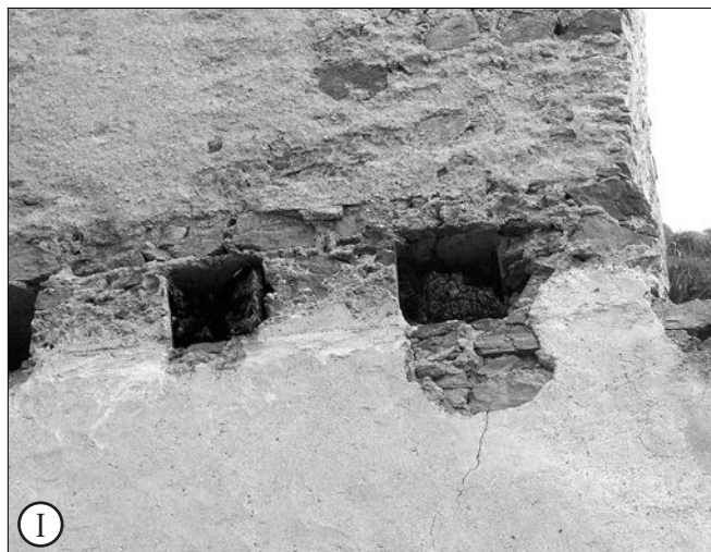
Obr. 23. Doklady prkenných podhledů pro srovnání: I: Hrad Divčí Kámen (okres Český Krumlov), jižní obytná místnost vstupního paláce, detail omítek navazujících na podhled naspodu stropních trámů (srov. situaci v Kestřanech).
