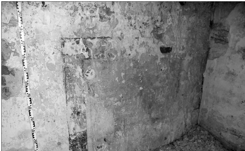
Obr. 27: Stvolínky, kostel Všechných svatých, interiér, východní část severní zdi lodi (úroveň nad emporou) s omítkou s malovaným rámem, zabíhající pod podlahu současné empory i pod východní zeď lodi.
