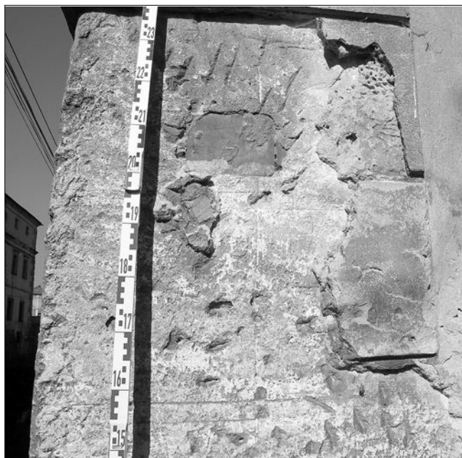
Obr. 24: Stvolínky, kostel Všech svatých, jižní průčelí lodi, starší omítka s patrným předřísováním iluzivního kvádrování při jihozápadním nároží.
