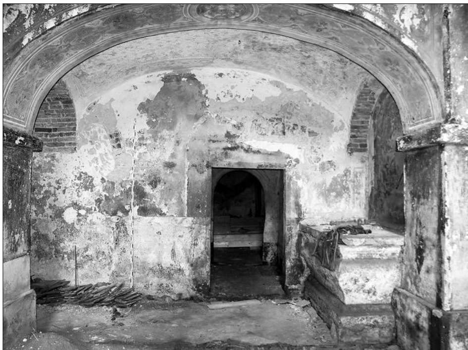
Obr. 20: Stvolínky, kostel Všechných svatých, portál průchodu z lodi do podvěží; vlevo patrné stopy odstraněné empory (část oblouku z odsekaných cihel).
