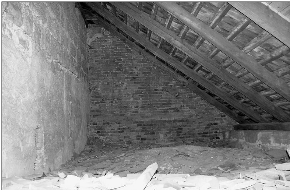
Obr. 15: Stvolínky, kostel Všechn svatých, prostor krovu kaple sv. Anny, pohled k západu. Vlevo severní zeď lodi s patrnou linií horního zakončení původně v exteriéru se uplatňující omítky; nad touto linií neomítaná nadezdívka z pískovcových kvádrů.
