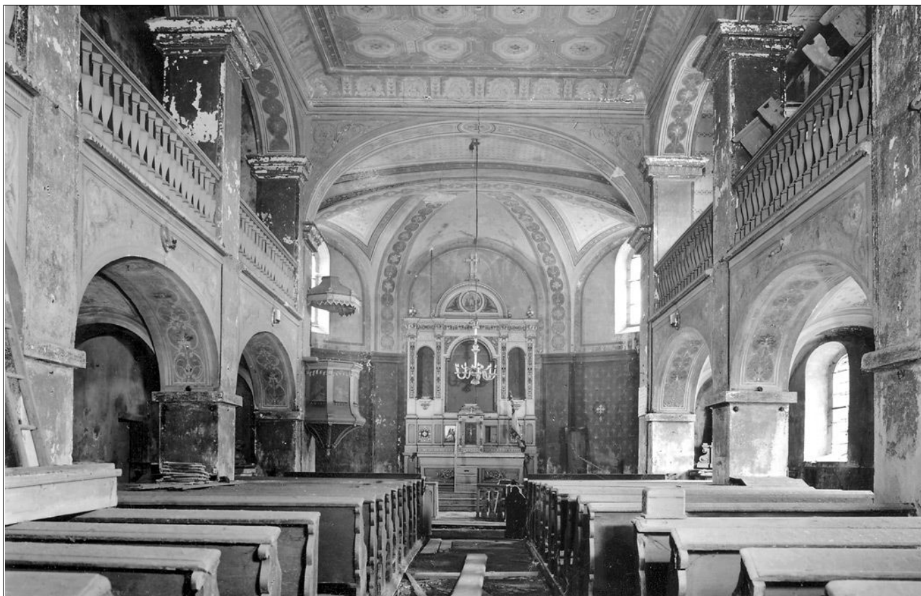
Obr. 33: Stvolínky, kostel Všechných svatých, interiér, pohled k východu, stav v roce 1996 – před vyrobáním veškerého zařízení (NPÚ, územní odborné pracoviště Liberec, sbírka fotodokumentace, č. neg. 119857, foto Roman Kursá).
