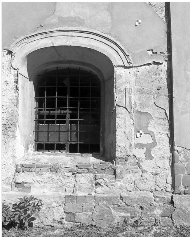
Obr. 12: Stvolínky, kostel Všechn svatých, relikv portálku v jižním průčelí lodi (část půlkruhem zakončeného ostění patrná vpravo od šambrány mladšího okenního otvoru).
