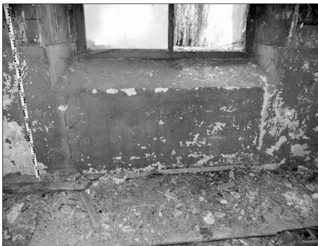
Obr. 16: Stvolínky, kostel Všechn svatých, interiér, stopy špalety otvoru ve střední ose západní zdi lodi, narušeného mladším oknem (patrné při obou stranách parapetu).
