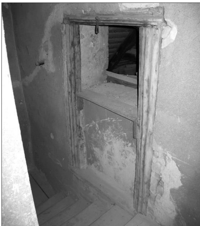
Obr. 17: Nové Dvory, profilované dřevěné ostění vstupu do podkrovní lodi.
