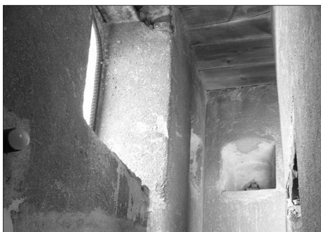
Obr. 20: Nové Dvory, interiéru zámecké věže, prostor mezi obvodovou zdí a středním kubusem, vlevo okno s půlkruhovým záklenkem, vzadu jsou zazděné kapsy po trámech, uvnitř upravené jako niky se segmentovým záklenkem.
