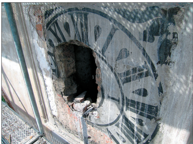
Obr. 31: Nové Dvory, hodinový ciferník na východní stěně zámecké věže.
