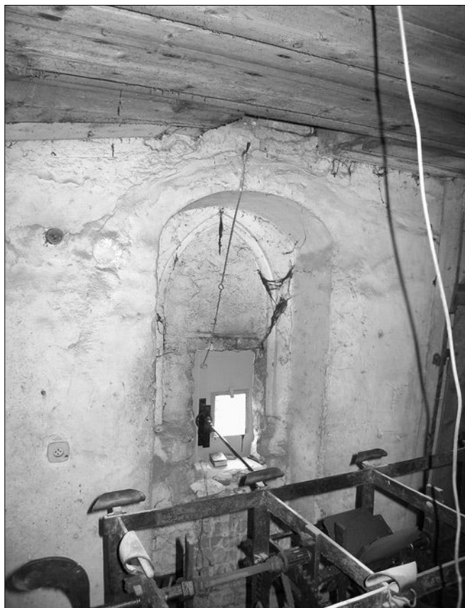
Obr. 21: Nové Dvory, zazděné hrotité okno s kamenným ostěním na západní straně dnešního hodinového podlaží věže.
