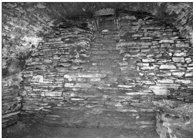
Obr. 18: Nové Dvory, sklep v podvěží, nahoře na čele valené klenby je patrné kamenné ostění větracího průduchu, osazené téměř ve vodorovné poloze.
