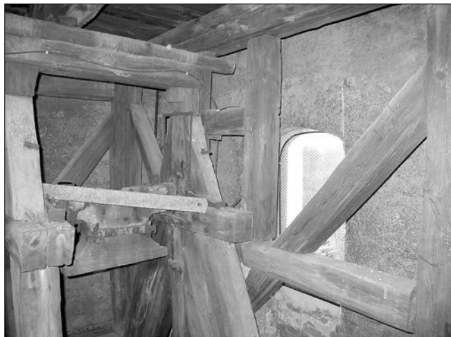
Obr. 24: Nové Dvory, zvonová stolice s obvodovým hranolovým rámem, dendrochronologicky datovaná do 80. let 17. století.
