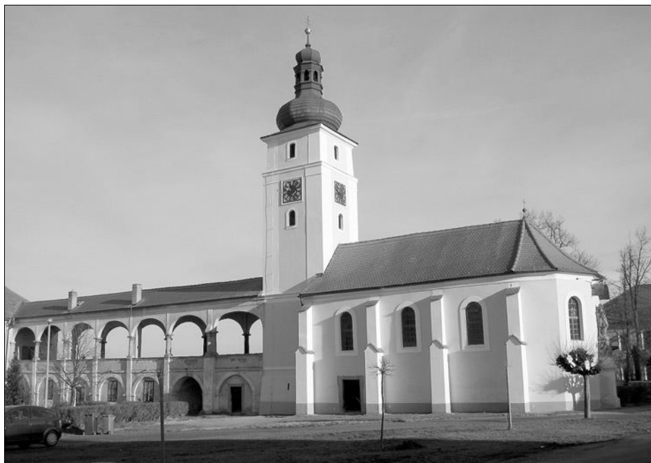
Obr. 34: Nové Dvory, pohled na zámecký kostel po opravě od jihozápadu (prosinec 2006).
