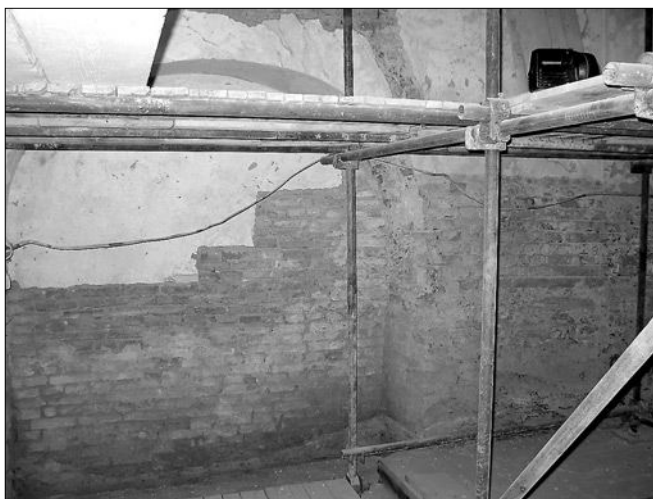
Obr. 10: Nové Dvory, jedna z nik na severní straně lodi, které se původně otevíraly do severní přístavby.
