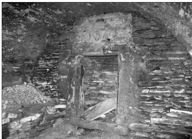
Obr. 19: Nové Dvory, severní strana sklepa pod zámeckou věží s kamenným vstupním portálem.
