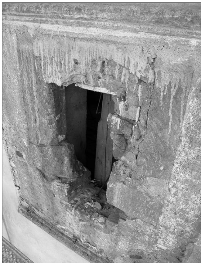
Obr. 29: Nové Dvory, spodek kamenného ostění hrotitého okénka pod hodinovým ciferníkem na západní straně věže.
