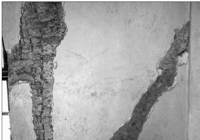
Obr. 11: Nové Dvory, situace při pravém okně severní stěny lodi – spára s náběhem záklenku signalizuje původní širší otvor, který se otvíral do patra severní přístavby
