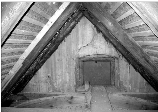
Obr. 16: Nové Dvory, pohled z podkrovní na západní stěnu věže. Krov byl podle dendrochronologie vyroben z trámů kácených v letech 1828–1830.
