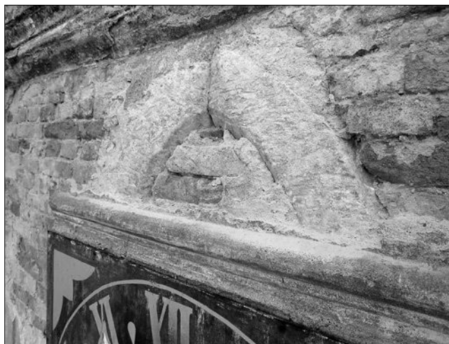
Obr. 28: Nové Dvory, hrotitý záklenek okénka na západní straně věže.
