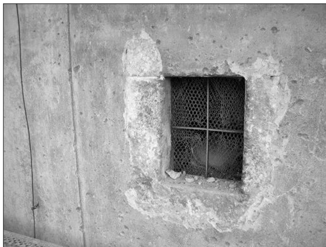
Obr. 27: Nové Dvory, „renesanční“ kamenné ostění okénka v patře severní stěny věže.
