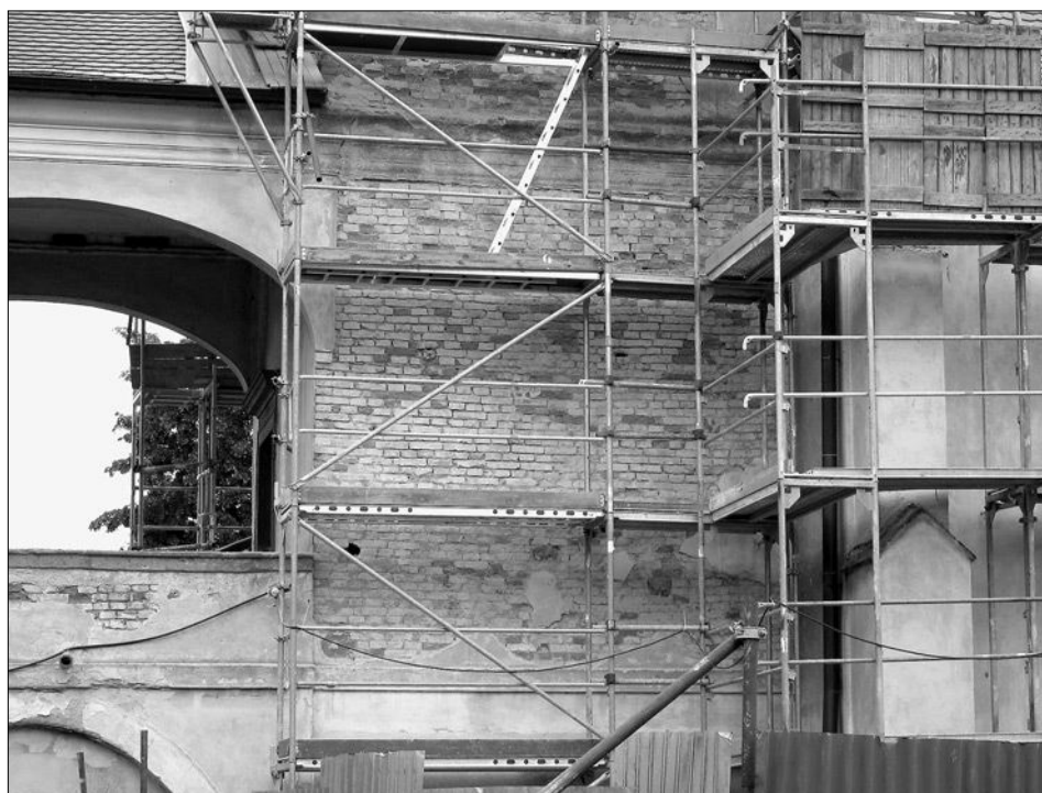
Obr. 26: Nové Dvory, cihelné zdivo na spodku jižní stěny věže při opravě.
