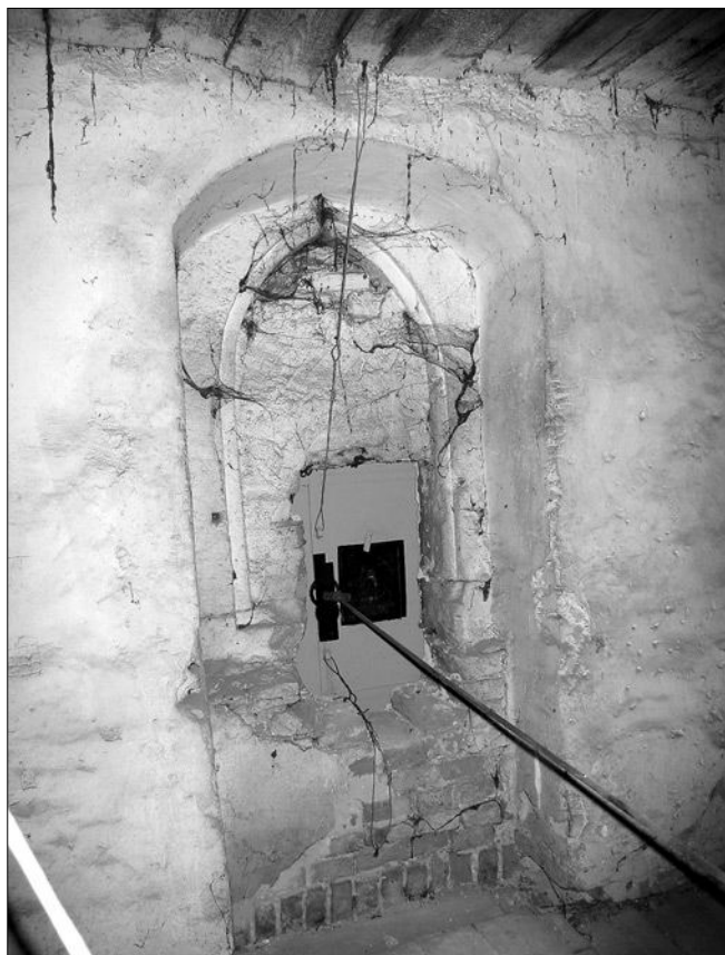
Obr. 22: Nové Dvory, zazděné hrotité okno s kamenným ostěním na severní straně dnešního hodinového patra věže.
