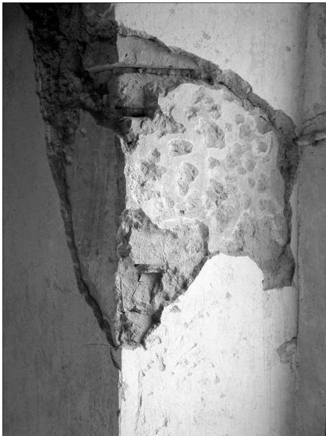
Obr. 9: Nové Dvory, staré omítky s malovanou výzdobou ve špaletě okna na jižní straně lodi.
