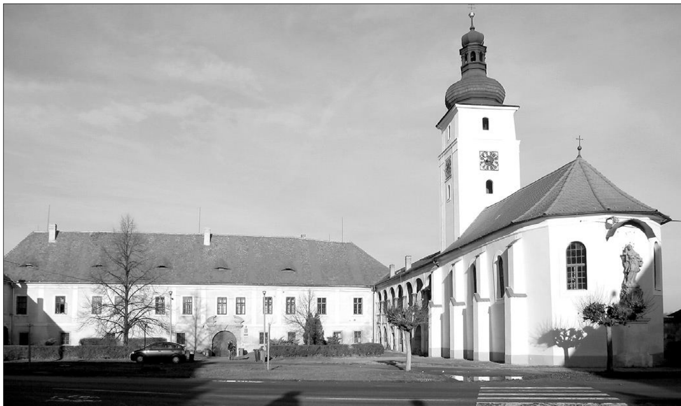
Obr. 3: Nové Dvory, pohled na zámek od západu s kostelem po opravě (zima 2006).
