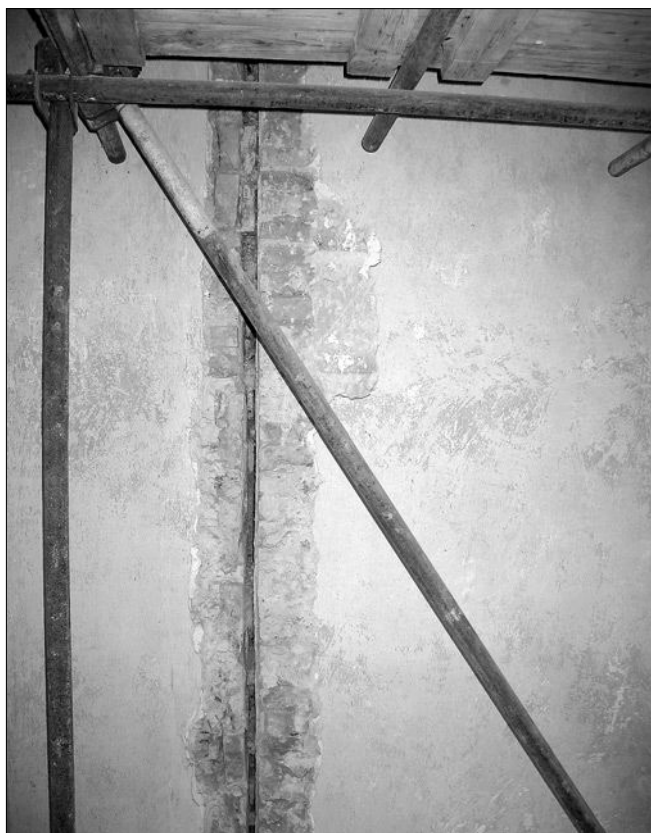
Obr. 12: Nové Dvory, jihozápadní nároží původně samostatné věže, zhruba uprostřed nad lešeňovou trubkou je odkryto renesanční červeně malované kvádrování. Renesanční omítky zabíhají i do spáry mezi věží a novější boční přízdívkou.
