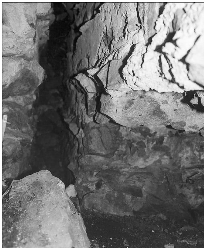
Obr. 15: Helfenburk, hrad, jihovýchodní bašta severního segmentu vnějšího opevnění. Detail otisků trámů na stěně západní poloviny dutiny, která vznikla po vyhnití dlouhé stěny vložené do osy severního ramena. V pravé dolní části snímku je zachycena část téměř zasypané níky, či střílny (foto J. Kypta, 2005).
