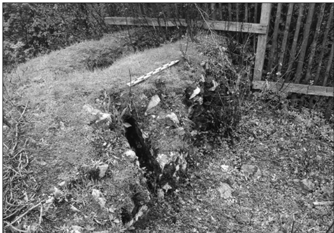
Obr. 11: Helfenburk, hrad, jihovýchodní bašta severního segmentu vnějšího opevnění. Detail koruny zaobleného čela, dobře je patrná dutina vzniklá po vyhnití dřevěné stěny. Nad latí zřetelný obrys rozsáhlé dutiny nepravidelného tvaru. Pohled od severozápadu (foto J. Kypta, 2005).
