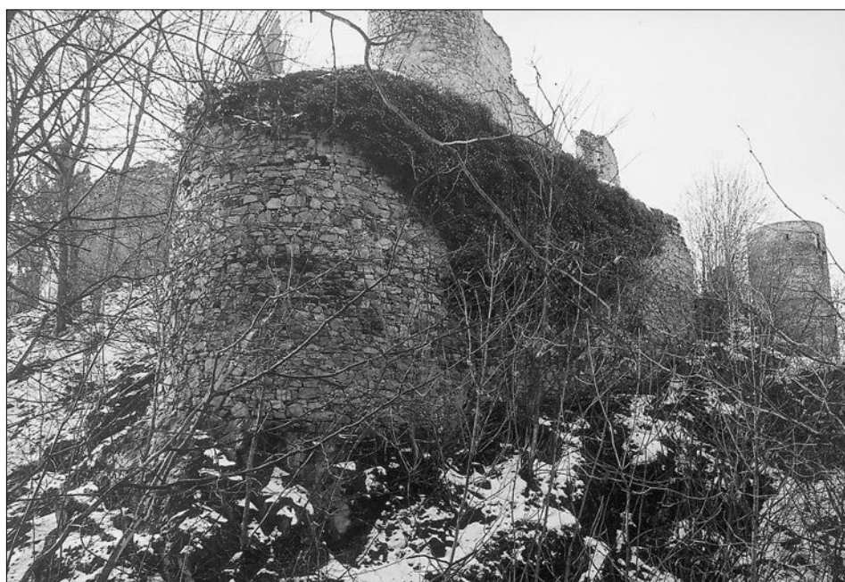
Obr. 2: Helfenburk, hrad, jihovýchodní bašta severního segmentu vnějšího opevnění. Celkový pohled od severovýchodu z koruny okružního valu (foto J. Kypta, 2005).
