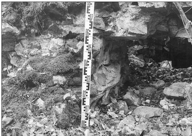
Obr. 6: Helfenburk, hrad, jihovýchodní bašta severního segmentu vnějšího opevnění. Detail západního ukončení severozápadní špalety střílny v čele bašty. Vpravo od latě, v úrovni 40–60 je zřetelný otisk trámku překladu, v úrovni 20–40 otisky dvou trámů obkladu špalety (foto J. Kypta, 2005).
