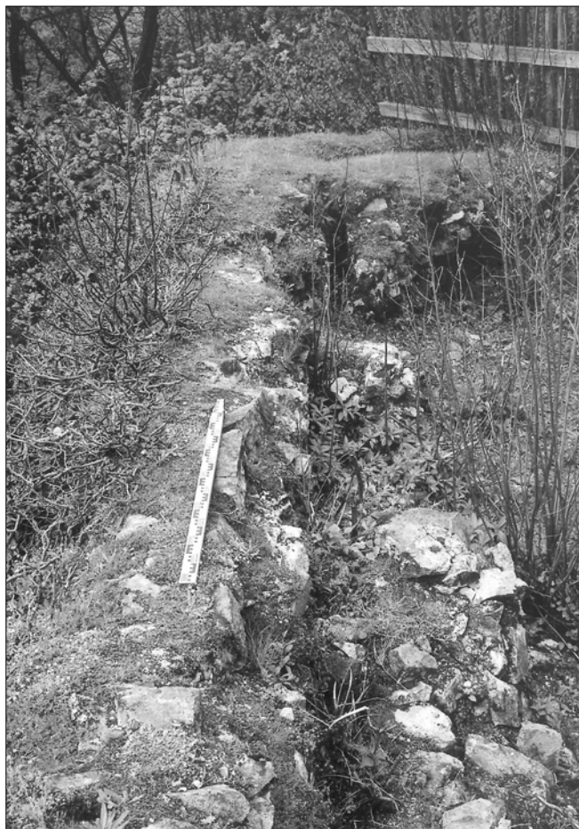
Obr. 10: Helfenburk, hrad, jihovýchodní bašta severního segmentu vnějšího opevnění. Detail koruny severního ramena a zaobleného čela, dobře jsou patrné negativy dvou dřevěných stěn vložených ve směru Z-V. Pohled od západu (foto J. Kypta, 2005).
