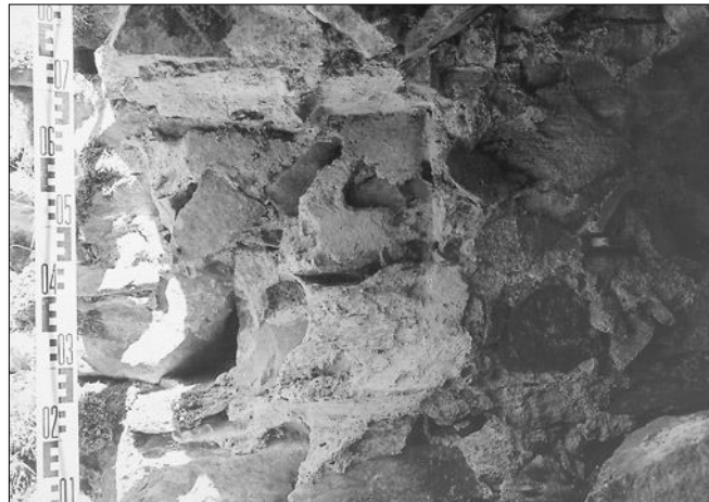
Obr. 7: Helfenburk, hrad, jihovýchodní bašta severního segmentu vnějšího opevnění. Kolmý pohled k obr. 6. Vpravo do latě, v úrovni 44–70 jsou zřetelné otisky čel trámů překladu, v úrovni 15–40 otisky obkladu špalety (foto J. Kypta, 2005).
