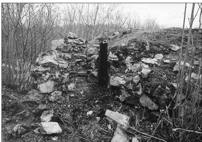
Obr. 13: Helfenburk, hrad, jihovýchodní bašta severního segmentu vnějšího opevnění. Detail západního ukončení severního ramena, dobře jsou zřetelné negativ dřevěné stěny a vlevo od něj spára oddělující fragment hradby přihrádku. Pohled od jihu (foto J. Kypta, 2006).
