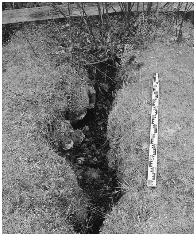
Obr. 14: Helfenburk, hrad, jihovýchodní bašta severního segmentu vnějšího opevnění. Detail dutiny v koruně zaobleného čela, jejíž nepravidelný obrys zřejmě vznikl výraznou destrukcí negativu stěny probíhající ve směru SZ–JV. Pohled od severozápadu (foto J. Kypta, 2005).
