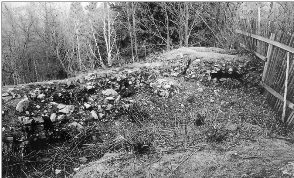
Obr. 5: Helfenburk, hrad, jihovýchodní bašta severního segmentu vnějšího opevnění. Pohled do interiéru od jihozápadu. V popředí vystupuje skalní blok, na jehož temeni je založena válcová věž, vsazená do severovýchodního nároží opevnění jádra hradu. V pravé části snímku je zachyceno ústí střílny v čele bašty, vlevo od ní je dobře zřetelný negativ jedné z dřevěných stěn (foto J. Kypta, 2006).
