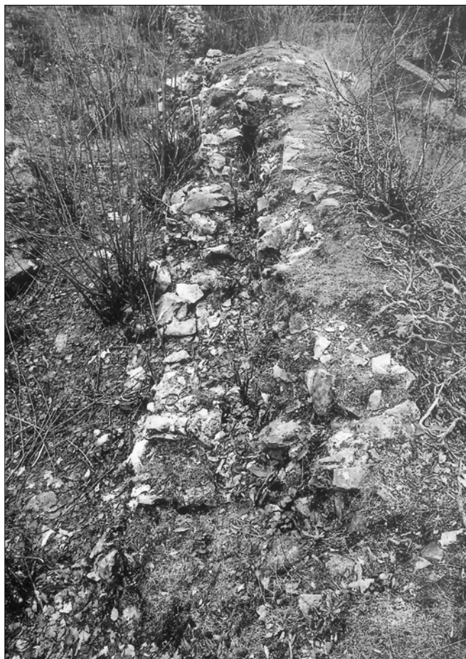
Obr. 9: Helfenburk, hrad, jihovýchodní bašta severního segmentu vnějšího opevnění. Koruna severní zdi, v jejíž ose je patrná z větší části zasypaná dutina, vzniklá po vyhnutí dřevěné stěny ztužující konstrukce. V horní části snímku je zachycen fragment původního zdiva, překrývajícího negativ dřevěné konstrukce. Pohled od východu (foto J. Kypta, 2006).
