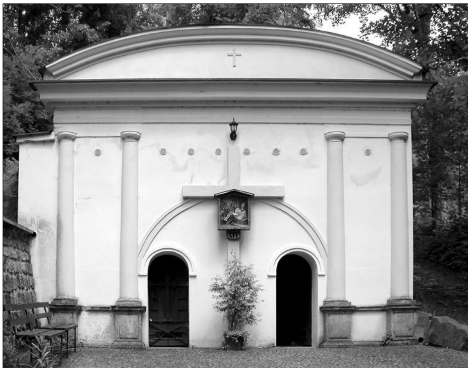
Obr. 28: Malé Svatoňovice, Mariánská zahrada, areál poutního kostela Sedmi radostí Panny Marie, pohled na průčelí Božího hrobu z období 1902–05 se 14. zastavením.
