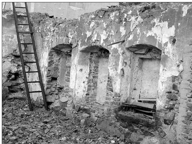
Obr. 4: Zlatá Koruna (Český Krumlov), mlýnec u mlýna čp. 3. Objekt byl dokumentován před zahájením demolice i v jejím postupném průběhu (foto Jarmila Hansová, 2005).
