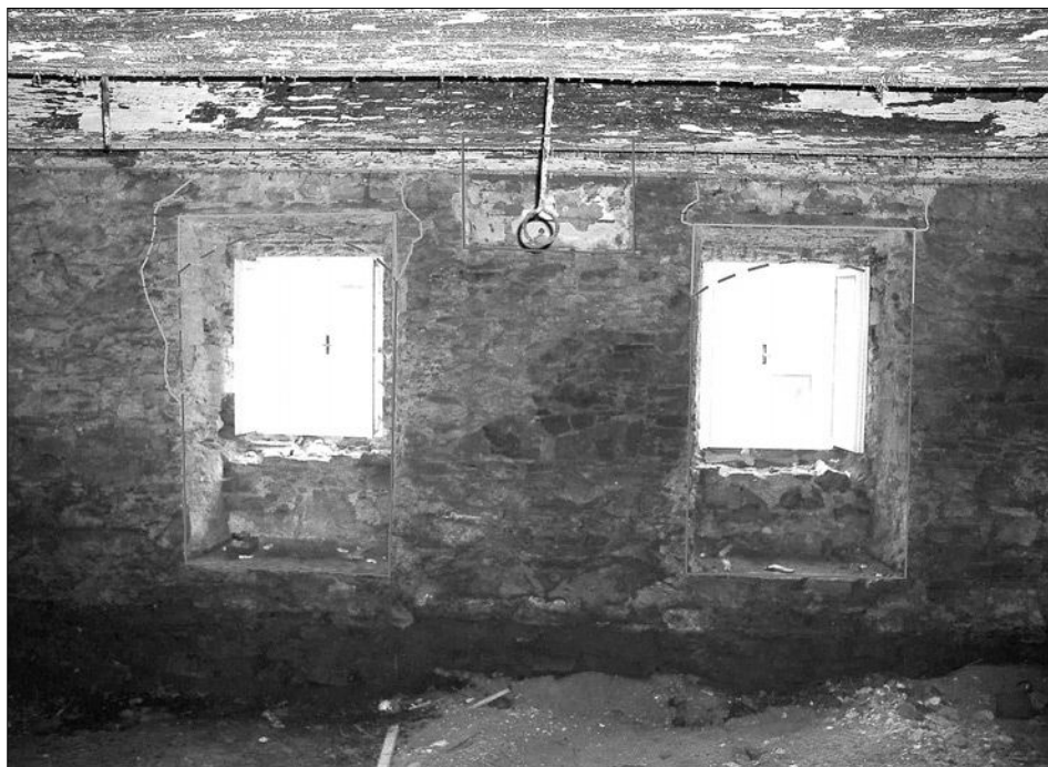
Obr. 2: Hořice na Šumavě (Český Krumlov), dům čp. 15. Severní stěna, jizby s trojúhelníkovou kompozicí otvorů, spodní okna byla dodatečně zvýšena. Zákres do fotografie (zpracoval Daniel Šnejd, 2006).
