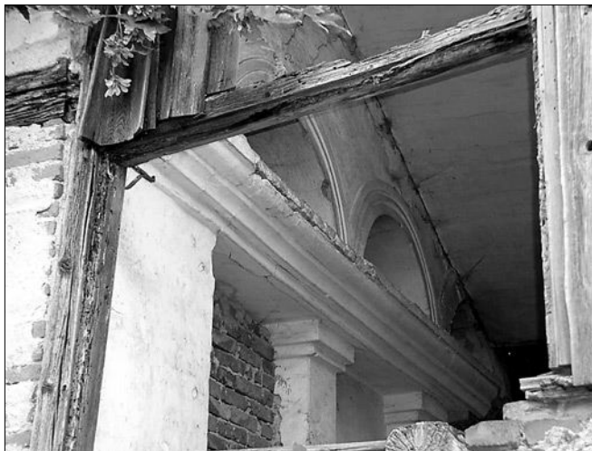
Obr. 3: Lnáře (Strakonice), oranžerie v zámekském parku. Detail okenního rámu pěstební části a architektonického členění reprezentačního vestibulu (foto Daniel Šnejd, 2006).
