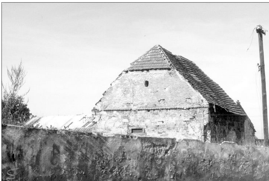
Obr. 35: Dobré Pole (okres Kolín), sýpka. Neobvykle drobná stavba sýpky stojí samostatně za ohradní zdí na východní straně dvora. Spolu se sousední obytnou budovou, ze které se dnes dochovaly pouze zbytky čelní stěny s okenními otvory, je situována v areálu někdejší tvrze. V urbáři je zde popsána ratejna, komory a v patře dokonce obyvatelné světnice (foto J. Žizka, 2001).
