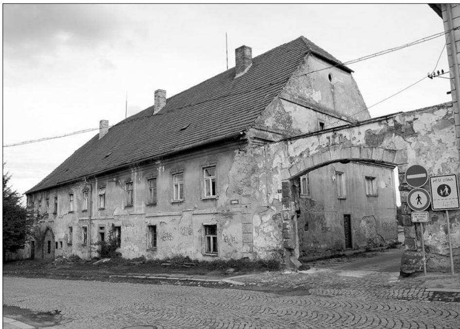
Obr. 20: Kostelec nad Černými lesy (okres Praha-východ), pohled na dům čp. 15 v čele hospodářského dvora. Dům renesančního původu, složitých stavebních dějin, obýval v době sepsání urbáře pojezdny, obroční písař a šafář. V levé části průčelí je dosud dochován renesanční vjezdový portál, který zřejmě vedl do kolny a k oficiální koniřně. Brána do dvora po pravém boku domu – mezi ním a někdejší „Jägerhausem“, byla postavena někdy ve druhé polovině 19. století s využitím renesančních ostění (foto J. Žížka, 2008).
