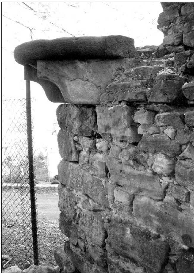
Obr. 2: Kostelec nad Černými lesy (okres Praha-východ), areál zámku, zbytek nárožní věžičky bastionu. Prostor bastionu na východní straně sloužil v době porážení urbáře jako nezastřešená jízdná. Strážní věžička byla nepochybně jedním z dvojice „krytých vjezdů“, kdež v každém jedna osoba seděla a do tumpplacu hledět může“ (foto J. Žizka, 1998).
