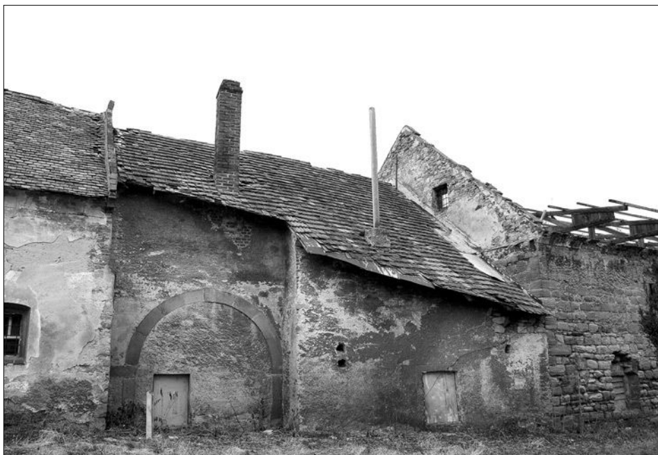
Obr. 19: Tuchoraz (okres Kolín), původní brána dvora. Brána, zazděná někdy v 19. století, má dochováno ostění s půlkruhovou archivoltou, které nepochybně měla již v 17. století. Na zdivu jsou zachovány zbytky omítky s nárožními kvádry, vlevo bývalá ratejna, vpravo sýpka (foto J. Žižka, 2007).
