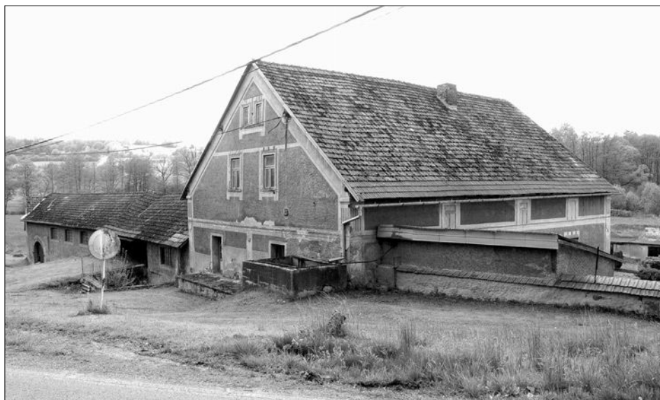
Obr. 39: Hruškovský mlýn u Stříbrné Skalice, popsáný v urbáři od severovýchodu. Ve mlýně tehdy nazývaném „Růžkovský“ byla v 70. letech 17. století postavena nová pila. Mlýn byl do dnešní podoby přestavěn ve druhé polovině 19. a na počátku 20. století. Ve druhé polovině 20. století i na počátku 21. století řada mlýnů černokosteleckého panství zanikla, nebo byla zásadněji přestavěna. „Růžkovský“ mlýn stojí na Jevanském potoce (Propast), který kdysi napájel řadu rybníků a mezi Jevany a Stříbrnou Skalici poháněl šest mlýnů (foto J. Žizka, 2006).
