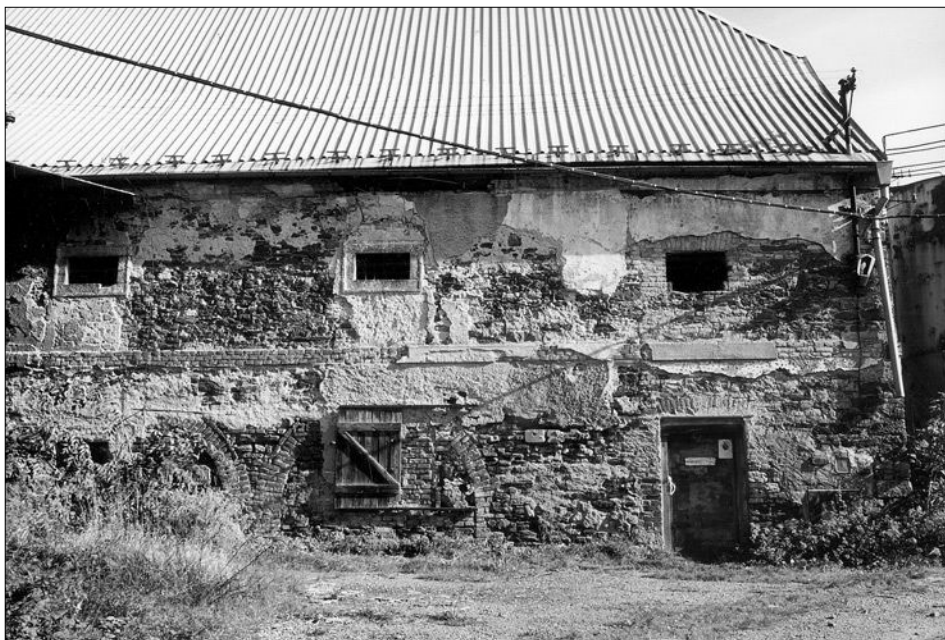
Obr. 26: Klučov (okres Kolín), pohled na část západní fasády sýpky. Sýpka stojící na východní straně dvora, severním čelem obrácená k vodnímu příkopu zaniklého zámku, postavená na počátku 18. století, obsahuje zdivo starší stavby. Pozoruhodná je zejména zazděná arkáda v přízemí, provedená v jiném rytmu než okna sýpky. Snad šlo o zděnou vozovou kůlnu, tedy příslušenství zámku, zmíněnou v urbáři (foto J. Žižka, 2001).
