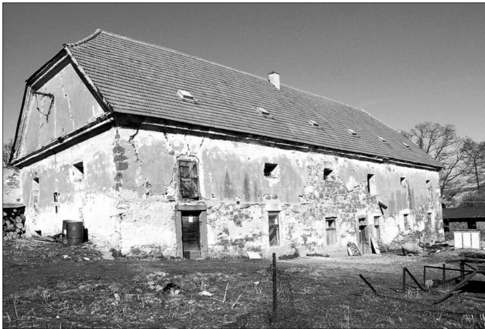
Obr. 21: Syneč (okres Kolín) sýpka na severovýchodní straně dvora. Barokní sýpka se zbytky iluzivního malovaného členění upomíná svým uspořádáním na starší stavby. Podstatnou část přízemí zaujímá v celém rozsahu valeně zaklenutá obytná část s velkou střední místností – zřejmě ratejnou, komorami a kuchyní po bocích. Vlevo je vstup na schodiště do sýpkových podlaží, při kterém je další komora s archaickým překlápěným jošnovým stropem (foto J. Žizka, 2007).
