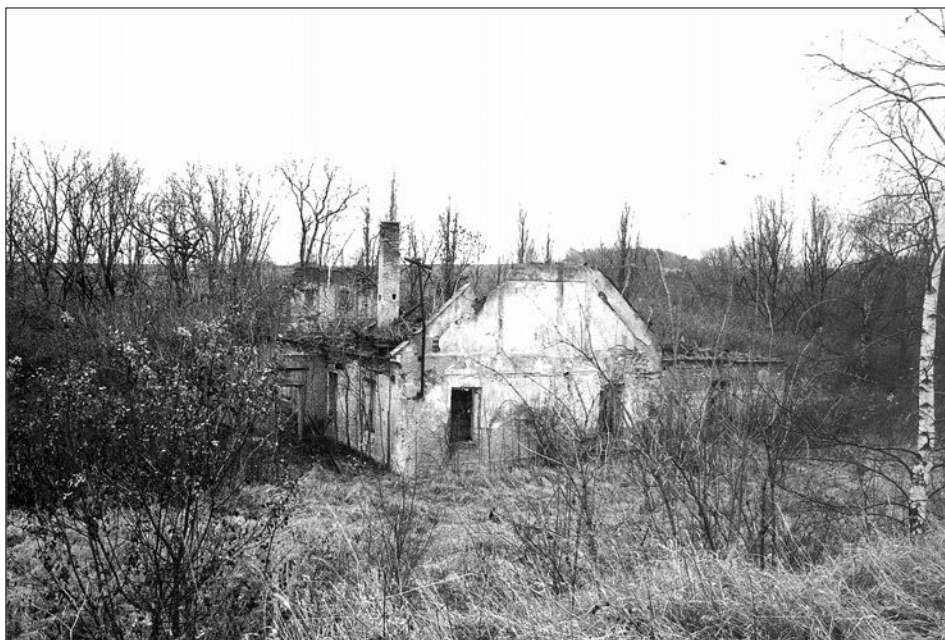
Obr. 23: Přebozy (okres Kolín), zřícenina domu ovčáckého mistra v jihovýchodní části dvora. Samostatně stojící budova v dolní starší části dvora u rybníka je pozůstatkem starého uspořádání. Přes mladší stavební úpravy jsou zde dosud zřetelné dochované barokní konstrukce (foto J. Žižka, 2001).
