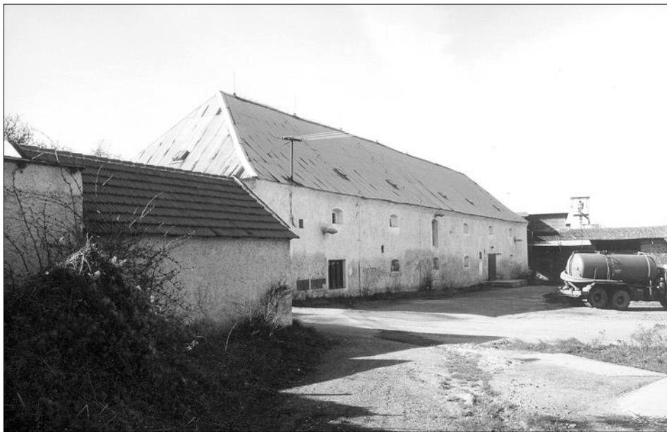
Obr. 25: Hřiby (lk. ú. Vitice, okres Kolín), pohled na sýpku ze dvora. Jednopatrová sýpka nahradila ve druhé polovině 18. století dobře vybavenou sýpku popsanou v urbáři, která stála ve výrazné poloze u brány dvora. Sýpka byla v této době stejně situovaná a nejspíše i stejně vysoká. Délkově byla kratší, disponovaná na 4 osy, ve střeše bylo po třech vikýřích. Pozoruhodná je zmínka o provětrávané podlaze. Jak naznačuje poměrně malá šířka budovy, která není u barokní sýpky obvyklá, v organismu dnešní stavby může být ještě zachováno zdivo stavby ze 17. století (foto J. Žižka, 1997).
