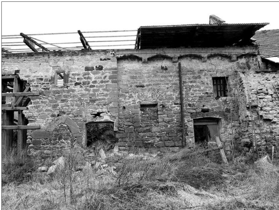
Obr. 24: Tucharaz (okres Kolín), východní část budovy sýpky v hospodářském dvoře. Pozdně gotická sýpka je zřejmě nejstarší hospodářskou budovou ve středních Čechách. Krakorce vynášely nepochybně v roce 1677 zmiňovanou věž (foto J. Žižka, 2007).
