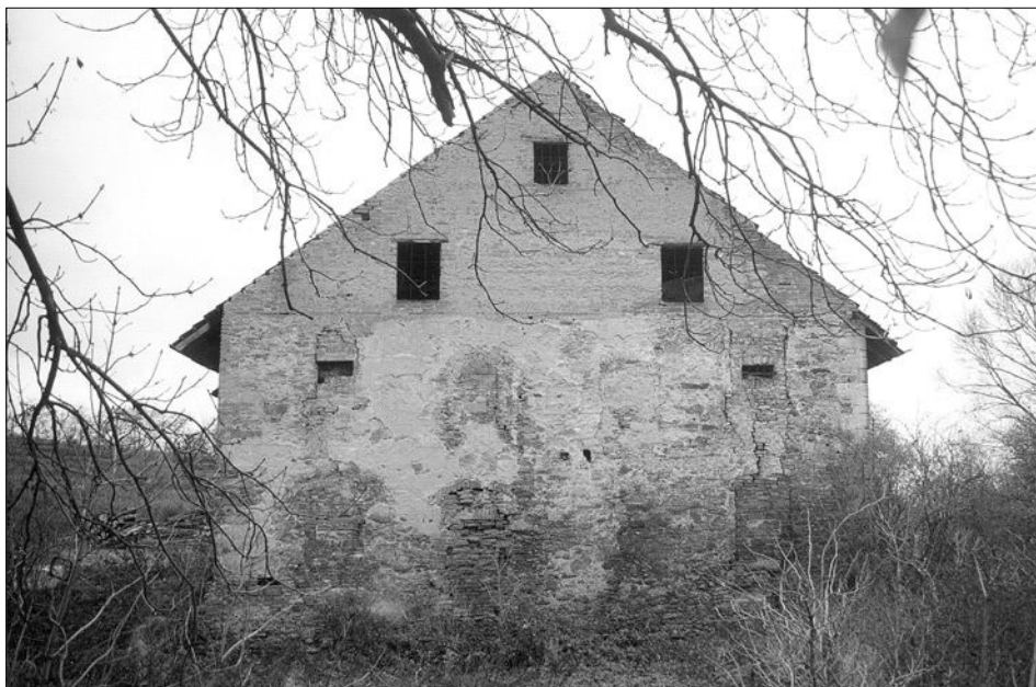
Obr. 32: Cerhůnky (okres Kolín), hospodářský dvůr, jižní čelo sýpky. Sýpka stála samostatně v severní části dvora. Dochované úseky zdíva s náročným armovaným kvádry, stopy sgrafitové omítky i dodatečné úpravy otvorů dokládají, že části turze zmiňované v urbáři byly využity ke stavbě hospodářské budovy (foto J. Žizka, 1997).
