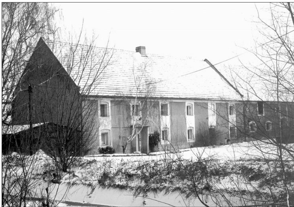
Obr. 22: Běšínov (okres Kolín), pohled na severní křídlo dvora. V popředí je zachycena obytná část tam, kde v 70. letech 17. století byla ratejna a nad ní v patře panská světnice. Lze tedy předpokládat, že budova dochovaná v podobě, kterou dostala ve třetí čtvrtině 19. století, obsahuje ještě některé konstrukce ze 17. století (foto J. Žižka, 1998).
