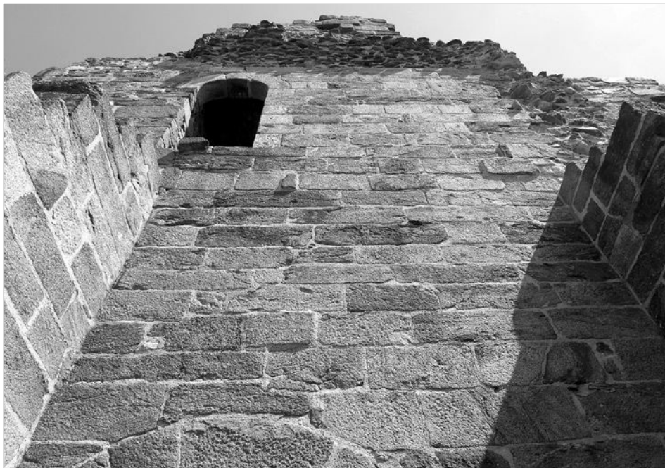
Obr. 34: Hrad Přimda, risalitu věže. Pohled na západní průčelí věže s portálkem do chodby, jejího 1. patra. Patrně jsou ústupky pro osazení stropu přízemí risalitu, nerovnosti líce věže patrně souvisejí s konstrukcí tohoto stropu. Vyčnívající kámen pod prahem portálku je patrně fragmentem schodu, neboť práh portálku byl vyvýšen nad podlahu. Nahoře zbytek klenby 1. patra risalitu (srov. obr. 27, 35, 36, foto autor, 2008).
