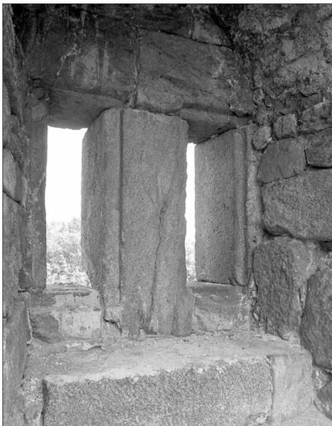
Obr. 13: Hrad Přimda, věž, detail ostění okna 1. patra (srov. obr. 11) s obvodovými ústupky pro okenice (foto autor, 2000).
