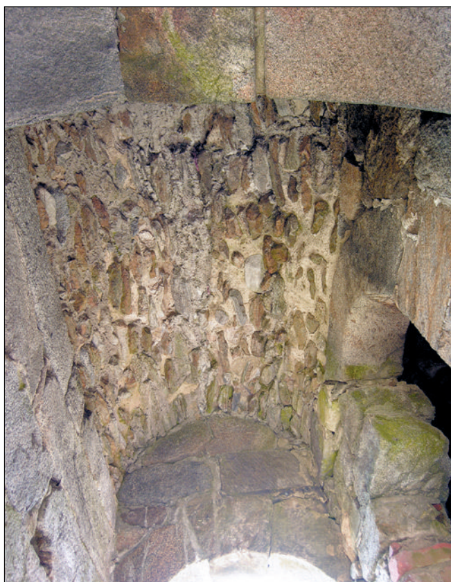
Obr. 19: Hrad Přimda, věž. Chodba k rizalitu, klenba v pohledu směrem k vnějšímu portálku. Vpravo vstup do předpokládaného převětu (foto autor, 2008).
