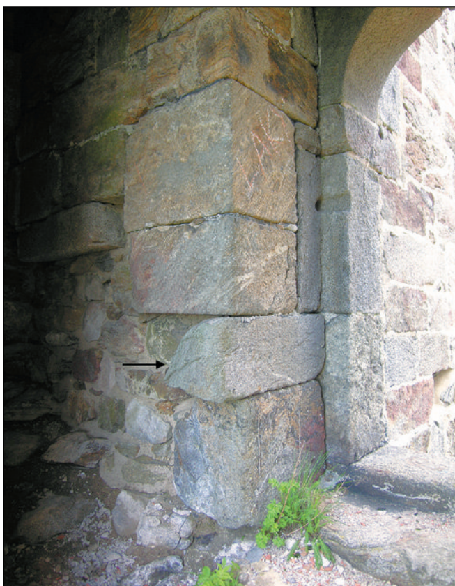
Obr. 18: Hrad Přimda, věž. Chodba k rizalitu, vpravo vnitřní portálek, v popředí nároží vstupu do předpokládaného převětu (srov. obr. 17). Šipkou označena část původního prahu (foto autor, 2008).
