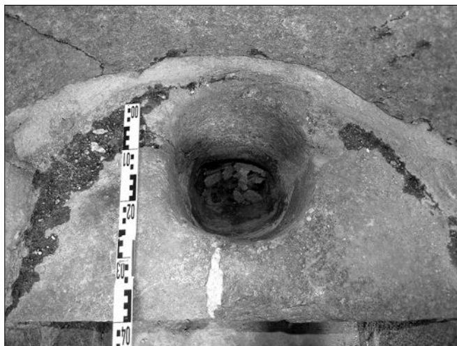
Obr. 31: Hrad Přimda, rizalit věže. Detail sedátka převétu s odpadním otvorem (foto autor, 2008).
