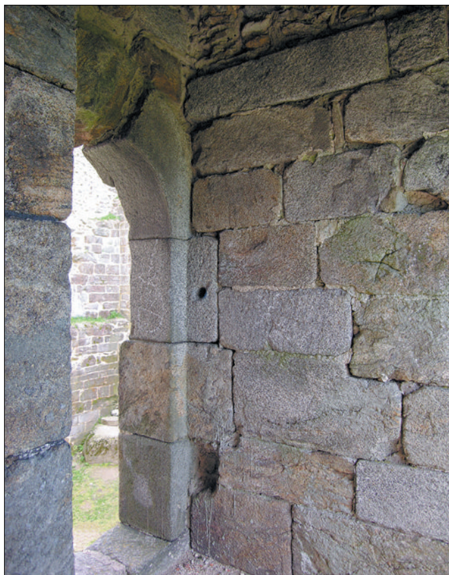
Obr. 17: Hrad Přimda, věž. Chodba k rizalitu, původní jižní stěna s vnitřním portálkem, vedle nějž jsou stopy druhotného uzavírání. Úroveň podlahy na tomto konci chodby i práh jsou původní. V popředí vlevo nároží vstupu do předpokládaného převětu (foto autor, 2008).
