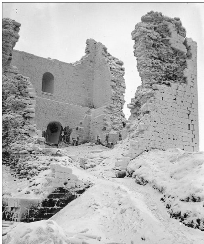
Obr. 6: Hrad Přimda, věž od jihozápadu, stav v průběhu rekonstrukce ve 20. letech 20. století. Srov. obr. 5.
