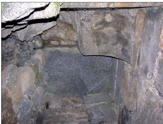
Obr. 25: Hrad Přimda, věž. Detailní pohled do prostoru chodby k prevétu (srov. obr. 24). Nahoře částí záklenků vstupu, pod nimi deska stropu, dole horní část zadní stěny se dvěma původními kvádry a novodobým lomovým zdivem (foto autor, 2008).
