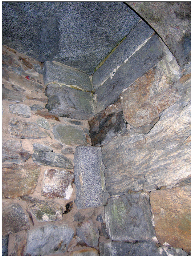
Obr. 24: Hrad Přimda, věž. Detailní pohled do severovýchodního kouta chodby k prevétu (srov. obr. 23). Nahoře novodobá deska stropu, v koutě původní kvádry obou vzájemně kolmých líců východní a severní stěny, vlevo novodobé zdivo zadní strany prostoru (foto autor, 2008).
