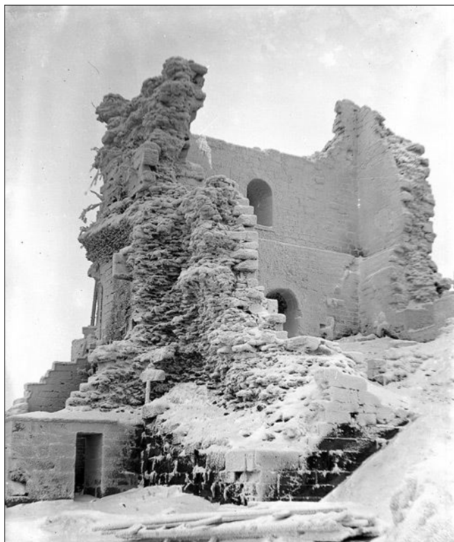
Obr. 5: Hrad Přimda, věž od jihozápadu, stav v průběhu rekonstrukce ve 20. letech 20. století. Pozoruhodný je zejména stav horní části zbytků dynníku krbu a zříceně severozápadní nároží věže v úrovni 1. patra (fotoarchív ÚP NPÚ).
