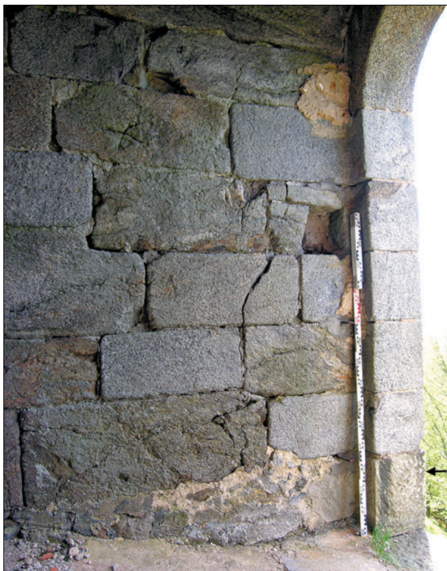
Obr. 16: Hrad Přimda, věž. Chodba k rizalitu, původní jižní stěna s vnějším portálkem a mělkou kapsou pro závoru. Původní podlaha zanikla, dnešní pochozí plocha šikmo klesá směrem ven. V dolní části portálku (označeno šipkou) odsekaný práh (foto autor, 2008).
