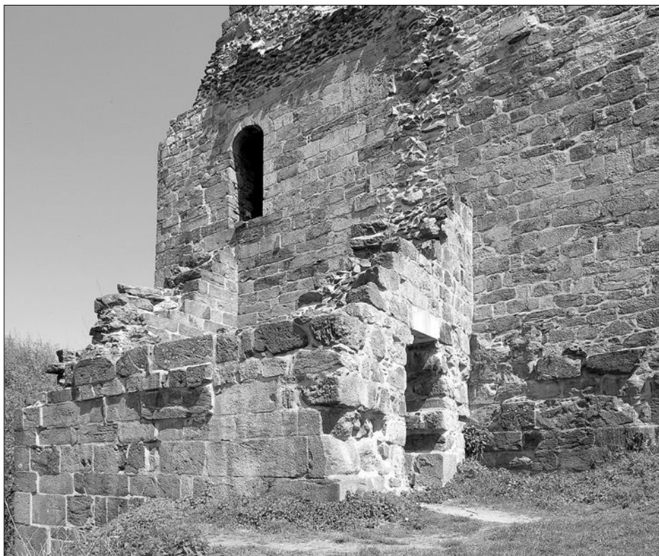
Obr. 27: Hrad Přimda, rizalit věže. Celkový pohled od jihozápadu (foto autor, 2008).
