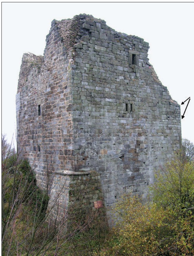
Obr. 9: Hrad Přimda, věž od severovýchodu. V popředí na nároží renesanční opěrák, šípkami označena část severozápadního nároží rekonstruovaná ve 20. letech 20. století (foto autor 2007).
