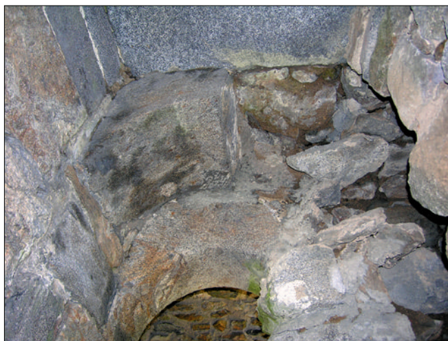
Obr. 26: Hrad Přimda, věž. Detailní pohled do prostoru chodby k prevétu, opačný než obr. 25. Nahoře část desky stropu, pod ní dvojitý, stupňovitý záklenek vstupu (foto autor, 2008).
