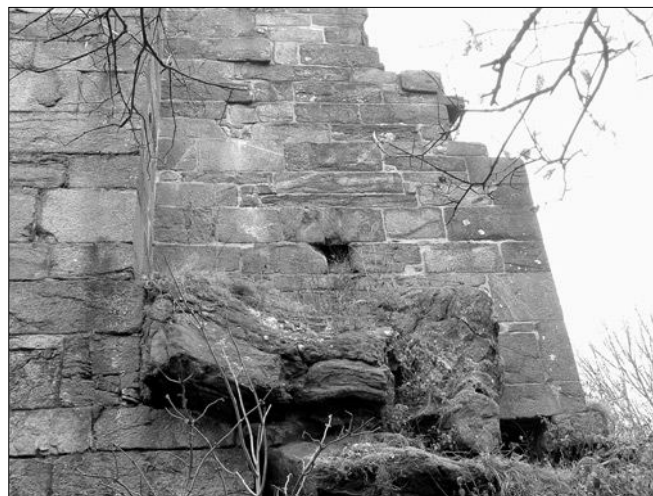
Obr. 32: Hrad Přimda, rizalit věže. Severní průčelí s vyústěním odpadního otvoru převétu (foto autor, 2007).
