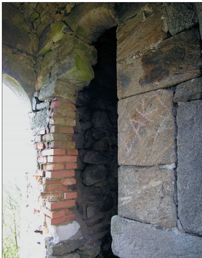
Obr. 20: Hrad Přimda, věž. Chodba k rizalitu, vpravo vstup do předpokládaného převětu. Dole zbytek prahu, vlevo novodobá část zdiva a záklenek vnějšího portálku (srov. obr. 18; foto autor, 2008).
