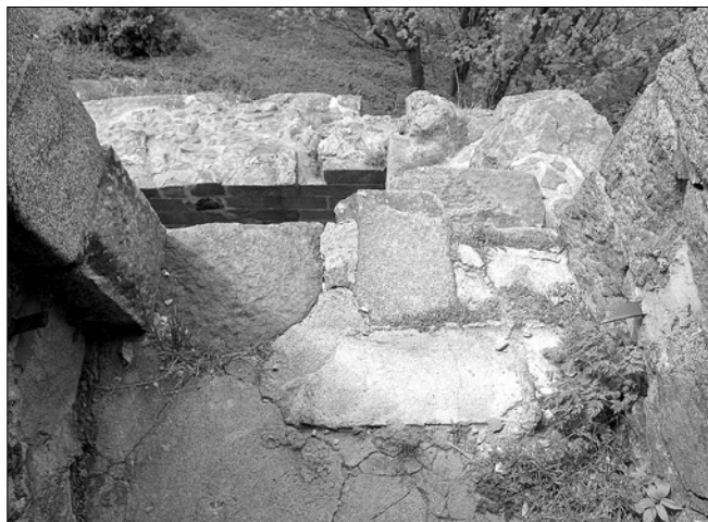
Obr. 36: Hrad Přimda, rizalit věže. Detailní pohled na dolní část vstupního portálu do věže. Vlevo odsekaný práh (srov. obr. 16), uprostřed vyčnívající kámen (srov. obr. 22 vlevo, 34, 35), stojka upravo novodobá (foto autor, 2008).
