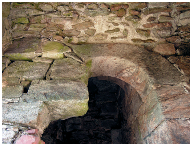
Obr. 21: Hrad Přimda, věž. Detail horní části vstupu do předpokládaného převětu (srov. obr. 20). Levá část záklenku i navazující zdivo jsou novodobě vyzděny (foto autor, 2008).
