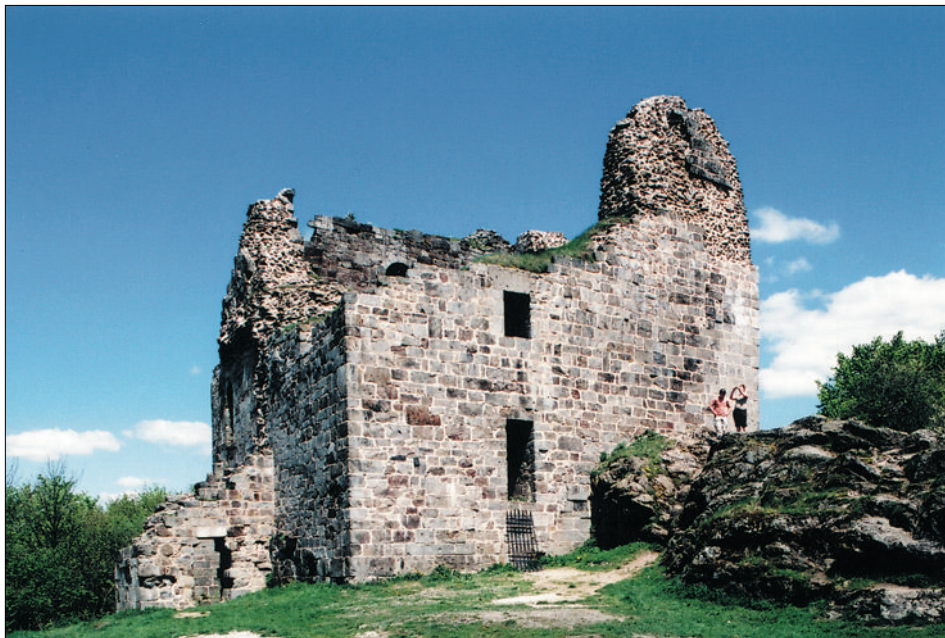
Obr. 8: Hrad Přimda, věž od jihozápadu (srov. obr. 3), dnešní stav po rekonstrukcích (foto autor, 2008).
