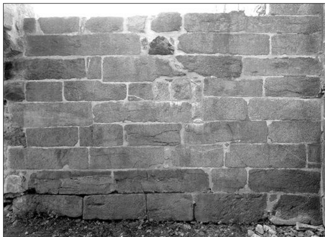
Obr. 28: Hrad Přimda, rizalit věže. Celkový pohled na vnitřní stěnu západní zdi. Struktura zdiva nasvědčuje tomu, že zde nebylo původní okénko (foto autor, 2008).
