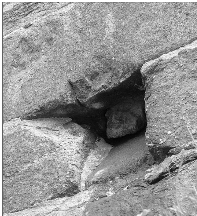
Obr. 33: Hrad Přimda, rizalit věže. Detail vyústění odpadního otvoru převétu (srov. obr. 32, foto autor, 2008).
