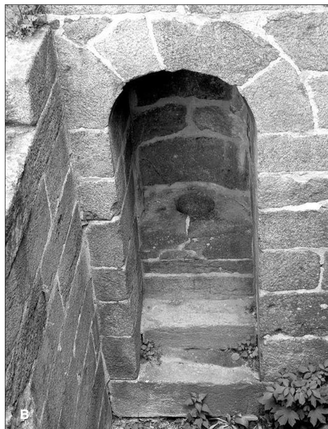
Obr. 29: Hrad Přimda, rizalit věže. A – celkový pohled do interiéru, vlevo prevét, vpravo sedátko ve výklenku; B – detail prevétu (foto autor, 2008).
