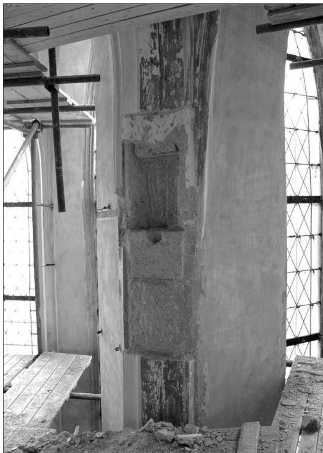
Obr. 12: Sedlec, kostel Nanebevzetí Panny Marie, sonda na stěně mezi kaplemi č. 3 a 4 v partii paty arkádového oblouku. Gotická svazková přípora sbíhající až k zemi byla v baroku osekána a přerušena kapsou pro uložení cihelné konstrukce oblouku. V patě výběhu původního oblouku bylo osazeno železné táhlo, po jehož háku se ve zdivu dochoval otvor, které zajišťovalo stabilitu původní podpory na místě barokního toskánského sloupu. Zachycena je také změna při barokně gotickém tvarování oblouku v omítce (foto A. Pospíšil, 2008).
