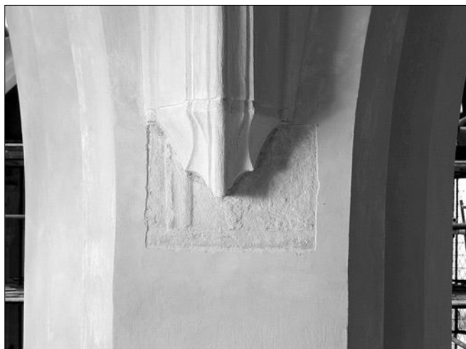
Obr. 11: Sedlec, kostel Nanebevzetí Panny Marie, sonda na pilíři chóru ze strany ochozu na jižní straně kostela. Výběh žeber hruškového profilu gotické klenby ochozu, který byl při barokní obnově kostela z větší části osekán. Výběh se skládá ze dvou diagonálních žeber křížových kleneb polí ochozu a středního meziklenebního žebra (foto A. Pospíšil, 2008).
