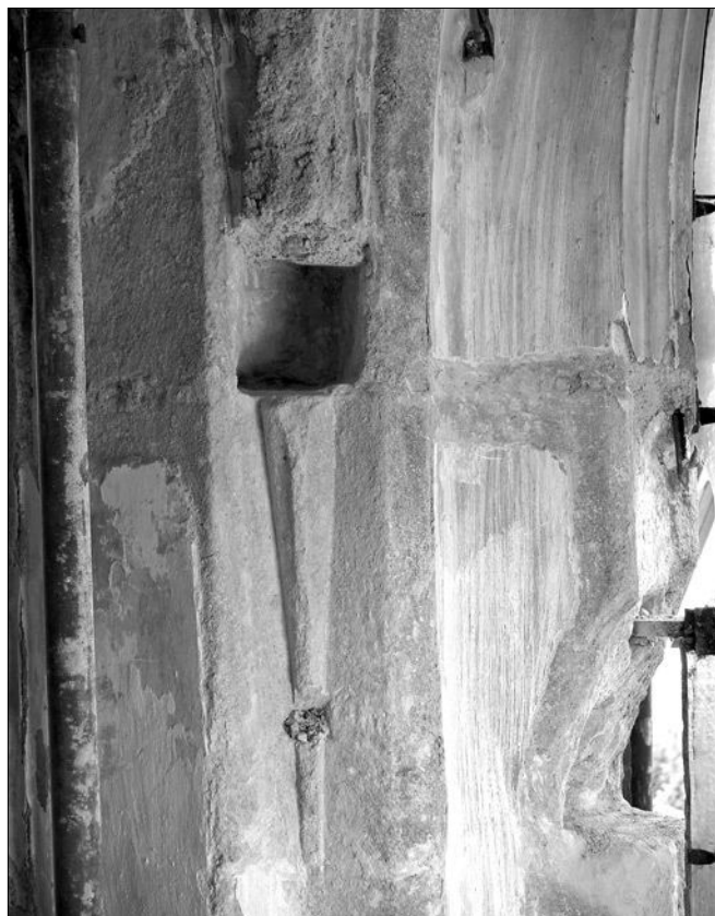
Obr. 9: Sedlec, kostel Nanebevzetí Panny Marie, sonda na stěně mezi okny kaple č. 4. Výběh žebra hruškového profilu gotické klenby byl při barokní obnově kostela přerušen kapsou určenou pro uložení cihelné konstrukce barokní klenby. Vpravo je zachyceno ostění osového okna kaple s mělkým výžlabkem v základku pro osazení kružby a kapsa vysekaná pro odstranění táhla (foto A. Pospíšil, 2008).
