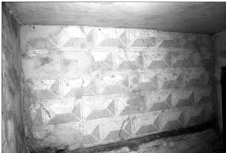
Obr. 13: Toušeň, čp. 30. Detail horní části někdejšího průčelí jižního rizalitu, jež bylo zakryto připojením v půdoryse lichoběžné přístavby (foto J. Veselý, 2002).
