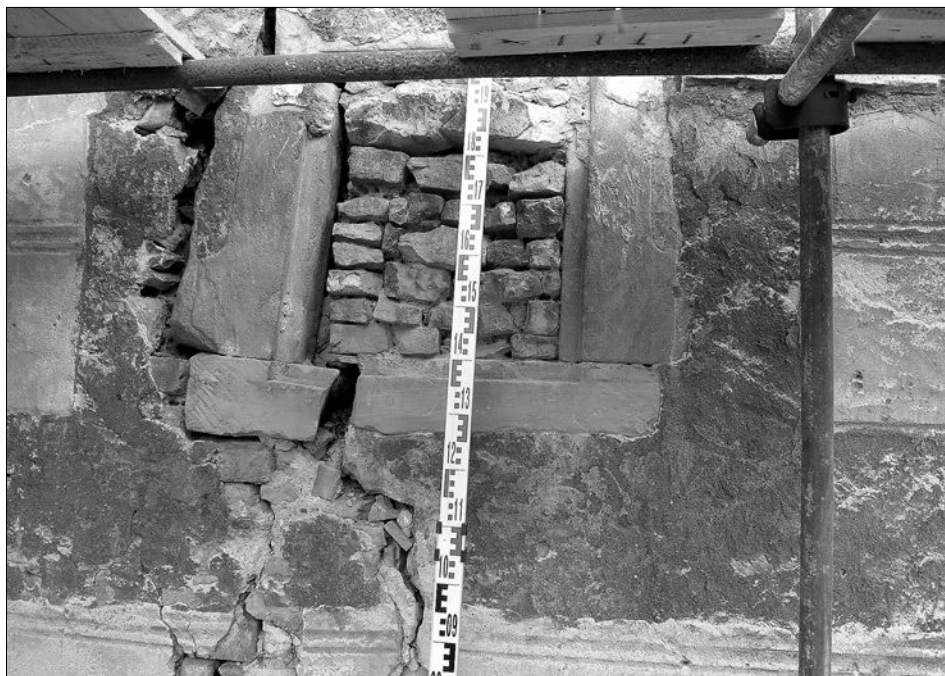
Obr. 15: Toušeň, čp. 30. Detail jižního průčelí s ostěním okna patra (foto J. Kypta, 2006).
