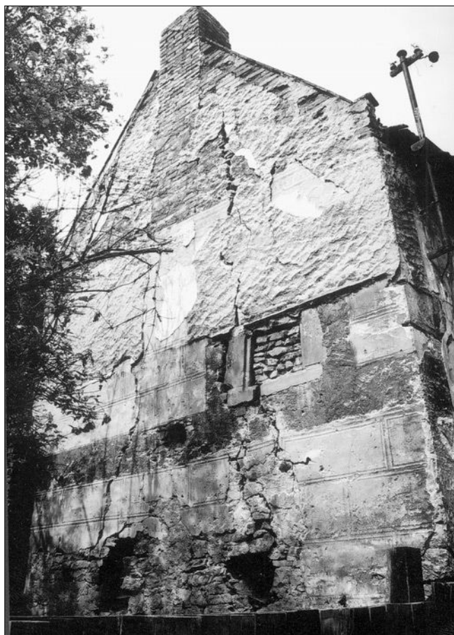
Obr. 14: Toušeň, čp. 30. Jižní průčelí (foto J. Pešta, 2002).
