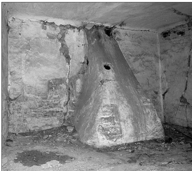
Obr. 19: Toušeň, čp. 30. Interiér patra s tělesem dymníku nad ústím exteriérové pece (foto J. Veselý, 2002).
