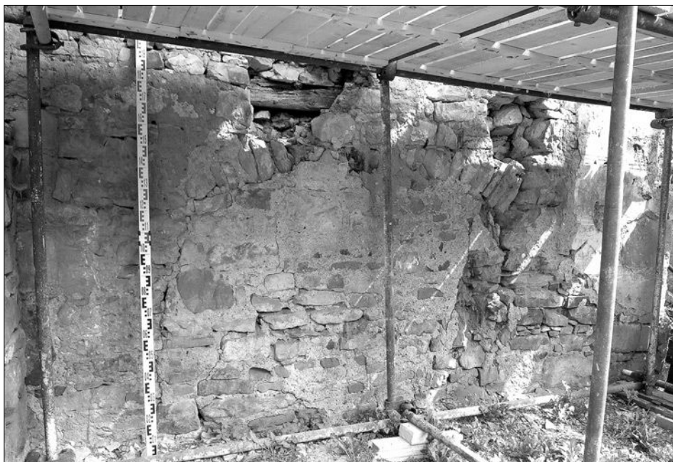
Obr. 17: Toušeň, čp. 30. Detail jižního průčelí se zadržkou rozměrného otvoru, jímž prostupovalo těleso exteriérové pece. Nad vynášecím pasem je obnažena část kleštiny (foto J. Kypta, 2006).
