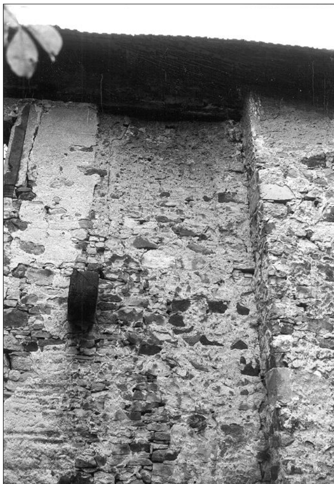
Obr. 11: Toušeň, čp. 31. Detail západní fasády se zadržkou průchodu do zaniklého arkýře (foto J. Veselý, 2002).
