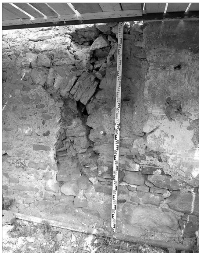
Obr. 18: Toušeň, čp. 30. Detail jižního průčelí. Vlevo od měřítka je zřetelný fragment pláště ubourané exteriérové pece, vpravo fragmenty náběhů omítky se sgrafitovou výzdobou ke stěně zaniklého přístřešku pece (foto J. Kypta, 2006).
