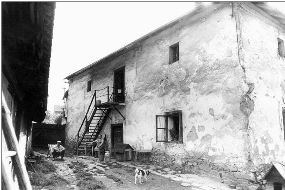
Obr. 6: Toušeň, čp. 31. Východní průčelí. Těsně pod korunou zdi jsou patrné obrysy čel odřezaných zhlaví stropních trámů. Na pravém nároží vyčnívá tesaná konzola (foto V. Hejda, 1974, snímek přiložený k plánové dokumentaci [viz popiska obr. 2]).
