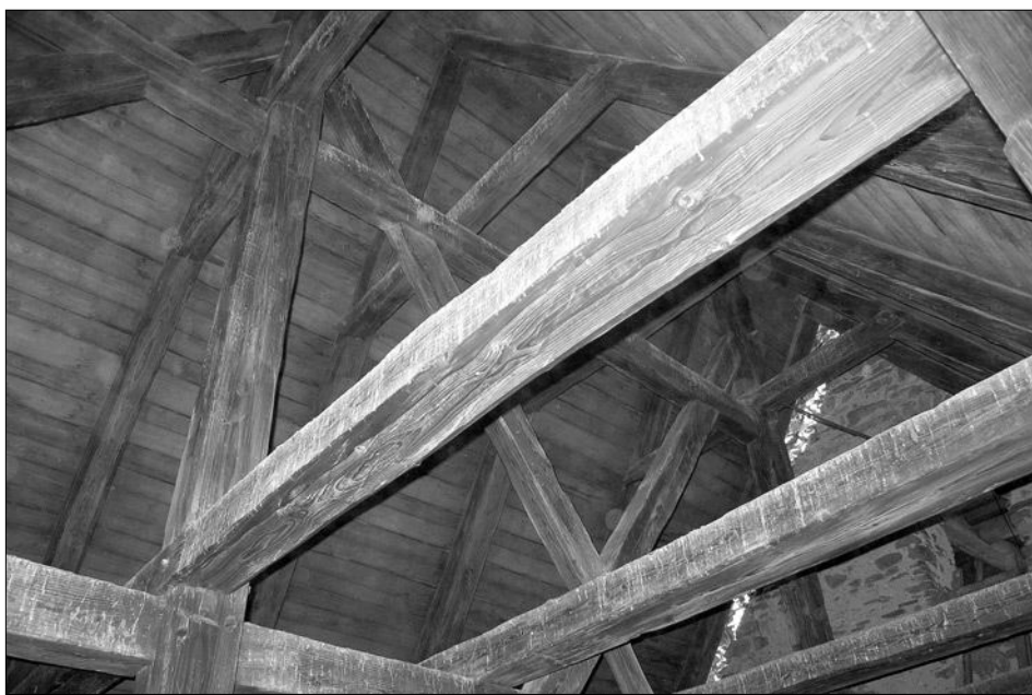
Obr. 11: Malín, kostel sv. Jana Křtitele, konstrukce krovu nad lodí.
