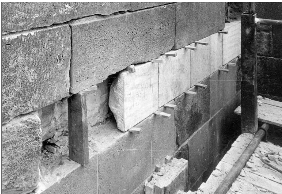
Obr. 6: Oprava zvětralých kvádrů Karlova mostu plombami z božanovského pískovce (foto V. Rybařík, květen 1987).
