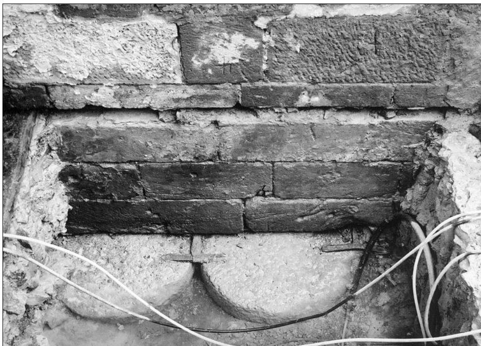
Obr. 3: Část sestavy mlýnských kamenů ze železitého křídového pískovce v základu 9. pilíře Karlova mostu (foto J. Zavřel, 2005).
