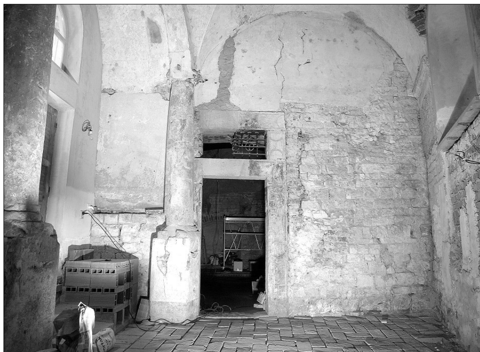
Obr. 23: Tzv. Juditina věž, Praha - Malá Strana; část východní fasády věže viditelná z prostoru přízemí arkádové loggie severního křídla domu čp. 56/III. Uprostřed portál vstupu do přízemí věže, jehož levá stojka je zakryta sloupem arkády. Vpravo od portálu odhalené kvádřikové zdivo věže se 3 kapsami po stropní konstrukci starší celnice v úrovni jeho horního překladu. Vlevo dole, při patě sloupu arkády, patrný nevelký úsek líce kvádřikového zdiva (foto J. Veselý, 2006).
