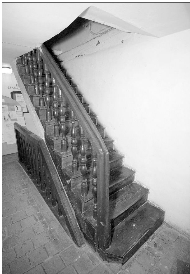
Obr. 28: Tzv. Juditina věž, Praha - Malá Strana; schodiště z druhého do třetího patra s pozdně renesančním kuželkovým zábradlím. Schody mají archaickou nosnou konstrukci s masivními tesanými stupni přibíjenými na trámové schodnice (foto V. Tůt, 2008).
