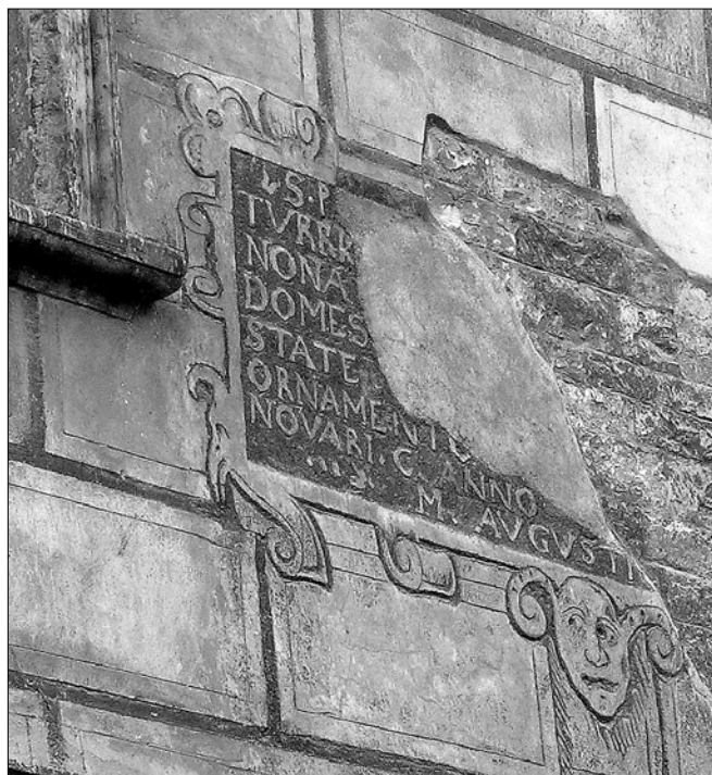
Obr. 15: Tzv. Juditina věž, Praha - Malá Strana; detail zbytku nápisové kar- tuse mezi okny třetího patra východní fasády (foto J. Veselý, 2008).
