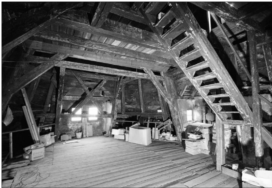
Obr. 30: Tzv. Juditina věž, Praha - Malá Strana; celkový pohled do prostoru půdy v úrovni pod prvními hambalky krovu. Vpravo původní renesanční schodiště do prvního patra krovu (foto V. Tůt, 2008).
