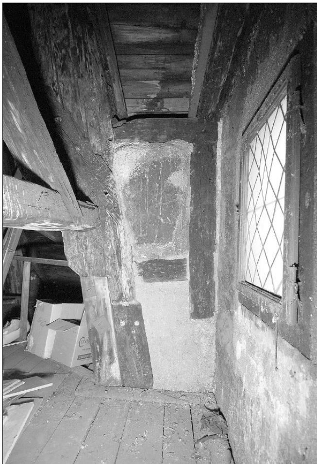
Obr. 31: Tzv. Juditina věž, Praha - Malá Strana; hrázděná konstrukce východní stěny jižního vikýře. Pata krokve valby (vlevo) je nastavena dubovou protézou z počátku 17. století (foto J. Veselý, 2008).
