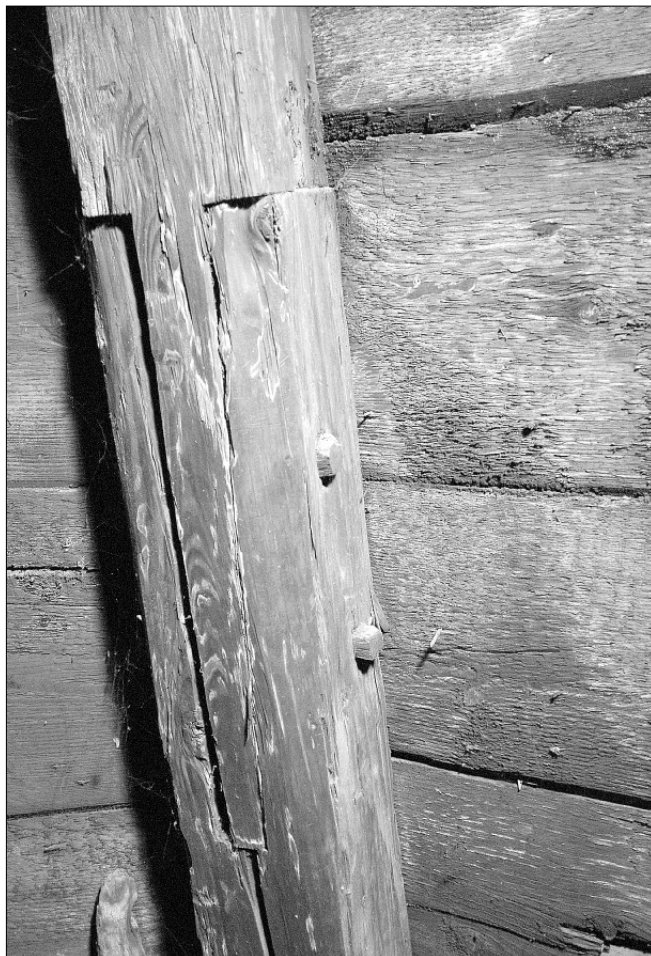
Obr. 32: Tzv. Juditina věž, Praha - Malá Strana; detail originálního nastavení hlavních krokve krovu v úrovni mezi druhým a třetím hambalkem. Oba díly jsou vzájemně spojeny klínovitým vloženým čepem, zajištěným dvojicí dřevěných hřebů (foto V. Tůtr, 2008).
