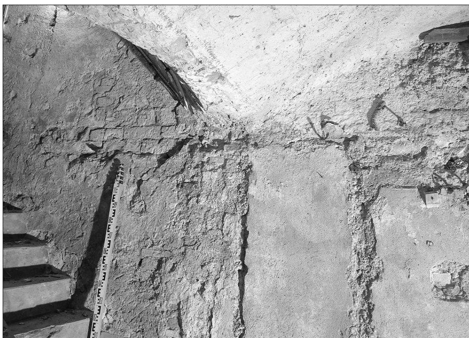
Obr. 21: Tzv. Juditina věž, Praha - Malá Strana; detail jižní stěny sklepa při vyústění schodišťové šije. Nahore klenba sklepa. Vlevo neveliký odhalený úsek líce kvádrkového zdiva, končící zhruba v úrovni vrcholu nívelační latě. V této úrovni se pravděpodobně nacházela podlaha románského přízemí. Předstupující nerovný líc zdiva pod ní, vyrovnávaný a doplňovaný pod stávající omítkou úlomky cihel i kamene, náleží již původně základové partii zdiva (foto J. Veselý, 2008).
