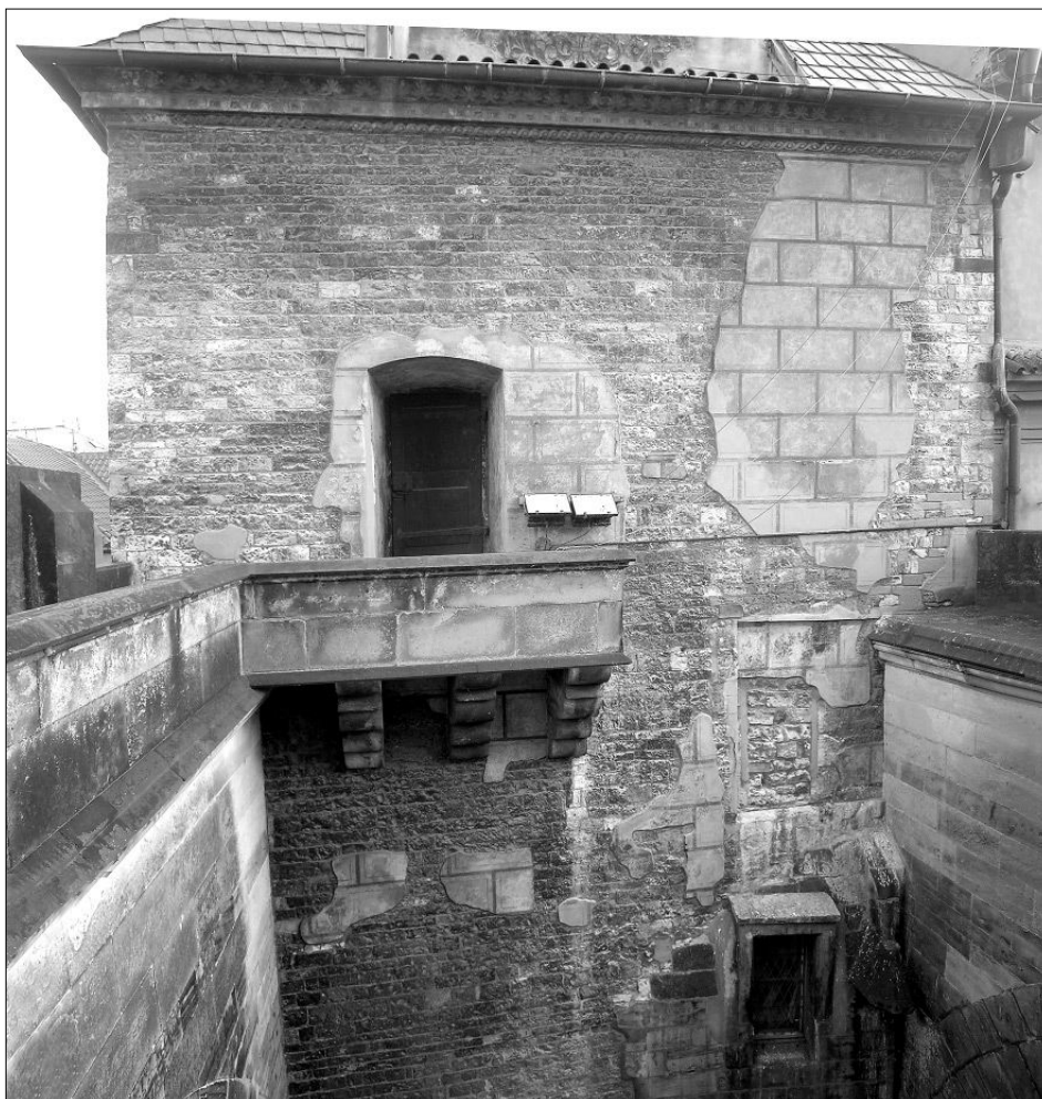
Obr. 18: Tzv. Juditina věž, Praha - Malá Strana; horní část severní fasády, v pohledu z ochozu brány. Románské kvádříkové zdivo dosahuje až k renesanční korunní římsě. Řádky zdiva jsou vůči líně římsy skloněny nepatrně k východu. V pravé části snímku jsou dobře patrné výškové vztahy ukončení kvádřové přízdívky a vpadliny portálu druhého patra k ochozu brány (foto J. Veselý, 2008).
