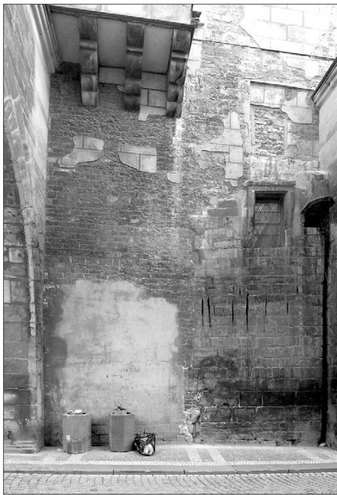
Obr. 16: Tzv. Juditina věž, Praha - Malá Strana; spodní část severní fasády věže, sevřená mezi oblouky brány. V přízemí vlevo zazdívká někdejšího výkladce, nad zazdívkou neporušené románské kvádřikové zdivo věže s nepatrnými zbytky renesanční omítky, zachovanými především pod ochozem brány. Vpravo gotická přízdívka z pravidelných kvádrů ukončená pilířem západního oblouku. Ve hmotě přízdívky je realizována drážka pro „hřeben“. Vpravo nahoře je patrná situace v okolí skarpovitěho ukončení přízdívky, s obdélným otvorem, zakrytým vykonzolovaným baldachýnem a s mladším oknem kuchyně prvního patra (v místě staršího otvoru). Nad přízdívkou, ve vlastním zdivu věže, je obdélné vpadlé pole se zazděným portálkem 2. patra (foto J. Veselý, 2008).
