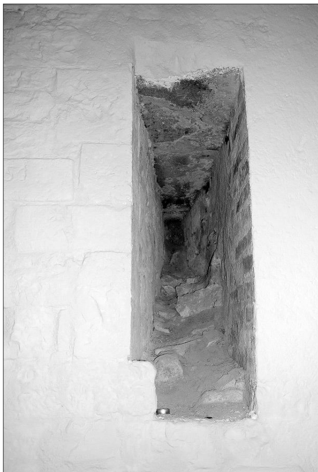
Obr. 24: Tzv. Juditina věž, Praha - Malá Strana; románské okénko někdejšího prvního patra v jižní stěně dnešního přízemí. Levá špaleta okna je původní, pravá, cihelná souvisí až s obnovením otvoru v 60. letech 20. století. V hloubi niky patrný dochovaný malý úsek původní pravé špalety. Překlady niky jsou původní, z červeného pískovce (foto J. Veselý, 2008).
