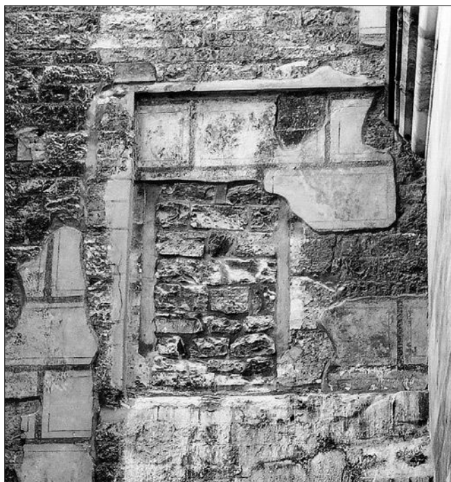
Obr. 17: Tzv. Juditina věž, Praha - Malá Strana; detail vpadlého pole se zazděným portálkem v severní fasádě věže, pod ochozem západního oblouku mostecké brány. V úrovni 100 cm nad prahem portálku probíhá zřetelná hraničnice mezi lícem zdiva zasaženým a nezasaženým ohněm. Zarudnutí od ohně jeví od příslušné úrovně i zazdívká portálu (foto V. Razím, 2003).
