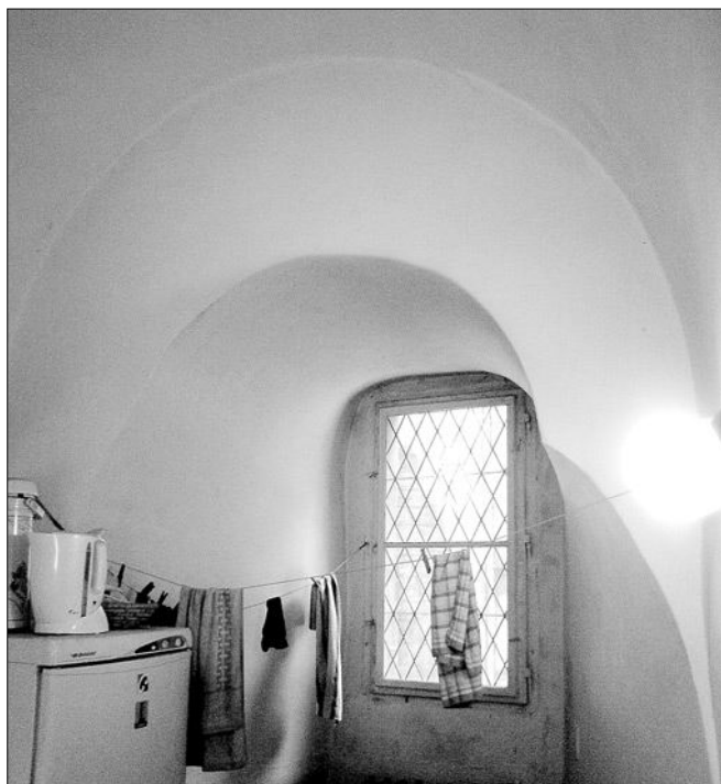
Obr. 27: Tzv. Juditina věž, Praha - Malá Strana; horní část niky okna kuchyně v prvním patře věže. Nika je ve spodní části druhotně rozšiřovaná, původní je mírně nepravidelný půlkulatý záklenek. V souvislosti s osazením renesančního okenního ostění byl záklenek při vnějším líci stěny přisekán (foto J. Veselý, 2008).
