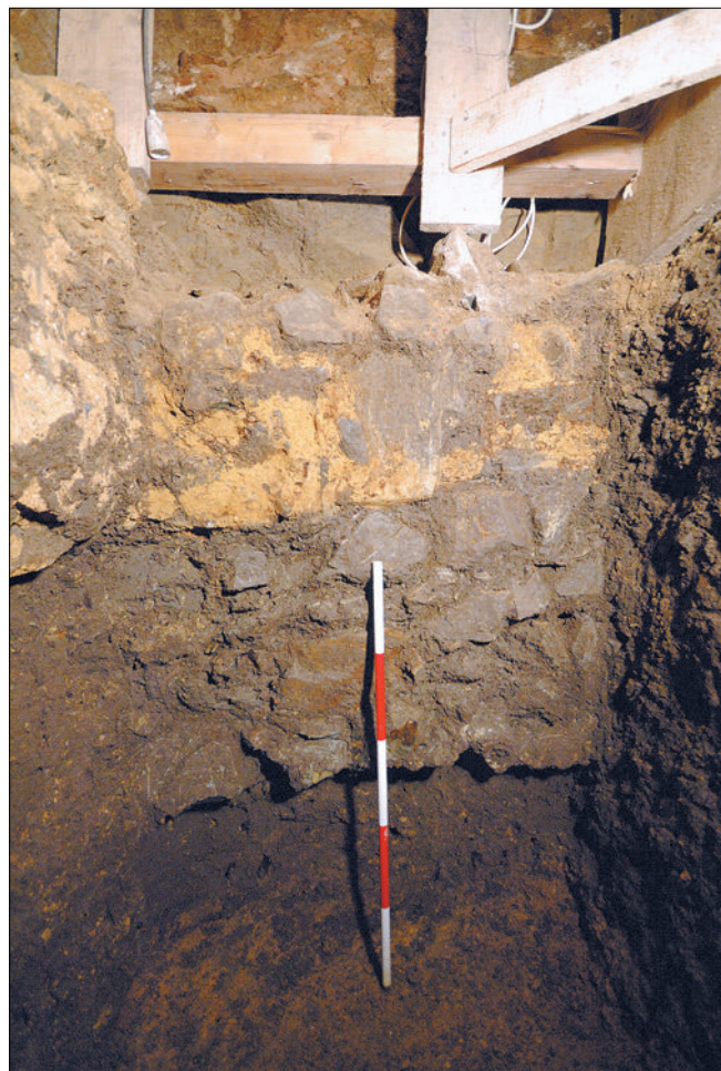
Obr. 20: Křivoklát, hrad. Detail základového zdiva hlavní hradby v S 4/06. Dobře je patrné rozhraní mezi úseký pojenými maltou a pouze hlínou, srov. obr. 18: G (foto Z. Neustupný).
