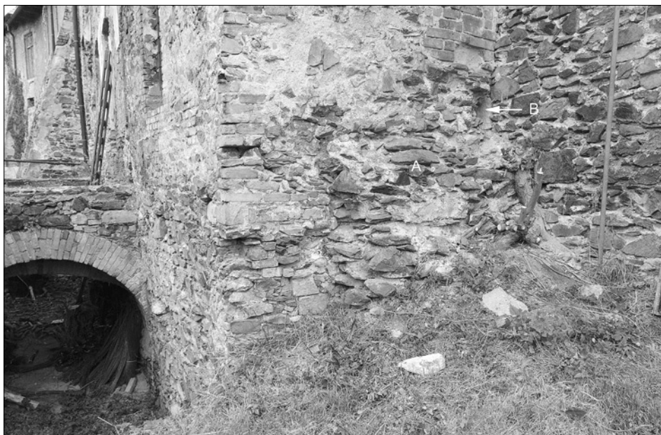
Obr. 33: Křivoklát, hrad. Detail obr. 32. A – torzo obvodové hradby, B – armování severozápadního nároží hranolové věže (foto Z. Neustupný).
