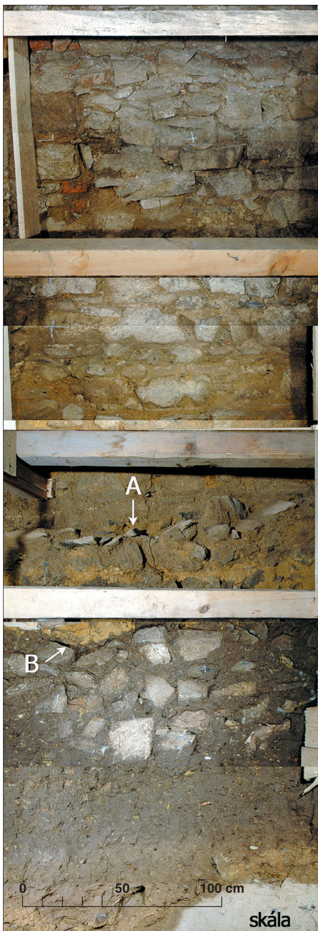
Obr. 14: Křivoklát, hrad. Stěna hlavní hradby v S 3/05. A – nepravidelná hrana předzákladu; B – rozhraní v základovém zdivu (foto a sestavení v počítači V. Tutr).
