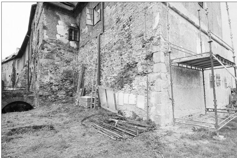
Obr. 32: Křivoklát, hrad. Pohled na jihozápadní nároží věže v koutě tzv. dolního hradu. Novodobá nástavba je oddělena výrazným ústupkem (foto Z. Neustupný).
