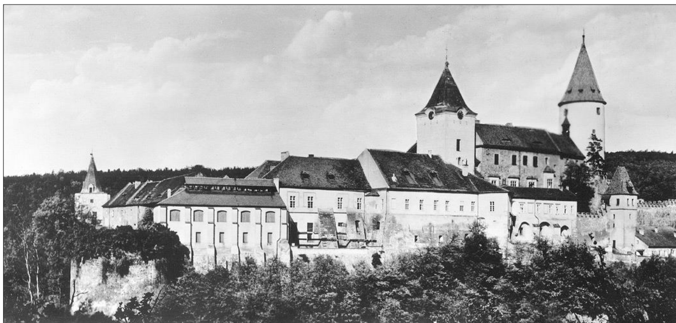
Obr. 1: Křivoklát (okres Rakovník), hrad. Celkový pohled od jihozápadu, v levé části snímku zachycena budova později zbořeného tzv. nového pivovaru (foto D. Kusák, 50.–60. léta 20. století, pohlednice).
