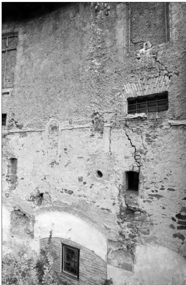
Obr. 34: Křivoklát, hrad. Detail západního průčelí tzv. purkrabství se zděnými románskými okénky (foto Z. Neustupný).
