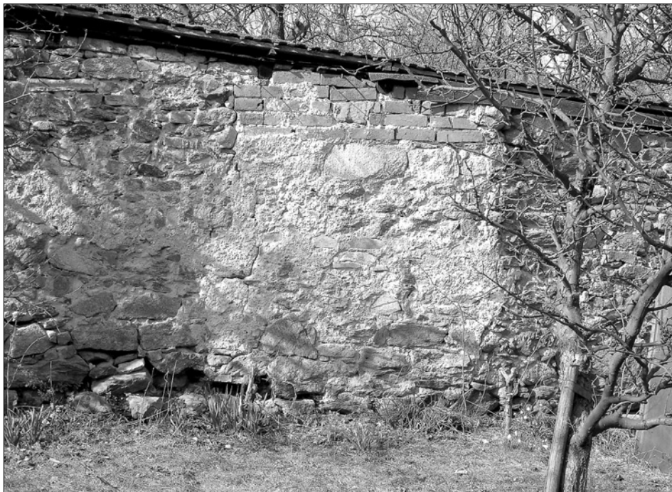
Obr. 18: Telč, fragment hlavní hradby, dochovaný v novodobé zdi mezi parcelami domů čp. 48 a 49 (pohled od čp. 48). Metodicky pozoruhodný doklad důležitosti pečlivého průzkumu v sítích (i zdánlivě bezcenných) stavebních konstrukcí v městské zástavbě (foto V. Razím, 2007).
