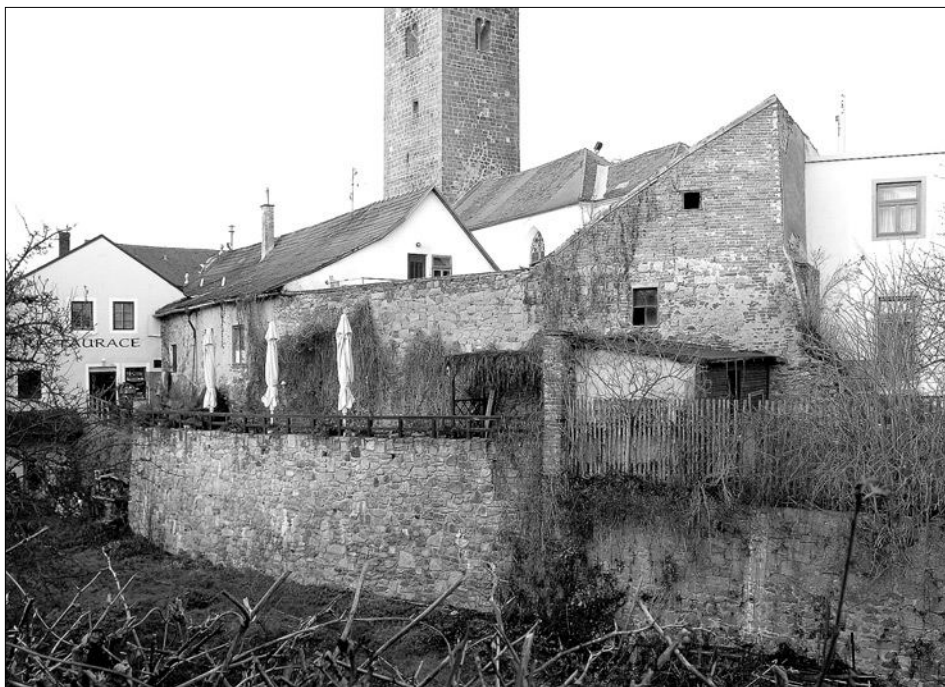
Obr. 37: Telč, pohled přes příkop směrem k domům čp. 38 (upravo), 28 (uprostřed) a 116 (vlevo). V pozadí kostel sv. Ducha s románskou věží. V popředí nově vyzděná eskarpa příkopu, nad ní hlavní hradba s náběhem oblouku (upravo, srov. obr. 38) (foto V. Razím, 2007).
