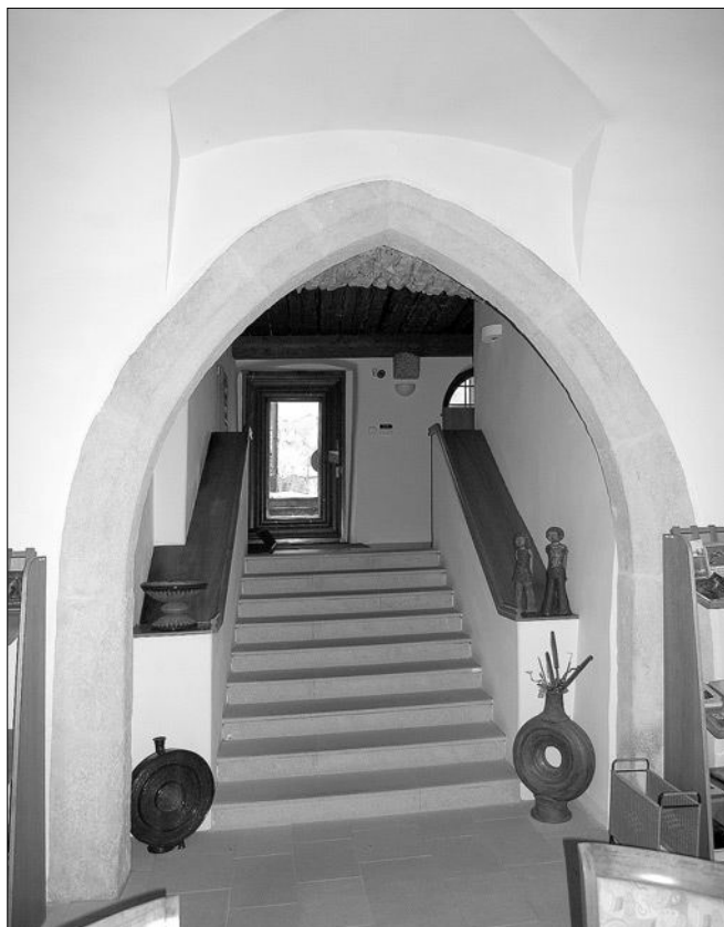
Obr. 25: Telč, portál (branka) v linii hlavní hradby v budově bývalého jezuitského semináře, vnější strana (foto V. Razím, 2007).
