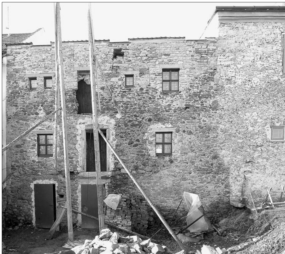
Obr. 17: Telč, průčelí zadního domu čp. 61, pohled od Novoměstského rybníka. Dům využil jako jednu ze svých obvodových zdí hlavní hradbu. Stav během obnovy omítky (vpravo čp. 133) (foto V. Razím, 2007).
