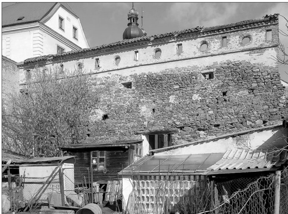
Obr. 14: Telč, úsek hlavní hradby za domem čp. 79. Autentický vnější líc. Pod cihelnou nástavbou oboustranně špaletované střílny v předprsí zídce (foto V. Razím, 2007).
