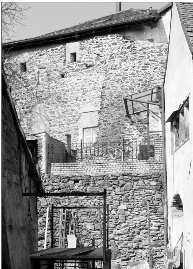
Obr. 11: Telč, pohled z příkopu na hlavní hradbu za čp. 27 (v pozadí, vpravo druhotný opěrný pilíř) a parkánovou hradbu (v popředí, vpravo čp. 115) (foto V. Razím, 2007).
