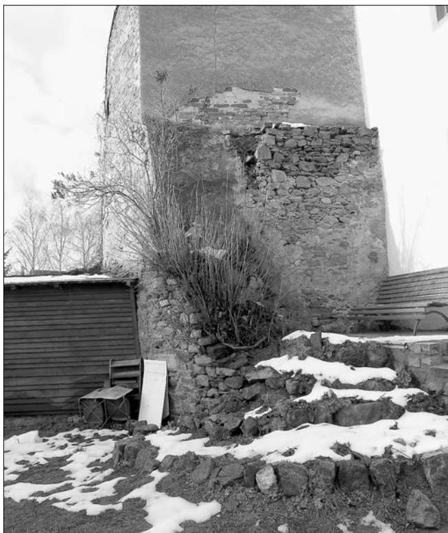
Obr. 38: Telč, obloukovitě probíhající hlavní hradba v místě jejího ubourání za čp. 38. Pohled od jihovýchodu (foto V. Razím, 2007).
