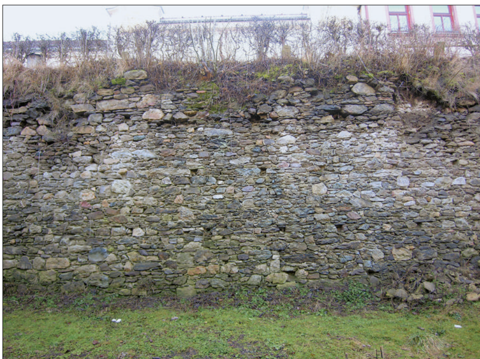
Obr. 28: Telč, kontreskarpa příkopu na jihovýchodní straně města, naproti čp. 38. Autentický líc zdiva s vodorovnými řadami otvorů po lešení (foto V. Razím, 2006).
