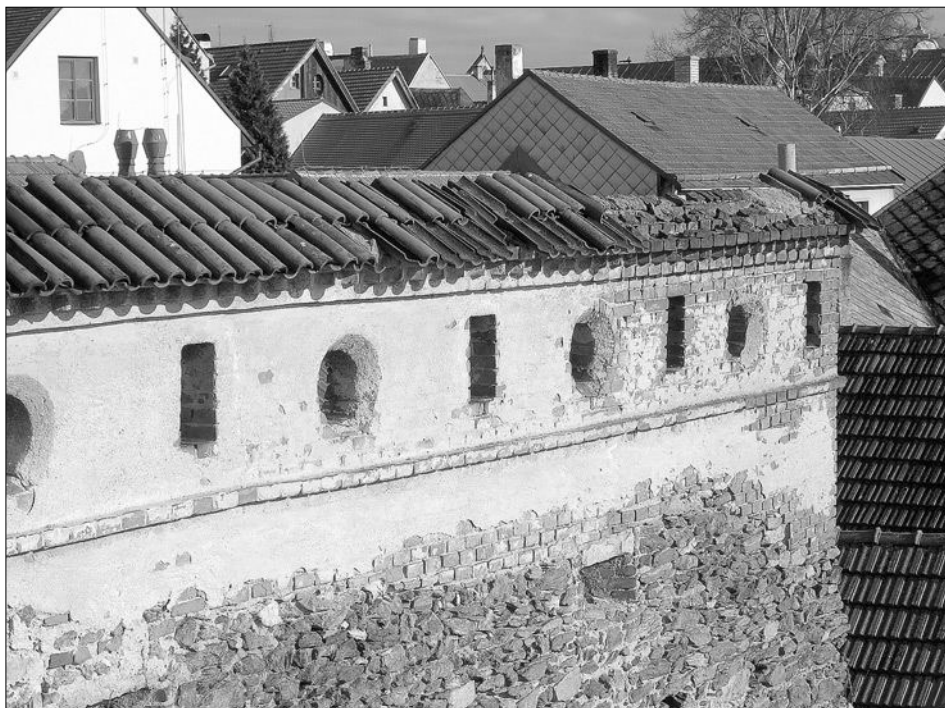
Obr. 15: Telč, úsek hlavní hradby za domem čp. 79. Detail vnější strany cihelné nástavby s prežovou stříškou (foto V. Razím, 2007).
