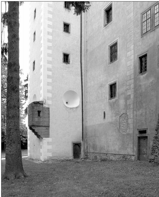
Obr. 32: Telč, pozdně gotická věž, která vystupuje ze severovýchodního nároží jádra hradu. V patře arkýřový prevet a jeden z pozoruhodných trychtýřových otvorů (foto V. Razím, 2007).
