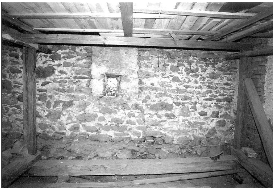
Obr. 13: Telč, hlavní hradba. Detail vnitřní strany neomítnutého cimbuří v podstřeší domu čp. 118. Uprostřed zazděná proluka se střílnou, dole odlámaný ochoz (foto V. Razím, 1999).
