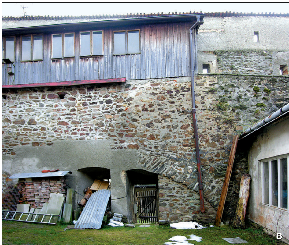
Obr. 12: Telč, hlavní hradba s rozměrným vynásecím pasem západně od čp. 27. A – vnější, B – vnitřní strana (foto V. Razím, 2007).
