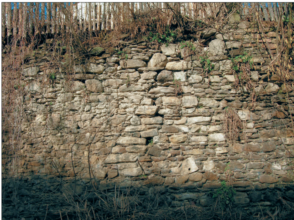
Obr. 27: Telč, eskarpa příkopu na jihovýchodní straně města, naproti čp. 38. Detail s šikmou spárou mezi dvěma etapami výstavby (foto V. Razím, 2007).
