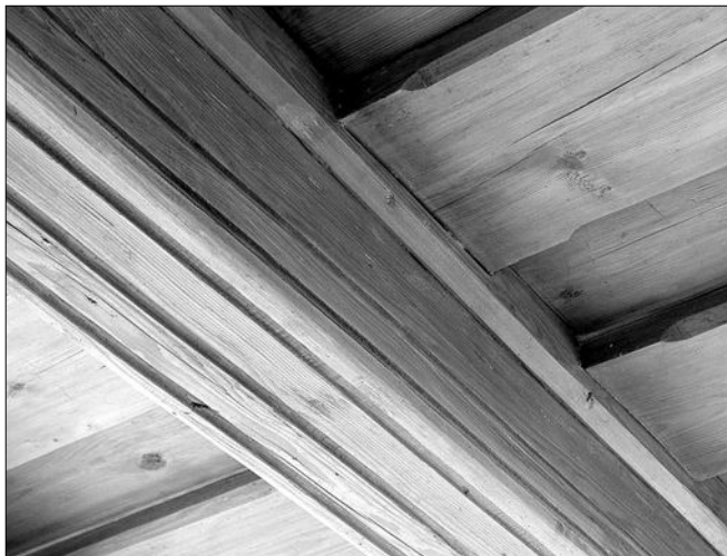
Obr. 2: Telč, Vnitřní Město, dům čp. I/56. Detail dřevěného stropu s překládaným deskovým záklopem (1661+ d) nad nejvyšším podlažím dvorního dílu domu (foto J. Bláha, 2008).
