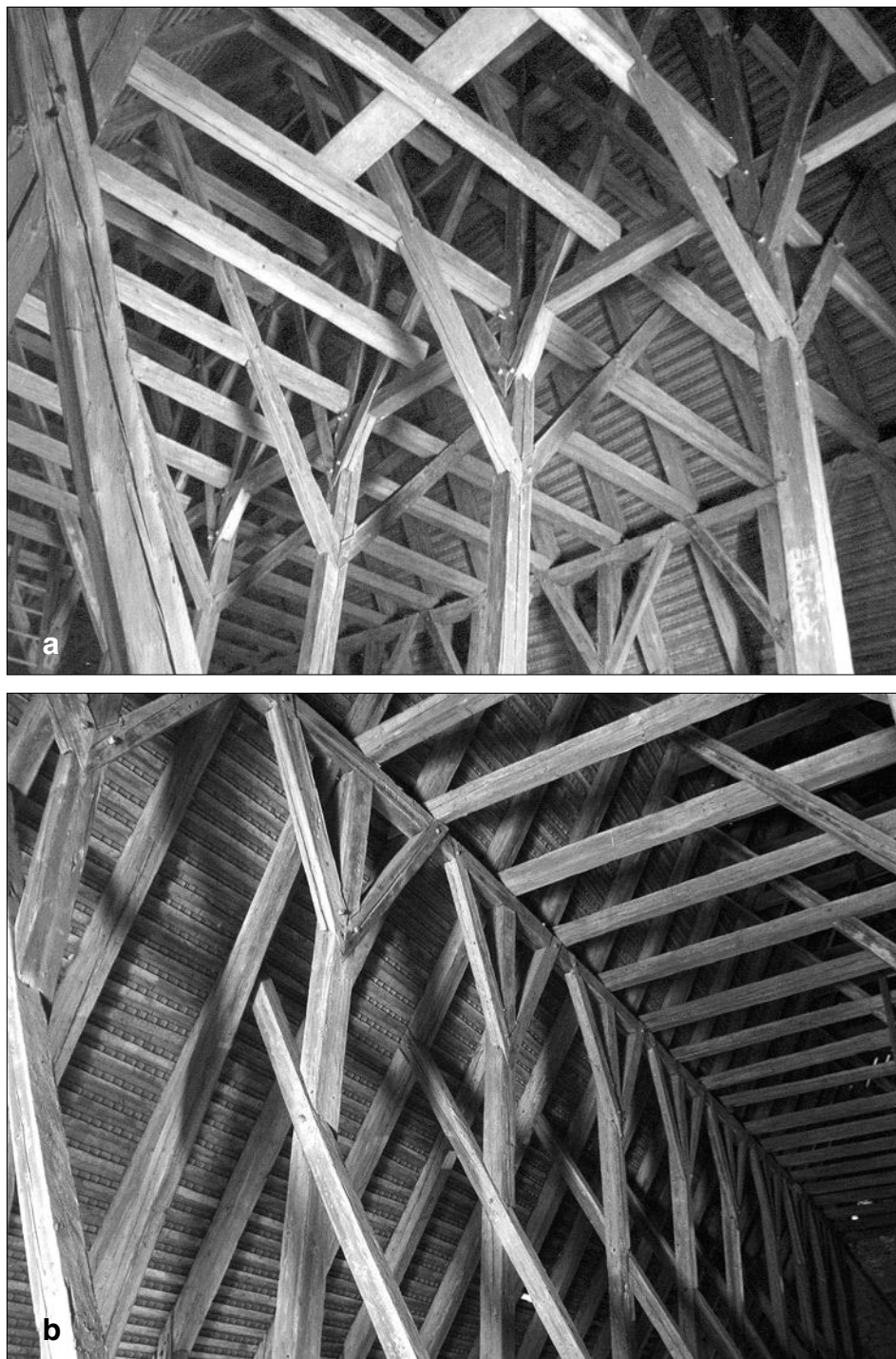
Obr. 5: Telč, kostel sv. Jakuba, krov nad hlavním dvojlodím (1464/65 d): a – pohled na hřebenovou stolicí podélného vázání; b – pohled na boční stolicí podélného vázání (foto J. Bláha 2008).
