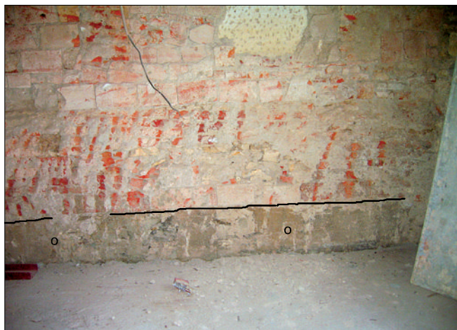
Obr. 7: Praha 1 – Staré Město, Vejvodova čp. 442. Pohled na otisky vložené dřevěné interiérové konstrukce s patrným výběhem při západní parcelní zdi objektu. O – otisky (foto M. Kovář).
