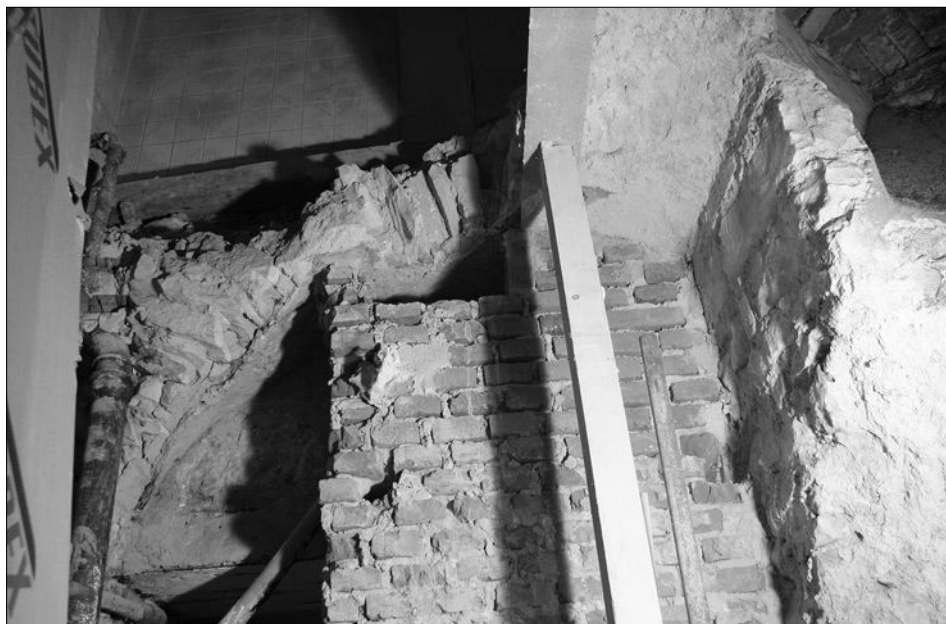
Obr. 9: Praha 1-Staré Město, Celetná ulice čp. 558/I. Pohled od severu do prostoru vstupní šije. Nahoře vlevo otvor po klenbě šije, odstraněné při vložení výtahu při minulé úpravě a zviditelňující řez klenbou, vpravo dochovaná část zaklenuté šije, podepřená recentní cihlovou příčkou (foto. M. Müller).
