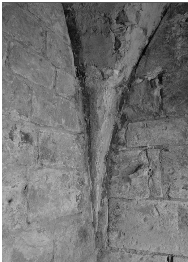
Obr. 8: Praha 1-Staré Město, Celetná ulice čp. 558/I. Detail tesaných prvků klenebního výběhu v jihovýchodním rohu místnosti 1. Pohled od severozápadu (foto J. Hlavatý).
