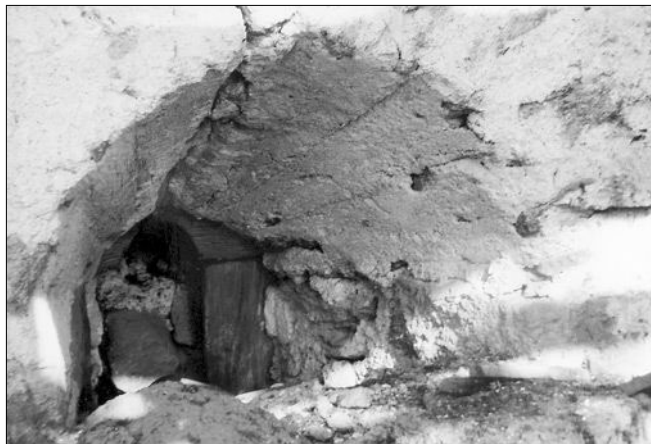
Obr. 5: Malý Bor (okres Klatovy), kostel sv. Maří Magdalény. Románské okénko v jižní stěně lodi s patrným dřevěným orámováním průzoru a otisky šalování na záklenku (foto J. Richterová, 2007).
