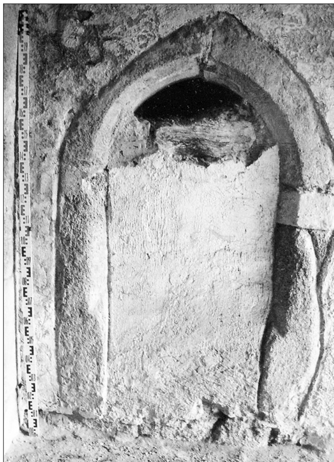
Obr. 1: Bor (okres Tachov), zámek, severní křídlo. Gotický boční portálek v západní stěně bývalého gotického průjezdu brány (foto J. Macek, 2007).
