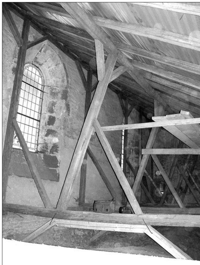
Obr. 8: Předklášteří u Tišnova (okres Brno – venkov), klášter Porta Coeli. Krov nad jižním křídlem ambitu a severní boční lodí kostela Nanebevzetí Panny Marie. Průhled krovem na severní stěnu hlavní lodí kostela (foto L. Šabatová, 2007).
