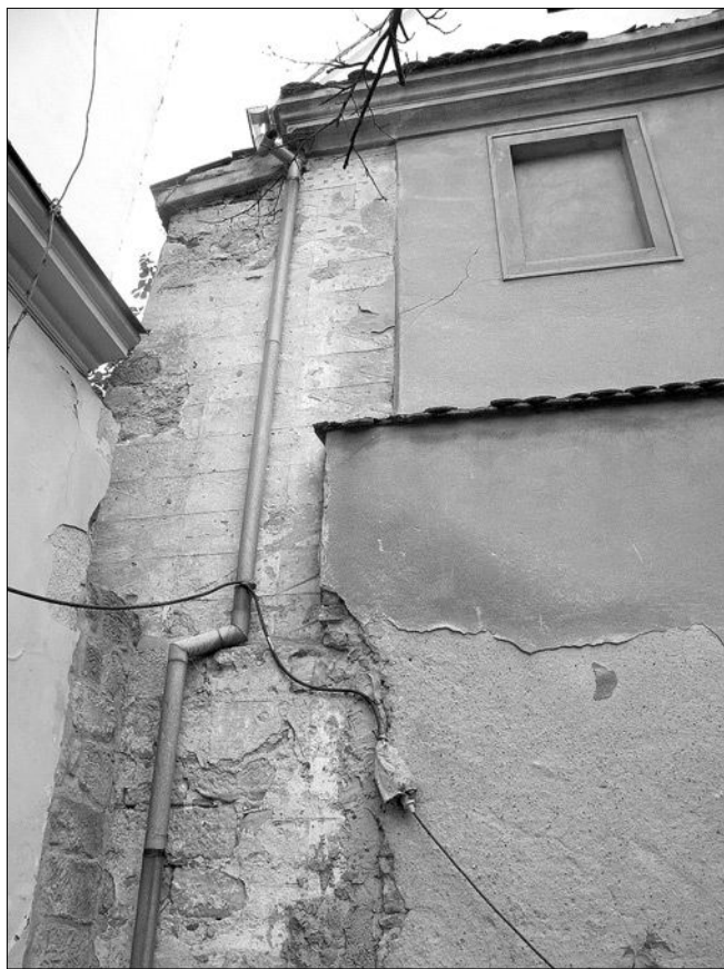
Obr. 9: Ústě (okres Litoměřice), hrad – severní objekt. Detail odhalených starších omítkových vrstev na nároží (foto F. Gabriel, 2007).
