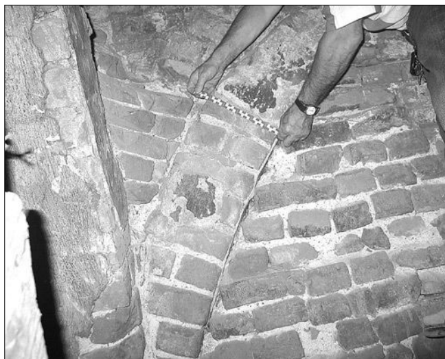
Obr. 7: Opava, konkatedrála Nanebevzetí Panny Marie. Snímek z pořizování podrobné dokumentace zdíva v interiéru věže. Průzkumné a dokumentační práce probíhají často ve velmi těžko přístupných místech, za špatné viditelnosti a mnohdy nejsou možné bez účasti většího počtu pracovníků, což zvyšuje organizační náročnost (foto D. Kouřilová, 2007).
