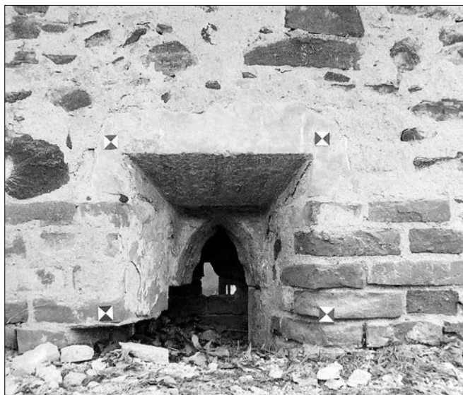
Obr. 14: Zahořany (okres Chomutov), kostel sv. Jana Evangelisty. Okénko ve východní stěně presbyteria s lícovacími měřicími značkami (foto J. Skopec, 2007).
