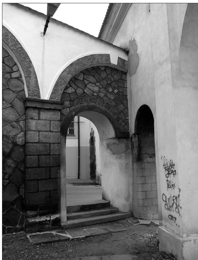
Obr. 5: Děčín, Dlouhá jízda. Detail vazby starší boční stěny na raně barokní vstupní portál.
