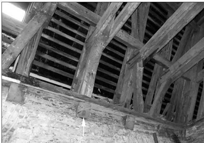
Obr. 33: Starý Hrožňatov (Kinsberg), zámek, jihovýchodní křídlo, 1. patro, v 80. letech 19. století odřezané vazné/stropní trámy na jihovýchodní obvodové zdi, pohled k jihu. Šipka označuje relikt dlabu pro čep přízední stojky, která byla součástí hrázdné přičky vymezující západní cel jezuitského domu vůči bývalému západnímu hrázdnému štítu jihovýchodního křídla. Přička byla odstraněna v 80. letech 19. století (foto J. Anderle, 2007).
