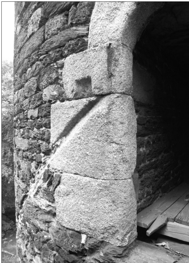
Obr. 17: Starý Hrozňatov (Kinsberg), hrad, původní vchod bergfritu v úrovni půdy zámku, levá část se stopami vývoje kontaktu věže se sousedními objekty. Trámová kapsa odpovídá stopě po vaznici krovu zastřešení přístupu do věže (foto J. Anderle, 2007).
