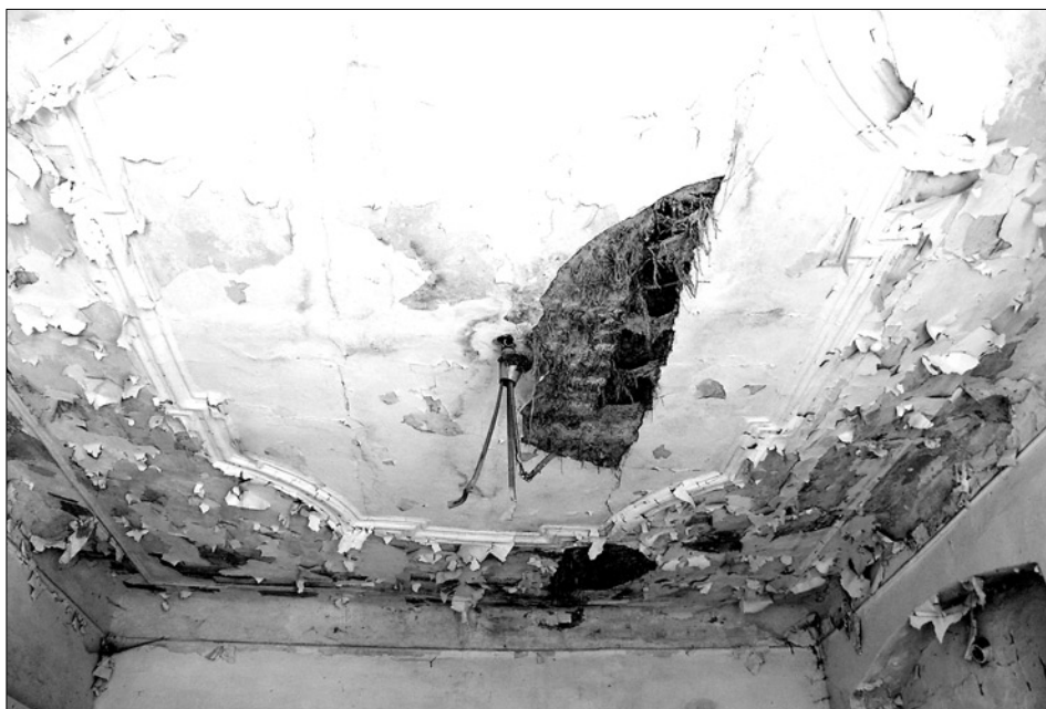
Obr. 28: Starý Hroziatov (Kinsberg), zámek, jihovýchodní křídlo, přízemí, západní místnost v pozdně barokní jezuitské novostavbě. Pohled od jihu na pozdně barokní strop před zahájením stavebních prací (foto J. Anderle, 2007).
