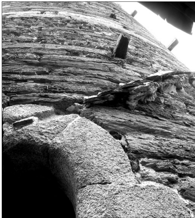
Obr. 18: Starý Hrozňatov (Kinsberg), hrad, původní vchod bergfritu, pravá horní část s reliktem střechy, která pokrývala sousední budovu zámku před její pozdně barokní přestavbou (foto J. Anderle, 2007).
