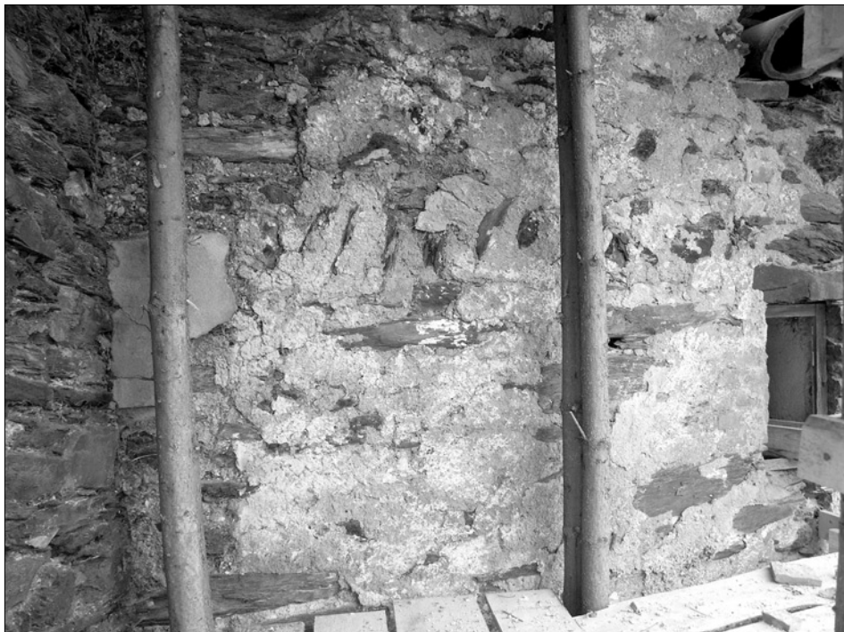
Obr. 25: Starý Hrozňatov (Kinsberg), zámek, jihozápadní průčelí v úrovni suterénu, pozdně románské zdivo s úsekem opus spicatum, vpravo dodatečný průraz snad pozdně renesančního či barokního okénka se šedě malovanou paspartou. V popředí pozůstatky havarijního novodobého schodiště (foto J. Anderle, 2007).
