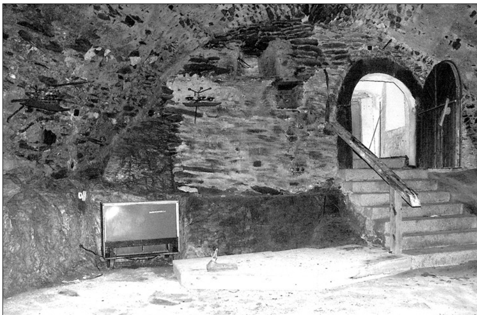
Obr. 29: Starý Hrožňatov (Kinsberg), zámek, severní suterén, pohled k jihu. Zleva doprava: dodatečně zaslepené okénko, odkládací nika, dodatečně osazený vstupní portál snad ze 16. století (foto J. Anderle, 2007).
