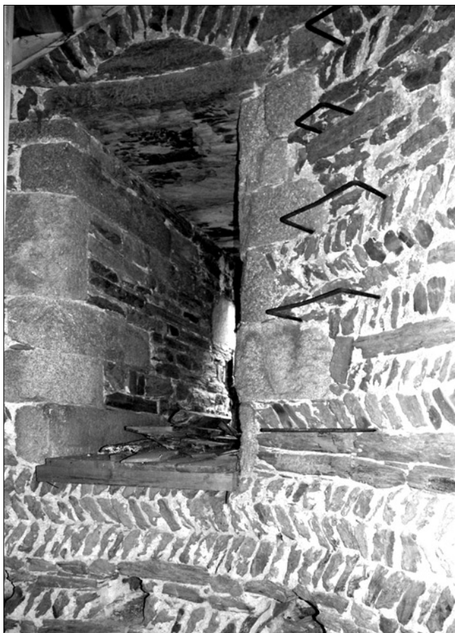
Obr. 22: Starý Hrozňatov (Kinsberg), hrad, pozdně románský vchod bergfritu, pohled z vnitřku. Dole kapsy po nosných trámech původní podlahy (foto J. Anderle, 2007).
