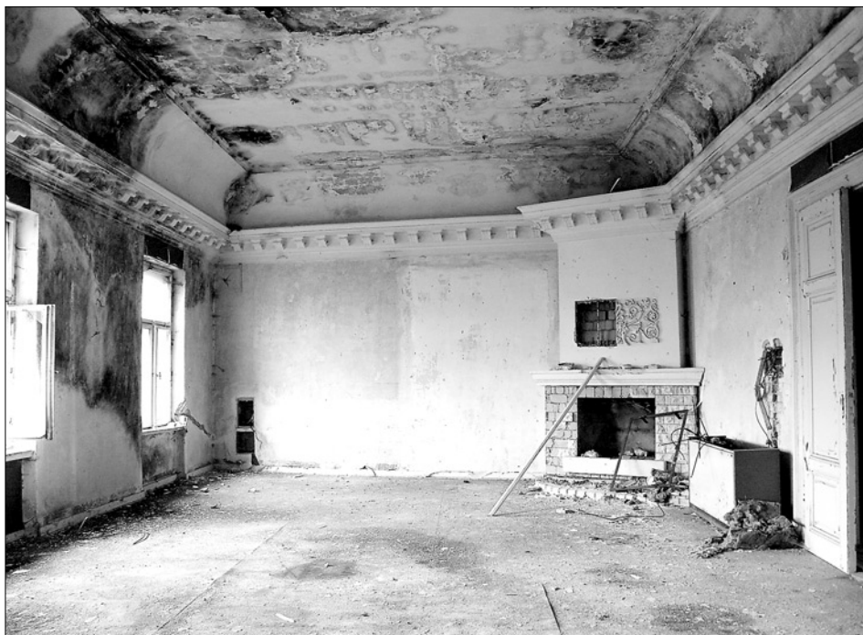
Obr. 30: Starý Hroznatov (Kinsberg), zámek, 1. patro, západní pokoj jihovýchodního křídla, pohled k jihozápadu před zahájením stavebních prací. Úprava podhledu z 80. let 19. století, krb v koutě ze 2. poloviny 20. století (foto J. Anderle, 2007).
