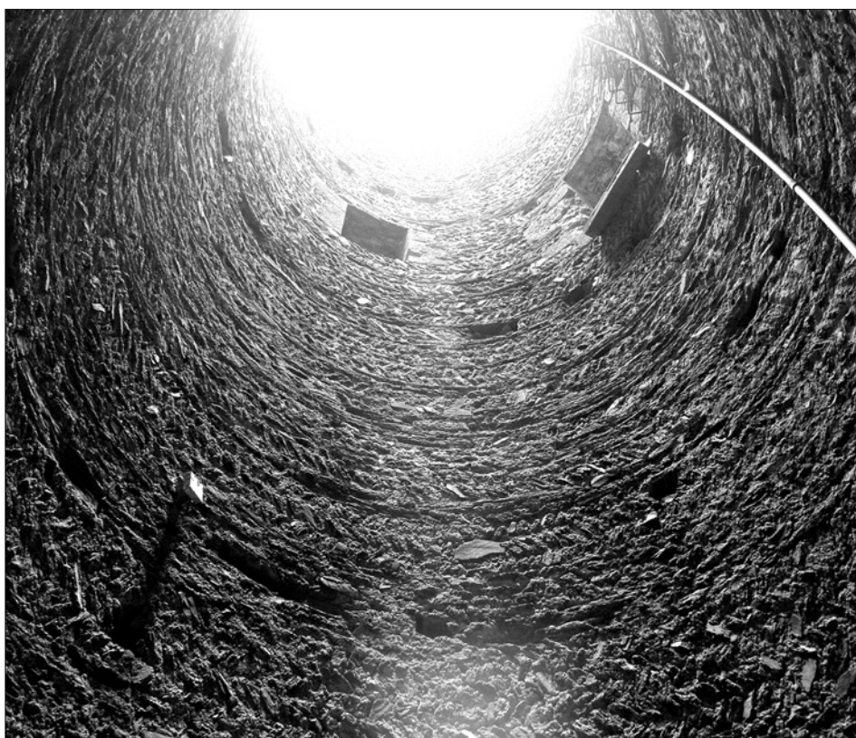
Obr. 21: Starý Hroznatov (Kinsberg), hrad, vnitřek bergfritu po odstranění havarijních novodobých konstrukcí, pohled zdola k podlaží s původním vchodem (vpravo) a oknem k severovýchodu (vlevo). Výrazně se uplatňuje zdivo opus spicatum (foto J. Anderle, 2008).
