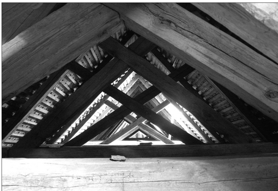
Obr. 45: Starý Hroznatov (Kinsberg), zámecký kostel Nejsvětější Trojice, horní část krovu z roku 1757/58 nad lodí. Pohled k jihozápadu (foto J. Anderle, 2007).
