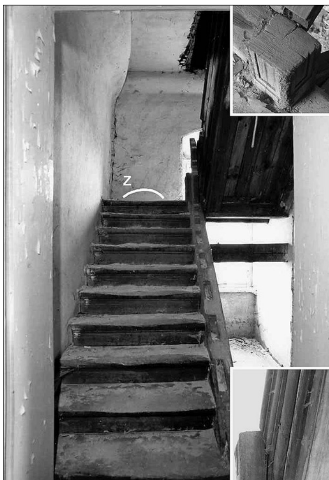
Obr. 36: Starý Hrozňatov (Kinsberg), zámek, jihovýchodní křídlo, 1. patro, bývalé hlavní barokní schodiště jezuitského domu reinstalované v 80. letech 19. století do vstupu na půdu v sousedství bergfritu. Vpravo nahoře detail zbytku sloupku zábradlí, vpravo dole detail profilace srovnice. „Z“ označuje polohu záklenu dodatečně zazděné niky barokního záchodu (foto archiv NPÚ ÚOP v Plzni – celek, J. Anderle, 2007 – detaily a úprava).
