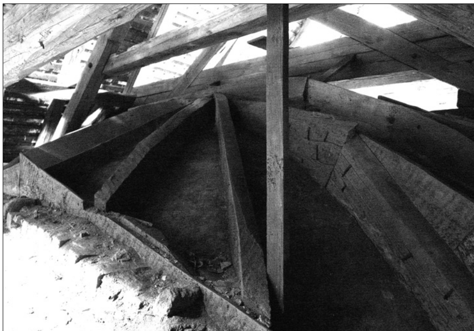
Obr. 44: Starý Hroznatov (Kinsberg), zámecký kostel Nejsvětější Trojice, ramenáty na rubu falešné klenby lodi při styku s klenutím kruchty a spodní partie krovu z roku 1757/58. Pohled k jihu (foto J. Anderle, 2007).
