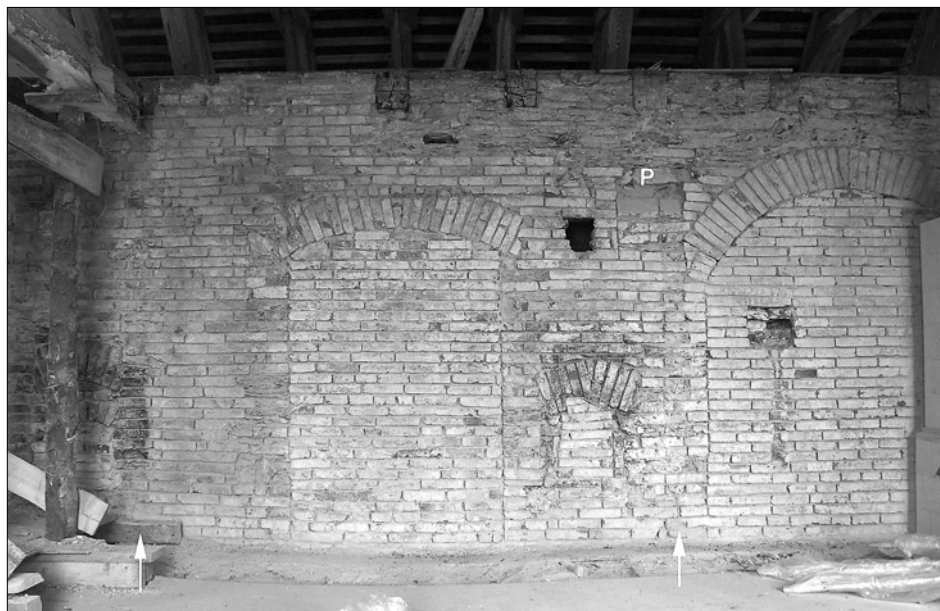
Obr. 35: Starý Hrozňatov (Kinsberg), zámek, jihovýchodní křídlo, 1. patro, místnost č. 5, pohled na severozápadní stěnu. Šipky označují zjištěnou polohu barokních přiček cel – vlevo hrázděná, vpravo zděná, oddělující bývalý prostor barokního schodiště (odstraněno spolu s přčkami v 80. letech 19. století), výše zazděné otvory k nepřímé obsluze barokních kamen v celách, „P“ označuje patu záklenu slepé kamnové niky v přčce mezi celou a schodišťovým prostorem, uprostřed zazděný vchod do bývalé cely, vpravo zazděná arkáda spojující chodbu v nádvorním křídle s bývalým prostorem schodiště (foto J. Anderle, 2007).
