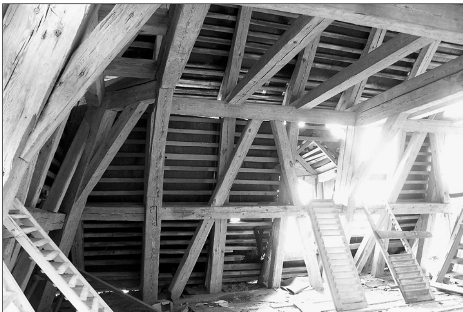
Obr. 38: Starý Hrožňatov (Kinsberg), zámek, východní konec jihovýchodního křídla, mansardový krov dendrochronologicky datovaný 1766/67. Pohled k jihu (foto J. Anderle, 2007).
