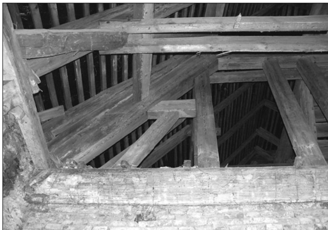
Obr. 34: Starý Hrožňatov (Kinsberg), zámek, 1. patro, pohled k jihozápadu na bývalý západní hrázdný štít jihovýchodního křídla. Vazný trám štítové vazby krovu byl v 80. letech 19. století dodatečně přtesán, aby vyhověl tvaru nového stropního fabionu (foto J. Anderle, 2007).
