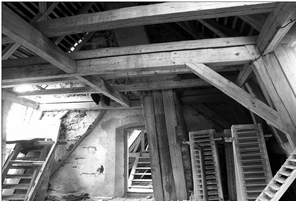
Obr. 37: Starý Hrožňatov (Kinsberg), zámek, východní konec jihovýchodního křídla, prostor půdy a mansardový krov, dendrochronologicky datovaný 1766/67. Pohled k jihozápadu (foto J. Anderle, 2007).
