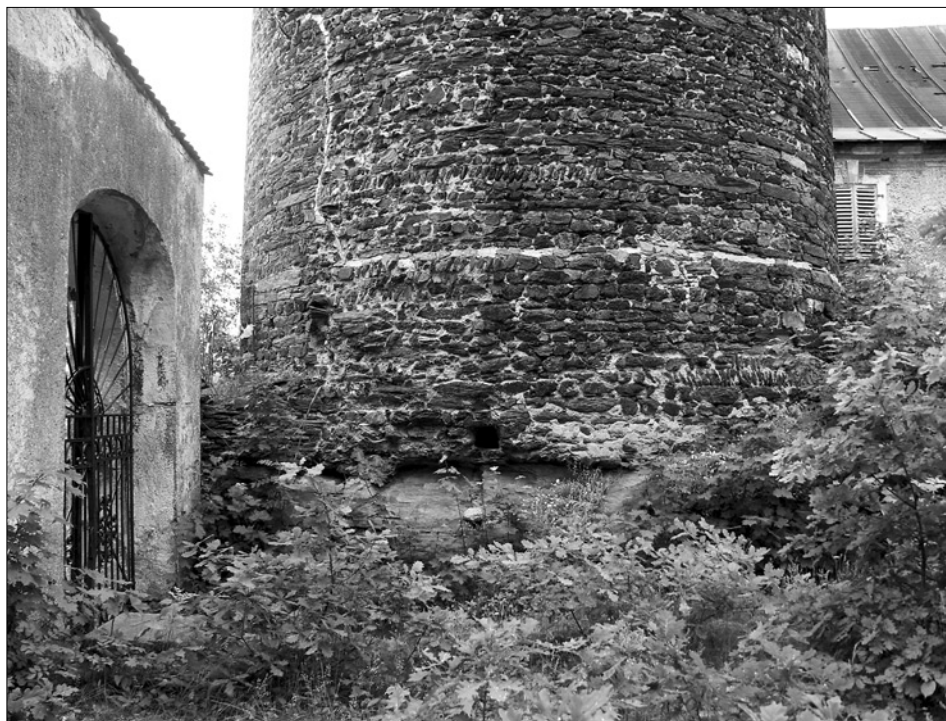
Obr. 15: Starý Hroznatov (Kinsberg), hrad, pata pozdně románského bergfritu od severozápadu. Nízko nad základem otvor pochvy pro závoru původní brány, výše svislý pás zdiva se světlejší a nerovnou lící označuje místo styku s obvodovou hradbou (foto J. Anderle, 2007).
