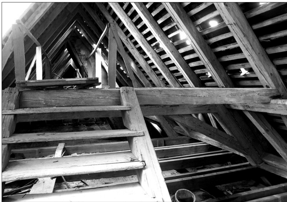
Obr. 39: Starý Hroznatov (Kinsberg), zámek, jihovýchodní křídlo, pozdně barokní krov se šikmými (ležatými) stolicemi nad starší částí jezuitského domu. Konstrukce je stratigraficky starší než mansardový krov na východním konci křídla. Pohled k jihozápadu. Dole kleštiny, datované 1883–85, nahrazující funkci odstraněných vazných trámů (foto J. Anderle, 2007).
