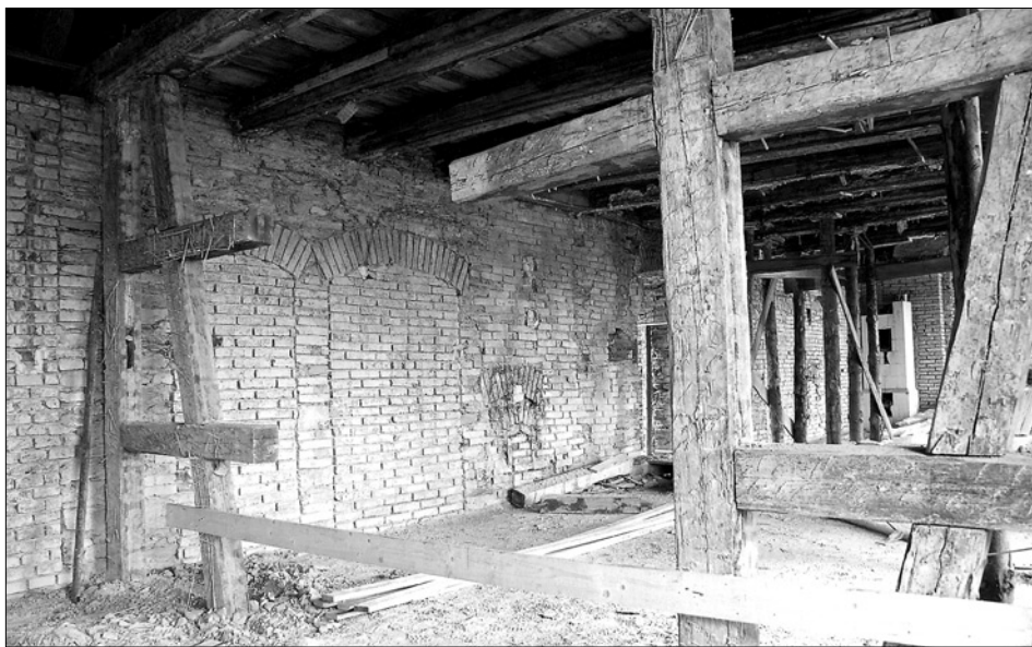
Obr. 32: Starý Hrožňatov (Kinsberg), zámek, jihovýchodní křídlo, 1. patro, rámová konstrukce barokní přičky mezi místnostmi č. 2 a 3, pohled k severu. Přička původně oddělovala dvě z cel jezuitského domu (foto J. Anderle, 2007).
