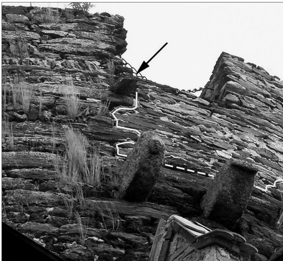
Obr. 20: Starý Hroznatov (Kinsberg), hrad, konzoly arkýře v úrovni ochozu bergfritu. Jejich poloha v půdorysu odpovídá umístění níže položeného původního vchodu do věže. Čelo levé z konzol zdobeno lidskou maskou. Šipka označuje šmorce, kterými byl do těla věže zavázán zděný bok arkýře. Světlou linií označen rozsah novodobého přezdění (foto a úprava J. Anderle, 2007).
