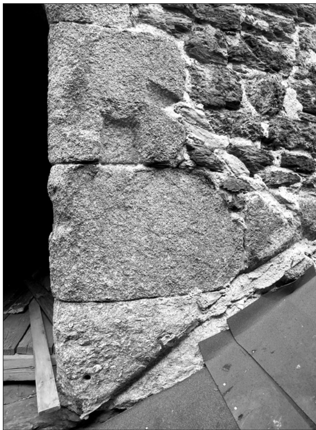
Obr. 19: Starý Hrozňatov (Kinsberg), hrad, původní vchod bergfritu, pravá část se stopami vývoje kontaktu věže se sousedními objekty. Trámová kapsa odpovídá stopě po vaznici krovu zastřešení přístupu do věže a nejspíše souvisí se šikmou drážkou výše – stopou po příslušné sedlové stříšce. Vztah této střechy ke světlosti vchodu ukazuje na její dodatečný vznik. Otvor v patě stojky portálu možná souvisí se starší konstrukcí můstku (pant umožňující jeho sklápění?) (foto J. Anderle, 2007).
