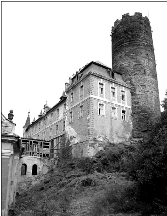
Obr. 13: Starý Hrozňatov (Kinsberg), zámek od východu před započatím stavebních prací r. 2007. Vlevo spojovací chodba ke kostelu (foto J. Anderle, 2007).
