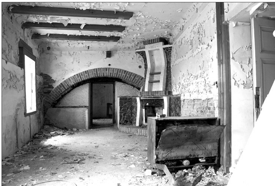
Obr. 27: Starý Hroziatov (Kinsberg), zámek, západní část jihovýchodního křídla, přízemí, pohled od severovýchodu do prostoru bývalé barokní dýmníkové kuchyně před zahájením stavebních prací. V pozadí novodobý pas, který zajišťuje zbytek klenby dýmné části kuchyně (foto J. Anderle, 2007).
