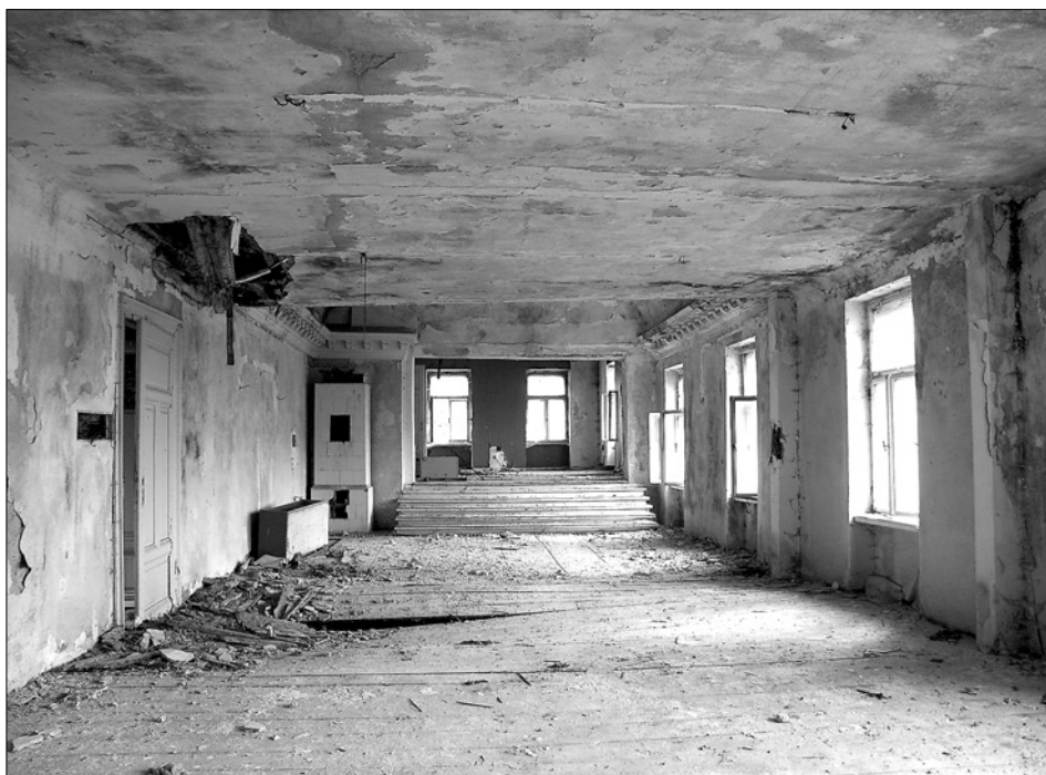
Obr. 31: Starý Hroznatov (Kinsberg), zámek, jihovýchodní křídlo, 1. patro, celkový pohled k severovýchodu před zahájením stavebních prací (foto J. Anderle, 2007).
