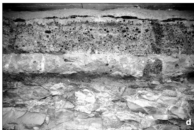
Obr. 2: Makroskopická fotografická dokumentace kopané sondy K7 (všechny snímky R. Přikryl): a – celkový pohled seshora; b – detail vnitřní opukové klenby a navazujícího původního výplňového zdiva; c – střední část vodorovně kladeného původního výplňového zdiva; d – přechod mezi původním výplňovým zdivem (spodní strana snímku) a novodobými vrstvami (na snímku jsou patrné vrstvy 1–5 dle obr. 3).
