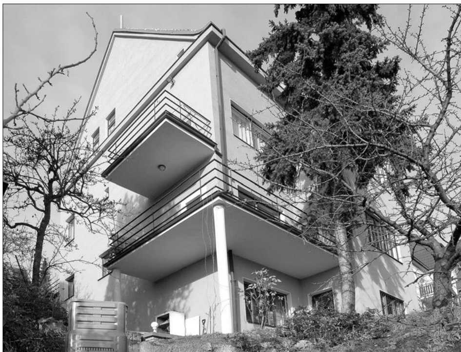
Obr. 8: Praha 8, dům čp. 1377, pohled od jihozápadu (foto autorka, 2009).
