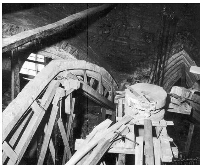
Obr. 58: Fotografie z doby rekonstrukce chrámu v letech 1941–46. Vpravo v pozadí hrotitý oblouk severní arkády úzkého západního pole před věží, vlevo navazující klenební pole. Snímek pořízen v době, kdy byla do ramenátů osazena žebra pro následné vyklenutí obou polí klenby. Nad ním prochází v baroku osazené dubové táhlo, vetknuté do nadezdívky obou mezilodních arkád (SOKA Kutná Hora, Sbírka fotografií a negativů Kutná Hora, 394/IIIB).
