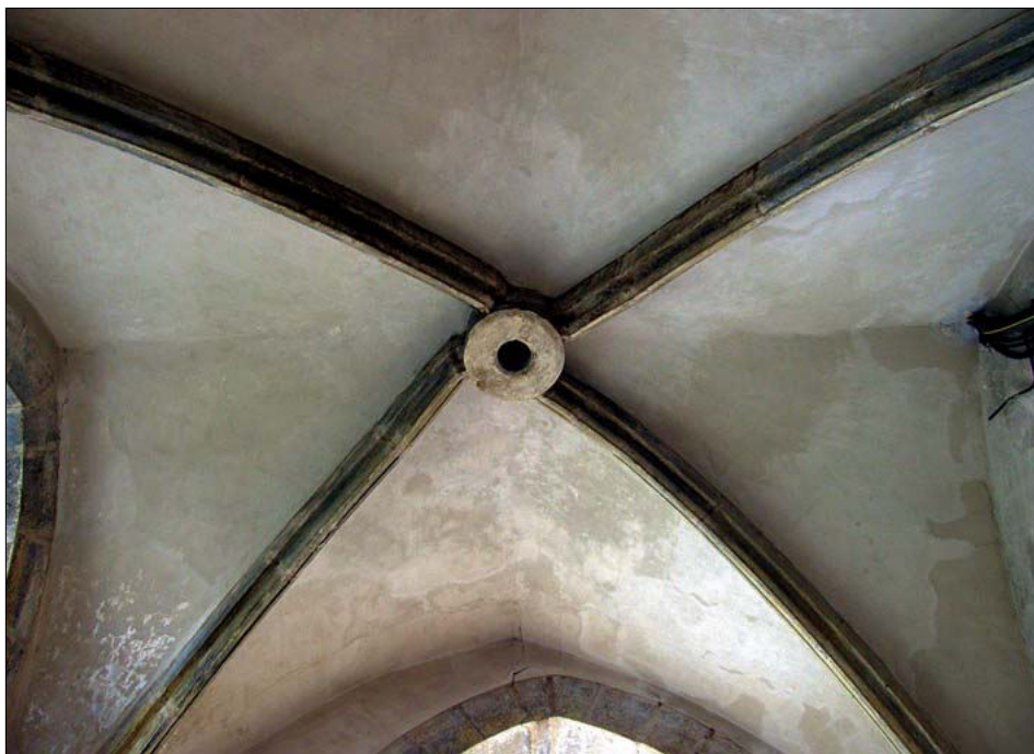
Obr. 34: Pohled do vrcholu klenby v 1. patře jižní věže. Diagonální žebra z protilehlých koutů neleží v přímce, nýbrž se ve vrcholu míjejí, což vytváří efekt rotujícího svorníku. Otevřenou otázkou zůstává, zda šlo o záměr nebo důsledek nedokonalého nasazení výběhů žeber (foto J. Beránek, 2009).
