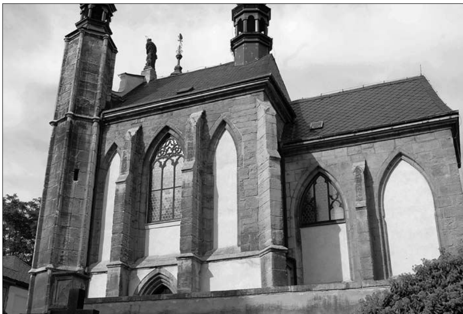
Obr. 20: Horní kaple karneru v Sedlci u Kutné Hory. Stylovou vazbu s presbytářem kostela sv. Jakuba dokládá nejenom lancetový tvar okenních záklenků, ale rovněž hmotová podoba a povrchové členění subtilních věží západního průčelí. Základním inspiračním zdrojem alespoň pro utváření vzhledu exteriéru byl konventní chrám v Sedlci. Předlohu pro věže západního průčelí lze hledat v utváření věží raně gotického chrámu v nedalekém Kolíně (foto J. Beránek, 2009).
