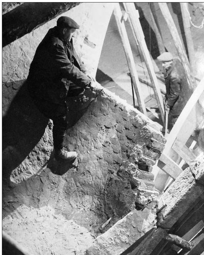
Obr. 57: Fotografie z doby rekonstrukce chrámu v letech 1941–46. Popis snímku v albu: „Partie nad probouraným klenutím. Pohled z podstřeší do chrámu. „Cesta“ stavbyvedoucího Horáčka přes pozůstalou pevnou patku odbouraného klenutí v podkroví hlavního kůru. Únor 44“. Snímek ukazuje, že pateční části výběhů kleneb stejně jako přilehlé plochy klenebních kápí byly při rekonstrukci zachovány (Arciděkanství úřad Kutná Hora, Oprava arciděkanství chrámu sv. Jakuba, Album II, snímek č. 307, autor J. Kohel – J. Čáp).
