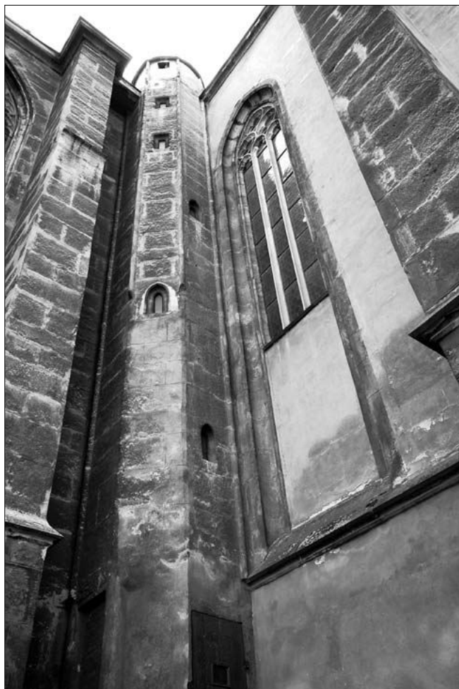
Obr. 15: Schodišťová věžka situovaná do koutu svíraného presbytářem a severní lodí. Schodiště vzniklo nepochybně zároveň s presbytářem a přílehlou částí východní zdi severní lodi, což dokládá i původní koncept síňové dispozice. Tvarově a částečně i svým členěním navazuje na subtilní věže západního průčelí horní kaple karnaru v Sedlci (foto J. Beránek, 2008).
