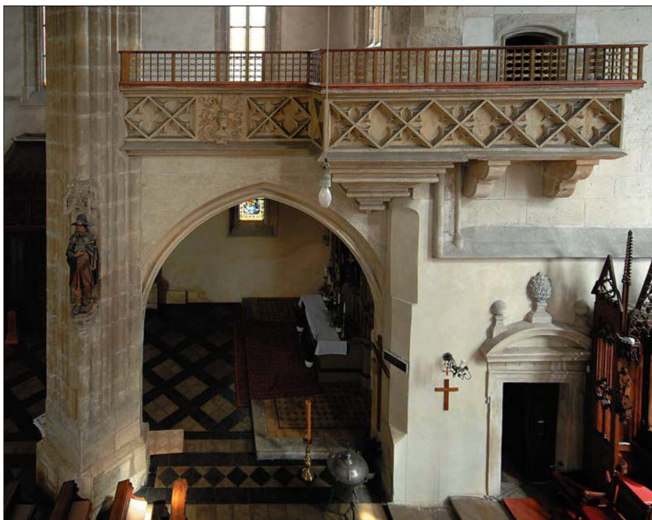
Obr. 49: Pohled na jižní stranu Charvátovské kaple ve východním poli severní lodi. Vpravo navazuje severní stěna presbytáře. Patro nad kaplí je přístupné pavlačí osazenou na bohatě profilované pozdně středověkou konzolu. Jinak je utvářena východní část pavlače, zjevně staršího původu, na dvojici konzol s oblými čely. Portálek ze severního točitého schodiště pochází asi ještě ze 14. století, byť sám je do hmoty schodiště vložen nepochybně druhotně. Na původně krátkém balkónku se mohly nacházet varhany, případně přes něj mohl být přístupný letner, situovaný na rozhraní presbytáře a střední lodi (foto J. Beránek, 2008).
