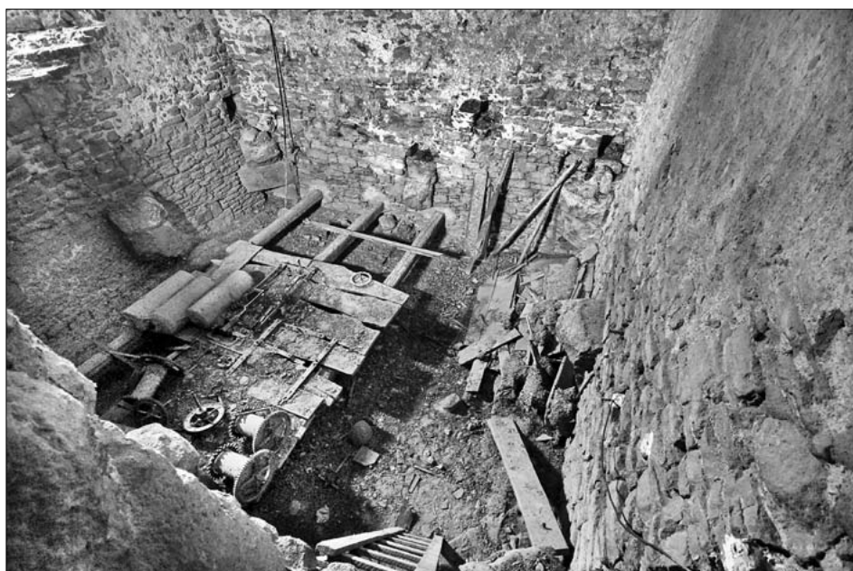
Obr. 19: Pohled do spodní části 1. patra severní věže z chodbičky od vstupu z točitého schodiště západního průčelí. Patro severní věže není do interiéru trojlodí otevřeno hrotitými arkádami jako věž jižní. Důvodem je skutečnost, že nad klenbou přízemí se velmi pravděpodobně nacházela hranolová dřevěná konstrukce, která pod zvonovým patrem podírala vlastní konstrukci zvonové stolice. Dokládají to mohutné kamenné bloky, zazděné v koutech věže, nad nimiž jsou ve zdech situovány hluboké kapsy pro přízední trámy roštu, který konstrukci podíral. Bloky i kapsy jsou součástí obvodových zdí věže (foto J. Beránek, 2009).
