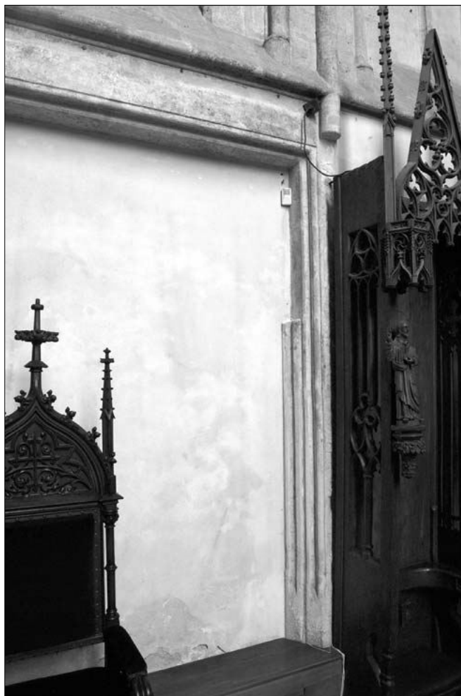
Obr. 21: Detail členění části jižní zdi presbytáře, jež již východní třetinu zdi zaujímá hlubší výklenek sedile pravoúhlého tvaru. Ze jde o sedile, dokládá, jak hloubka výklenku, tak i stopy po lípané kružbě, která se nacházela v horní třetině plochy výklenku. Pozdně gotická chórová lavice zakrývá sousední výklenek, který je podobně jako na severní stěně presbytáře segmentově překlenutý (foto J. Beránek, 2008).
