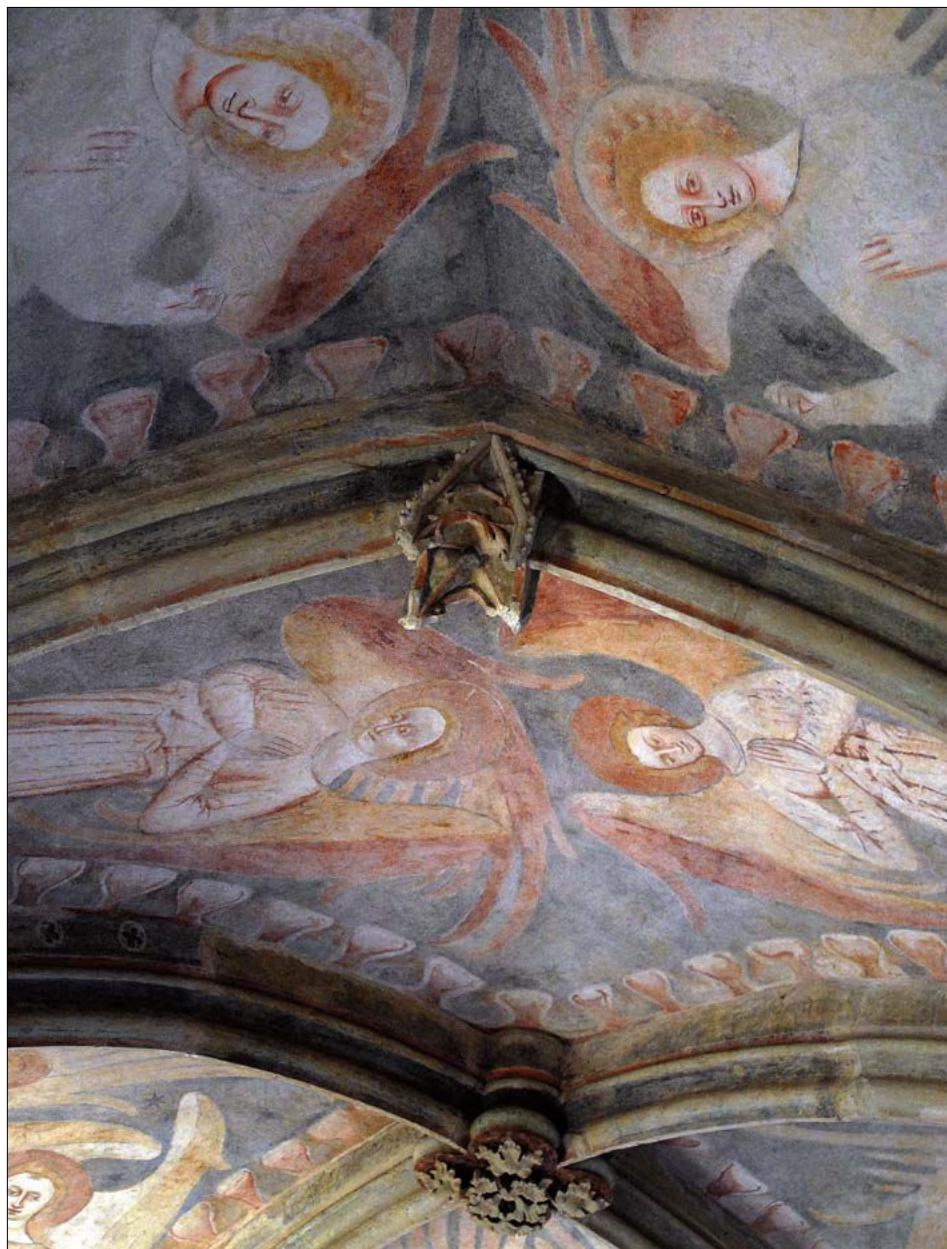
Obr. 41: Sázavský klášter. Pohled do vrcholu klenebního pasu, oddělujícího východní dvojici polí bývalé kapitulní síně. V rámci předhusitských Čech jde o zřídka viděný příklad použití svorníku ve vrcholu dělicího zebra. Zde je navíc užito neobvyklé formy podklenutého baldachýnu (foto J. Beránek, 2009).
