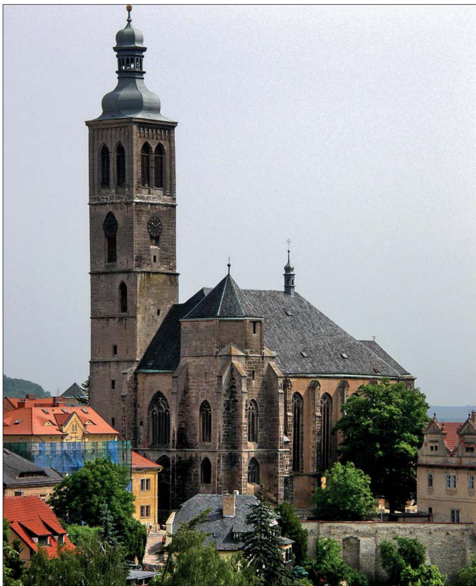
Obr. 1: Kutná Hora, pohled na kostel sv. Jakuba od jihozápadu, jemuž dominuje vysoká severní věž západního průčelí kostela, zatímco jižní zůstala nedokončena. Její nepravidelně šestiúhelné poslední patro kryje jehlancová střecha. Charakteristickou barevnost propůjčuje střechám brdlícová krytina (foto J. Beránek, 2008).
