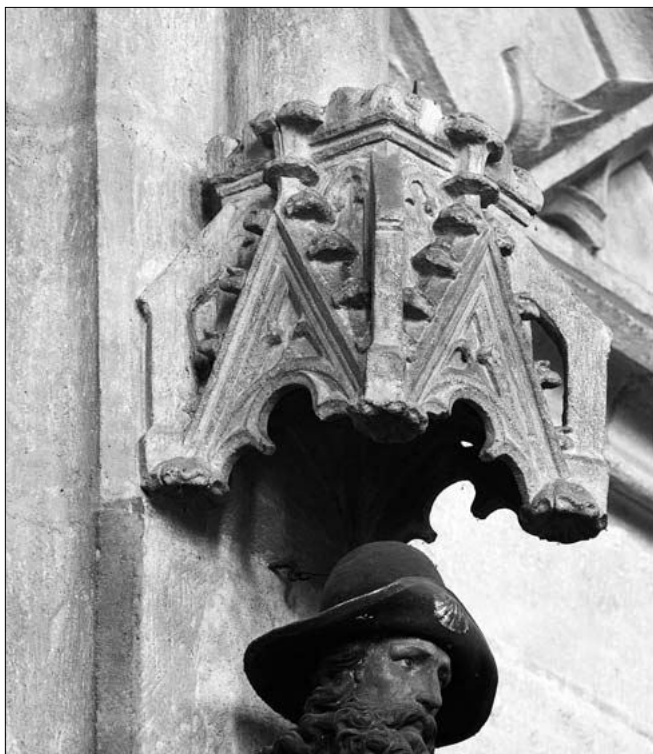
Obr. 30: Detail baldachýnu na jižní straně východního pilíře severní arkády. Východní pilíře severní i jižní arkády jsou jediné, na nichž se dochovaly původní baldachýny, pocházející z III. stavební etapy (foto J. Beránek, 2009).
