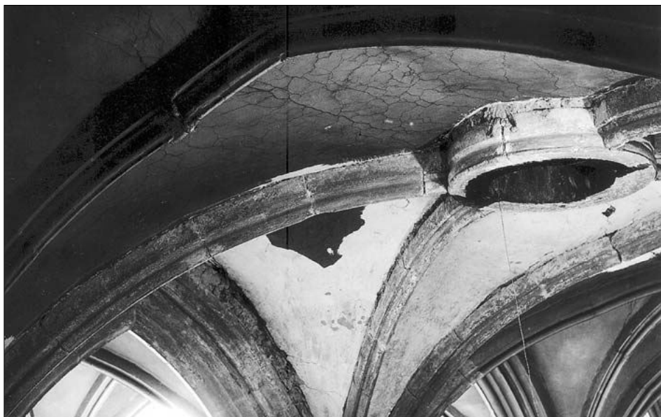
Obr. 33: Fotografie z doby rekonstrukce chrámu v letech 1941–46. Pohled do 2. pole střední lodi od východu. Mimořádně důležitý snímek pořízený před rozebráním klenby zachycuje velký dutý svorník, jenž původně akcentoval osu severního a jižního bočního vstupu. Při rekonstrukci byl osazen menší plný svorník. Pole bylo z větší části přezděno, včetně vrcholů obou dělicích žebířů (SOKA Kutná Hora, Sbirka fotografií a negativů Kutná Hora, 373/IIIB).
