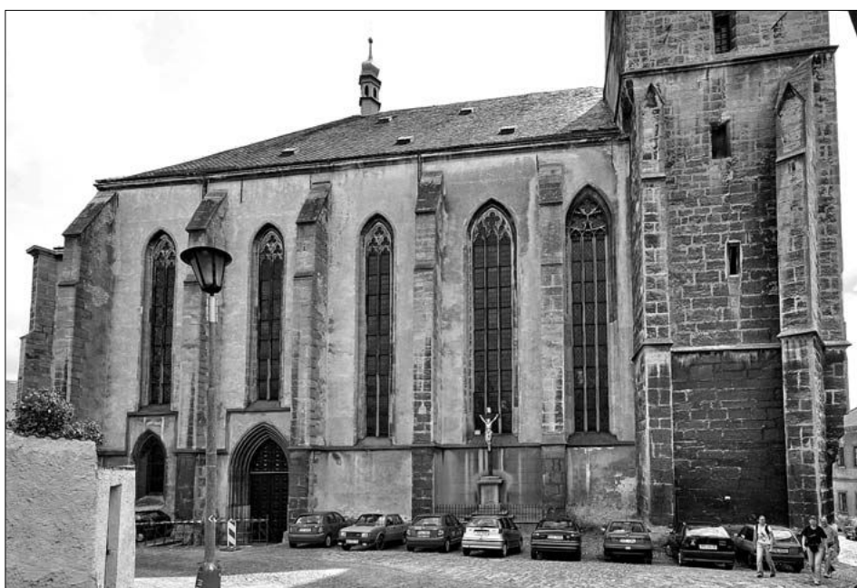
Obr. 6: Severní strana kostela sv. Jakuba. Opěrák severozápadního nároží severní věže je natočený o 45° z osy východním směrem. Dvě krajní východní okna jsou zkrácena, protože se zde nachází boční vstup a nižší hrotité okno, osvětluje kapli v čele východní boční lodi (foto J. Beránek, 2008).
