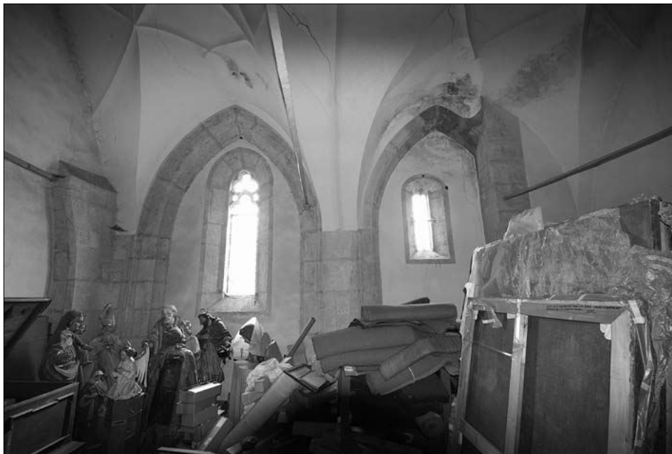
Obr. 23: Pohled do jižní části depozitáře v patře nad sakristií. Členění jižní i východní stěny depozitáře v patře ukazuje, že původním záměrem bylo prolomení zdí širokými hrotitými okny, takže plocha stěny by se v podstatě vůbec neuplatňovala, vyjma typické přístěnné podložky doprovázené po stranách dvojicí přístěnných přípor. Tato koncepce byla opuštěna ještě v průběhu výstavby a jižní zeď prolomena dvojicí užších oken (foto J. Beránek, 2009).
