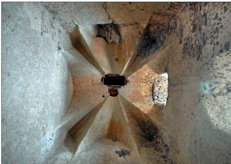
Obr. 50: Pohled do renesanční kamenné klenby 1. patra severní věže. Severní věž byla ve 2. polovině 16. století přepatrována dvojicí kleneb. Horní patro je nižší, nacházel se zde byt věžníka. Při této stavební úpravě logicky zanikla starší dřevěná hranolová konstrukce. Druhotný průřez ve vrcholu klenby má tvar zvonu, který byl někdy v minulosti otvorem snesen (foto J. Beránek, 2009).
