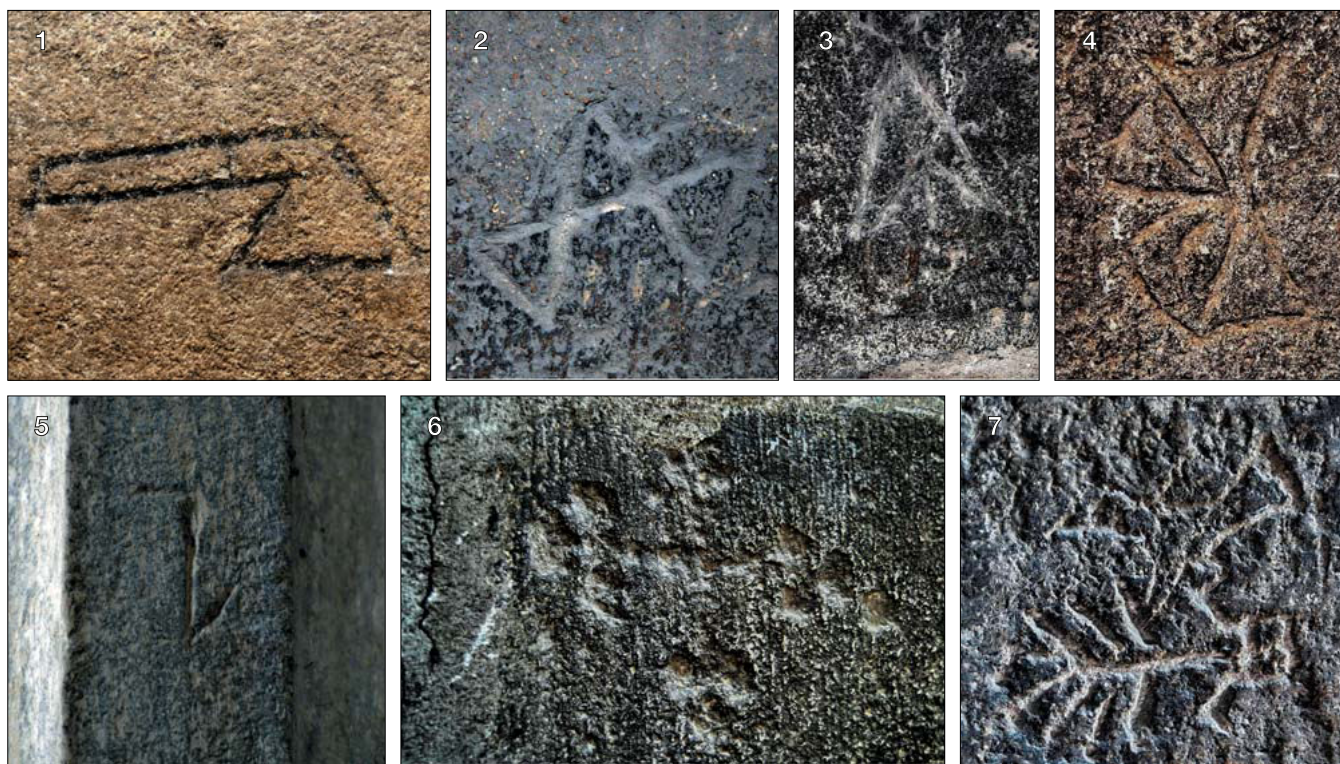
Obr. 42: Kamenické značky, které se vyskytují na kamenných blocích v interiéru kostela sv. Jakuba. 1 – 4 značky, které se vyskytují na architektonických prvcích a kvádrech presbytáře a severního točitého schodiště; 5 – značka vyskytující se na pilířích trojlodí; 6 – 7 schodiště v západním průčelí (jetelový kříž a ptáček na větvičce). Bez průzkumu z lešení lze značky na pilířích trojlodí rozpoznat jen obtížně. Od značek v presbytáři se zjevně odlišují, což dokládá nejenom odlišnou stavební etapu, ale také jiné kameníky (foto J. Beránek, 2008–09).
