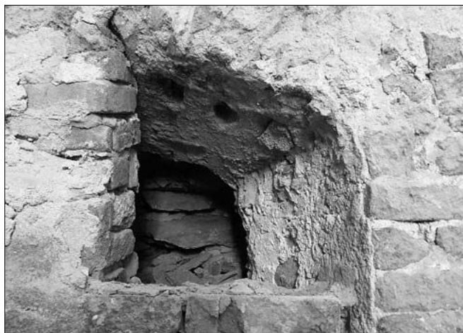
Obr. 19: Velhartice, hrad, přízemí přístavku k severnímu čelu tzv. jižního paláce, okno v západní zdi se stopami dřevěné „mříže“ (foto J. Anderle, 2006).
