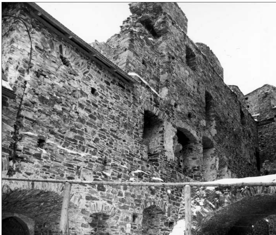
Obr. 14: Velhartice, hrad, Rajský dům, jižní zeď s krby ve 2. a 3. nadzemním podlaží. Stav roku 1993 (archiv NPÚ ÚOP v Plzni).
