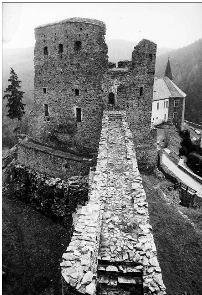
Obr. 7: Velhartice, hrad, pohled z Putny k Rajskému domu, stav před poslední opravou, 80. léta 20. století (archív NPÚ ÚOP v Plzni).
