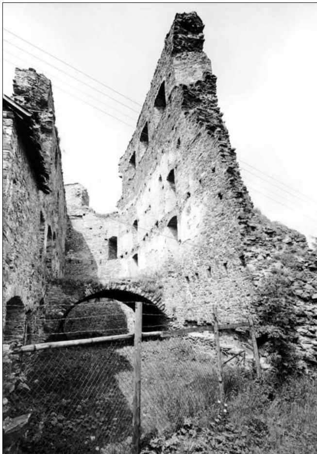
Obr. 13: Velhartice, hrad, Rajský dům, pohled od východu. Stav roku 1984 (archiv NPÚ ÚOP v Plzni).
