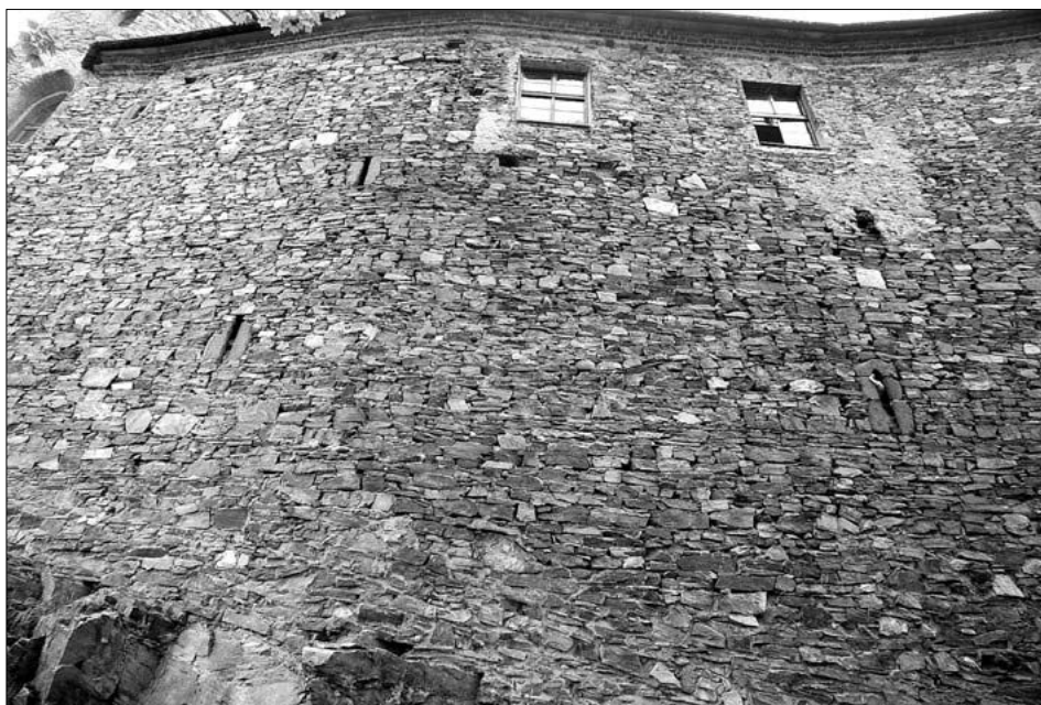
Obr. 5: Velhartice, hrad, východní stěna tzv. jižního paláce. Rozdílná povaha a výškové umístění oken v levé a pravé části nejstarší etapy hradby; nahoře vlevo v dodatečně nadezdívce patrně ze 2. poloviny 14. století průběžně okosené ostění okénka (foto J. Anderle, 2009).
