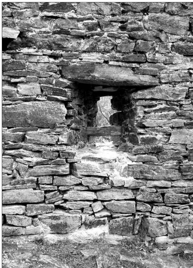
Obr. 23: Velhartice, hrad, střílna pro hákovnici v hradbě v jižním sousedství západní okrouhlé bašty (foto J. Anderle, 2009).
