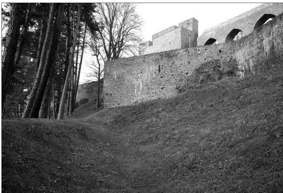
Obr. 31: Velhartice, hrad, trojúhelníková bašta, mladší fáze pozdně gotického západního opevnění, pohled od jihu (foto J. Anderle, 2009).
