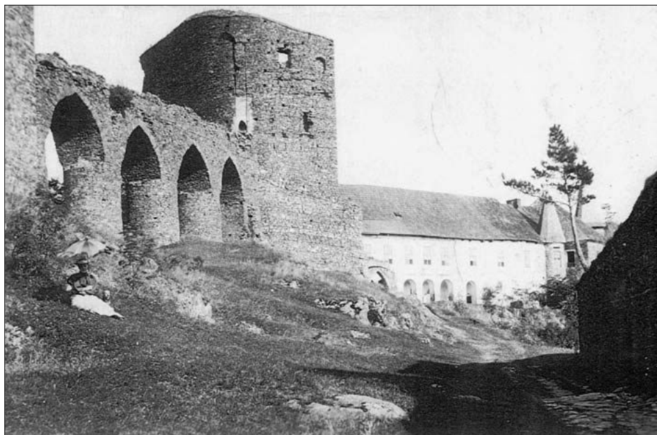
Obr. 6: Velhartice, hrad, pohled k Rajskému domu od severozápadu asi kolem roku 1900. Na zdi Rajského domu vpravo od mostu patrna klesající koruna nejstarší hradby z konce 13. století, na ní svislými spárami vymezený pilř pro sedlovou baštu, z níž zachovány 4 nosníky a otisky jejich šikmých vzpěr (uloženo u správy hradu).
