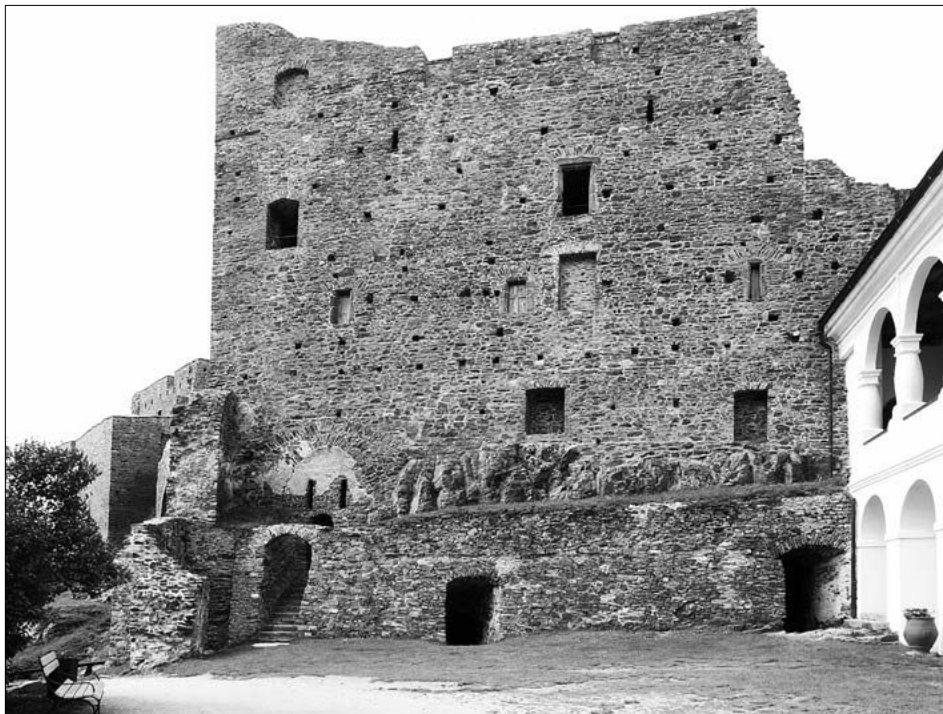
Obr. 10: Velhartice, hrad, nádvorní (jižní) stěna Rajského domu, dnešní stav po poslední opravě (foto J. Anderle, 2008).
