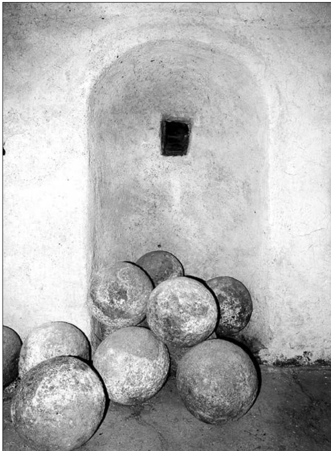
Obr. 26: Velhartice, hrad, západní okrouhlá bašta pozdně gotického opevnění, nika střílny v přízemí s větracím otvorem. V popředí sbírka kamenných projektílů (foto J. Anderle, 2009).
