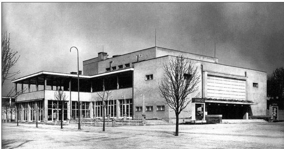
Obr. 10: Brno – Pisárky, čp. 405, pohled na čerstvě dokončenou kino-kavárnu od jihovýchodu, asi 1928 – ještě před osazením vnějších svítidel (soukromá sbírka, kopie MMB, archiv architektury).
