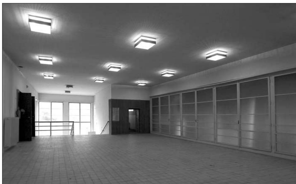
Obr. 32: Brno-Pisárky čp. 405, bývalá kino-kavárna; celkový pohled na horní foyer (foto J. Stará, 2009).
