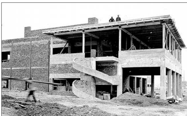
Obr. 4: Brno – Pisárky, čp. 405, rozestavěná kino-kavárna ještě před rozhodnutím o doplnění vysokého provaziště a přístavby v západní části, patrně jaro 1928 (archiv BVV, sbírka fotografií).
