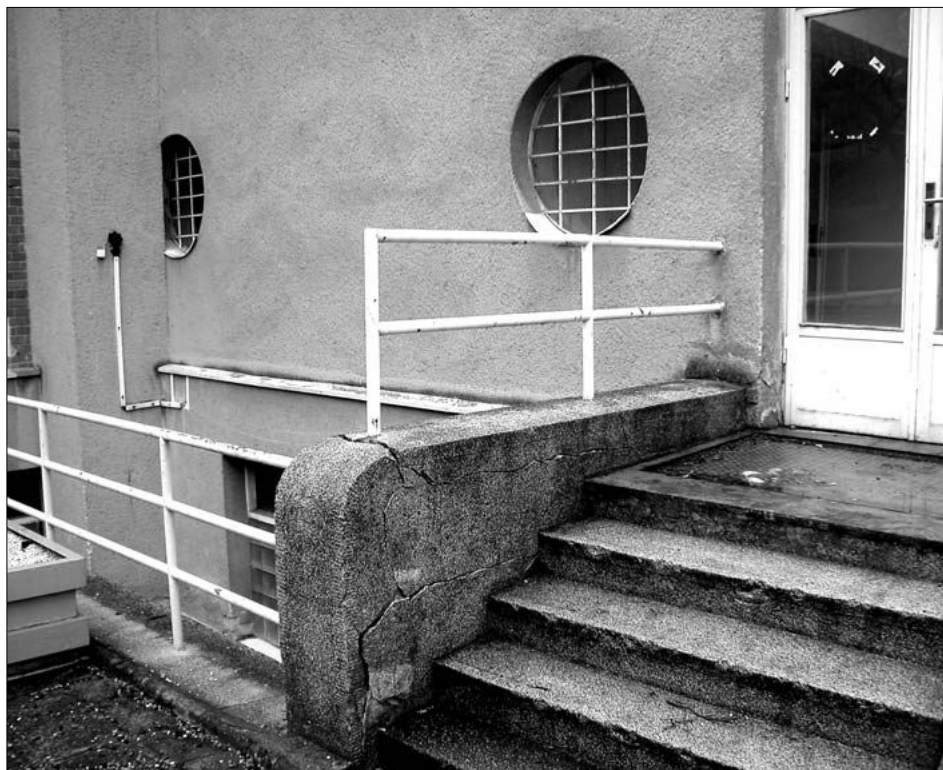
Obr. 27: Brno-Pisárky čp. 405, bývalá kino-kavárna; vnější schodiště zadního vstupu při severozápadním nároží (foto J. Bláha, 2009).
