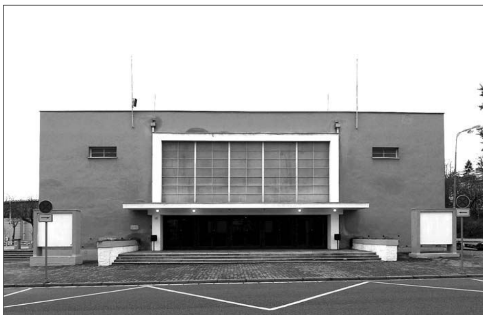
Obr. 22: Brno-Pisárky, čp. 405, bývalá kino-kavárna; pohled na průčelí hlavního vstupu (foto J. Stará, 2009).
