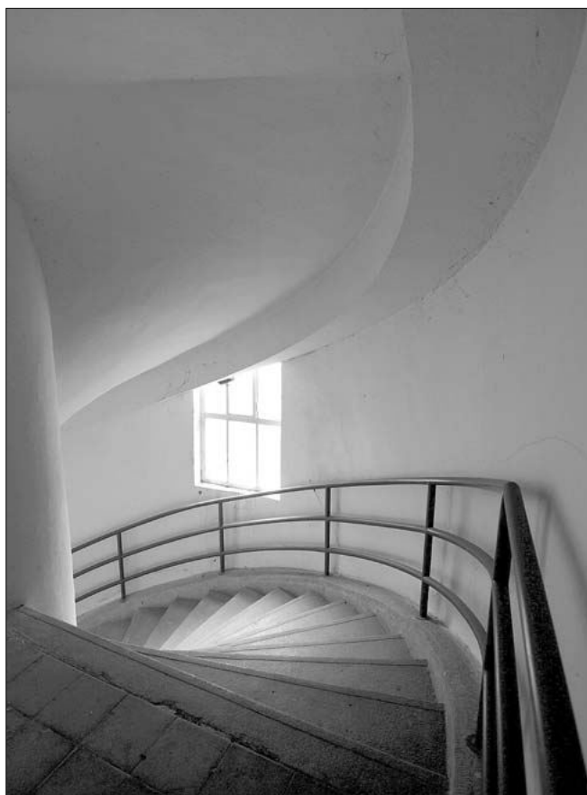
Obr. 43: Brno-Pisárky, čp. 405, bývalá kino-kavárna; spodní rameno do- datečně opláštěného půlválcového schodiště na horní terasu kavárny (foto J. Stará, 2009).
