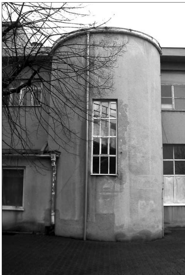
Obr. 28: Brno-Pisárky čp. 405, bývalá kino-kavárna; dodatečně opláštěné půlválcové schodiště na terasu kavárny (foto J. Bláha, 2009).
