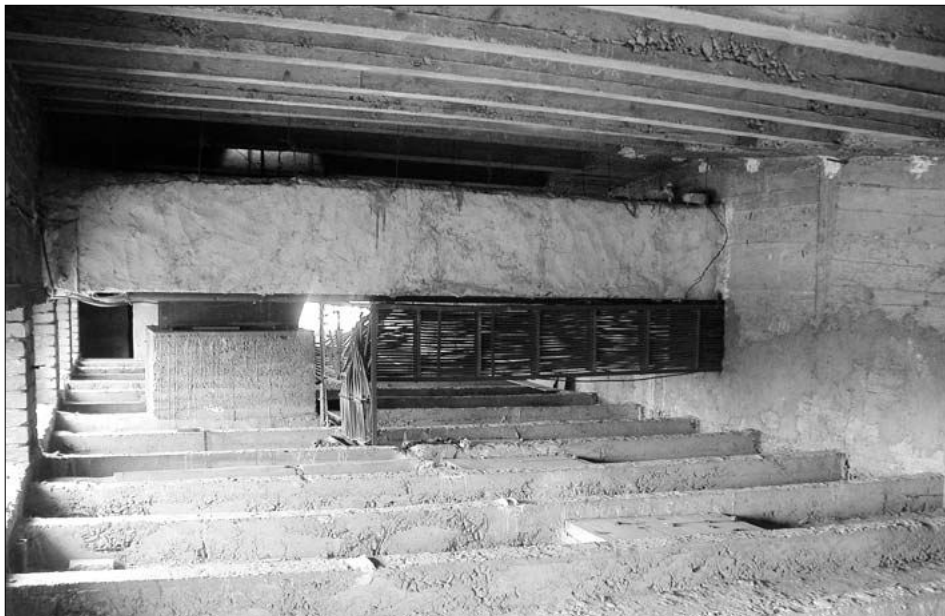
Obr. 44: Brno-Pisárky, čp. 405, bývalá kino-kavárna; pohled do technického podlaží nad foyer v patře před kinosálem (foto J. Bláha, 2009).
