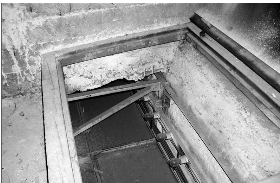
Obr. 46: Brno-Pisárky čp. 405, bývalá kino-kavárna; detail montážní šachty pro přístup k žárovkám na rampě obvodového osvětlení kinosálu (foto J. Stará, 2009).
