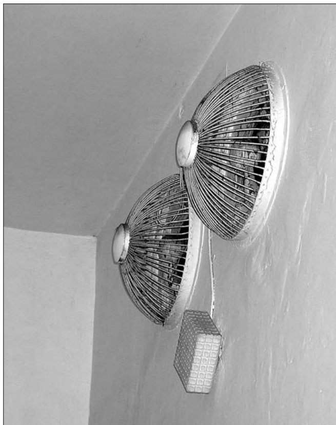
Obr. 39: Brno-Pisárky, čp. 405, bývalá kino-kavárna; detail odvětrání přizemní části kavárny (foto J. Bláha, 2009).
