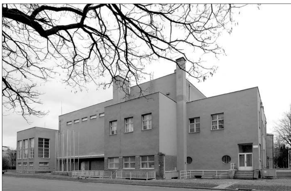
Obr. 23: Brno-Pisárky, čp. 405, bývalá kino-kavárna; severní průčelí (foto J. Stará, 2009).
