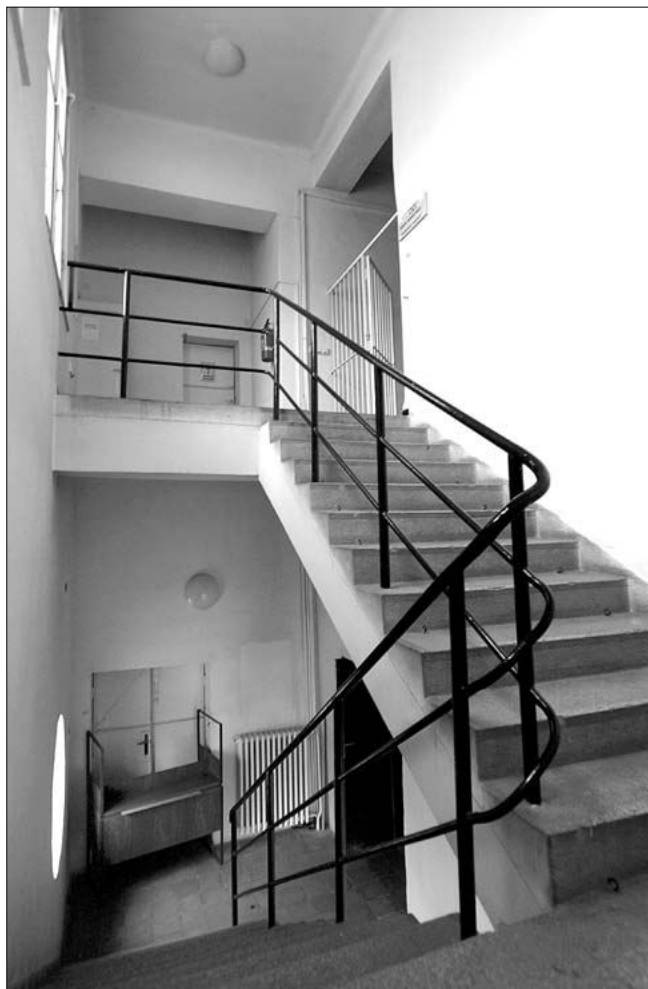
Obr. 37: Brno-Pisárky, čp. 405, bývalá kino-kavárna; schodiště při zadním vstupu do budovy (foto J. Stará, 2009).
