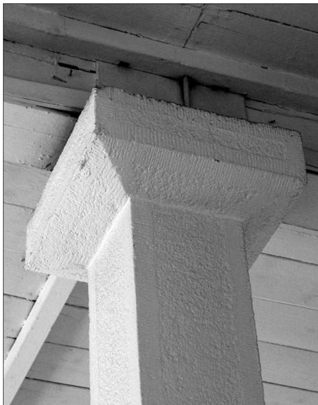
Obr. 41: Brno-Pisárky, čp. 405, bývalá kino-kavárna; detail hlavice nosného sloupu střechy kavárenské terasy (foto J. Bláha, 2009).
