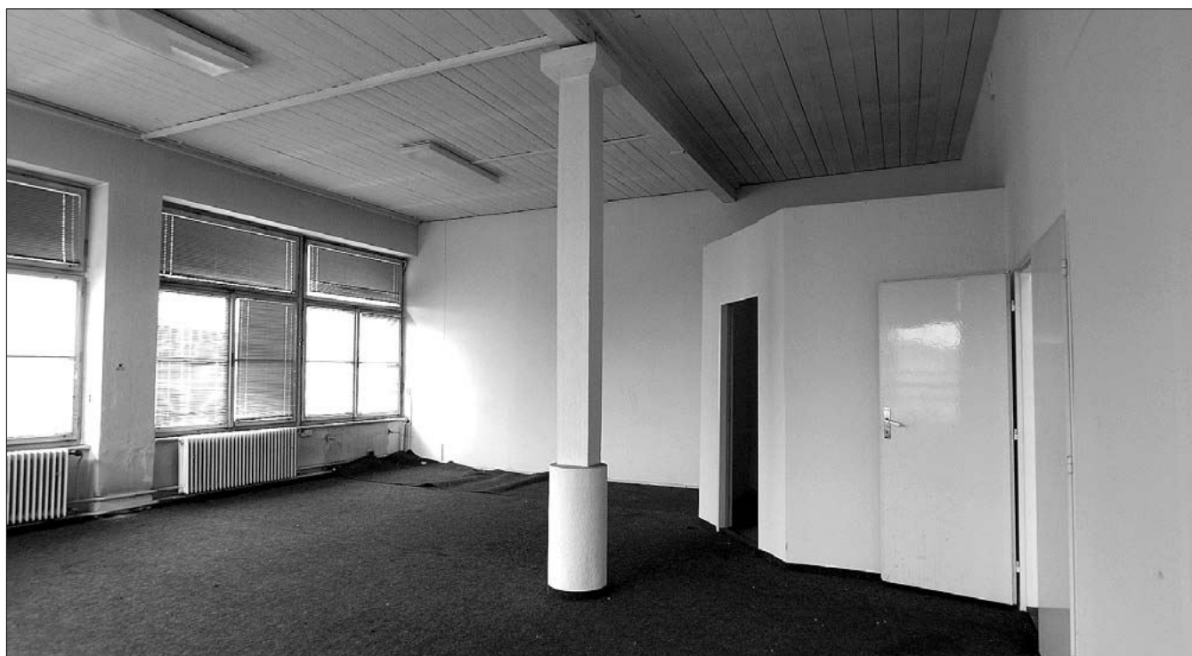
Obr. 40: Brno-Pisárky, čp. 405, bývalá kino-kavárna; dodatečně uzavřená krytá terasa v patře kavárny (foto J. Stará, 2009).
