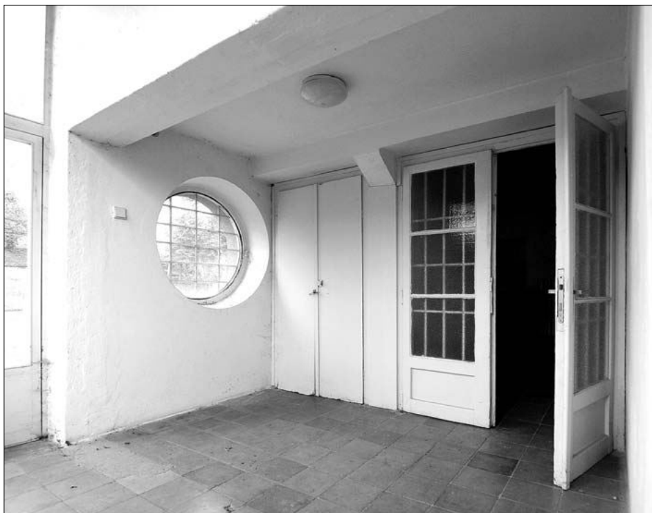
Obr. 36: Brno-Pisárky, čp. 405, bývalá kino-kavárna; hala pod schodištěm při zadním vstupu do budovy (foto J. Stará, 2009).
