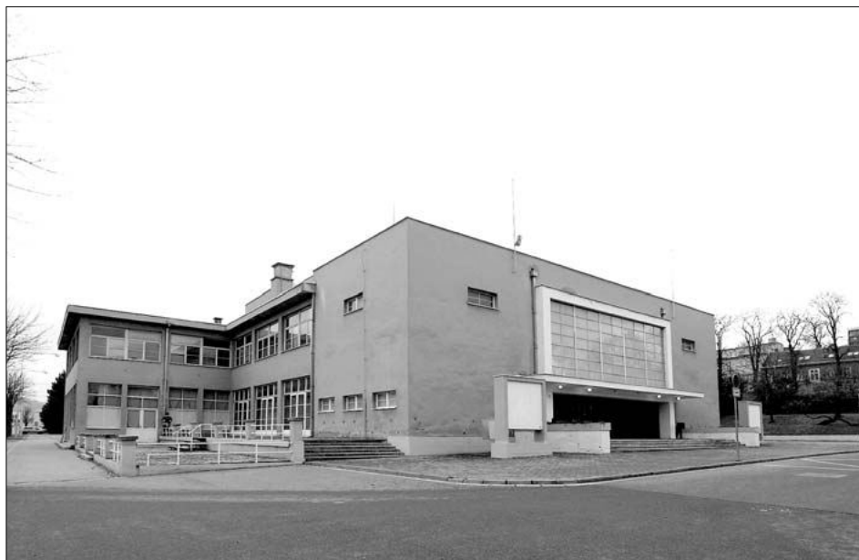
Obr. 21: Brno-Pisárky, čp. 405, bývalá kino-kavárna; celkový pohled od jihovýchodu (foto J. Stará, 2009).
