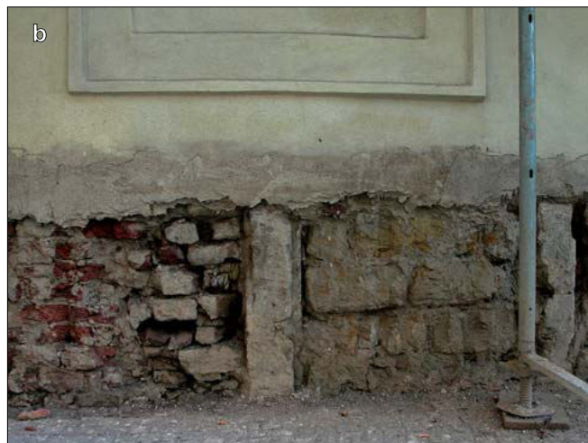
Obr. 15: Severní část uliční fasády domu Letenská čp. 33/III, za níž se skrývá interiér grotty: a – červeně archeologickým výzkumem objevený portálek točitého schodiště překrytý šambránou ze spodní řady oken. Dvě zamřížovaná okna nad touto řadou, mimo rytmus fasády, jsou původními okny grotty; b – stojky pískovcového portálku točitého schodiště na bázi dnešní uliční fasády. Vlevo zřetelné odsekání původního líce nároží renesančního Khynigovského domu čp. 33/III (foto: a – L. Smutka, b – M. Müller, podle zaměření M. Müllera dig. sestavil M. Ďurica).
