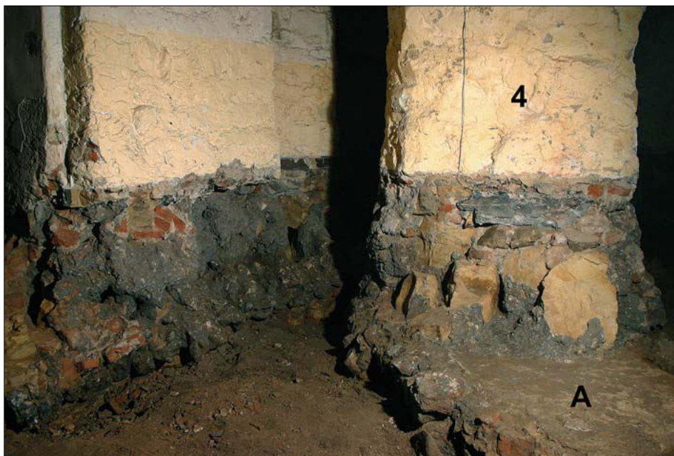
Obr. 9: Výškový rozsah fragmentů původní výzdoby, dochovaných pod pozdější podlahou pivovaru (rovná linie báze omítnutých a bíle natřených stěn). Zřetelné svisle rozpukané opukové balvany tvořící kostru suťoviště na úpatí stěn. A – plato mezi pilíři 3, 4. Pohled od severovýchodu (foto L. Smutka).
