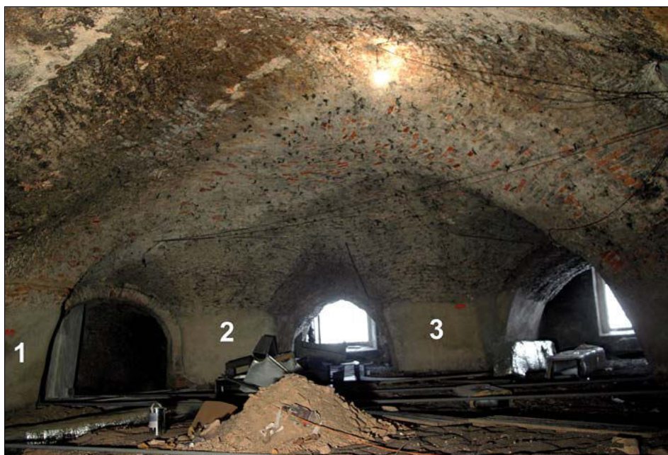
Obr. 7: Původní strop grotty (dnešního 1. patra) se stovkami drobných drátěných oček (častěji jejich zbytků), jimiž byly k zatlučeným skobám přivazovány prejzy s otvorem – jádra krápníků. Pohled od západu (foto M. Müller).
