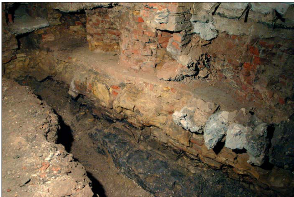
Obr. 26: Jižní část východní obvodové stěny budovy grotty. Povrch základového zdiva upraven do hladkého pláta, na obrubě řada hrud taveniny, lemující hladinu jezírka. Na dně jezírka tmavý tmel ze směsi jílu několika barev, z doby opravy jezírka po povodni. Nadzemní cihlové zdivo členěné do polosloupů a hrotitých výstupků. Nad úroveň podlahy pivovaru byla členitost zrušena a zarovnána. Pohled od jihozápadu (foto M. Müller).
