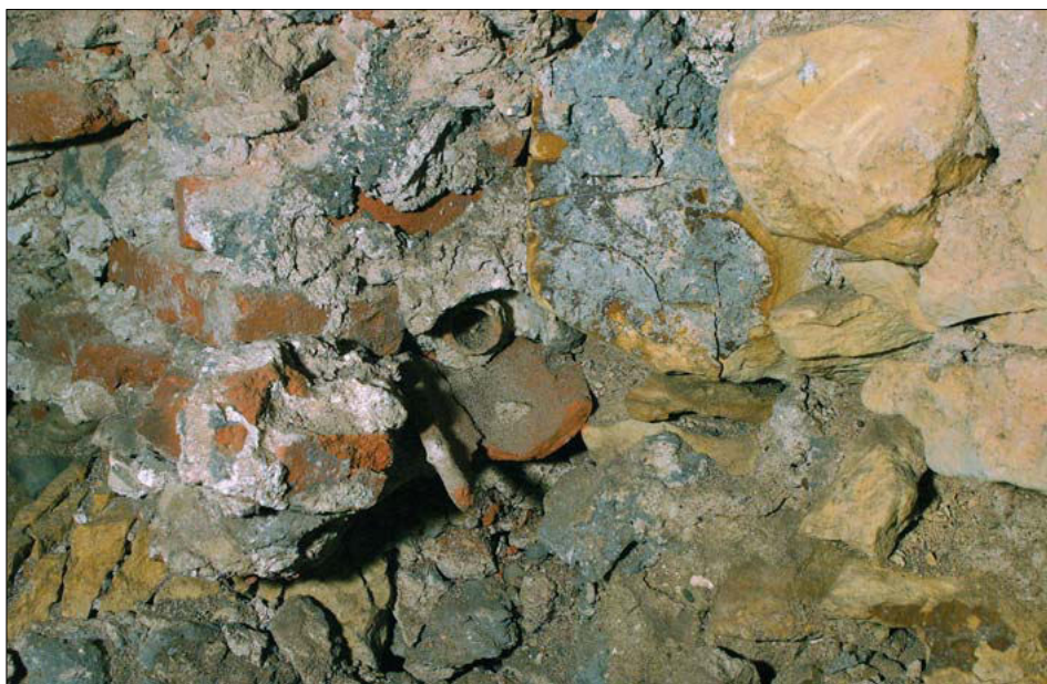
Obr. 17: Ústí keramického vodovodního potrubí typu A maltou fixované do lože z prejzu, v intaktní pozici zazděné ve stěně pilíře č. 5. Pohled od severu (foto L. Smutka).
