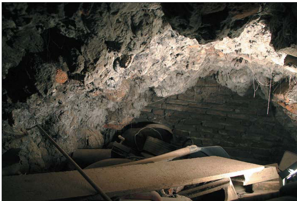
Obr. 8: Jediný zachovaný, téměř intaktní úsek původního stropu grotty s jizvami po velkých odlámaných krápnících, po nichž zbyly drátěné smyčky. Dnešní 1. patro, pohled od severu do nízké kóje za pilířem č. 2 (foto M. Müller).
