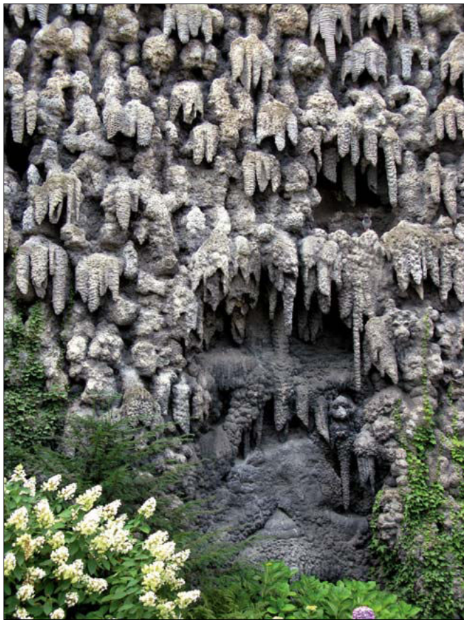
Obr. 6: Zazdívka původního vchodu se zřetelně odlišným ztvárněním do- datečně „krápníkové“ úpravy. Pohled od severu (foto M. Müller).
