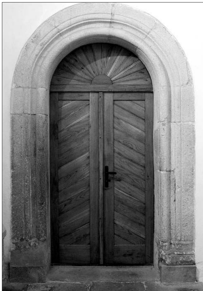
Obr. 8: Urbanov, kostel sv. Jana Křtitele. Pozdně románský portál v jižním vstupu do lodi z podvěží.
