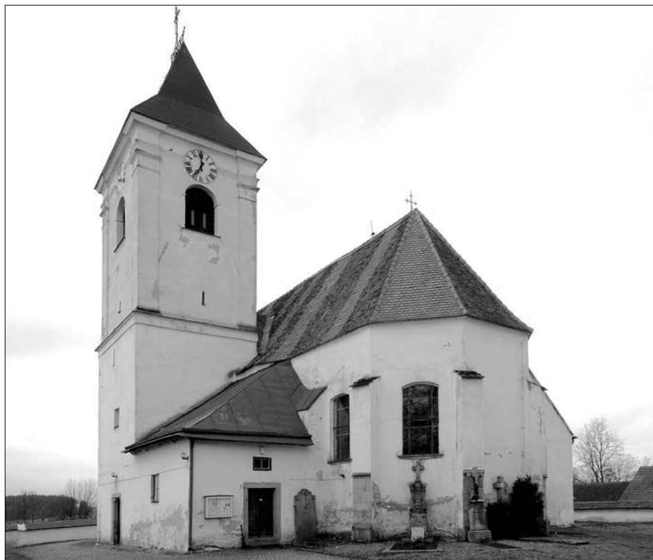
Obr. 6: Urbanov, kostel sv. Jana Křtitele. Pohled na kostel od jihovýchodu. Před věží po boku kněžiště je nová sakristie.
