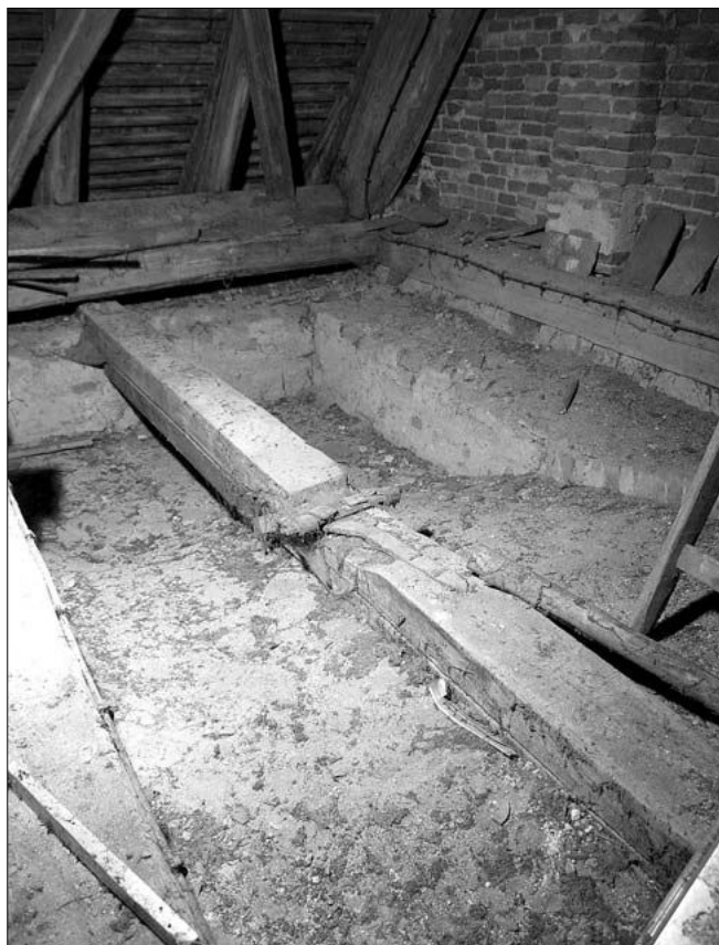
Obr. 13: Urbanov, kostel sv. Jana Křtitele. Západní část podkroví nad lodí. Trám z plochostropého interiéru lodi byl nad její západní částí využit k zavěšení železných táhel z patek pozdně barokní klenby. Trám s dendrochronologickou datací do roku 1527 je na třech stranách malovaný pomocí šablony.
