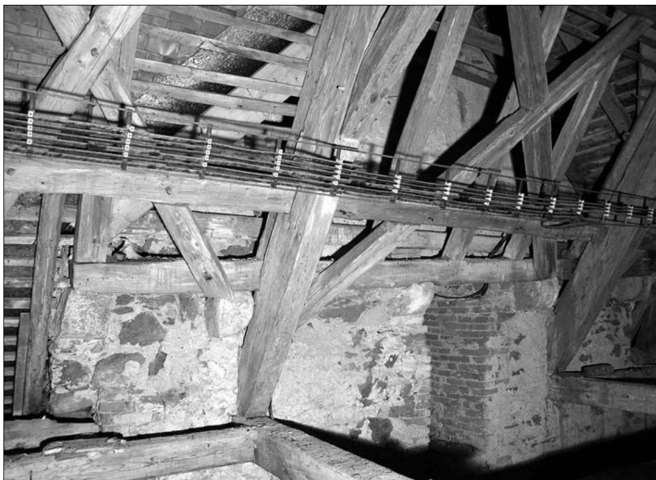
Obr. 11: Urbanov, kostel sv. Jana Křtitele. Severní stěna pozdně gotické věže v podkroví nad lodí. Kamenné krakorce, které původně zřejmě nesly útlabí středověké sedlové střechy lodí, posloužily k uložení výměny pozdně barokního krovu ze 60. let 18. století.
