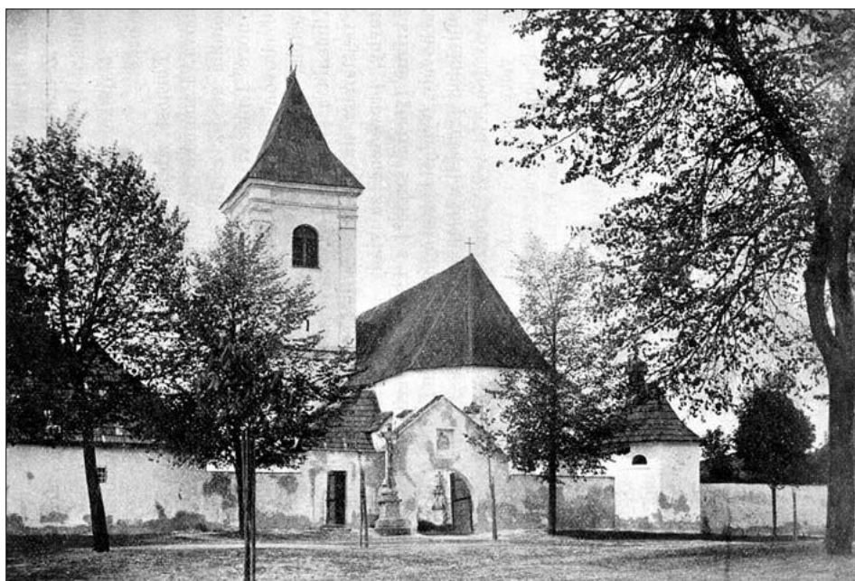
Obr. 5: Urbanov, kostel sv. Jana Křtitele. Stav kolem roku 1913. Pohled z návsi na kostel a starou hřbitovní bránu. Vlevo od brány bývalá hospodářská budova farního dvora upravená na márnici. Vpravo do hřbitovní zdi vektutá kaple sv. Barbory (převzato z: J. Tiray, o. c. v pozn. 6, s. 372, obr. 81).
