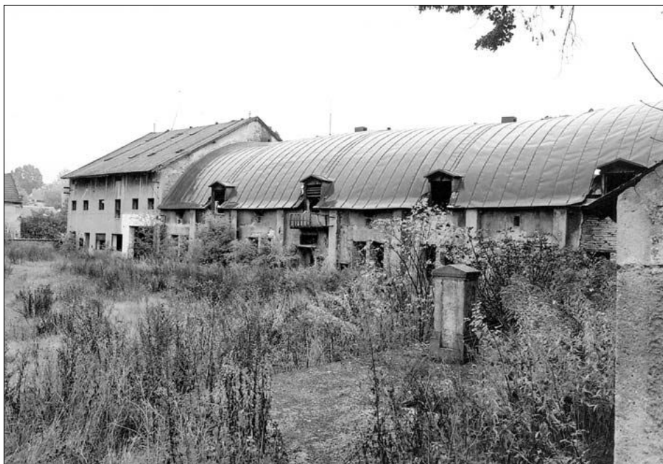
Obr. 15: Koleč (okres Kladno), pohled na budovu stájí se sýpkou s půlválcovou střechou z roku 1932.
