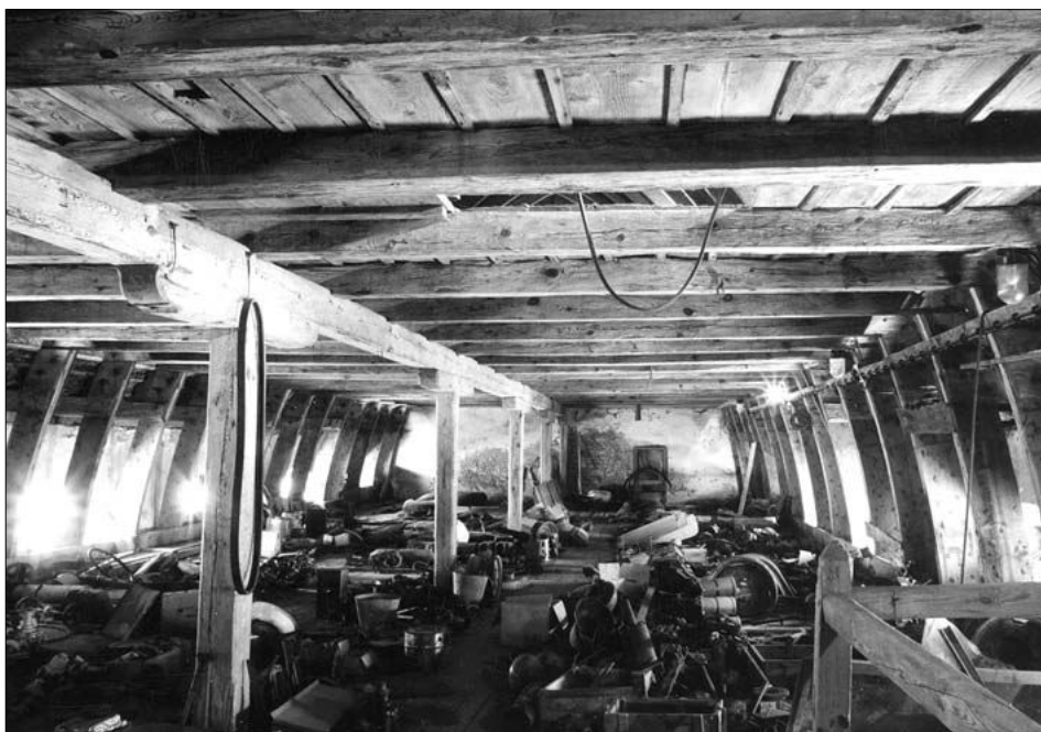
Obr. 4: Rymář (k. ú. Svárov), pohled do prostoru prvního patra sýpky se stropem osazeným na skružové segmenty.
