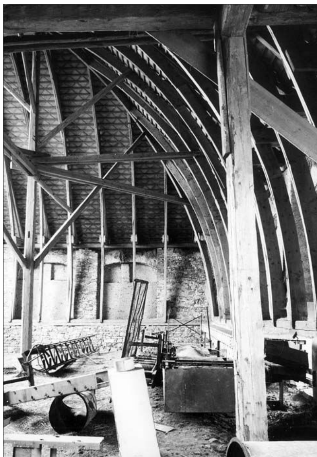
Obr. 6: Čabelice (okres Kutná Hora), bývalé panství Kácov, pohled na část interiéru v nároží stodoly se skružovým krovem.
