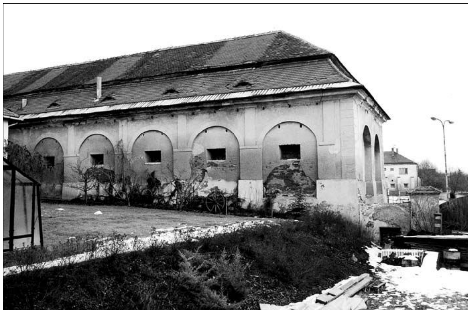
Obr. 9: Rudná – Hořelice (okres Praha-západ), bývalé panství Tachlovice, pohled na část budovy stávající s mansardovou střechou, nesenou skružovou konstrukcí s lomenými oblouky.
