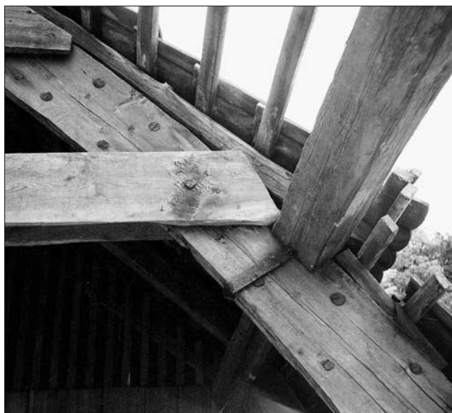
Obr. 10: Nížbor (okres Beroun), hospodářské stavení u domu při dnes zaniklé huti. Detail konstrukce krovy mansardové střechy s plnými skružovými vazbami.
