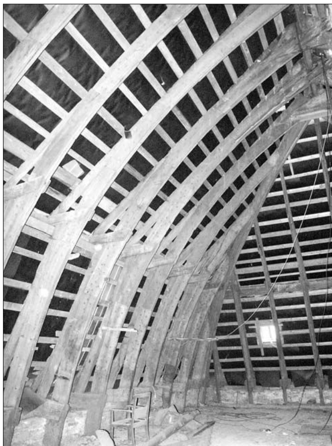
Obr. 8: Buštěhrad (okres Kladno), bývalé panství Buštěhrad, pohled na krov mansardové střechy obytného domu v areálu pivovaru (foto J. Pešta).
