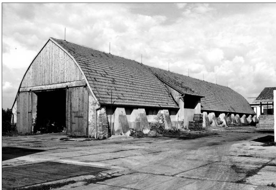
Obr. 18: Vrbice (okres Jičín), konstrukce krovu stodoly z roku 1960,
