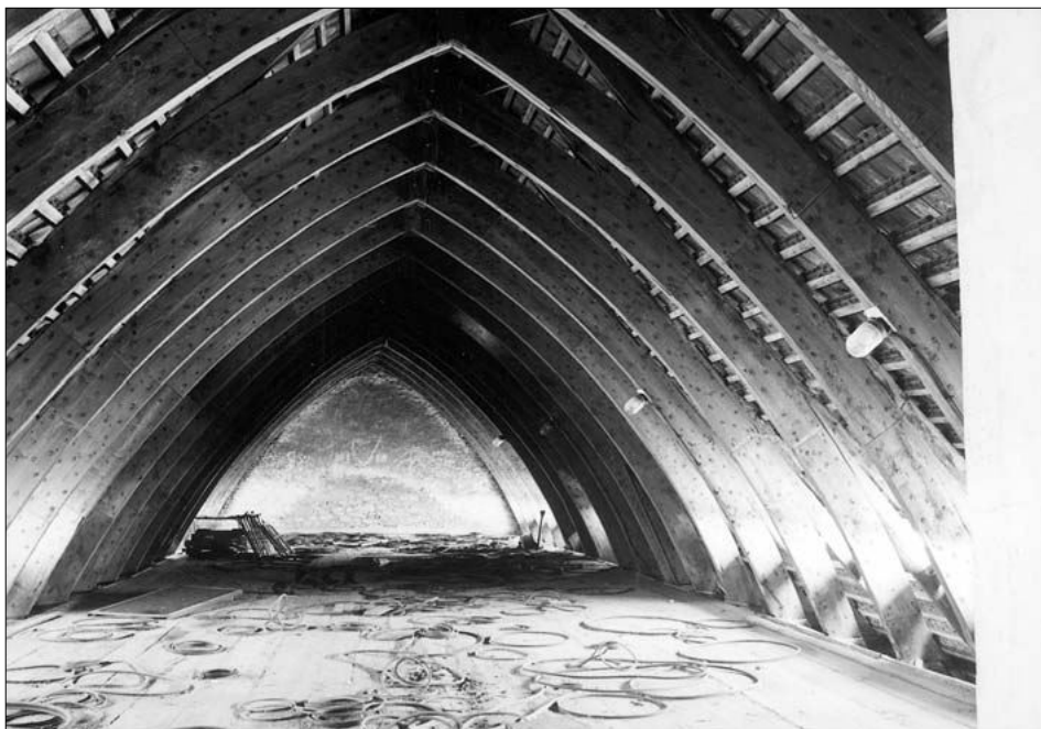
Obr. 3: Rymář (k. ú. Svárov, okres Kladno), bývalé panství Tachovice, pohled do podkroví sýpky se skružovými krovem.
