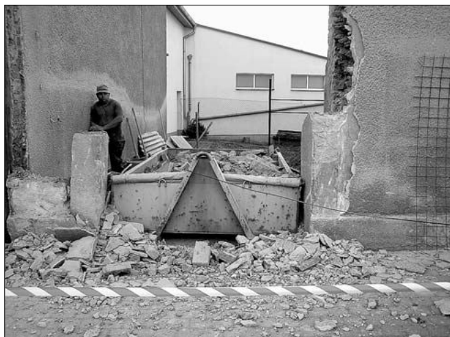
Obr. 10: Kralovice (okres Plzeň-sever), relikv městského domu, dříve čp. 31. Situace na místě je při akcích OPD často komplikována postupem stavebních či (v tomto případě) demoličních prací (foto J. Chaloupka, 2008).
