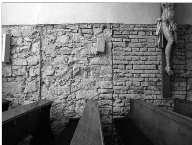
Obr. 6: Brno, Královo Pole (Brno-město), kostel Nejsvětější Trojice. Západní část jižní stěny kostela (P. Dohnalová, 2008).
