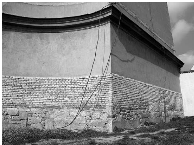
Obr. 11: Rajhrad (okres Brno-venkov), kostel sv. Petra a Pavla. Pohled na východní a část jihovýchodní zdi presbytáře kostela. V lici zdiva nad terénem jsou druhotně použity kvádry a architektonické články středověkého původu (foto P. Dohnalová, 2008).
