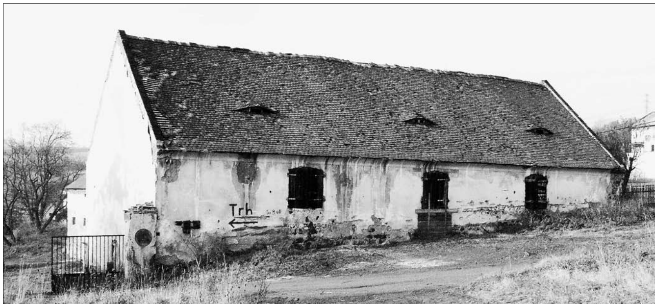
Obr. 36: Malhostice (okres Teplice), bývalé panství Teplice, stodola s neprůjezdnými mlaty a s nakládacími otvory ve vnější fasádě, postavená ve třetí čtvrtině 19. století.
