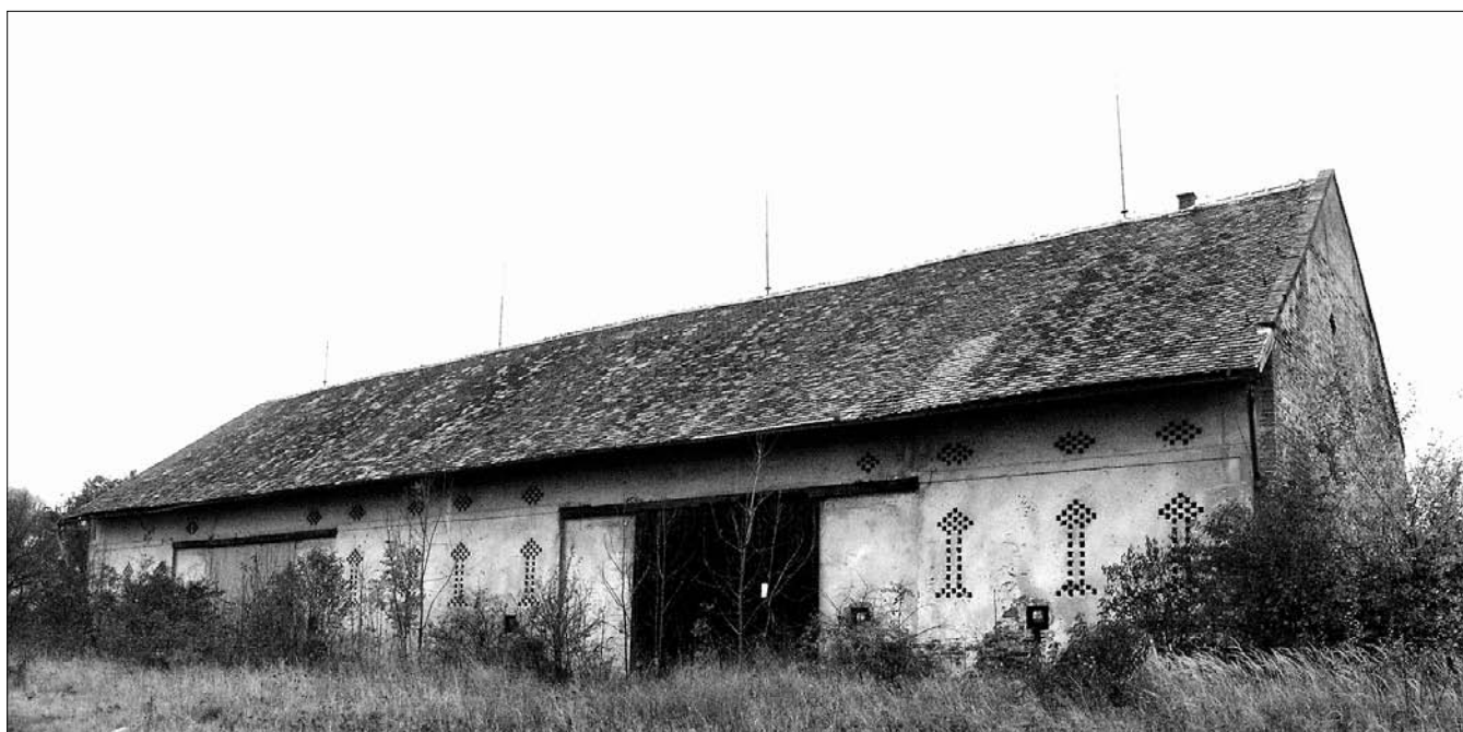
Obr. 49: Štěpánov (okres Pardubice), bývalé panství Choltice, stodola ze sklonku 90. let 19. století s pilřovou konstrukcí s ozdobně skládanými větracími otvory v tenkém výplňovém zdivu. Stodola byla od počátku vybavena posuvnými vraty.
