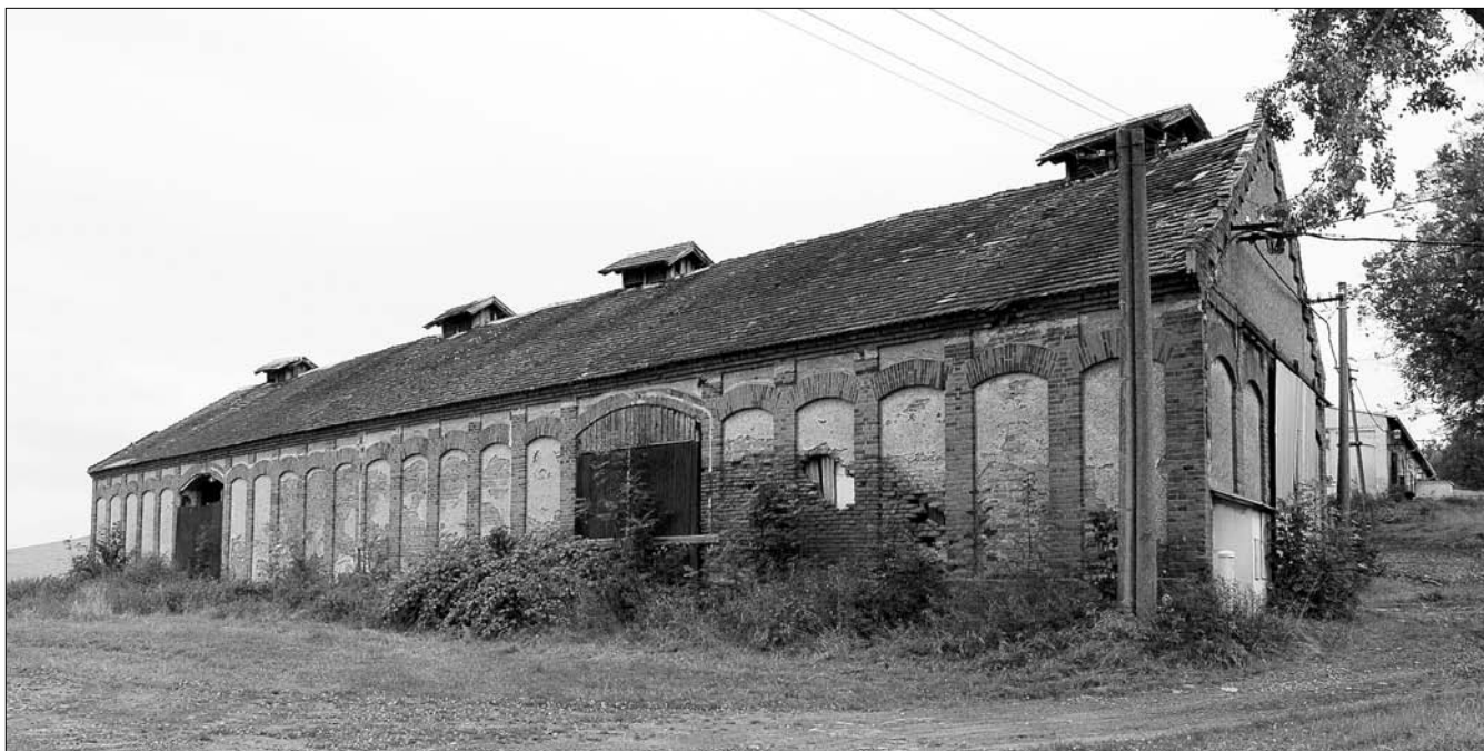
Obr. 50: Týnec (okres Klatovy), bývalé panství Týnec, stodola z počátku 20. století s výraznými větracími dýmnický na hřebenu střechy.
