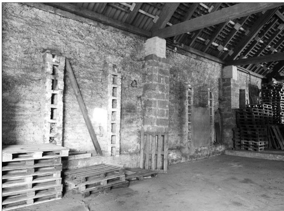
Obr. 29: Chomutice (okres Jičín), bývalé panství Kumburk, pohled na pilířovou konstrukci stodoly z třetí čtvrtiny 19. století s výplňovým zdívkem, ke kterému jsou ve třetinách polí přisazeny větrací pilířky, využívající komínový efekt.
