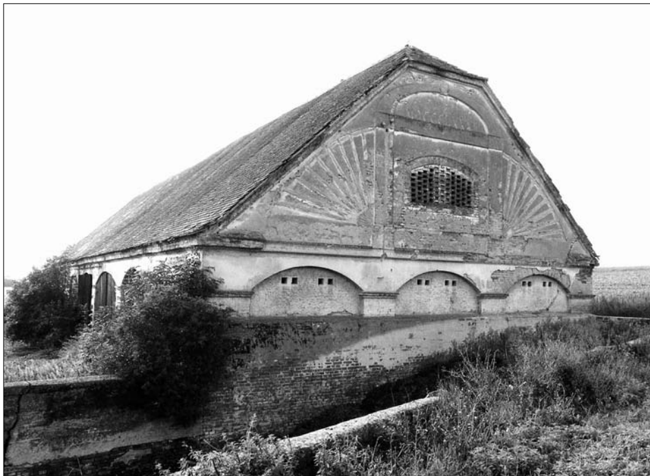
Obr. 28: Slavhostice (okres Jičín), bývalé panství Kopidlno, stodola z roku 1882. Bohaté architektonické členění fasády stodoly navazuje na podobu stodol stavěných na panství ve 40. letech 19. století. Novým prvkem je zde slepá arkáda s hlavicemi v patách archivolt a větrací systém využívající komínového efektu s drobnými výdechy v podřímí v horní části vpadlých polí.
