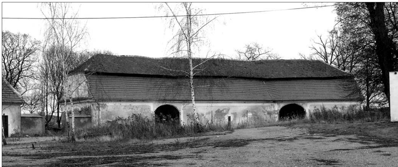
Obr. 12: Marianovice (k. ú. Jírovice, okres Benešov), bývalé panství Konopiště, stodola zalomeného půdorysu, zastřešená mansardovou střechou, stojí ve dvoře 22-bokého obrysu, postaveném ve 40. letech 18. století. Větrací systém je tvořen kombinací vertikálních a ležatých šterbinových průduchů, na fasádách lemovaných šambránami.
