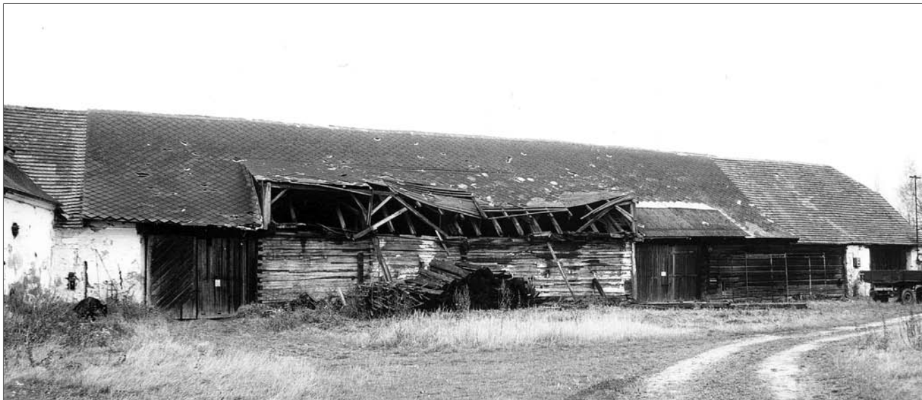
Obr. 16: Nový Dvůr (k. ú. Rožmítál pod Třemšínem, okres Příbram), bývalé panství Rožmítál, stodola s roubenou nádvorní stěnou.
