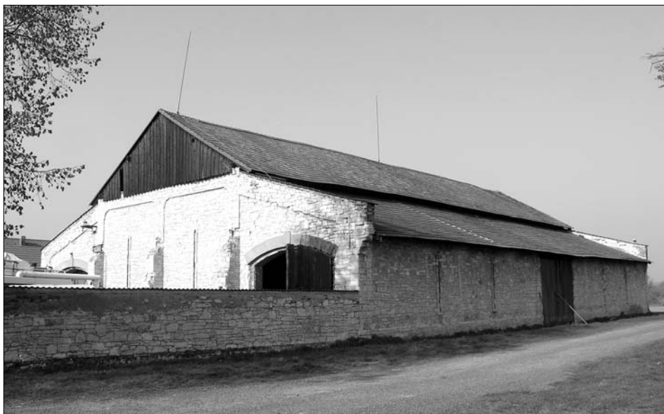
Obr. 40: Háj (lk. ú. Mšec, okres Rakovník), stodola s bočními podélnými mlaty a mlatem příčným, postavená v roce 1890 (foto E. Volfová).
