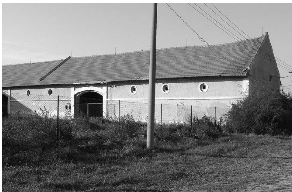
Obr. 34: Mažice (okres České Budějovice), bývalé panství Zálší, stodola s větracími kruhovými otvory v podřímsí.
