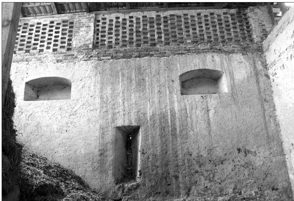
Obr. 52: Lhotice (okres Mladá Boleslav), detail stěny perny stodoly s dvěma typy větracích štěrbin a mladší větrací nadezdívkou, vytvořenou cihelnou mřížovinou s pilírkou.
