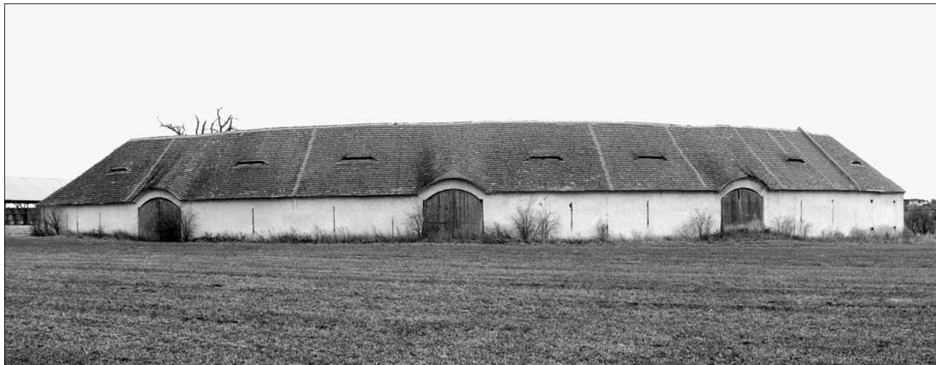
Obr. 15: Požáry (k. ú. Městečko, okres Rakovník), bývalé panství Křivoklát, stodola segmentového půdorysu o třech průjezdných mlatech s malou sýpkou, postavená na sklonku 18. století. Každé perné odpovídá pultový vikýř s náběhy.
