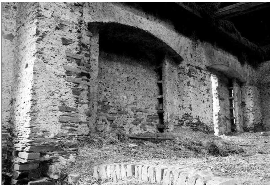
Obr. 30: Tupadly (okres Kutná Hora), bývalé panství Žleby a Tupadly, pohled na pilířovou konstrukci stodoly z 19. století s pásy a koutovými větracími pilířky. V popředí rubový pás klenby sklepa pod pernou.
