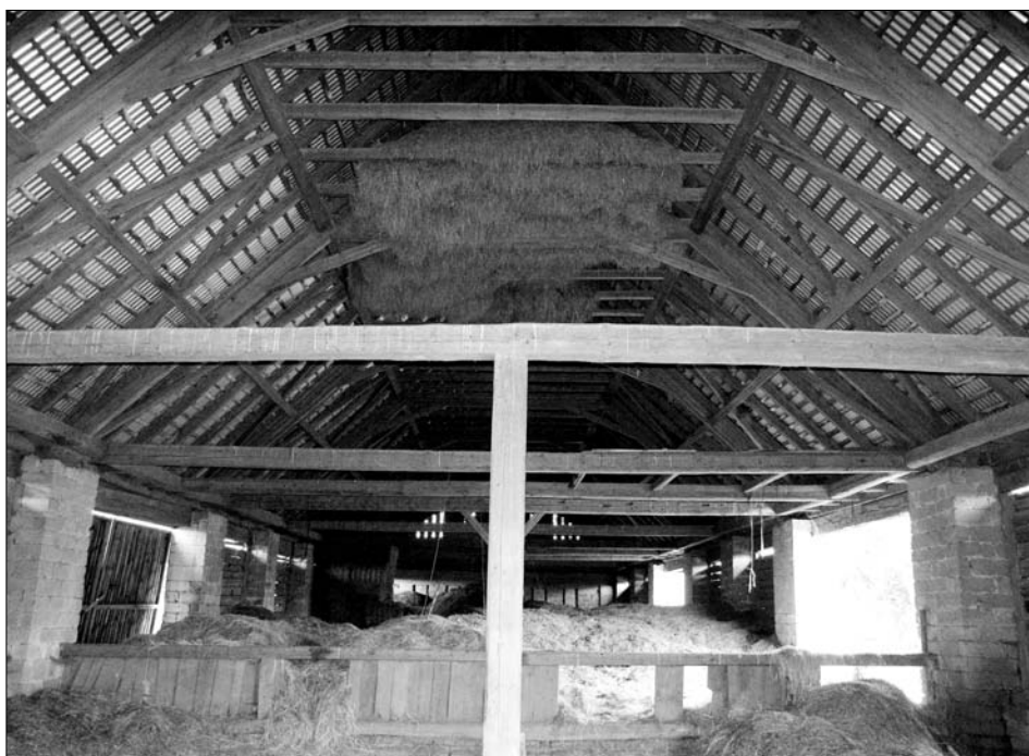
Obr. 25: Bartoušov (okres Jičín), interiér stodoly s pilířovou konstrukcí bočních stěn a hambalkovým krovem s ležatými stolicemi. Částečně jsou dochovány oplotně, oddělující mlaty od peren.
