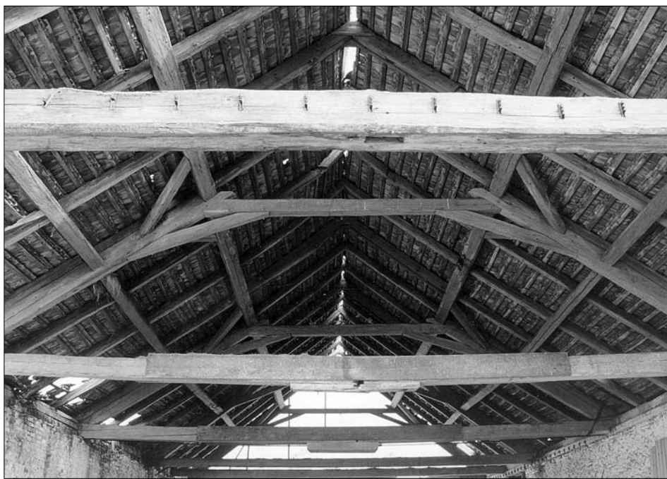
Obr. 31: Nový Ronov (okres Nymburk), pohled do krovy Rankovy úsporné konstrukce. Při zastřešování stodol v 50. a 60. letech 19. století byl Rankův krov tohoto typu velmi oblíbený.
