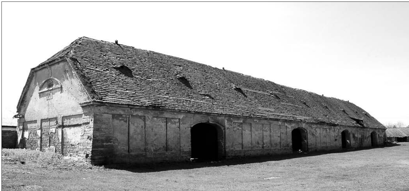
Obr. 19: Hospozín (okres Kladno), bývalé panství Zlonice, stodola o čtyřech mlatech, postavená v roce 1836 podle Joendlova vzorového návrhu, publikovaného v roce 1828 v tabulce č. I. Střechu nese hambalkový krov s ležatými stolicemi. Plné hambalky jsou pouze v plných a středních jalových vazbách, v ostatních jalových vazbách mají hambalky podobu krátčat.
