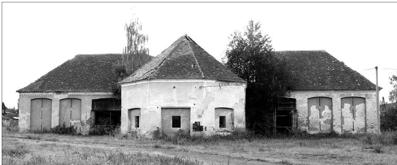
Obr. 38: Nahý Újezdec (okres Tachov), bývalé panství Planá, pohled na stodolu s velkým polygonálním mlatem se žentourem ze 60. let 19. století, přisazeným ke střední perně. Fasády peren člení vysoká segmentově sklenutá vpadlá pole, typická pro dobu vzniku stodoly.
