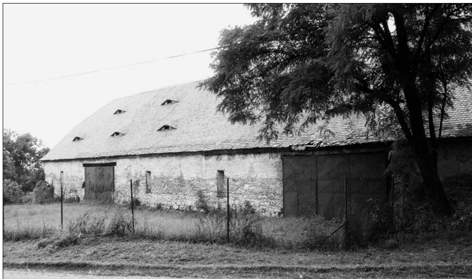
Obr. 10: Vidovle (okres Louny), bývalé panství Postoloprty, barokní stodola s oboustranně špaletovanými větracími šterbinami. Na střeše, nesené dosud hambalkovým krovem s ležatými stolicemi, jsou dvě patra vikýřů z 19. století.
