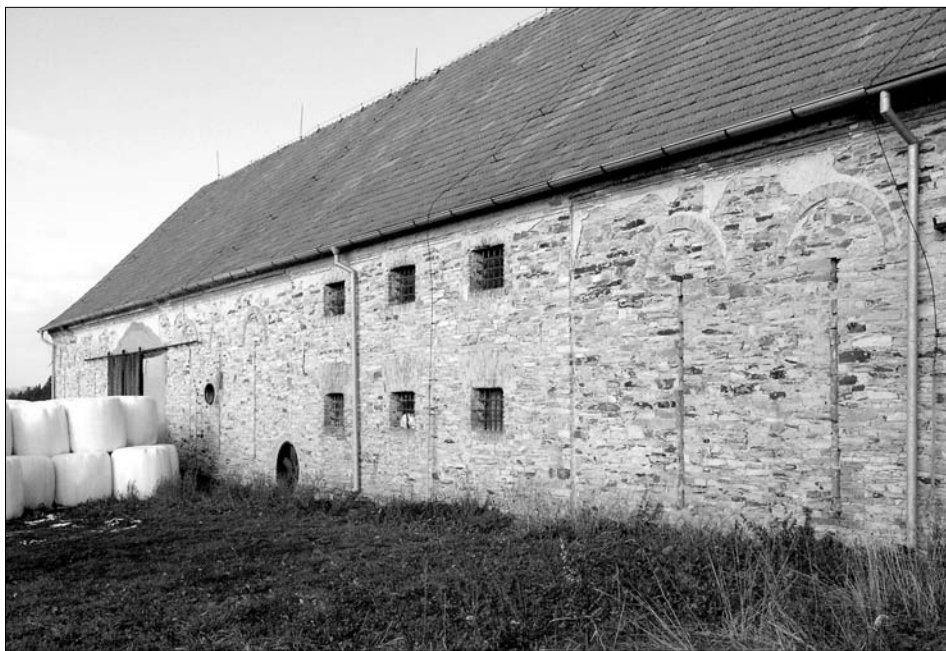
Obr. 27: Ledská (okres Rychnov nad Kněžnou), bývalé panství Častolovice, stodola se sýpkou začleněnou ve středu stavby mezi perny. Stodola byla postavena s celým dvorem ve druhé čtvrtině 19. století.
