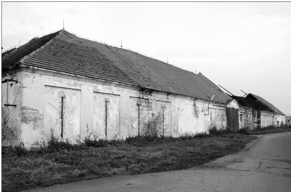
Obr. 26: Ramš (okres Česká Lípa), bývalé panství Nový Zámek (Zahrádka), výstavná stodola postavená v polovině 19. století, stavebně spojená se současným křídlem chlévů. Střední fasády obou křídel, členěných vpadlými poli, zdůrazňují trojúhelné štíty. Střešku nese hambalkový krov.
