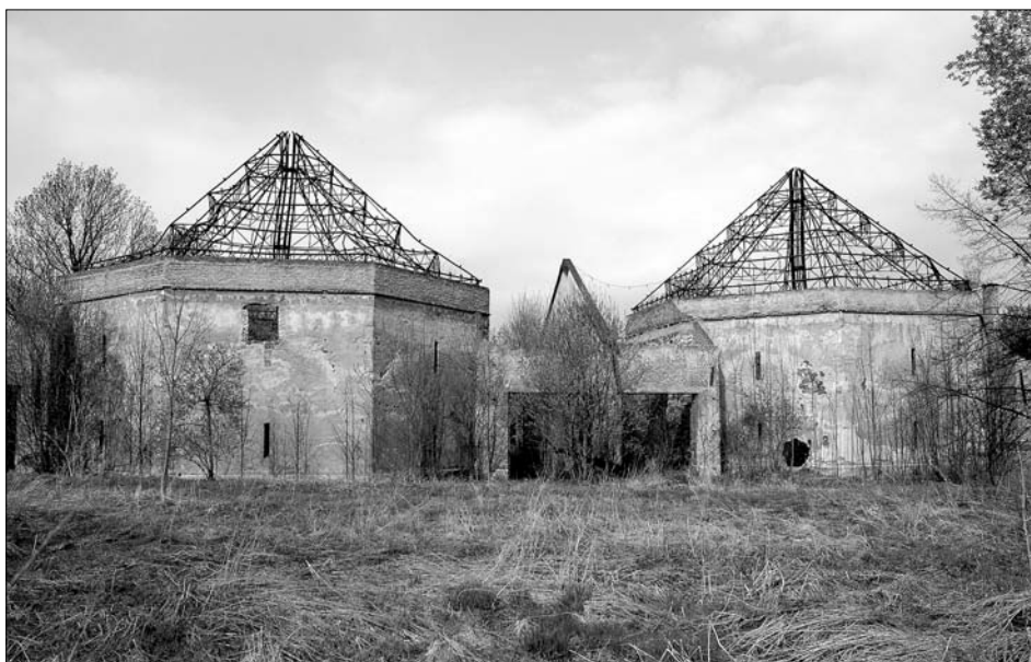
Obr. 39: Černousy (okres Liberec), bývalé panství Frýdlant, stodola anglického typu s dvojicí osmibokých vysokých peren, postavená zřejmě ve 30. letech 19. století. Mezi pernami a po jejich bocích jsou vždy dvojice nízkých příjezdných mlatů. Perno mají novodobé ocelové krovky osazené na betonové věnce.
