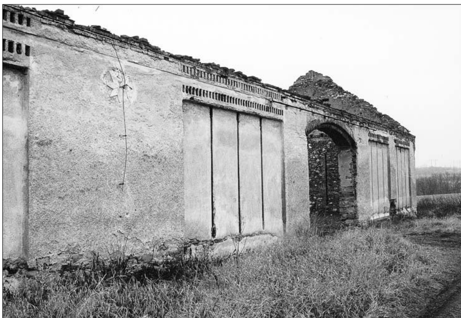
Obr. 17: Čejkovice (okres Benešov), bývalé panství Český Šternberk, pohled na část stodoly z 20. let 19. století s vysokými štěrbinami doplněnými pásy drobných větracích otvorů v podřímsí.
