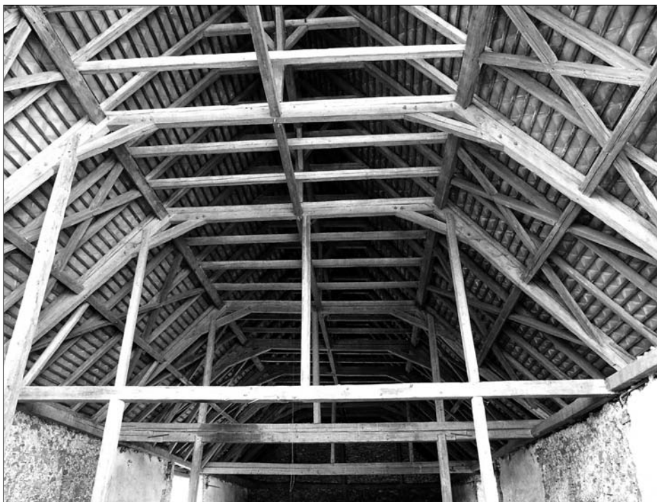
Obr. 7: Vřesná (okres Jindřichův Hradec), bývalé panství Kardašova Řečice, pohled na barokní krov stodoly. Stodola se svým stavebně-architektonickým řešením shoduje s Bayerovým návrhem stodoly pro dvůr Švamberk, podle kterého byla skutečně postavena. Větrací štěrbiny jsou umístěny v nikách se šikmými špaletami. Podle dochovaného plánu navrhl Bayer rovněž zásadní přestavbu dvora Vřesná.
