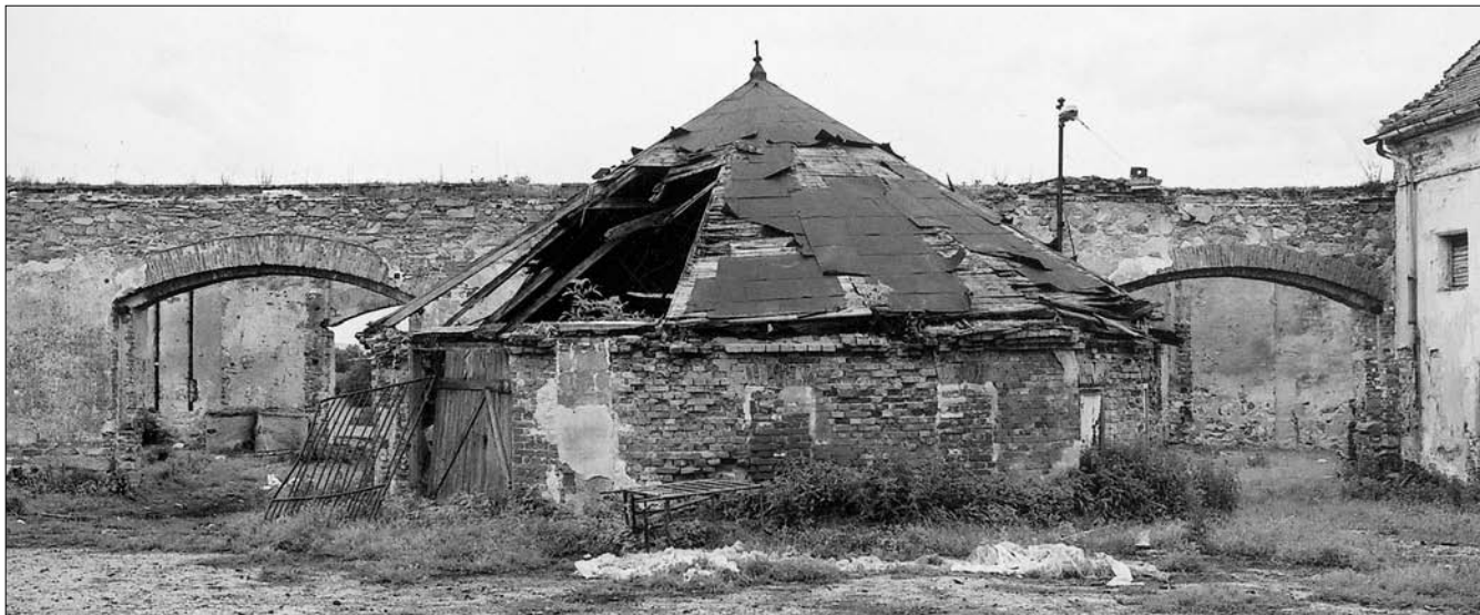
Obr. 37: Nové Hradky (okres České Budějovice), bývalé panství Nové Hradky, Zámecký Dvůr. Pohled na část stodoly s řezárnou, respektive malým mlatem se žentourem polygonálního půdorysu.
