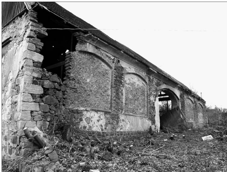
Obr. 32: Bělá (okres Karlovy Vary), bývalé panství Valeč, pohled na fasádu stodoly pilířové konstrukce stodoly s výplňovým zdivem ze 70.–80. let 19. století. V horní části pilířů jsou drobné výdechy komínových větracích průduchů.
