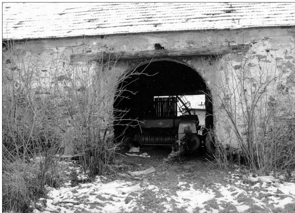
Obr. 11: Znosim (okres Benešov), bývalé panství Vlašim, půlkruhově sklenutý vjezd na mlat s vnější nikou s dřevěným nadpražím.
