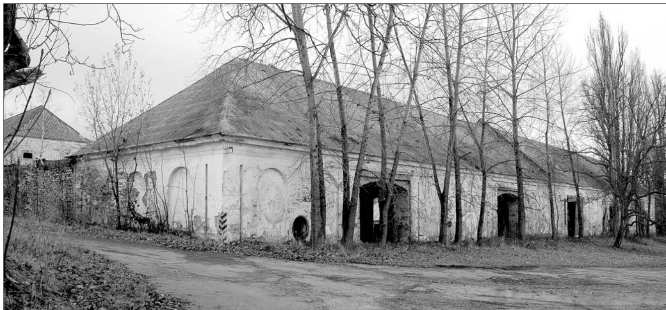
Obr. 23: Grabštejn (okres Liberec), bývalé panství Grabštejn, velká stodola o čtyřech mlatech, postavená v polovině 19. století. Patří k několika málo stodolám realizovaným podle vzorového návrhu, kde fasády člení pole půlkruhově sklenuté arkády, střídající se s úzkými poli obdélnými. V Grabštejně jsou do úzkých polí vloženy větrací štěrbin. Střechu stodoly nesl od doby výstavby krov Rankovy konstrukce.
