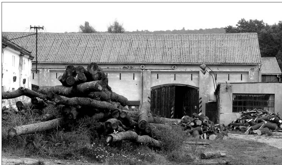
Obr. 33: Lužice (okres Litoměřice), bývalé panství Libčevěs, stodola s fasádami členěnými masivními lizénovými rámy s pásem větracích šterbin v podřímsí, postavená zřejmě v 70. letech 19. století.
