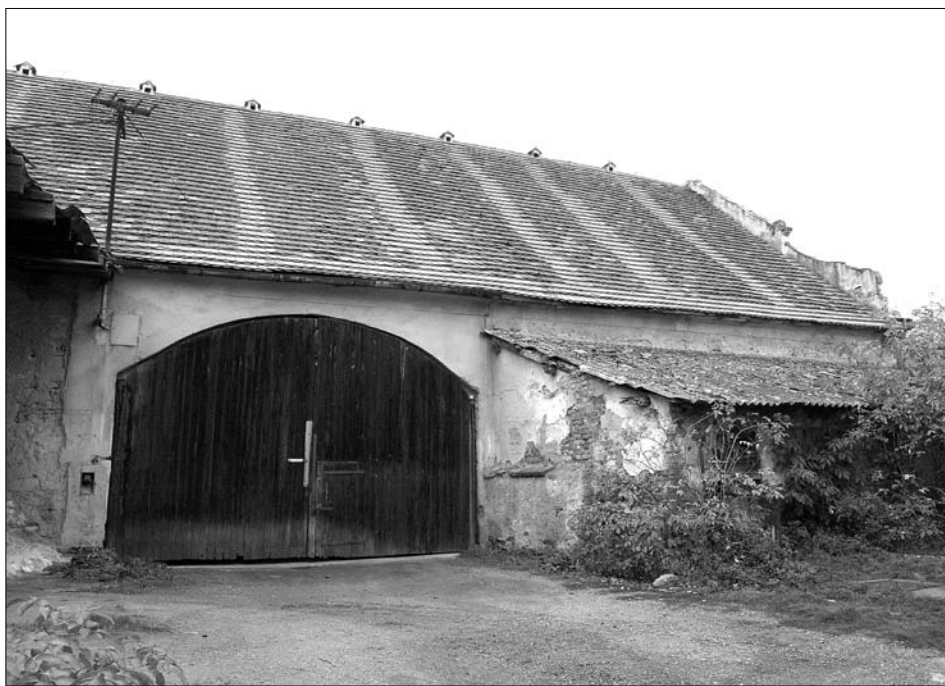
Obr. 53: Litice (okres Plzeň-jih), pohled na část stodoly s barokním štítem s volutovými křídly a trojúhelným nástavcem. Segmentově sklenutý široký vjezd na mlat pochází z úpravy v polovině 19. století, stejně jako větrací komínky na hřebenu střechy. Po pravé straně mlatu je k perně připojena řezárna. Stodola je příkladem různých stavebních a architektonických úprav hospodářské stavby.
