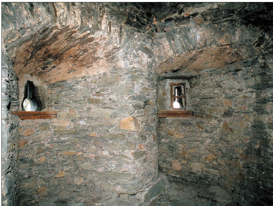
Obr. 13: Znojmo, věž za čp. 361. Komory s klíčovými střílnami ve 2. patře (vlevo východní střílna, s fragmentem obezdívky trámku u jeho pravého konce, vpravo jižní, natočená střílna) (foto autor, 2006).
