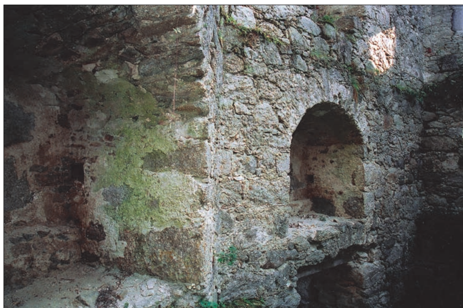
Obr. 26: Waxenberg (Horní Rakousko), předsunutá bašta hradu (kolem 1500). Dvě komory velkých střel s vy dřevěnými kapsami zasouvacích závor. Jednotlivá podlaží patrně nebyla vzájemně oddělena pevnými stropy. Vnitřek bašty tedy zřejmě vyplňovala samostatná trámová konstrukce, která snad umožňovala také uchycení zadních částí děl (foto autor, 2005).
