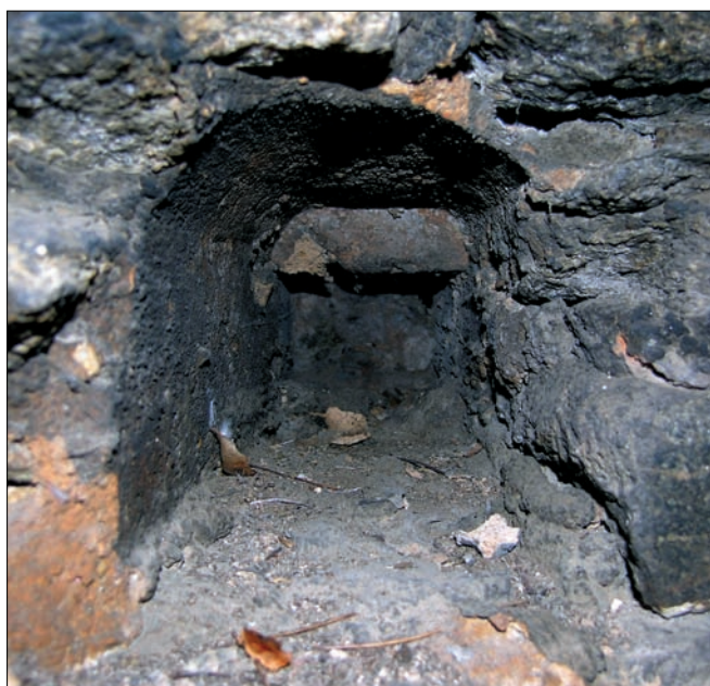
Obr. 17: Znojmo, věž za čp. 361. Detail negativu zhlaví jednoho ze stropních trámů 2. patra. Na konci otvoru je vidět negativ tesařského detailu, který prokazuje druhotné použití trámu (foto V. Tůt, 2010).
