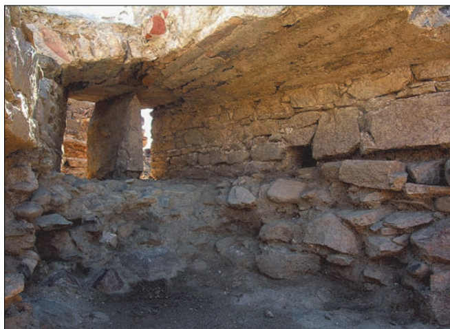
Obr. 30: Chomutov, komenda německých rytířů (kolem 1500?). Střílna se dvěma otvory a stopami uchycení v zadní části niky (foto autor, 2008).
