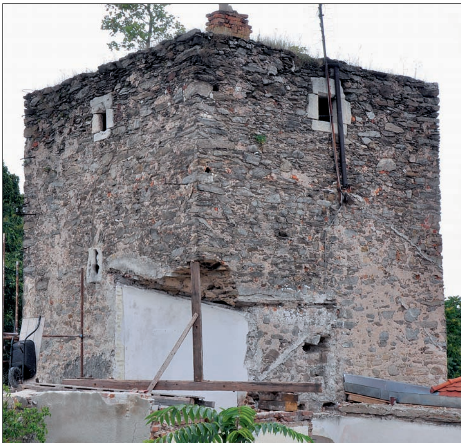
Obr. 9: Znojmo, věž za čp. 361. Pohled od severozápadu, s odbouranou spodní částí nároží (foto autor, 2009).
