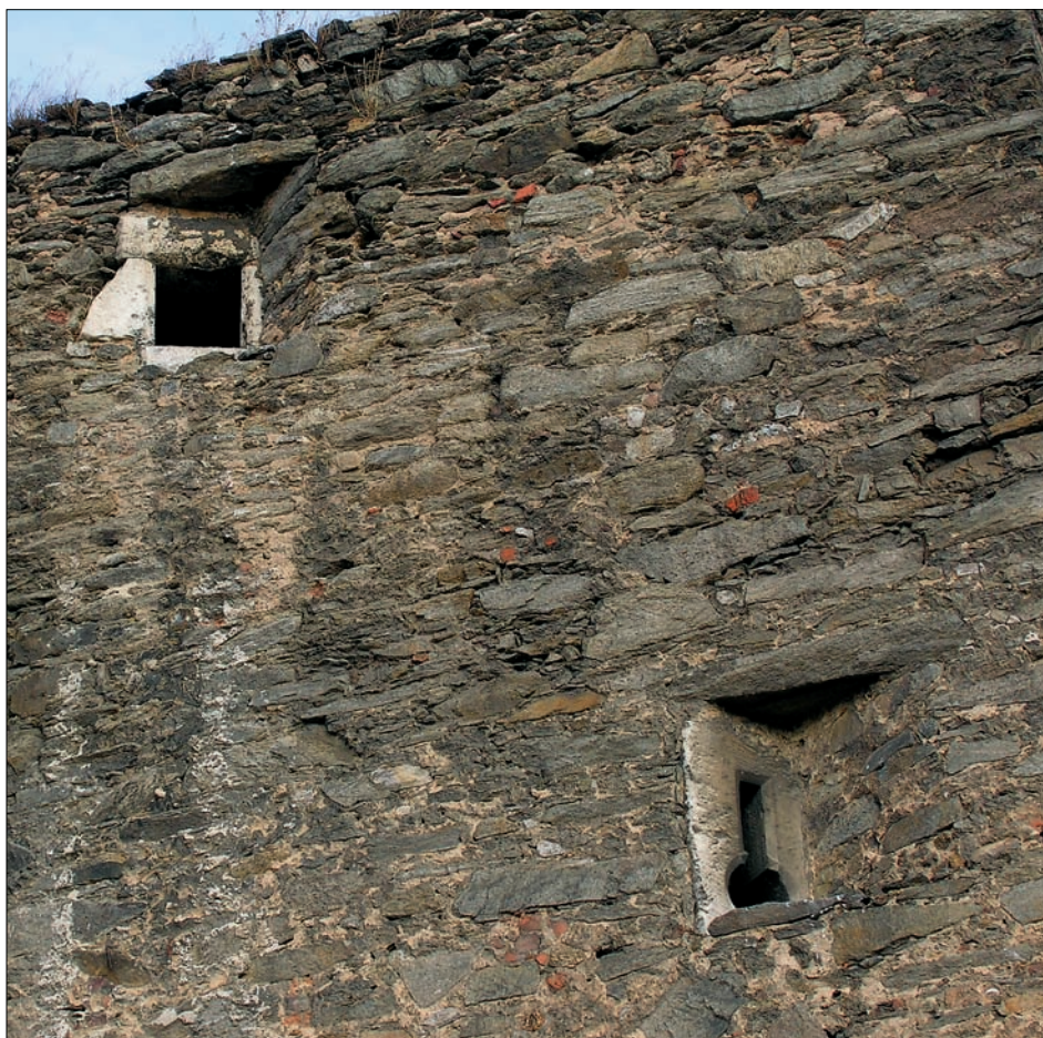
Obr. 6: Znojmo, věž za čp. 361. Detail jižního průčelí s šikmo natočenými střílnami 2. a 3. patra (foto autor, 2006).
