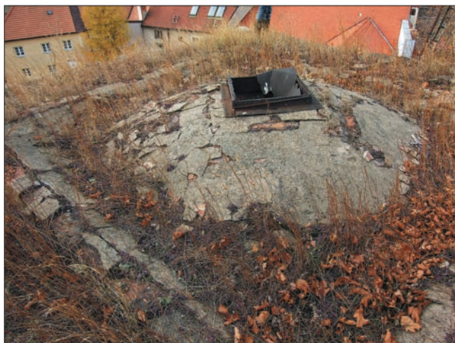
Obr. 19: Znojmo, věž za čp. 361. Koruna věže s rubem plackové klenby 3. patra a drážkou pro odvod vody (foto autor, 2006).
