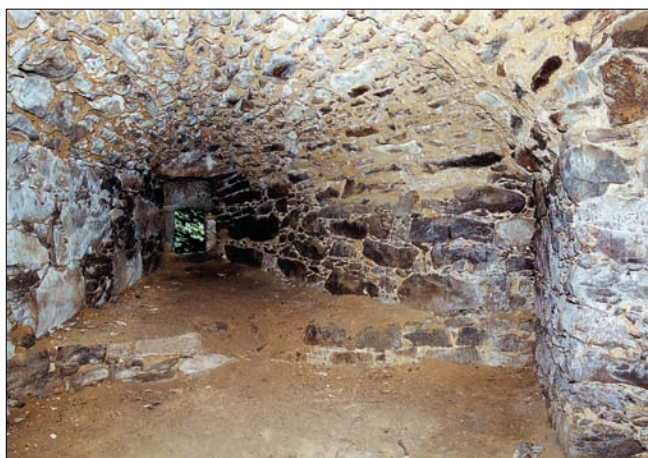
Obr. 24: Falkenstein (Horní Rakousko), předsunutá bateriová věž hradu. Některé střílny jsou pozoruhodné komorami s lomíci se špaletami, které patrně umožňovaly dočasné vkládání dřevěných konstrukcí umožňujících uchycení těžších palných zbraní (foto autor, 2005).
