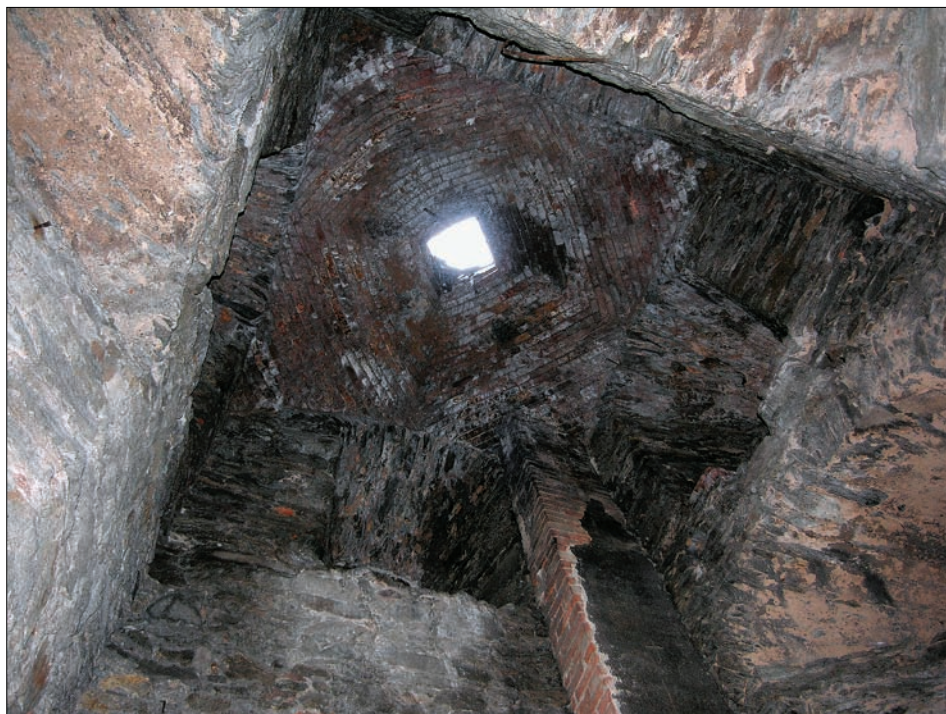
Obr. 11: Znojmo, věž za čp. 361. Průhled interiérem věže, nahoře cihelná placťová klenba s průlezem (stav před zbořením komína v severozápadním rohu) (foto autor, 2009).
