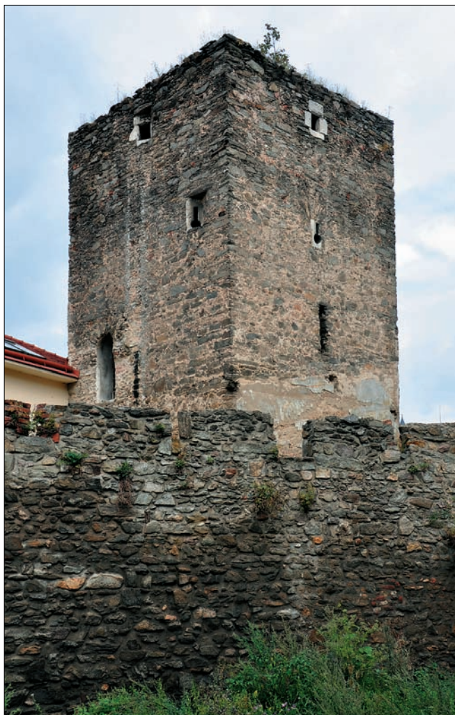
Obr. 3: Znojmo, věž za čp. 361. Celkový pohled od jihovýchodu. V popředí parkánová hradba (foto autor, 2009).
