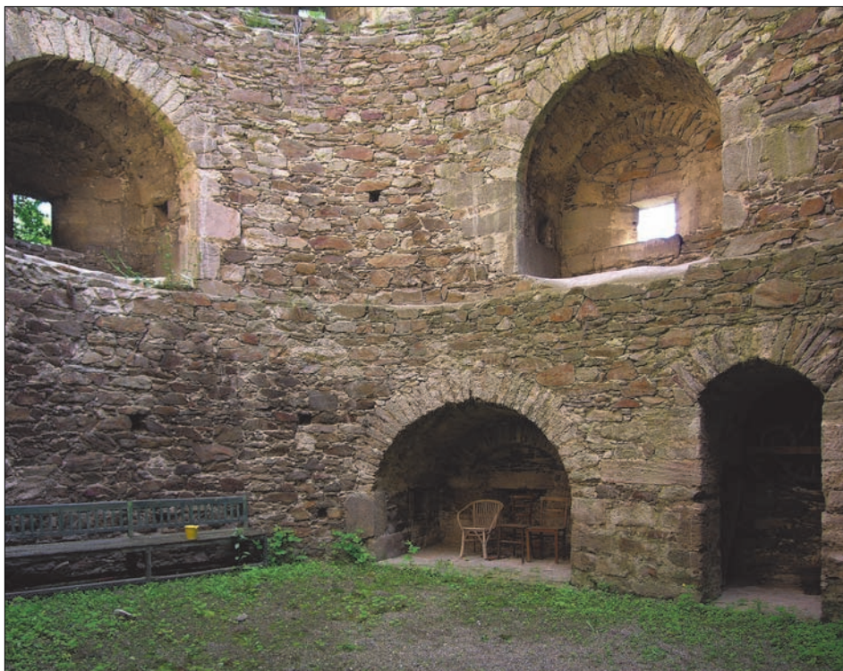
Obr. 27: Eggenburg (Dolní Rakousko), městské opevnění, bašta zv. Wahrsagerturm (kolem 1500 – polovina 16. století). Komory s velkými otvory střílen obsahují pouze odkládací výklenky, bez stop po uchycení zbraní. Podobně jako na Waxenbergu, ani zde patrně nebyly pevné stropy (foto autor, 2006).
