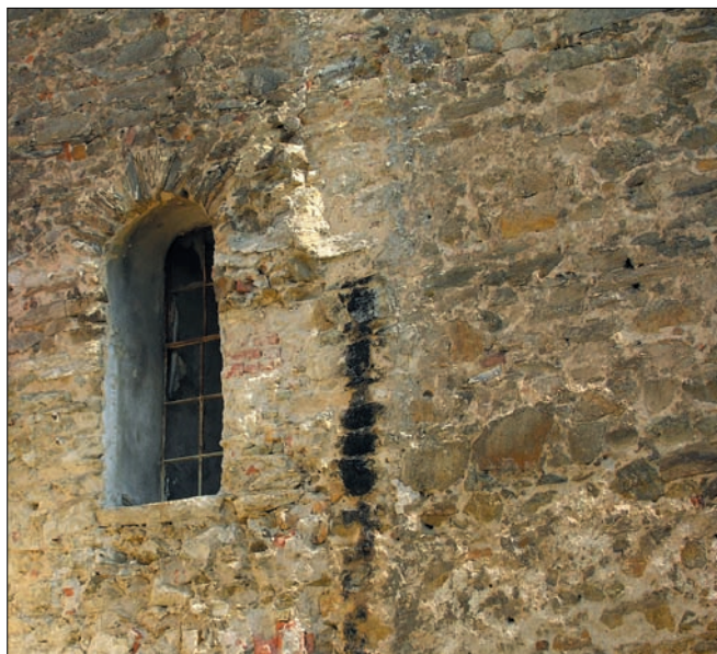
Obr. 5: Znojmo, věž za čp. 361. Detail původního vstupu do 1. patra (srov. obr. 4). Vpravo od záklenku vystupuje fragment vysoké předprsní zídky (foto autor, 2010).
