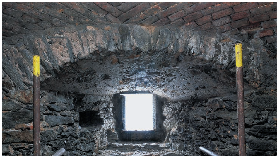
Obr. 15: Znojmo, věž za čp. 361. Výhled z východní střílny 3. patra. Před parapetním dílem ostění jsou patrné stopy zaniklého trámku pro zaklesnutí háku hlavní palné zbraně, vlevo ve špaletě negativ zhlaví zaniklého původního trámu. Nahoře náběh druhotné plackové klenby patra z cihel (foto V. Tůt, 2010).
