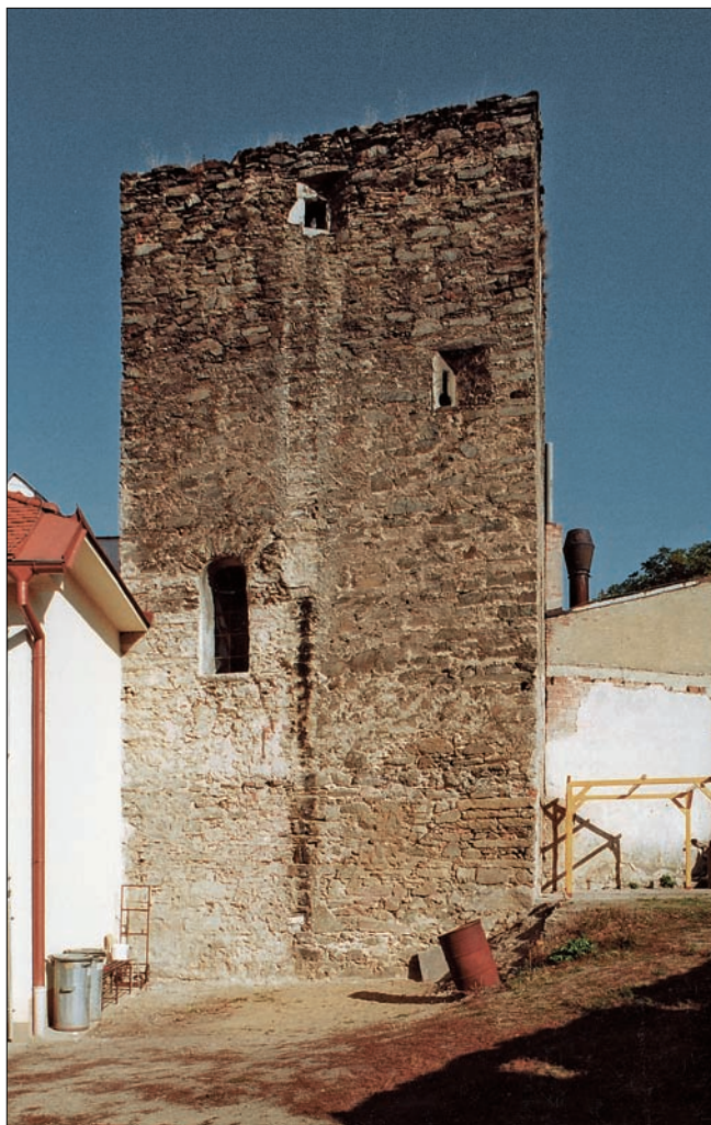
Obr. 4: Znojmo, věž za čp. 361. Celkový pohled na jižní průčelí. Vchod z 1. patra vedl na ochoz hlavní hradby, která byla odbourána (foto autor, 2006).
