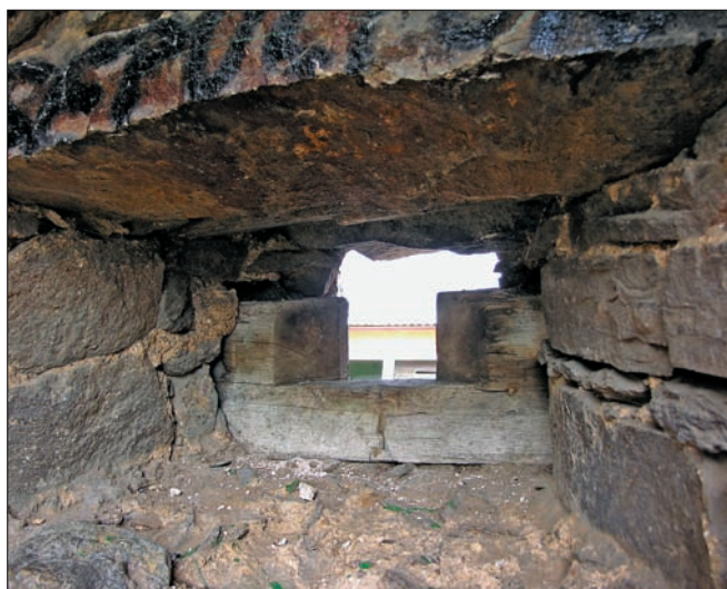
Obr. 20: Prachatice, městské opevnění, věž zv. Helvít (kolem roku 1500), dokumentace jedné ze střelnic určených pro těžší palnou zbraň. Snímek komory s dvojicí střelnic, snímek dřevěného ostění zvenku a zevnitř, zaměření, pohledová rekonstrukce (snímky autor, zaměření a kresba Zv. Dragoun, úpravy kreseb a jejich příprava k tisku J. Veselý).
