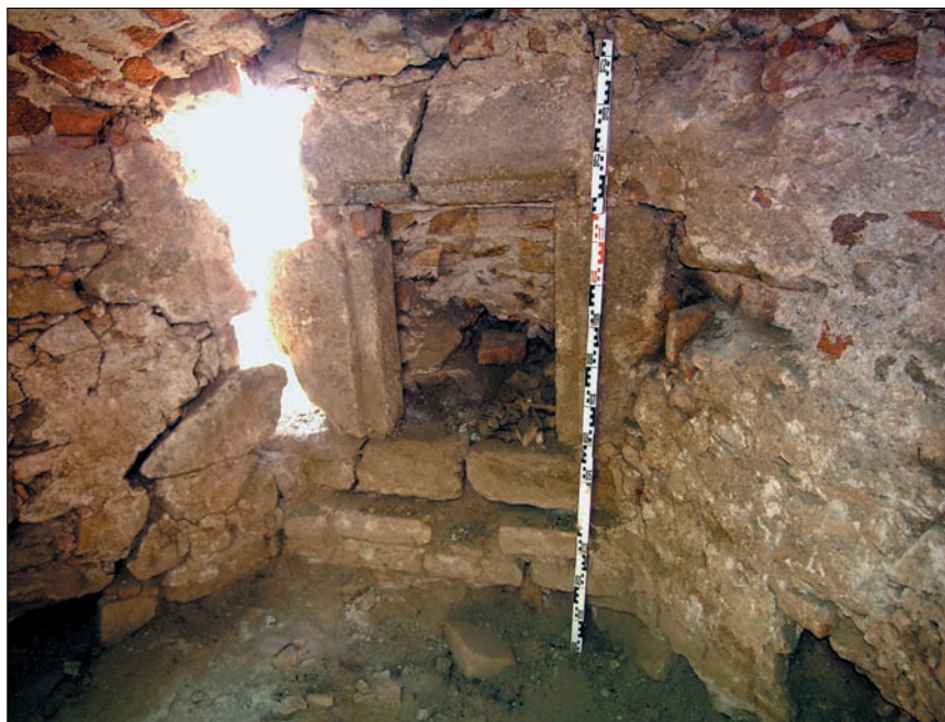
Obr. 29: Třebíč, jižní část opevnění bývalého benediktinského kláštera (cca závěr 15. století). Velkou střílnu bylo možno uzavřít okenicí, kterou zajišťovala nasazovací závora, jejíž využití zároveň pro zaklesnutí háku hlavně je sporné. Dole na rozhraní špalet a podlahy střílny jsou po stranách otvory, jejichž určení k uchycení zbraně rovněž není jisté (foto autor, 2008, zaměření půdorysu Zv. Dragoun 2008).
