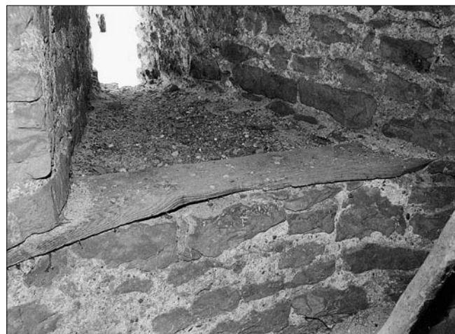
Obr. 31: Dvůr Králové nad Labem, městské opevnění, tzv. Šindelářská věž severní brány (60. léta 15. století). Podlaha niky jedné ze střílen má ve své nejširší části napevno zazděné původní prkno, jehož souvislost s uchycením palné zbraně není vyloučená (foto autor, 1998).
