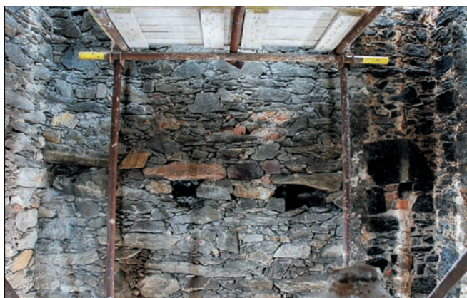
Obr. 16: Znojmo, věž za čp. 361. Pohled na západní stěnu 2. patra s vodorovnou řadou negativů zhlaví původních trámů, které probíhaly zhruba v polovině výšky prostoru podlaží (pravý otvor byl zazděn při zřízení novodobého komína, který stál v severozápadním rohu) (foto autor, 2009).
