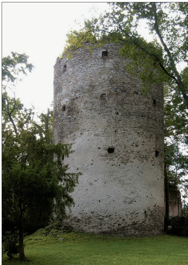
Obr. 32: Zruč nad Sázavou, bateriová věž vnějšího opevnění hradu (asi 2. polovina 15. století). Charakter nik střílen a jejich dřevěných trámů pro zaklesnutí háků hlavně nasvědčuje určení jen pro ruční palné zbraně, i když samotné průstřelnice jsou poměrně velké (foto autor, 2009).
