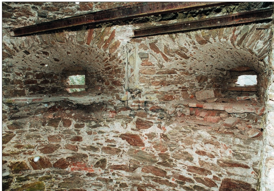
Obr. 33: Zruč nad Sázavou, bateriová věž vnějšího opevnění hradu (srov. obr. 32). Detail dvou střílen, jejichž niky byly ve spodních částech novodobě upraveny, a tak znehodnoceny pro průzkum (foto autor, 2000).
