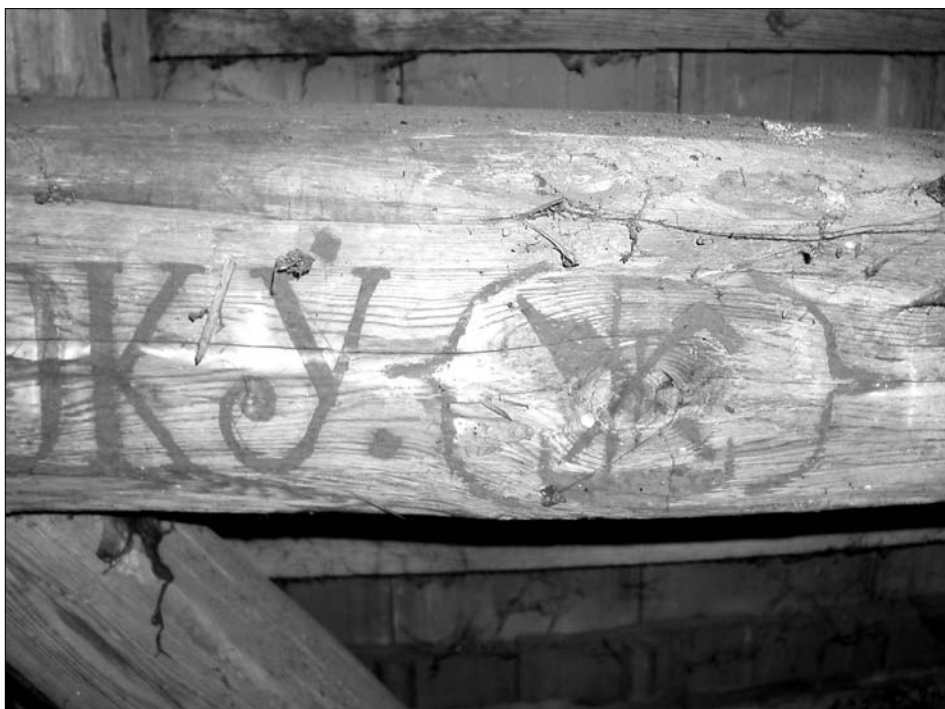
Obr. 9: Dešná (okres Jindřichův Hradec), krov přední části domu čp. 8, detail schématického vyobrazení tesařských nástrojů (foto J. Bláha 2010)
