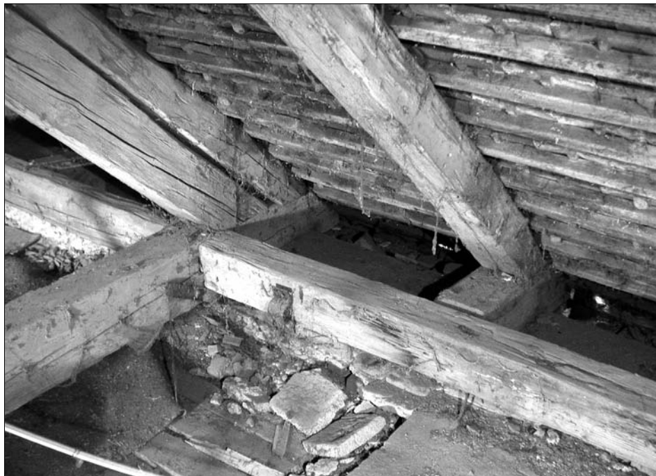
Obr. 3: Plačovice (okr. Jindřichův Hradec), dům čp. 9, detail prahové části krovu (1855/56 d) (foto J. Bláha, 2007).
