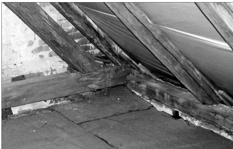
Obr. 4: Slavonice (okr. Jindřichův Hradec), dům čp. 533, detail prahové části krovu (1880/81 d) (foto J. Bláha, 2010).
