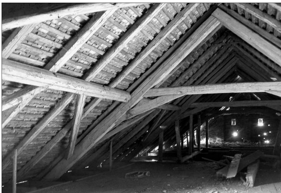
Obr. 1: Plačovice (okres Jindřichův Hradec), dům čp. 10, pohled do krovu (1852/53 d) nad dvorním křídlem se stájemi (foto J. Bláha, 2010).
