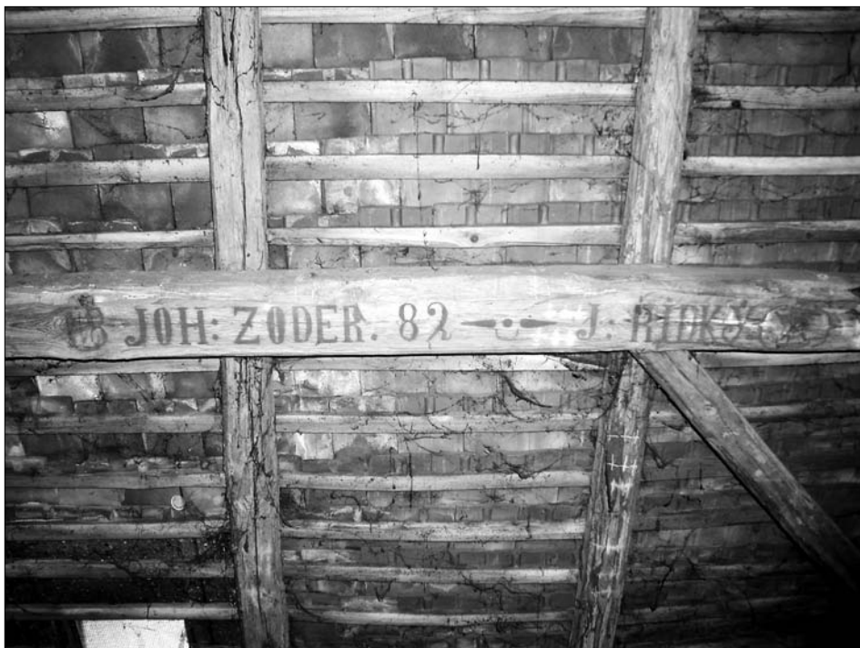
Obr. 8: Dešná (okres Jindřichův Hradec), krov přední části domu čp. 8, nápis s datací a jmény tesařů v krovu (foto J. Bláha 2010).
