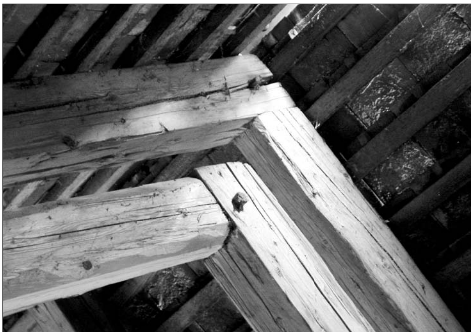
Obr. 2: Cizkrajov (okres Jindřichův Hradec), krov staré stodoly (1866/67 d), detail vazby v hřebeni střechy (foto J. Bláha 2008)
