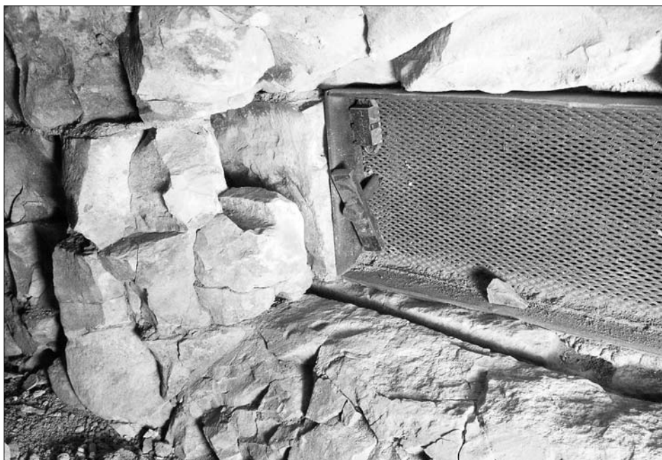
Obr. 4: Staré Město pražské, Husova ulice, dům čp. 156/I. Východní polovina východního okénka. Ve spodní partii patrná hrana okosení parapetní desky a východní stojky ostění, ve stojce kapsa středního prutu mříže a za ní kapsa pro zasouvání desky. Pohled od severozápadu (foto M. Semerád).
