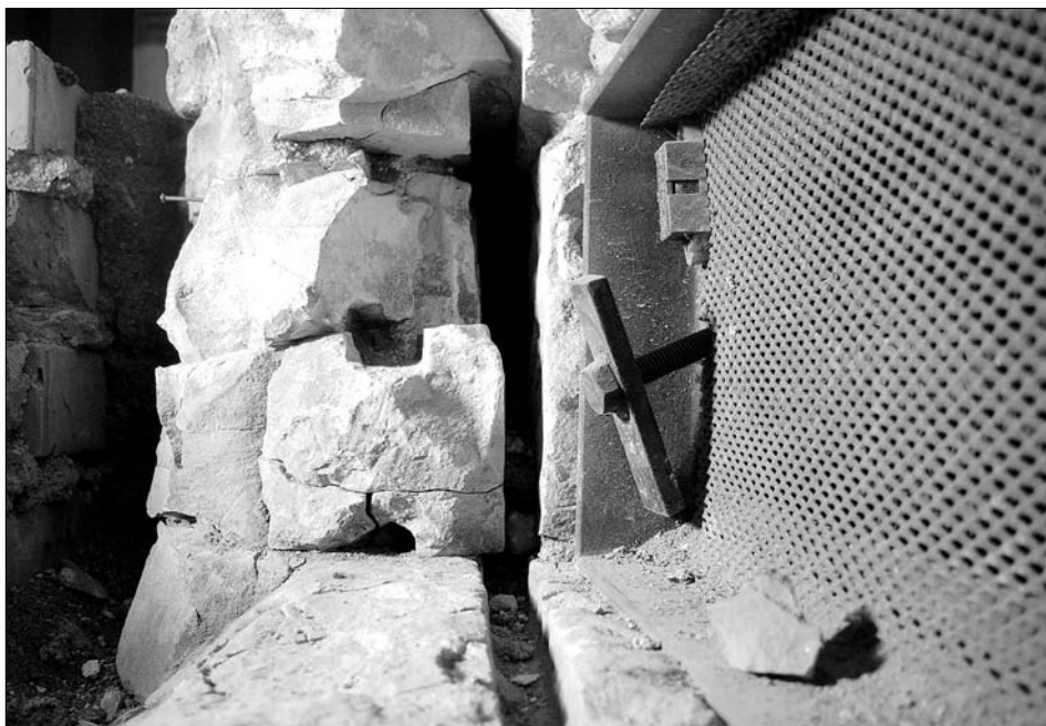
Obr. 6: Staré Město pražské, Husova ulice, dům čp. 156/I. Východní narušený bok ostění východního okénka s kapsou pro zasouvání desky, dolní a horní vodící drážkou a otvory pro umístění mříže. Pohled od západu (foto M. Semerád).
