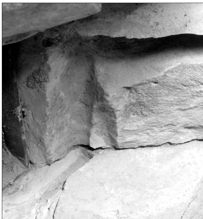
Obr. 8: Staré Město pražské, Husova ulice, dům čp. 156/I. Detail válcovitého zakončení škvíry pro přesah zasouvací desky na západním boku a dolní vodící drážky západního okénka. Pohled od východu (foto M. Semerád).
