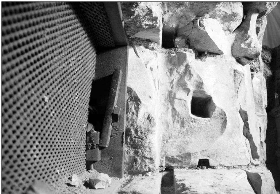
Obr. 5: Staré Město pražské, Husova ulice, dům čp. 156/I. Západní odlomený bok ostění východního okénka s dolní a horní vodící drážkou zasouvací desky a s otvory pro umístění mříže. Pohled od východu (foto M. Semerád).
