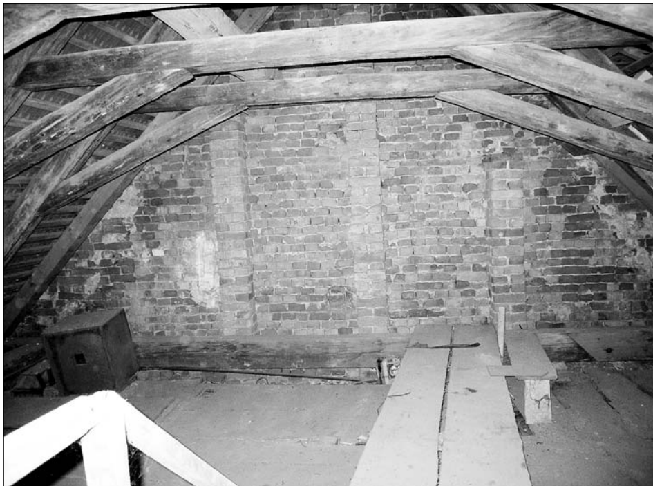
Obr. 29: Krchleby, kostel sv. Václava, pohled z podstřeší lodi na rub západního renesančního štítu.
