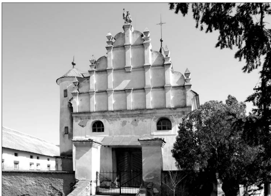
Obr. 18: Krchleby, pohled na kostel sv. Václava s renesančním štítem od západu, stav před opravou (foto 2009).
