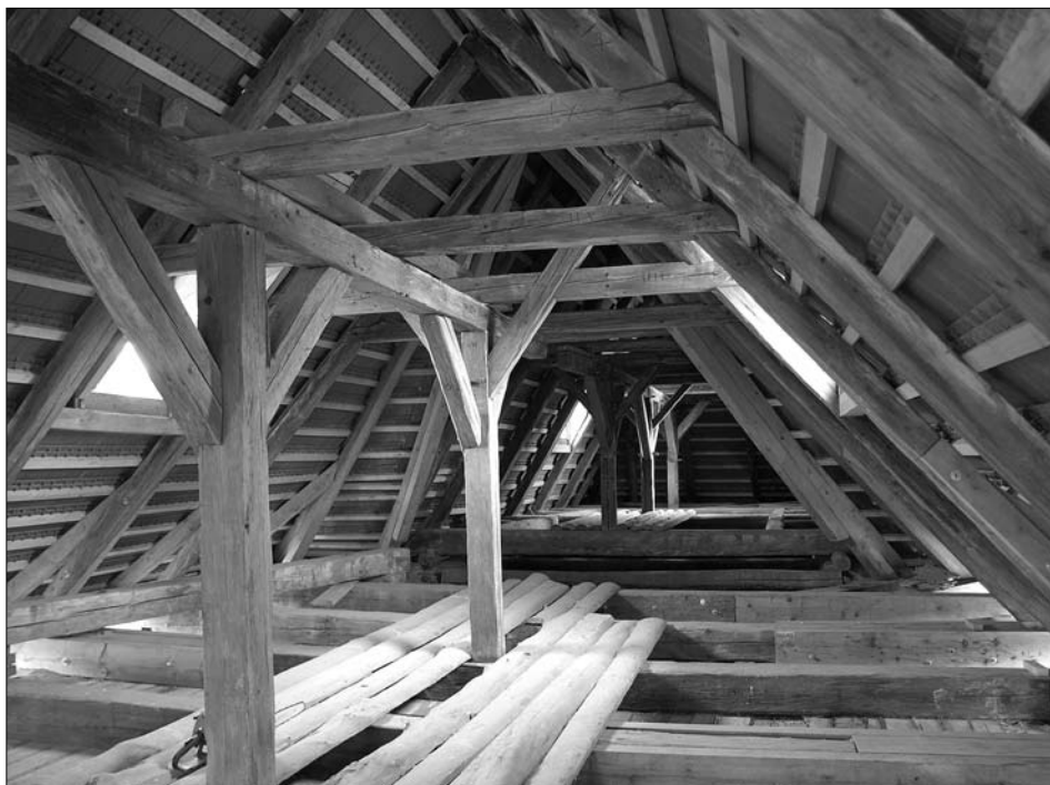
Obr. 6: Jindice, kostel sv. Václava, krovová konstrukce nad lodí a presbytářem, stav po opravě (léto 2009)
