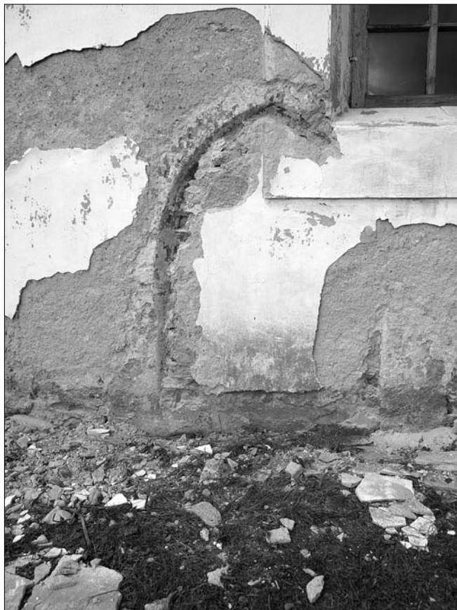
Obr. 22: Křehleby, kostel sv. Václava, odkrytý gotický portál na jižní straně lodi (podzim 2009).
