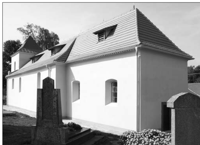
Obr. 14: Jindice, pohled na kostel sv. Václava od jihovýchodu, stav po opravě (léto 2009).
