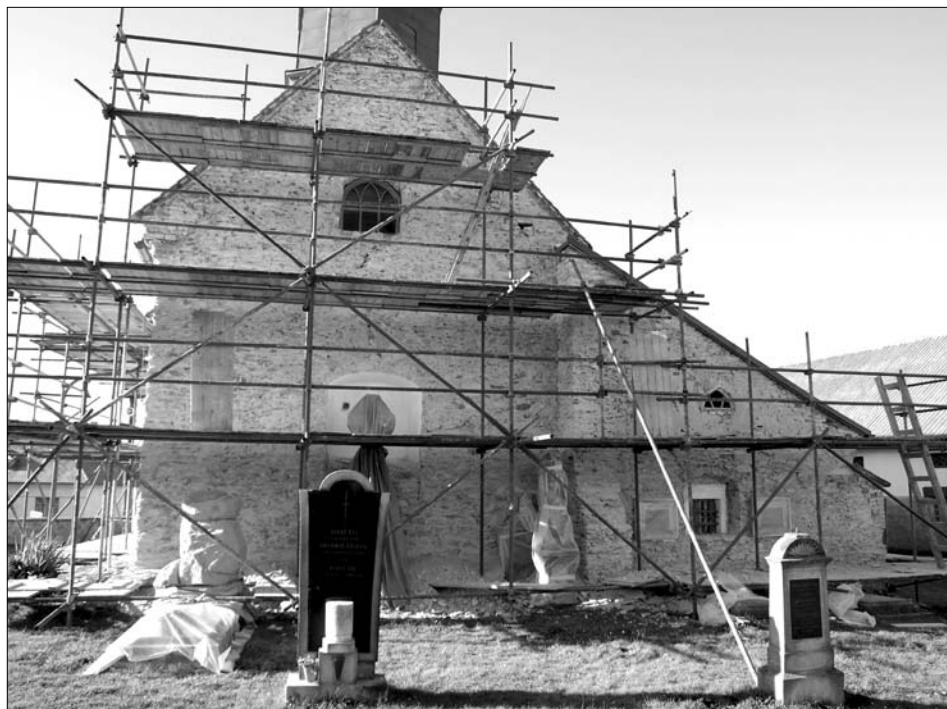
Obr. 26: Krchleby, pohled na kostel sv. Václava od východu, stav po sejmutí omítek během opravy (podzim 2009).
