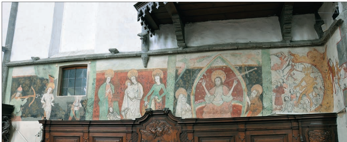
Obr. 10: Prachatice, kostel sv. Jakuba Většího, presbytář, jižní stěna, nově objevené malby, stav po restaurování (leden 2010).
