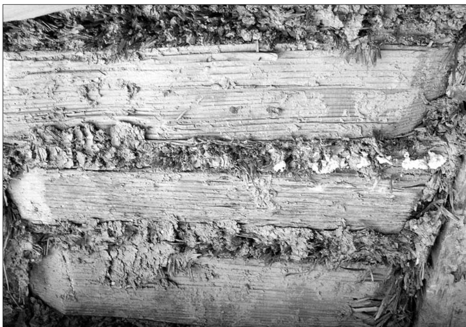
Obr. 20: Jihlava, dům čp. 1320. Přední plochostropá světnice v 1. patře. Konstrukce stropu v sondě do omítnutého podhledu. Detail hranolových příčli mezi stropními trámy.
