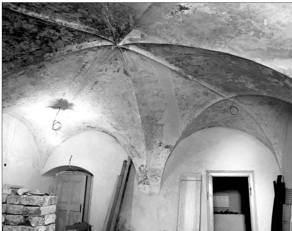
Obr. 18: Jihlava, dům čp. 1320. Zadní klenutá prostora v 1. patře. Stav po odstranění příčky.
