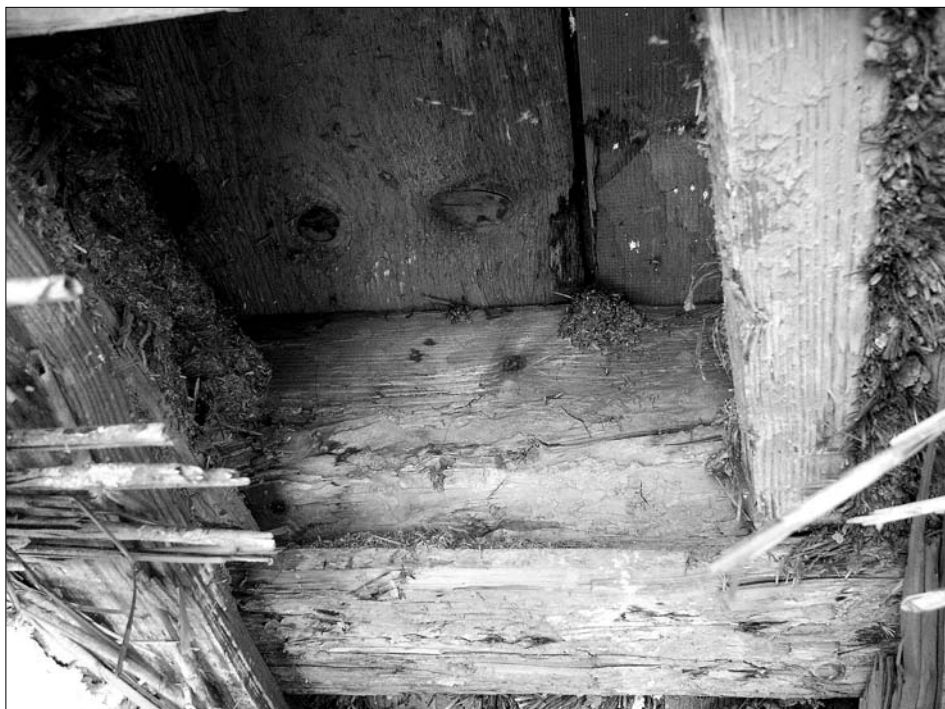
Obr. 19: Jihlava, dům čp. 1320. Přední plochostropá světnice v 1. patře. Konstrukce stropu odkrytá v sondě do omítnutého podhledu. Detail trojboké drážky na boční straně stropního trámu. Vlevo nahoře je patrná izolační vrstva z hrubých pilin a slaměné řezanky.
