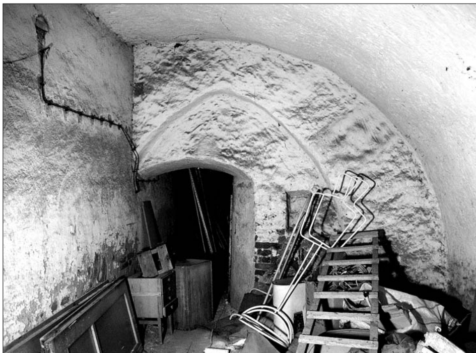
Obr. 15: Jihlava, dům čp. 1320. Zadní díl domu v přízemí. Pohled na zazděný hrotitý pas na straně náměstí. Stav před vybouráním příčky. V zazdivce pod pasem je odkládací výklenek.
