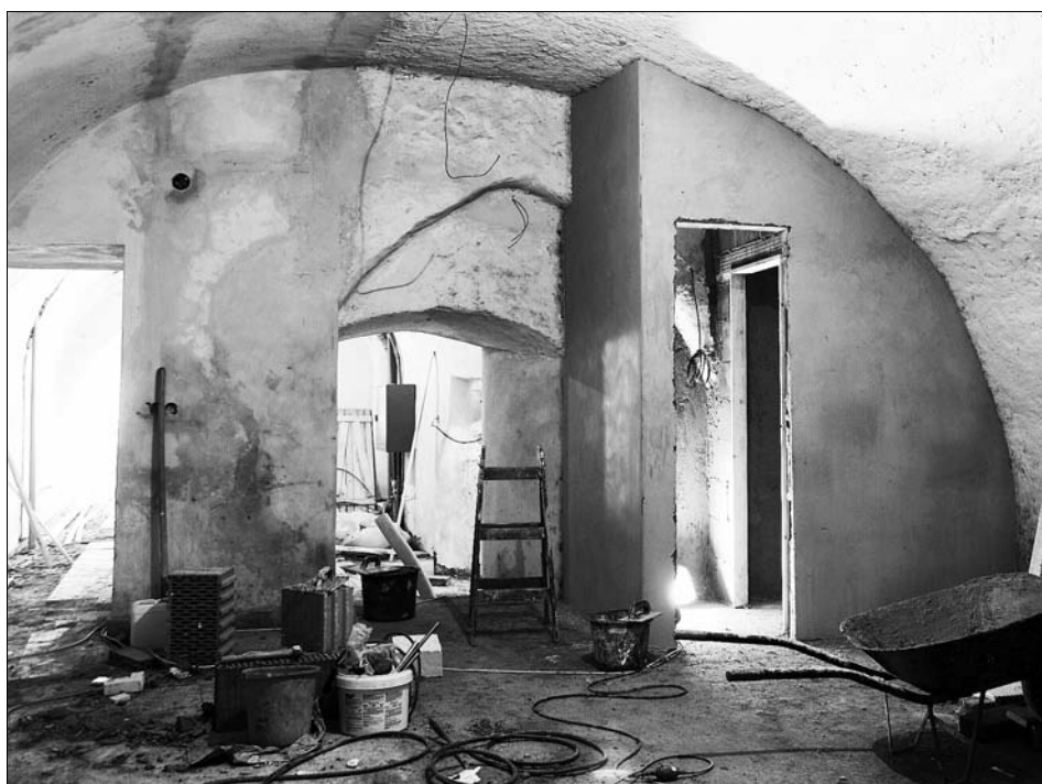
Obr. 14: Jihlava, dům čp. 1320. Zadní díl domu v přízemí. Pohled na zazděný hrotitý pas na straně náměstí. Stav po vybourání příčky.
