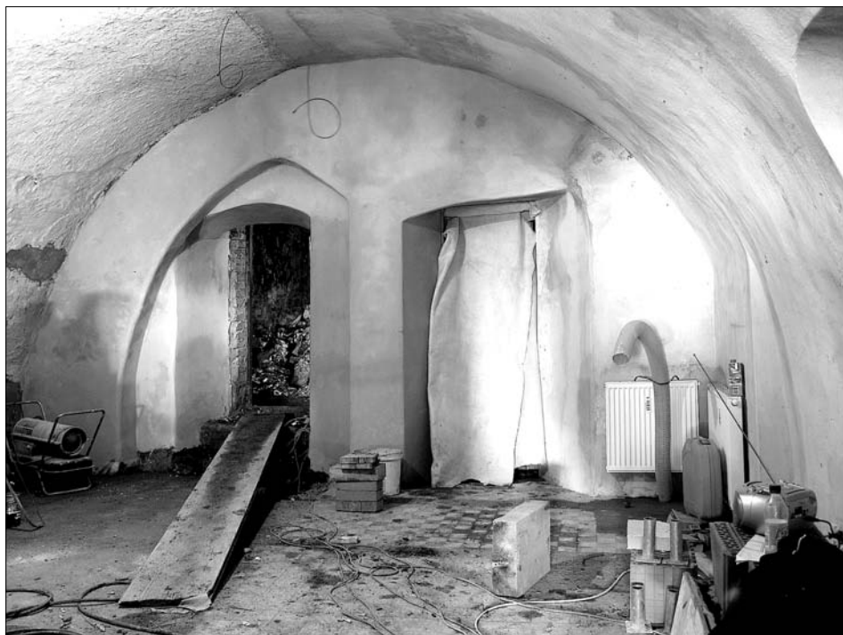
Obr. 16: Jihlava, dům čp. 1320. Zadní díl domu v přízemí. Pohled na zazděný hrotitý pas na straně dvora. Stav po vybourání příčky.
