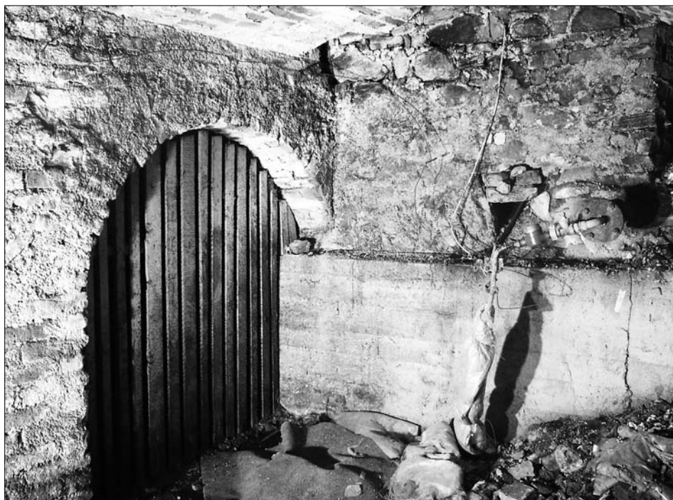
Obr. 12: Jihlava, dům čp. 1320. Přední sklep. Čelo předního sklepa na straně náměstí a přední část vestavěné arkády. Světlost arkády snad odpovídá předpokládané hloubce zrušeného loubí. Zdivo průčelí s výrazným podílem cihel se liší od viditelných částí kamenných podélných stěn a není ožehnuto ohněm.
