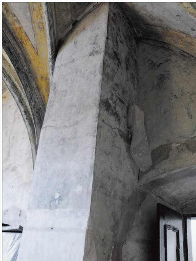
Obr. 3: Praha-Staré Město, kostel sv. Haštala, pohled na jižní stěnu sakristie s opěrným pilířem presbytáře, stav před odsekáním středověkých omítek (foto J. Dienstbier, 8. 10. 2009).
