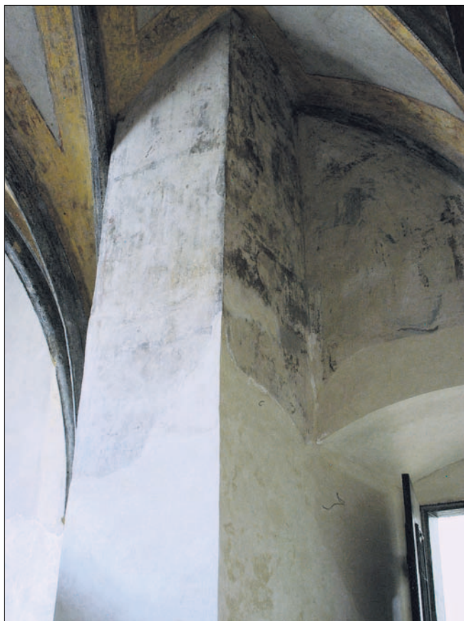
Obr. 4: Praha-Staré Město, kostel sv. Haštala, pohled na jižní stěnu sakristie s opěrným pilířem presbytáře, stav po odsekání středověkých omítek (foto P. Skalický, 13. 5. 2010).
