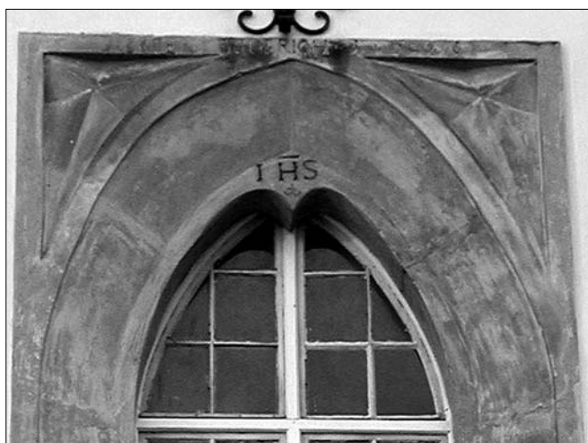
Obr. 26: Chřibská, kostel sv. Jiří, okno v jižním průčelí schodišťového rizalitu – detail. Na horní liště jméno Merten Friderich a letopočet 1596, pod ním zkratka IHS a kamenická značka.
