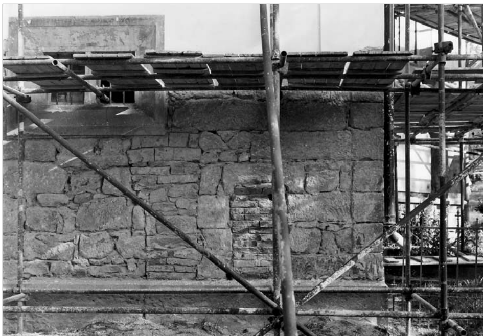
Obr. 14: Chřibská, kostel sv. Jiří, spodní úroveň zdiva východní části jižního průčelí. Pískovcové kvádry nárožní armatury kamenicky upravené pro dotažení omítky, zčásti druhotně přitesané v souvislosti s úpravami fasády na přelomu 19. a 20. století (NPÚ ÚOP v Ústí nad Labem, fotoarchiv, č. neg. 134959), foto K. Neumannová, 1999).
