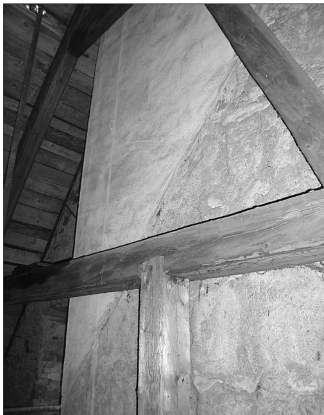
Obr. 28: Chřibská, kostel sv. Jiří, prostor krovu nad lodí – otisk staršího krovu na východní zdi věže. Na původně exteriérové bílé omítce světle žluté iluzivní nárožní kvádrování (úprava z let 1650–1670).
