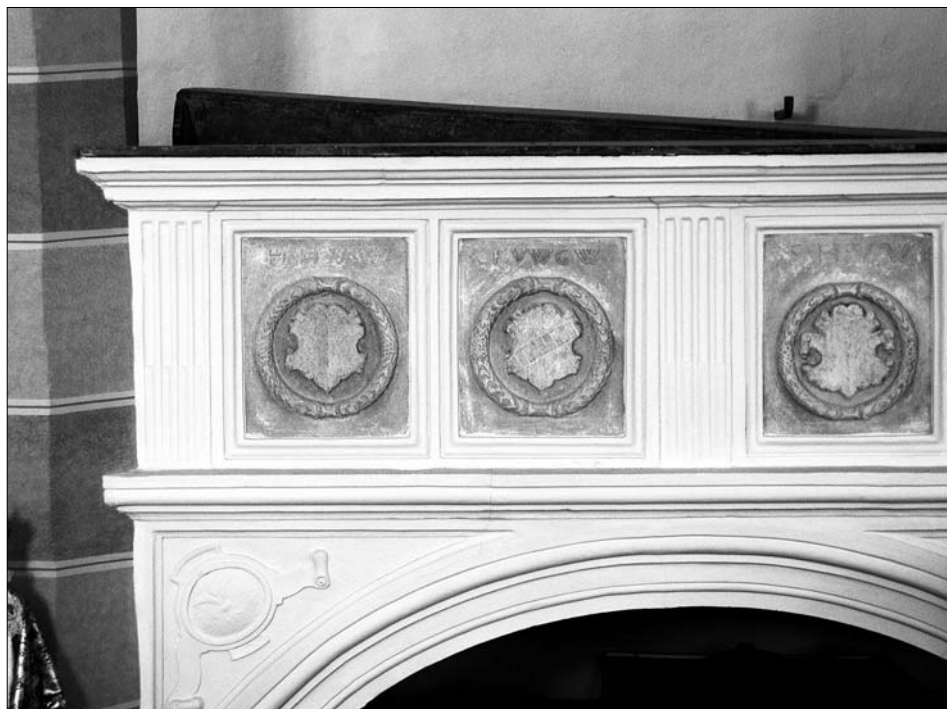
Obr. 24: Chřibská, kostel sv. Jiří, interiér, severní empora, první pole od východu, detail kamenické výzdoby parapetu.
