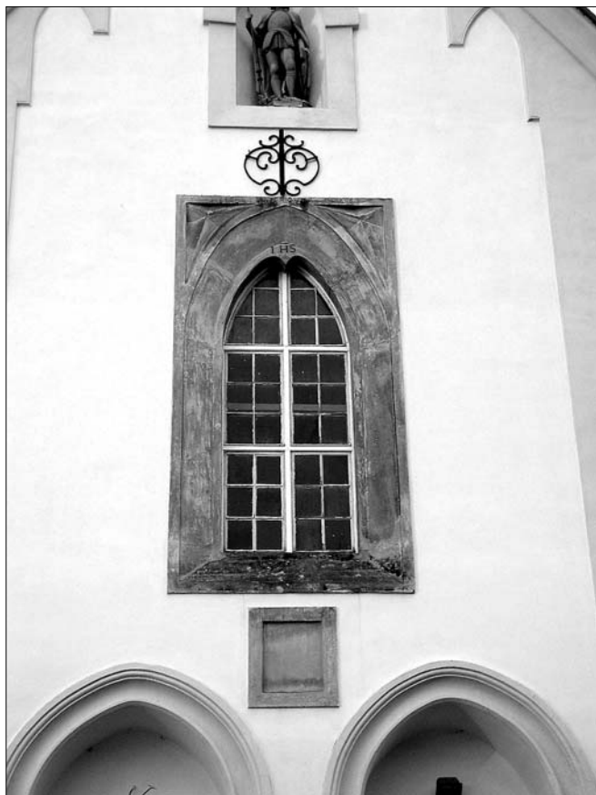
Obr. 25: Chřibská, kostel sv. Jiří, okno v jižním průčelí schodišťového rizalitu.
