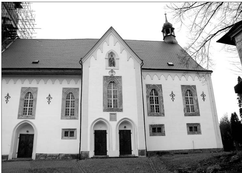
Obr. 5: Chříbská, kostel sv. Jiří, jižní průčelí.
