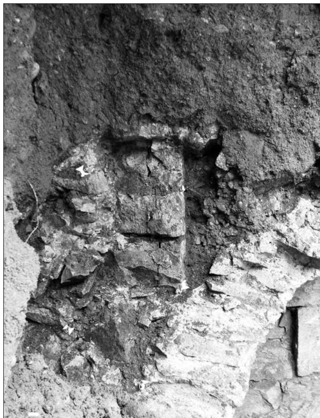
Obr. 10: Praha 1 – Staré Město, Staroměstské náměstí. Negativ stojky odkládací niky nad rubem vložené klenby v jižní stěně schodišťové šje (foto J. Havrda).
