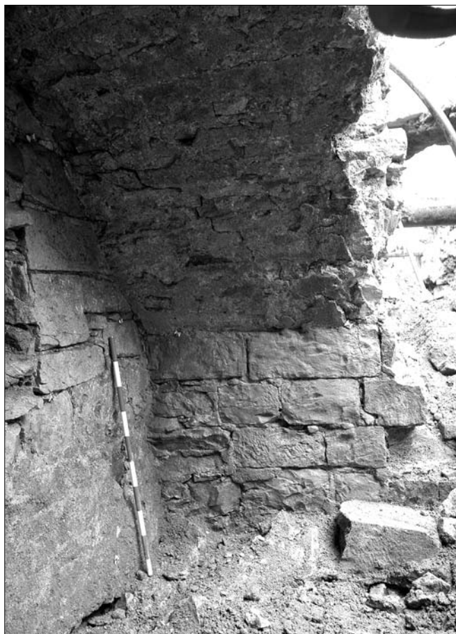
Obr. 12: Praha 1 – Staré Město, Staroměstské náměstí. Severní stěna schodišťové šje. V koutě místnosti, vlevo dole se rýsují obrisy dvou schodišťových stupňů. Do kvádříkového zdiva byla dodatečně vložena klenba z lomové opuky (nahore) (foto J. Hlavatý).
