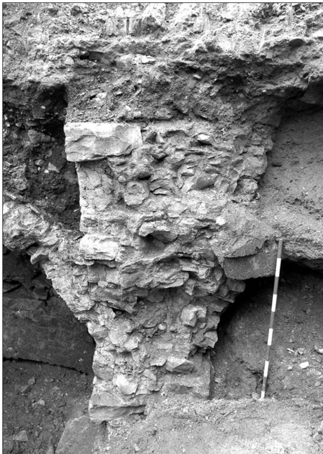
Obr. 14: Praha 1 – Staré Město, Staroměstské náměstí. Čelní pohled na řez severní zdi schodišťové šíje. Vložená gotická klenba vlevo je založena do hluboce vysekaných kapes, upravo je méně čitelný jednoduší přechod jádra románského zdiva do zaklenutí severní místnosti. Ústupek paty klenby vůči lici zdiva je 6 cm (foto J. Hlavatý).
