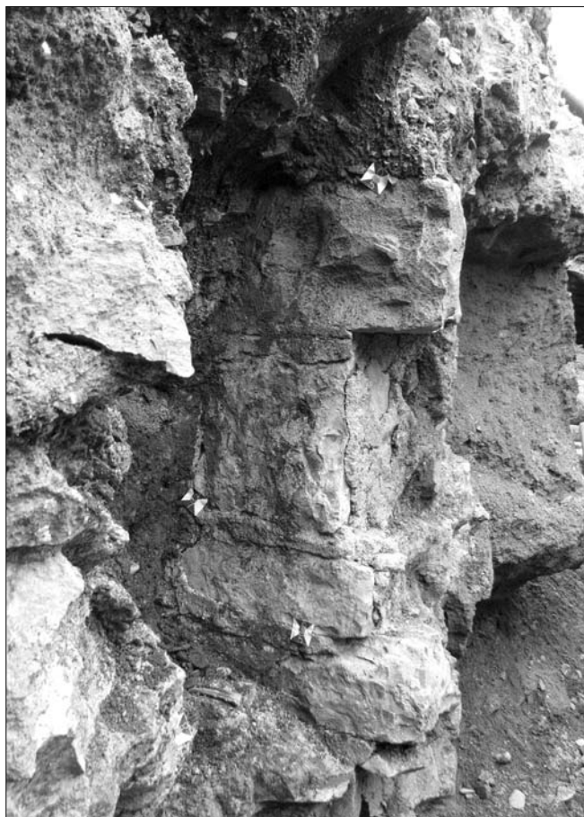
Obr. 13: Praha 1 – Staré Město, Staroměstské náměstí. Zakonzervovaná horní část lince severní zdi schodišťové šje nad rubem dodatečně vložené klenby. Původní úprava spár se zde zachovala ve velmi dobrém stavu (foto J. Havrdy).
