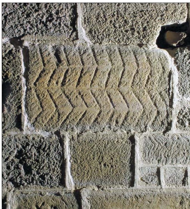
31: Svojšín, kostel sv. Petra a Pavla. Vystouplé spárování překrývá původní románskou úpravu se spárami podřezávanými. Úprava líce kvádrů místy imituje opus spicatum (foto M. Falta).
