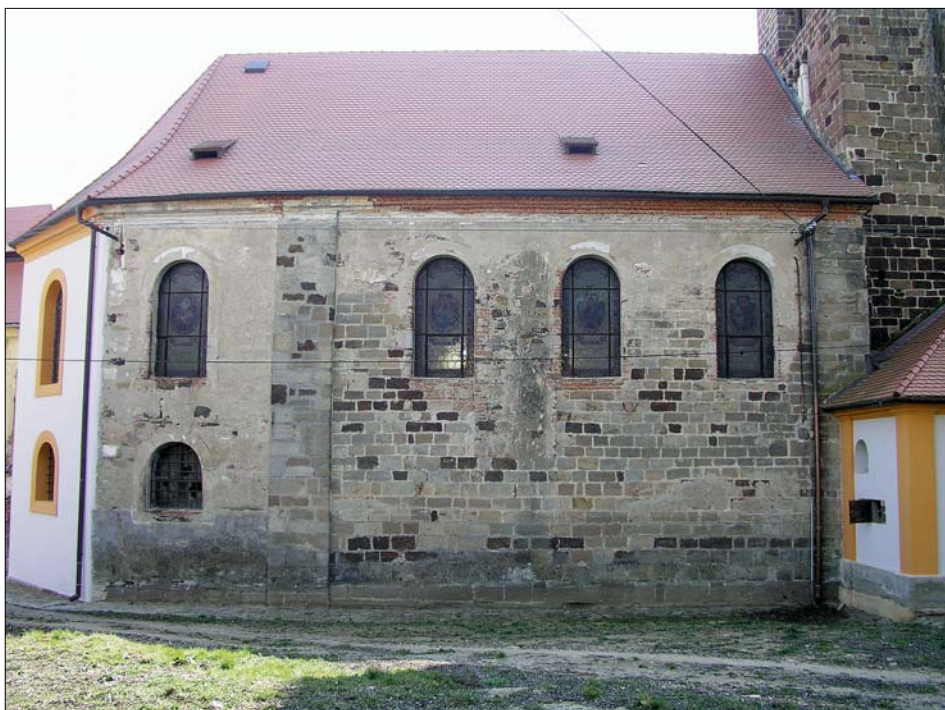
Obr. 33: Svojšín, kostel sv. Petra a Pavla. Severní stěna kostela před omítnutím (foto M. Hauserová).
