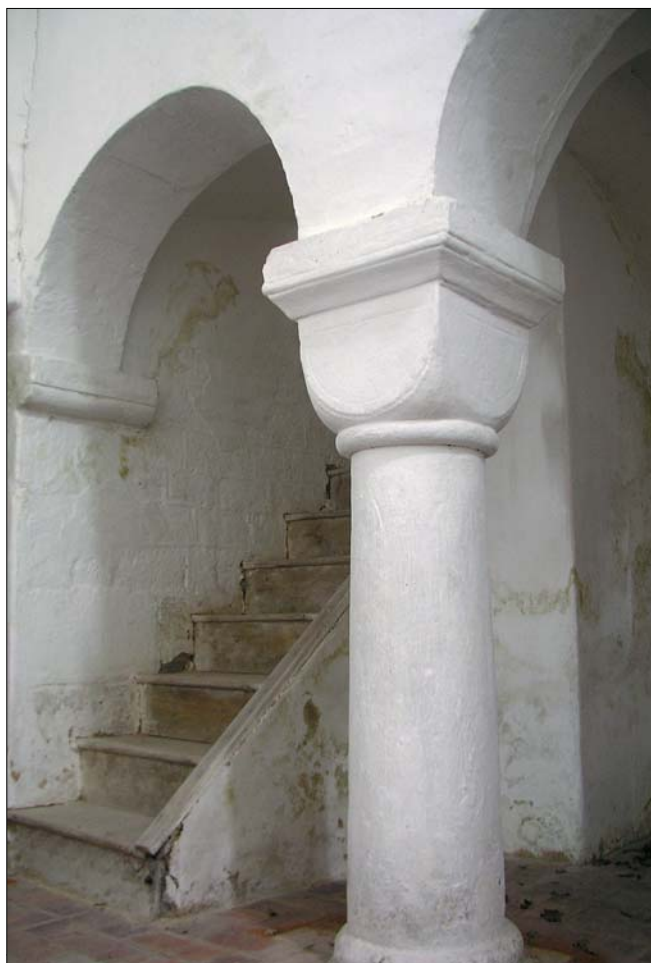
Obr. 26: Všeruby, kostel sv. Ducha. Detail schodiště na tribunu (foto M. Hauserová).
