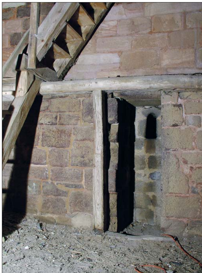
Obr. 19: Svojšíň, kostel sv. Petra a Pavla. Vyústění schodiště do prostoru věže nad klenbou tribuny. Na úrovni stropu podesty dřevěného schodiště, kde končí tmavý arkózový pás, byla stavba přerušena. Obvodové zdivo následné stavební etapy je užší (foto M. Falta).
