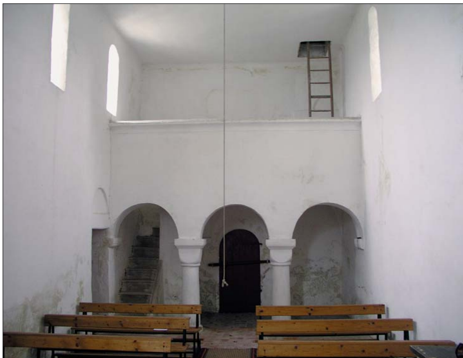
Obr. 25: Všeruby (okres Plzeň-sever), kostel sv. Ducha, pohled na tribunu. Obvodové zdivo kostela, k němuž schodiště levou stranou svého pravoúhelního zalomeného ramene přiléhá, vykazuje známky neporušeného kvádrového líc s původním spárováním. Stopy po průrazu klenbou, která byla dosud předpokládána, nejsou patrné. Schodiště pravděpodobně využívá místo starší vertikální komunikace (foto M. Hauserová).
