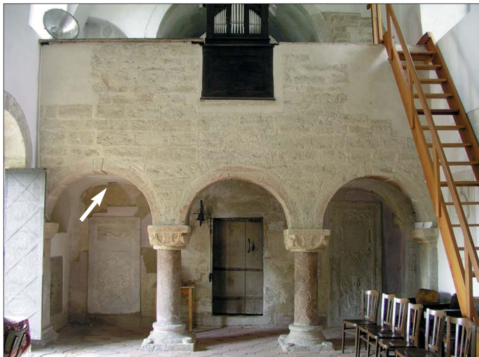
Obr. 27: Jakub (okres Kutná Hora), kostel sv. Jakuba, pohled na tribunu. Levé pole arkády na rozdíl od středního a pravého nebylo zaklenuto. Drobná dosud prezentovaná sonda na západní stěně nad náhrobkem (viz šipka) ukazuje středověkou interiérovou omítku s nátěry, k níž je renesanční cihlová klenba přizděna (foto M. Hauserová).
