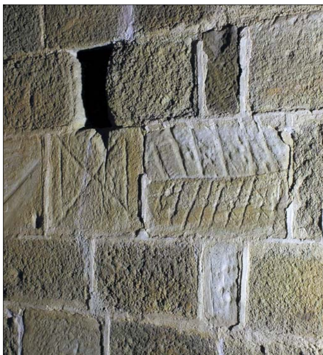
31: Svojšín, kostel sv. Petra a Pavla. Vystouplé spárování překrývá původní románskou úpravu se spárami podřezávanými. Úprava líce kvádrů místy imituje opus spicatum (foto M. Falta).
