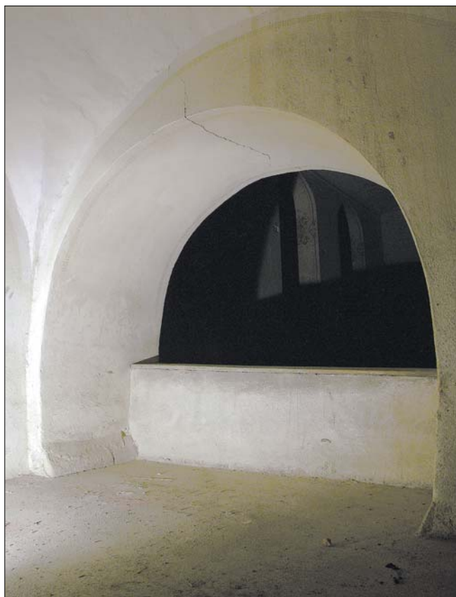
Obr. 11: Svojšíň, kostel sv. Petra a Pavla, otvor propojující prostor prvního patra věže s lodí. Při jeho patě kamenný tesaný trnož, překrytý zčásti mladším parapetem (foto M. Falta).
