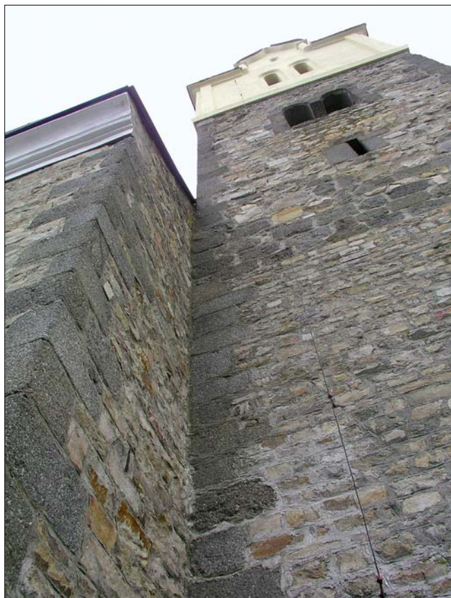
Obr. 6: Obděnice (okres Příbram), kostel Nanebevzetí Panny Marie, analogie styku věže a lodi ve variantě, kdy obě stavební jednotky mají vůči sobě vlastní plnou zeď (foto M. Hauserová).
