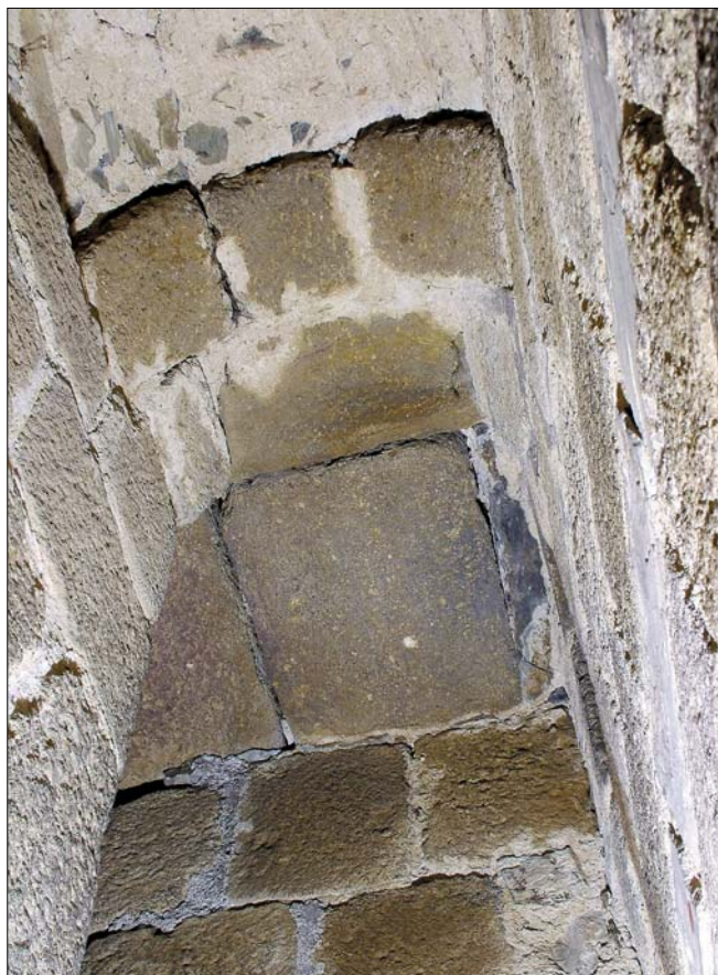
Obr. 20: Svojšíň, kostel sv. Petra a Pavla, zastropení prostoru horní podesty schodiště kamennými deskami jednostranně vetknutými do její boční stěny (foto M. Falta).
