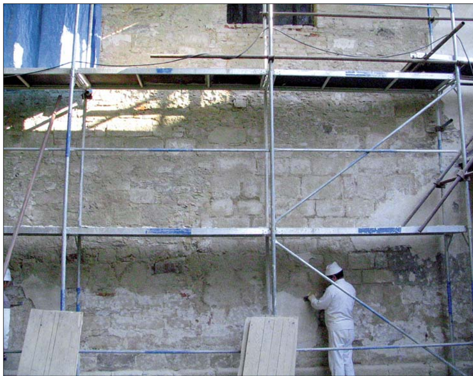
Obr. 35: Svojšín, kostel sv. Petra a Pavla. Jižní stěna lodi s druhotně užitými románskými kvádry. V levé části obrázku zazdivka zrušeného jižního portálu (foto M. Čechura).
