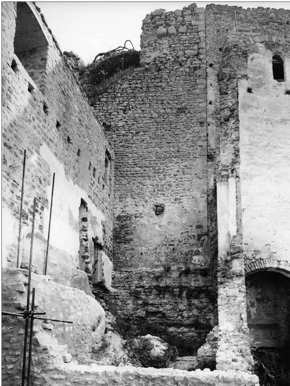
Obr. 25: Landštejn. Severní věž v pohledu od západu. Dole je dobře patrná obnažená, druhotně podezdívaná základová část, upravo nárožní armatura z kvádrů, k níž nádvoří zeď paláce přiléhá „na spáru“, nahoře částečně zřícené obvodové zdivo patra nad kaplí, s obloukem druhotné klenby. Stav před rekonstrukcí, duben 1981, jako obr. 16.
