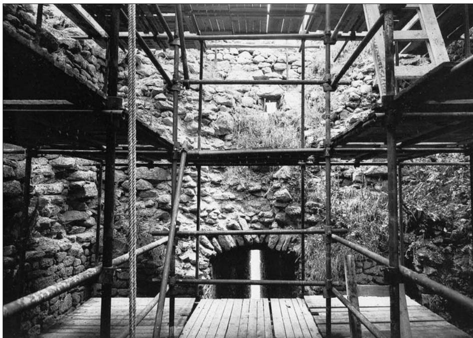
Obr. 19: Landštejn. Jižní věž, interiéru horní části v pohledu k východu. Dole horní část střelného otvoru 4. patra, nahoře podobný otvor 5. patra. Stav před rekonstrukcí, duben 1981, jako obr. 16.
