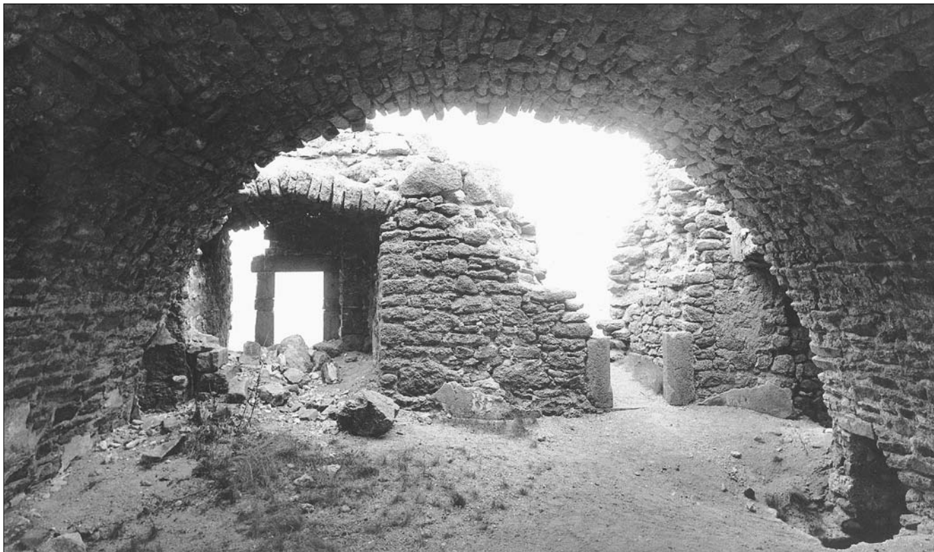
Obr. 34: Landštejn. Druhé patro severní věže, celkový pohled k východu (klenba je druhotná). V pozadí vlevo druhotně upravované okno, vpravo spodní část vchodu na točité schodiště (patrně druhotné). V popředí vpravo horní ústí schodiště v síle zdi. Stav před rekonstrukcí, duben 1981, jako obr. 16.
