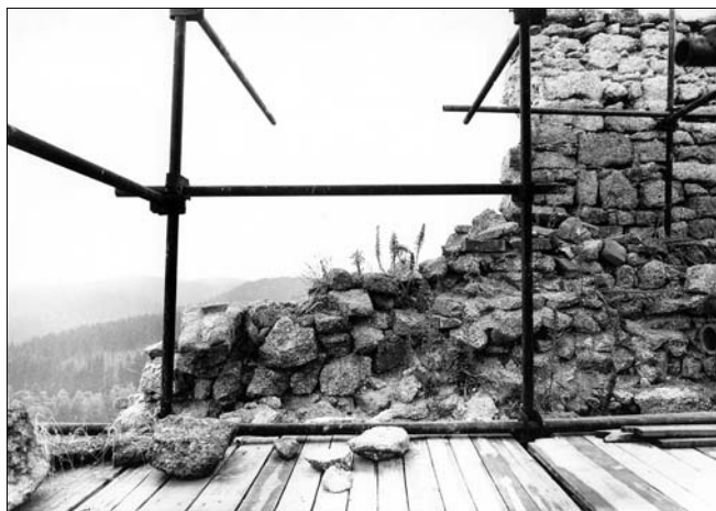
Obr. 23: Landštejn. Jižní věž, relikty obvodové zdi horního patra. Pohled k severu, vlevo zřícená část při severozápadním rohu interiéru věže, upravo líčovaná zeď se stopami (svislá hrana špalety) původního, později zadržaného otvoru. Stav před rekonstrukcí, duben 1981, jako obr. 16.
