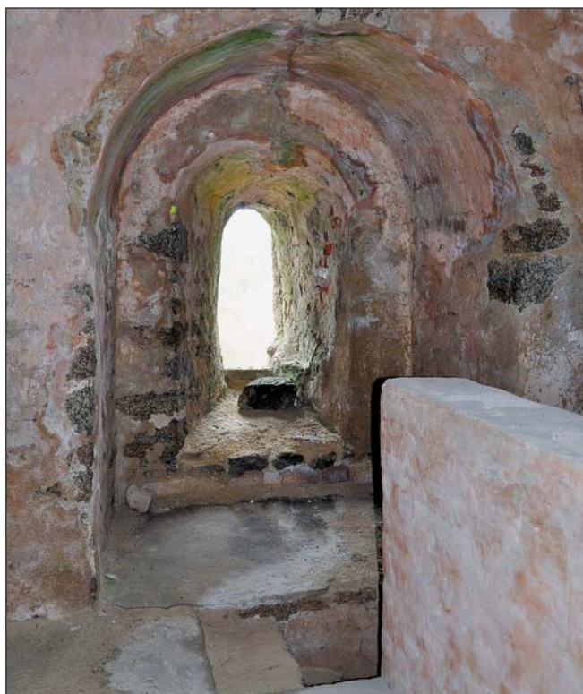
Obr. 32: Landštejn. Pohled z tribuny kaple k původnímu (částečně druhotně upravenému) okénku v severní zdi. Okénko osvětlovalo zároveň tribunu i loď kaple (foto autor, 2011).
