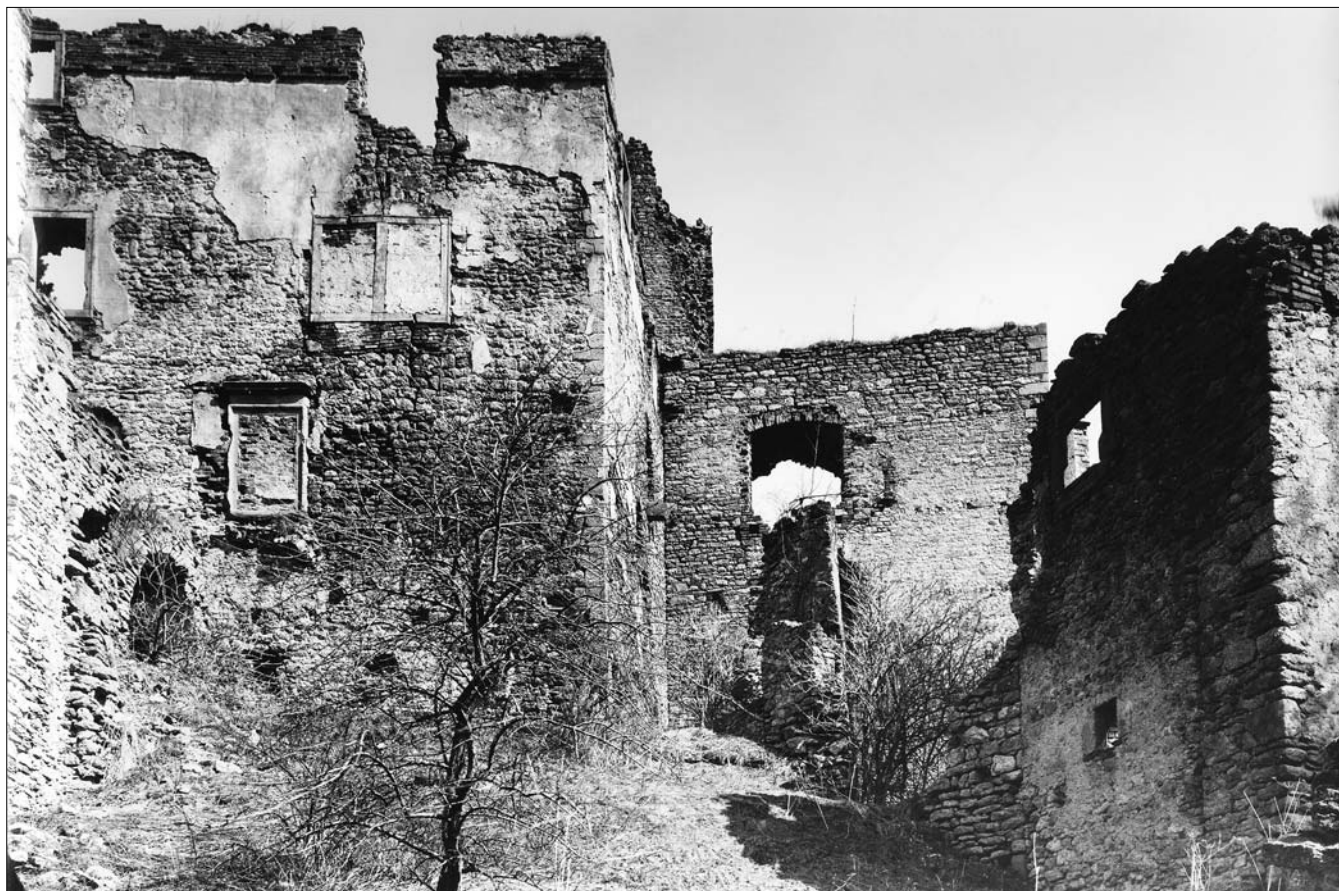
Obr. 48: Landštejn. Dílčí pohled na jižní část západního (v půdorysu se lomického) průčelí jádra hradu. Pod opadanou omítkou v horních partiích se patrně rýsují stopy zazděného cimbuří (vlevo jižní stěna předbraní třetí brány, uprostřed v pozadí tzv. donjon). Stav před rekonstrukcí, duben 1981, jako obr. 16.
