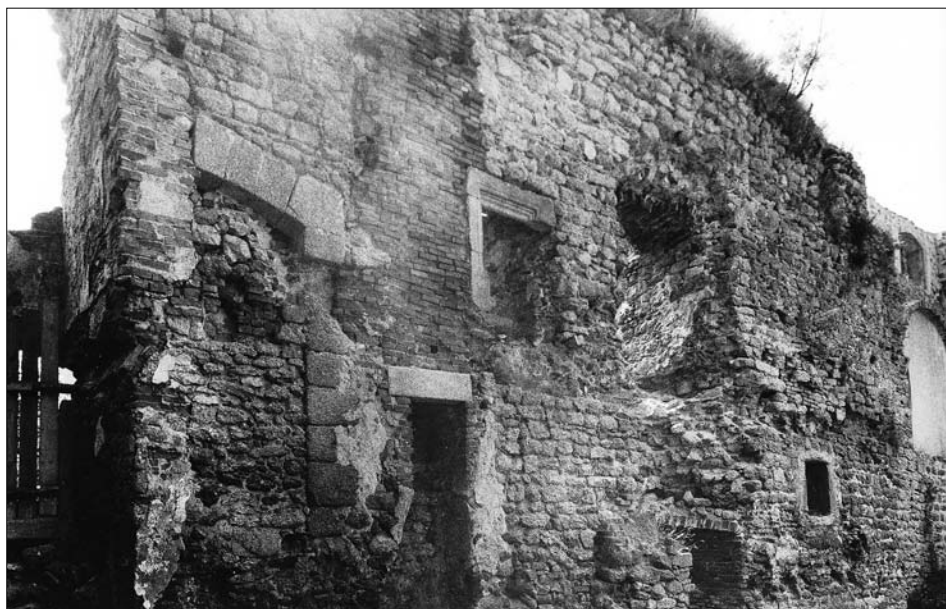
Obr. 45: Landštejn. Vnitřní strana jižní obvodové zdi hradu, část v západním sousedství velké, jižní věže. Vlevo v popředí pravá svislá hrana a část záklenku (obojí z tesaných kvádrů) původní brány hradu. Stav před rekonstrukcí, duben 1981, jako obr. 16.
