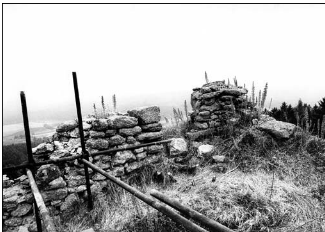
Obr. 22: Landštejn. Jižní věž, relikty obvodové zdi horního patra, pohled k jihovýchodnímu rohu. Uprostřed dolní část vstupu do arkýřového převertu. Stav před rekonstrukcí, duben 1981, jako obr. 16.
