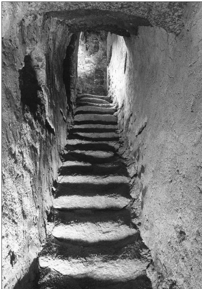
Obr. 33: Landštejn. Schodiště v síle zdi spojující průchod na tribunu kaple s druhým patrem severní věže. Průhled směrem vzhůru, druhotné úpravy. Stav před rekonstrukcí, duben 1981, jako obr. 16.
