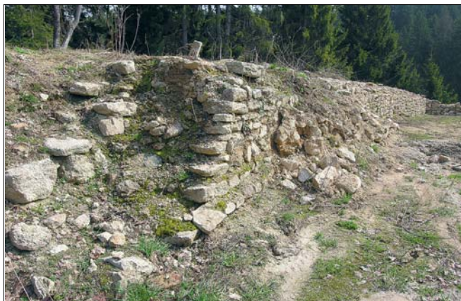
Obr. 9: Pomezí. Vnitřní strana mohutné kamenné hradby opevnění severně od kostela sv. Jana Křtitele (foto autor, 2006).
