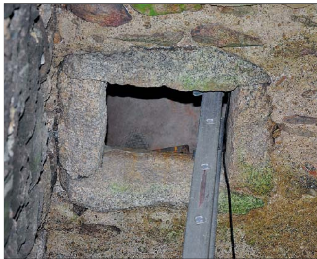
Obr. 29: Landštejn. Spodní podlaží severní věže, detail původního otvoru v klenbě (srov. obr. 28; foto autor, 2011).
