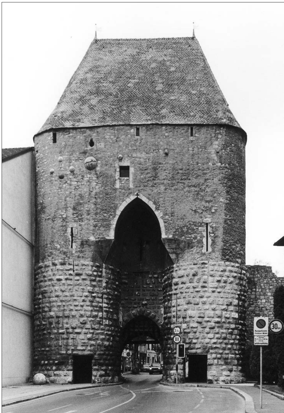
Obr. 52: Hainburg (Dolní Rakousko). Vídeňská brána, vnější průčelí. Opevnění Hainburku, mohutné babenberské pevnosti při uherské hranici, je vrcholnou ukázkou vysoké úrovně fortifikačního stavitelství doby vévody Leopolda VI. Spodní část Vídeňské brány, s lici zdíva z bosovaných kvádrů, naznačuje svou dispozicí se dvěma postranními věžemi souvislost s antickou tradicí a mediteránním (zároveň jihoevropským štaufským a francouzským) prostředím. Původní zakončení koruny zdíva této stavební fáze se nedochovalo. Horní omítnutá část pochází z pozdní doby vlády českého krále Přemysla Otakara II. Nad vrcholnicí lomeného oblouku probíhal ochoz vyložený na dřevěných nosnících, přístupný dochovaným obdélným portálkem na průčelí (foto autor, 1998).
