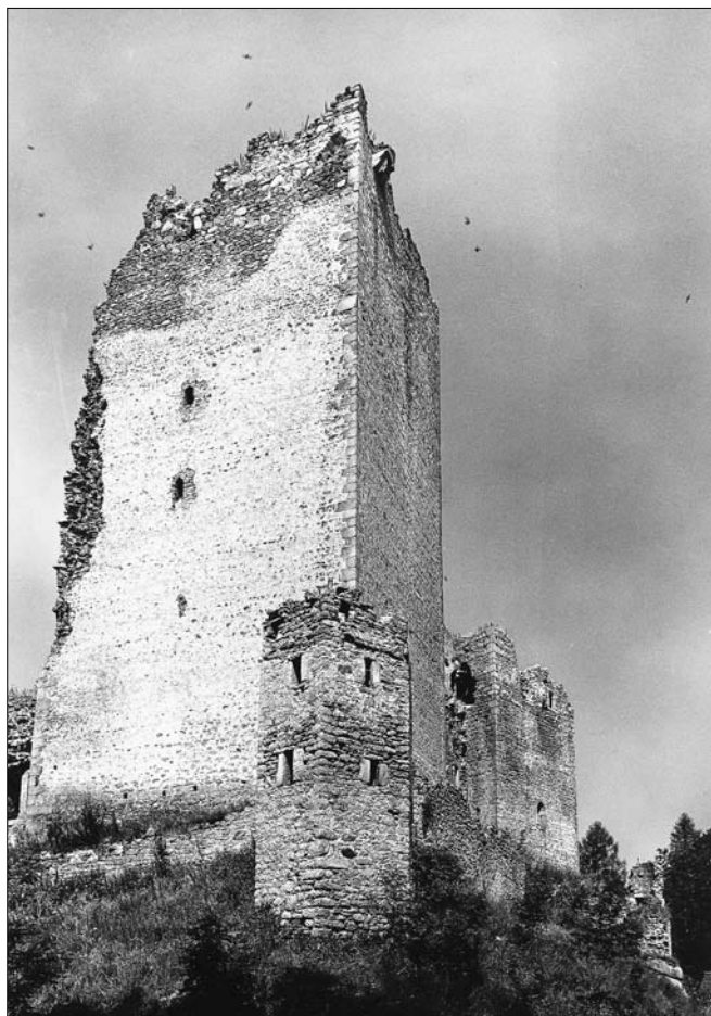
Obr. 17: Landštejn. Jižní (velká) věž od jihovýchodu. Ve 2. a 3. patře jižního průčelí dodatečně střilny pro palné zbraně, nahoře zbytky původních střeleckých otvorů a arkýřového prevetu. V popředí pozdně gotická bašta. Stav před rekonstrukcí, duben 1981, jako obr. 16.
