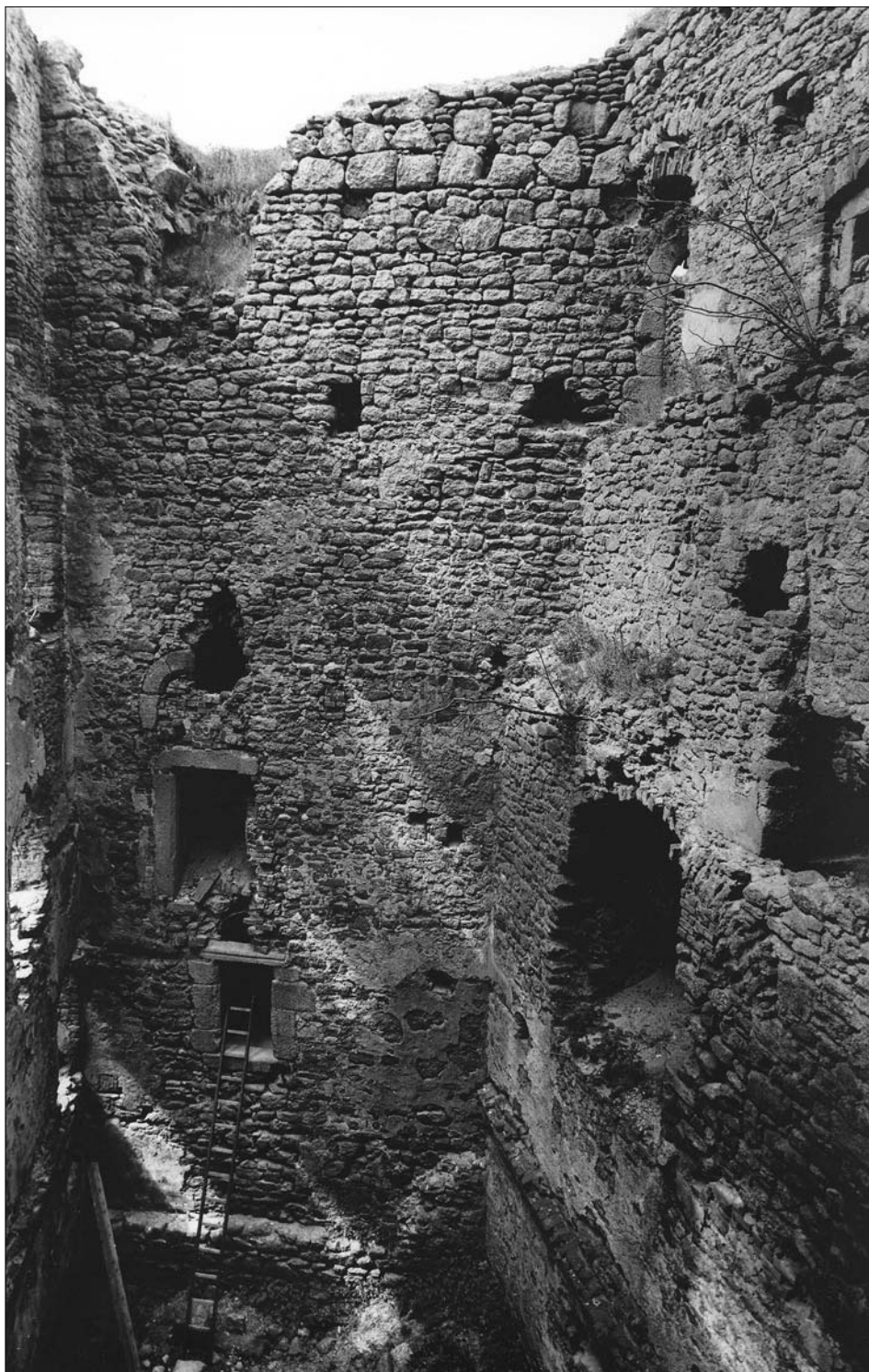
Obr. 26: Landštejn. Severní věž v pohledu od jihu, z interiéru paláce. Dole předstupující základová část. Žebřík je přistaven k původnímu vstupu do kaple, z něhož se dochovaly obě stojky, rovné nadpraží je však pozdější. O podlaží výš vstup na emporu kaple, avšak z původního, románského vstupu se dochovala jen část půlkruhového záklenku o něco výš. Zcela nahoře vlevo zbytky dalšího vstupního otvoru, který patrně spojoval patro nad kaplí s podstřeším paláce. Vpravo nahoře je vidět část původního portálku vstupu na vnější ochoz paláce. Stav před rekonstrukcí, duben 1981, jako obr. 16.
