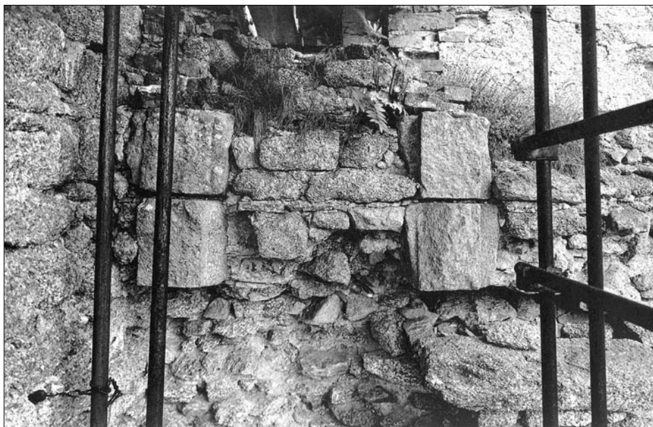
Obr. 40: Landštejn. Detail dvou odsekáných krakorců zaniklého ochozu paláce, těsně při severním průčelí jižní věže. Stav před rekonstrukcí, duben 1981, jako obr. 16.
