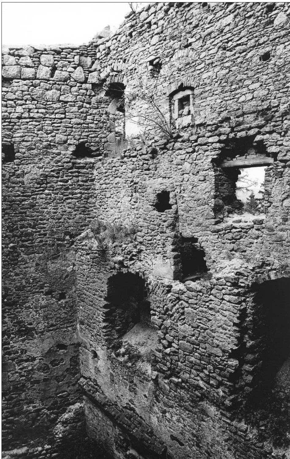
Obr. 41: Landštejn. Vnitřní strana východní obvodové zdi mezilehlého paláce, pohled k severovýchodu (vlevo průčelí severní věže, srov. obr. 26). Stav před rekonstrukcí, duben 1981, jako obr. 16.
