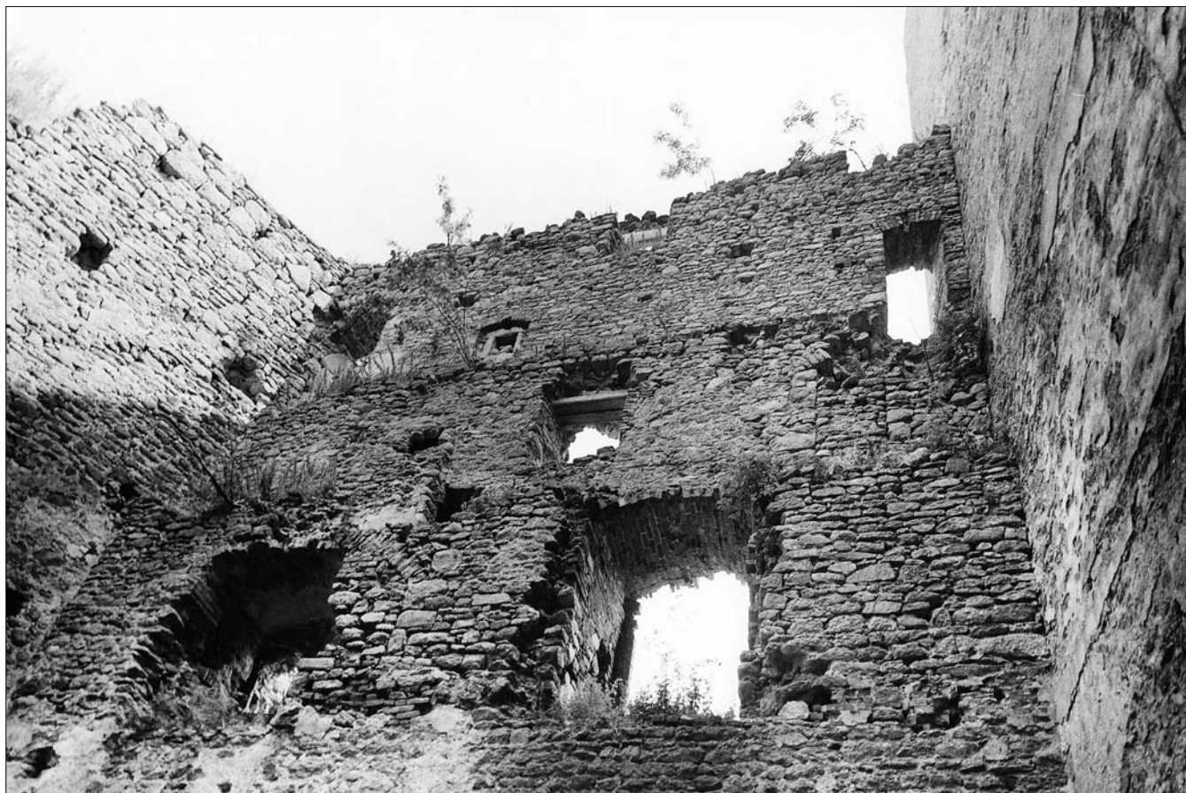
Obr. 42: Landštejn. Vnitřní strana východní obvodové zdi mezilehlého paláce, pohled z přízemí. Ve 2. patře vpravo patrně původní (druhotně zazděný) vstup do převetu (srov. též obr. 41). Stav před rekonstrukcí, duben 1981, jako obr. 16.
