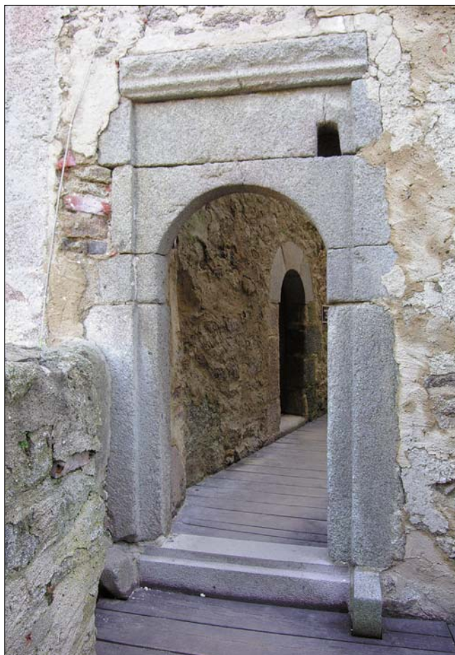
Obr. 44: Landštejn. Pozdně gotický vstup do 1. patra mezilehlého paláce od západu (práh a pravá točnice pro padací můstek jsou novodobými kopiemi), v pozadí vchod do kaple. Foto autor, 2010.
