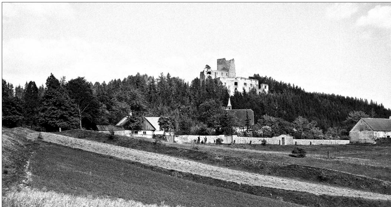
Obr. 6: Pomezí. Pohled na severní část někdejšího městečka od severozápadu. V popředí, za světlým pruhem pozemku, je dobře patrný bývalý příkop (dnes částečně využitý jako úvozová cesta) a nad ním val patrně středověkého opevnění. V pozadí areál kostela sv. Jana Křtitele a hrad, oddělený hlubokým údolím. Zcela vlevo násep silnice z Landštejna na Novou Bystřici (foto H. Zatloukal, asi 30. léta 20. století, archiv NPÚ ÚP).
