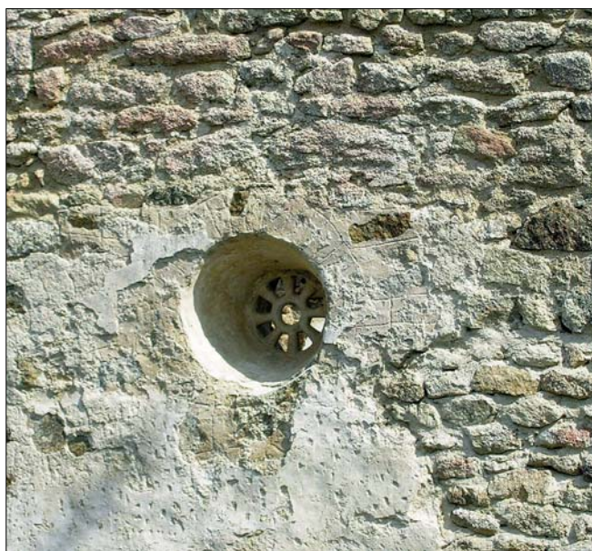
Obr. 11: Pomezí. Kostel sv. Jana Křtitele, současný stav, detail jednoho z dvou původních kruhových okének západního průčelí. V okolí okénka zbytky původní povrchové úpravy zdiva, se zřejmě provedenými kvádry vyřezanými v omítce (foto autor, 2006).
