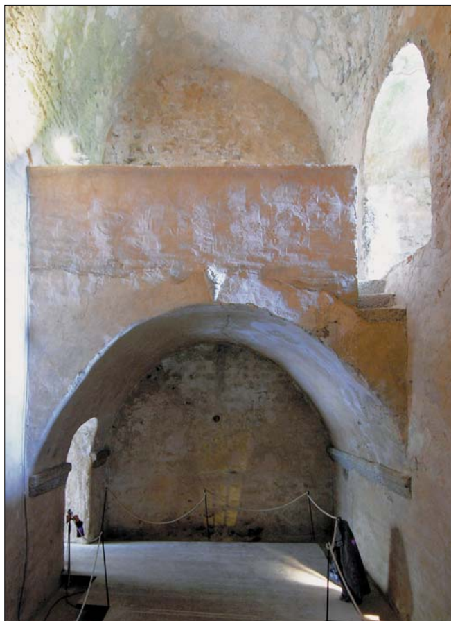
Obr. 31: Landštejn. Kaple v severní věži, pohled k západu. Klenba tribuny, nad vrcholnicí relikv konzoly emporového oltáře. Parapetní zídka tribuny novodobá. V pozadí pod tribunou otvor v podlaže do temného sklepa, vlevo původní vchod, přerušující pateční římsu klenby tribuny (foto V. Tůt, 2011).
