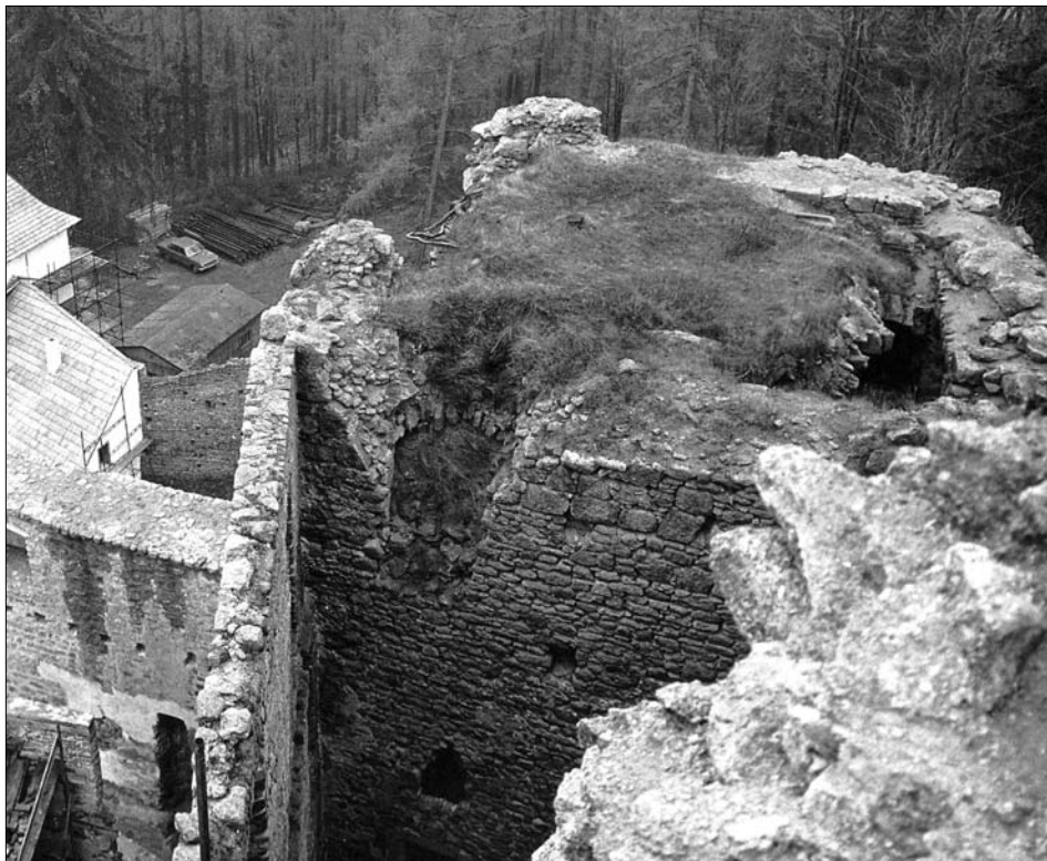
Obr. 27: Landštejn. Pohled na korunu severní věže od jihu. V jižní zdi vstup vedoucí patrně do podstřeší paláce, se zbytkem záklenku. Stav před rekonstrukcí, duben 1981, jako obr. 16.
