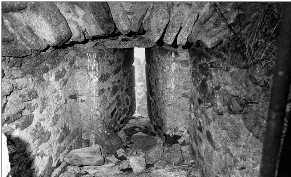
Obr. 20: Landštejn. Jižní věž, interiéru 4. patra, pohled do východního střílnového otvoru. Stav před rekonstrukcí, duben 1981, jako obr. 16.
