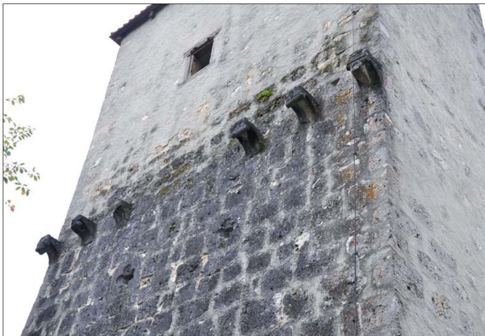
Obr. 50: Kastl (Horní Falc, Německo). Pozdně románská brána benediktinského kláštera, vnější průčelí. Vodorovná řada výrazně předstupujících krakorců v úrovni původní koruny zdíva může evokovat uplatnění ochozu typu machicoulis , skutečnou funkčnost však musíme zvažovat s nejvyšší skepti (foto autor, 2009).
