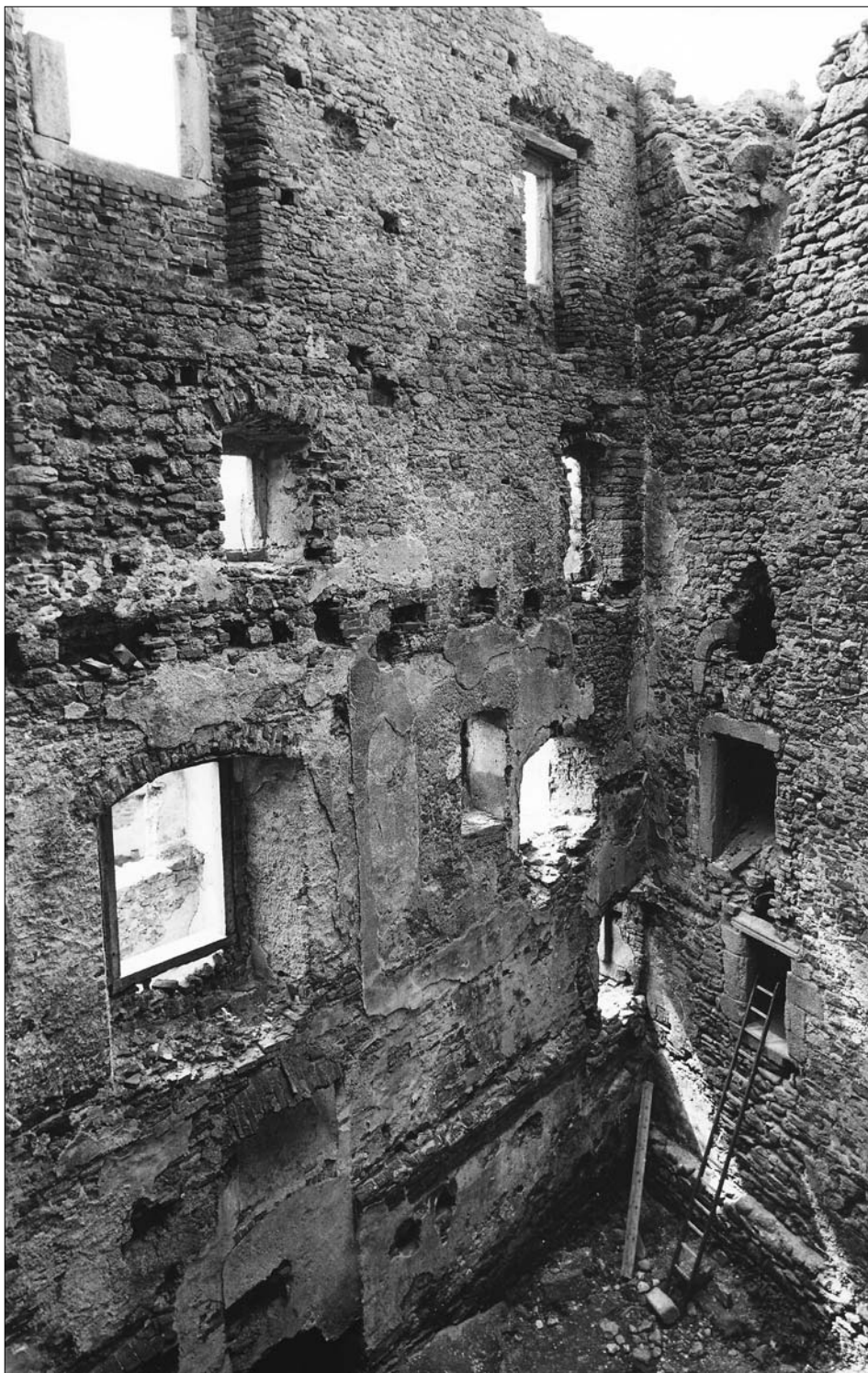
Obr. 43: Landštejn. Vnitřní strana nádvoří zdi mezilehlého paláce, pohled od jihovýchodu (srov. obr. 26). Stav před rekonstrukcí, duben 1981, jako obr. 16.
