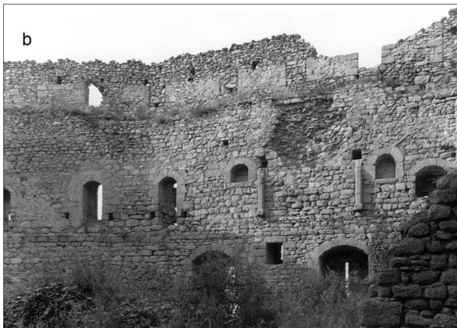
Obr. 51: Ortenbourg (Alsasko, Francie). Ukázka vnější obvodové zdi paláce (60. léta 13. století), před jehož střechou podobně jako na Landštejně probíhal ochoz, zvenku chráněný předprsní zidkou s cimbuřím (cimbuřím bylo později zrušeno a nadezděno). Na rozdíl od Landštejna zde však nebyl stálý, na kamenných krakorcích přesazený ochoz, srovnatelný s ochozy typu machicoulis, ale pouze příležitostný ochoz typu hourds na dřevěných nosnících. Nosníky byly po vysunutí z připravených otvorů podpírány drobnými kamennými konzolami (a – pohled zvenku, b – stejný pohled zevnitř paláce; v přízemí paláce šterbinové střílny v níkách pro lukostřelce, v patře zbytky velkého krbu, odkládací výklenky, vstupy do arkýřových prevetů, nahoře dobře patrné zuby cimbuřů) (foto autor, 2000).
