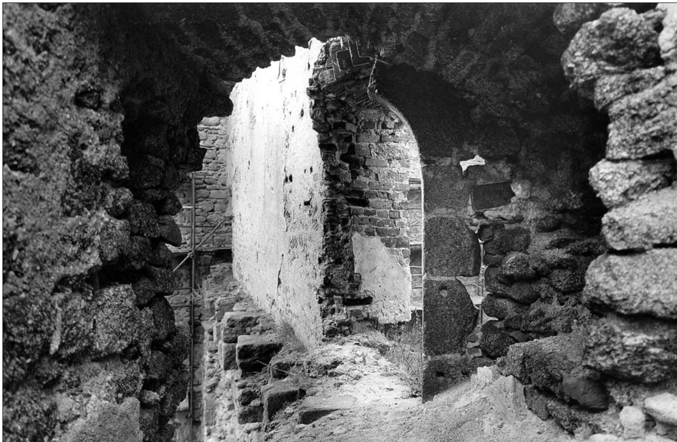
Obr. 37: Landštejn. Druhé patro severní věže, detailní pohled ke vchodu na ochoz paláce. V pozadí dole zbytky krakorců ochozu (srov. obr. 36). Stav před rekonstrukcí, duben 1981, jako obr. 16.
