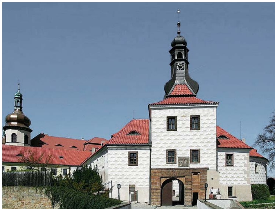
Obr. 9: Kostelec nad Černými lesy, vstupní brána do černokosteleckého zámku a budovy předzámčí (foto R. Šulc, 2010).
