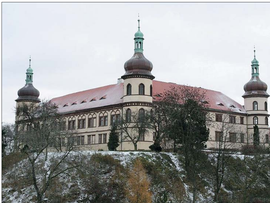
Obr. 10: Kostelec nad Černými lesy, zámek, pohled od severozápadu (foto R. Šulc, 2010).
