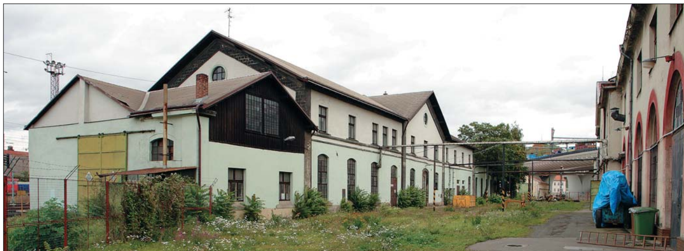
Obr. 47: Celkový pohled na křídlo s lakovnou; vlevo vestavba mezi lakovnou a někdejší západní vozovnou.
