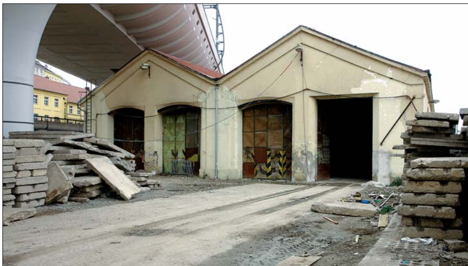
Obr. 63: Lokomotivní remíza – východní průčelí s otvory vjezdů.
