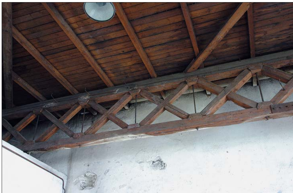
Obr. 19: Budova strojních dílen – vazník z dodatečného zastropení části velké kovářny v západním křídle objektu.
