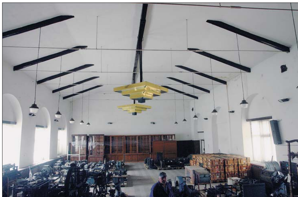
Obr. 28: Přístavba bucharu u budovy strojních dílen – sálový prostor s viditelnou částí krovu.
