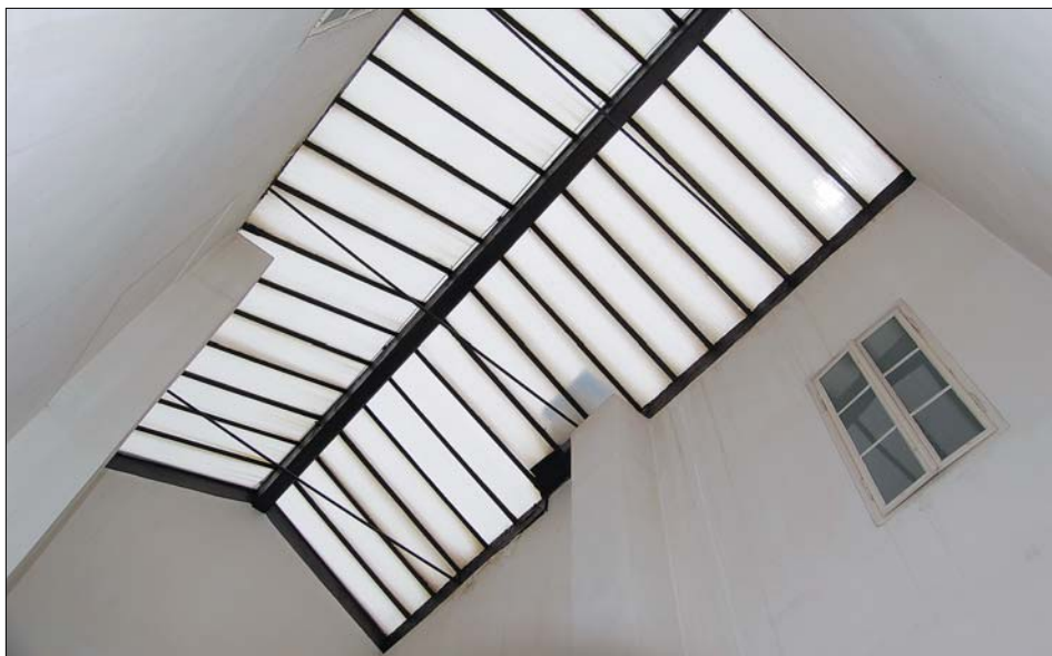
Obr. 40: Severní část přístavby k budově strojních dílen – konstrukce světlíku nad kancelářskou chodbou (foto P. Dostál).
