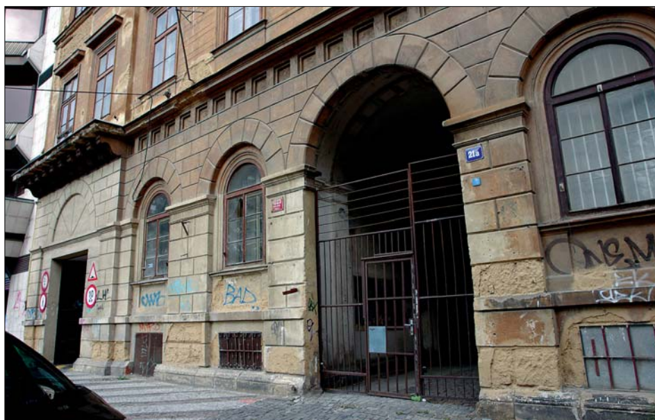
Obr. 30: Detail průčelí Desfourského paláce (čp. 1023/II) v ulici Na Florenci č. 21. Ztvárnění průčelí objektu, který vznikl v těsné blízkosti nádraží bezprostředně po jeho stavbě v letech 1845–47, je téměř identické s řešením průčelí hlavních strojních dílen.
