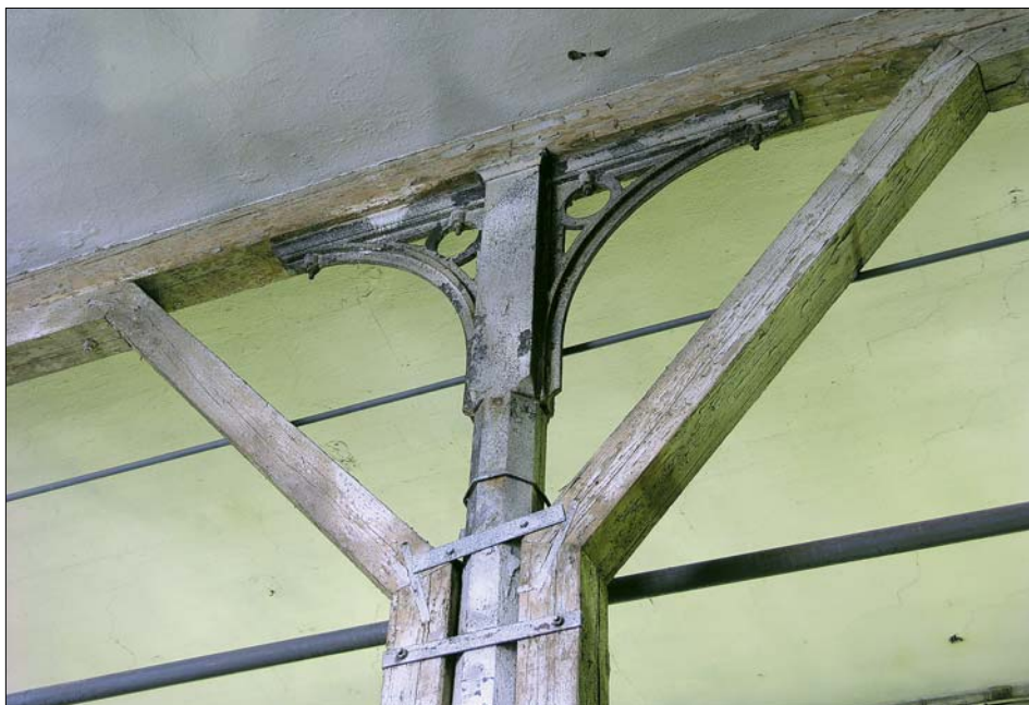
Obr. 50: Přizemí lakovny – detail hlavičky litinového sloupu s konzolami a průvlakem stropu.
