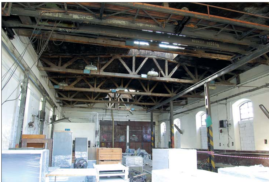
Obr. 61: Prostor východní vozovny – průhled směrem k západu, k lakovně.
