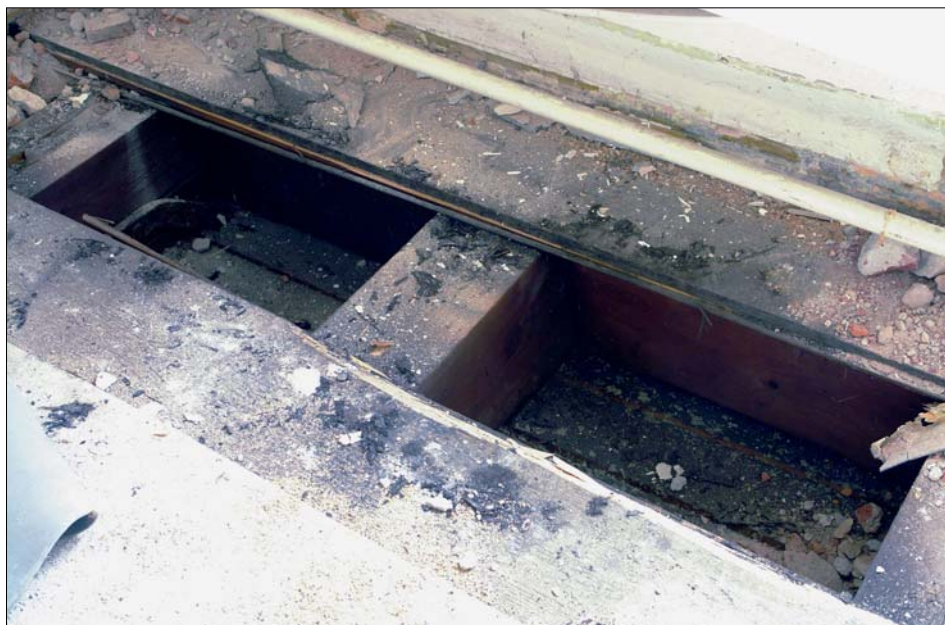
Obr. 51: Pohled shora do konstrukce původně pohledového trámového stropu nad přízemím lakovny.
