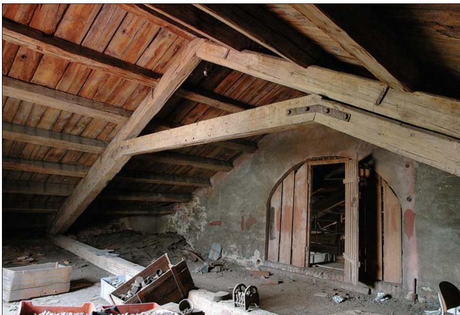
Obr. 27: Budova strojních dílen – vazník v jižním dílu krovu střední části objektu.
