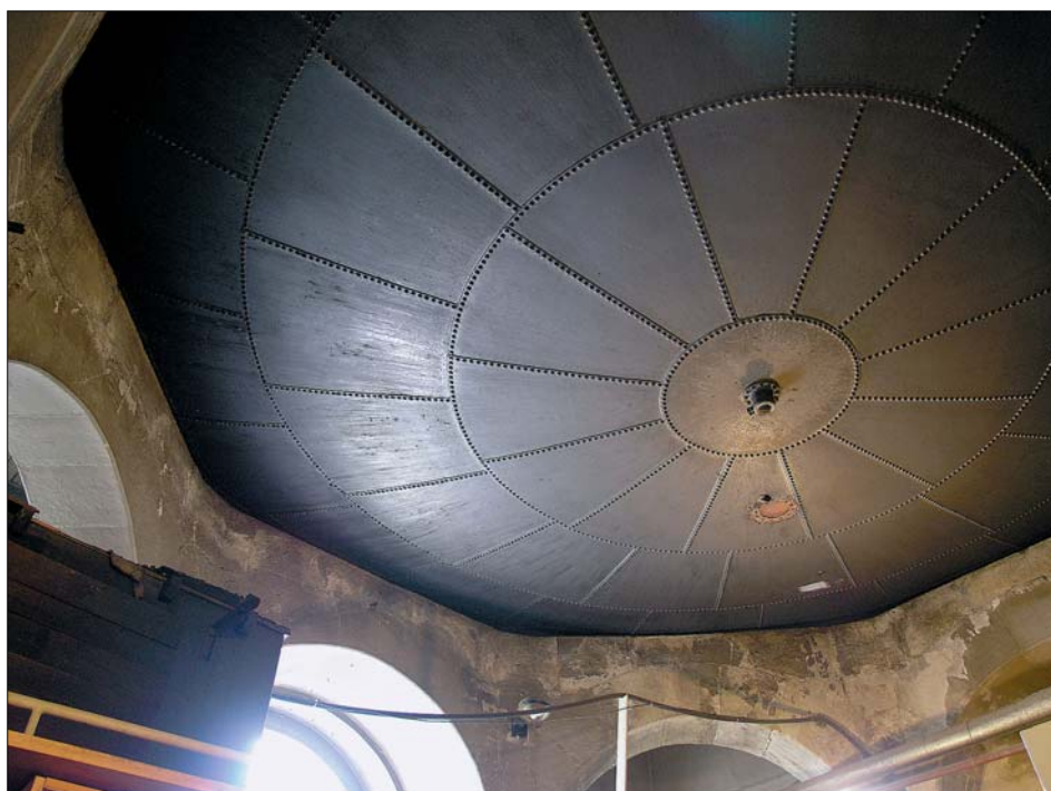
Obr. 10: Budova strojních dílen – dno nádrže někdejšího vodojemu, které tvoří zastropení vstupního prostoru.
