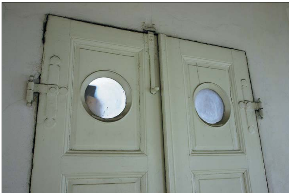
Obr. 42: Jižní část přístavby k budově strojních dílen – původní dveře u schodů na půdu na jižním schodišti.
