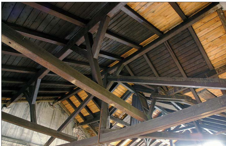
Obr. 58: Západní vestavba u lakovny – severní krov.
