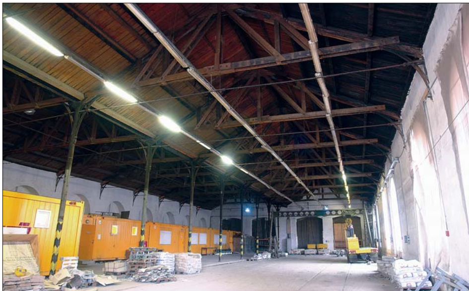
Obr. 64: Lokomotivní remíza – dvoulodní prostor s konstrukcí zastřešení.
