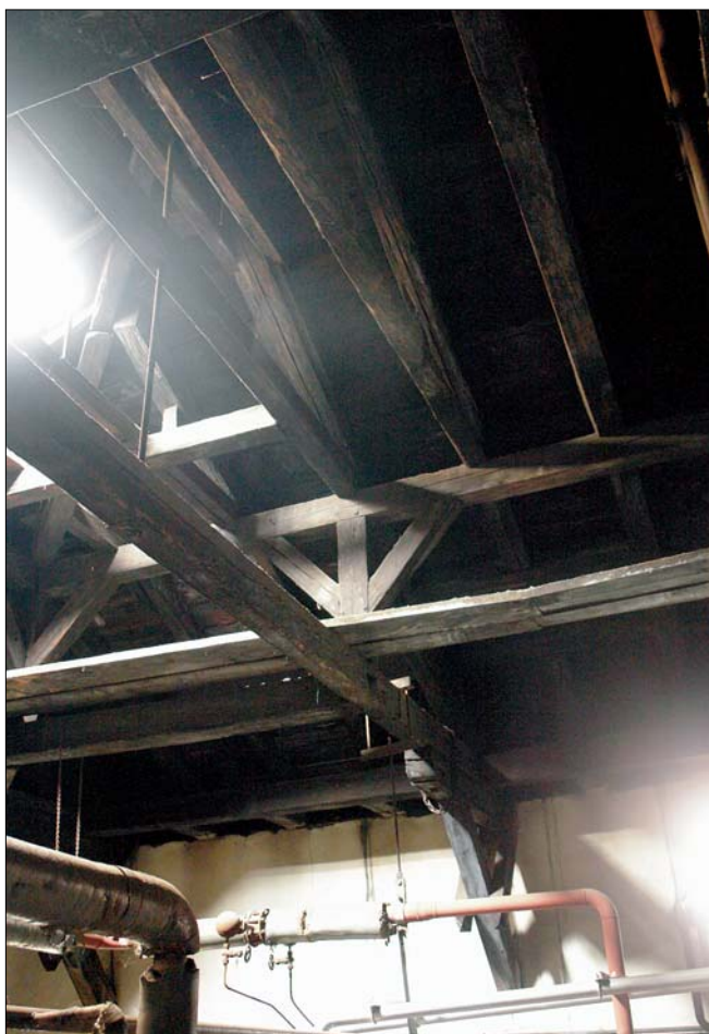
Obr. 12: Budova strojních dílen – podpůrná stolice a ocelové vyvšení vazného trámu krovu nad kotelnou.
