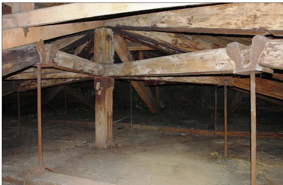
Obr. 23: Budova strojních dílen – krov nad koncovou částí východního křídla objektu.
