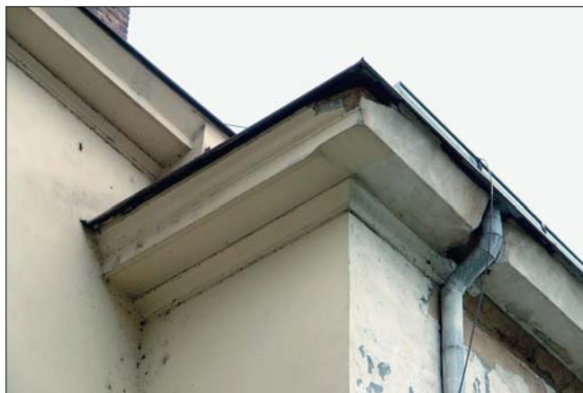
Obr. 34: Dvoudílná západní přístavba k budově strojních dílen – detail s nejlépe zachovanou profilací římsy ve zlomu styku obou částí budovy na východním průčelí.
