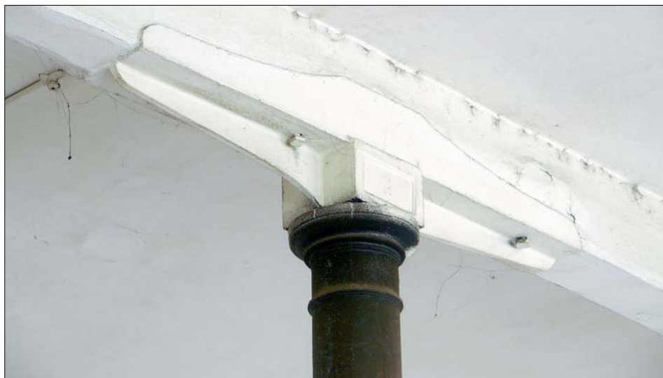
Obr. 20: Budova strojních dílen – horní část litinového sloupu se sedlem a omítnutým dřevěným průvlakem v zastropění halového prostoru v koncové západní části objektu.
