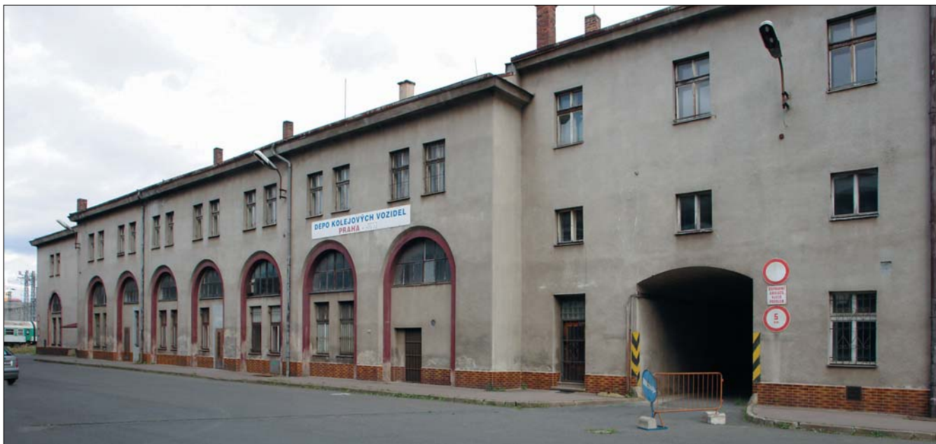
Obr. 33: Dvoulodná západní přístavba k budově strojních dílen – pohled od jihozápadu na hlavní západní průčelí.
