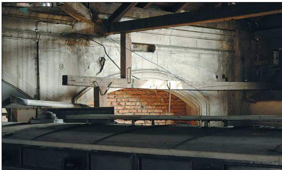
Obr. 57: Západní vestavba u lakovny – zachované kamenné ostění vjezdu do západní stěny lakovny.
