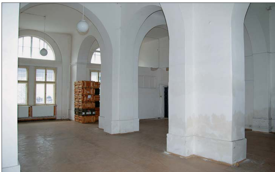
Obr. 35: Severní část přístavby k budově strojních dílen – pilíře a pasy trojlodního řešení halového prostoru v přízemí (foto P. Dostál).
