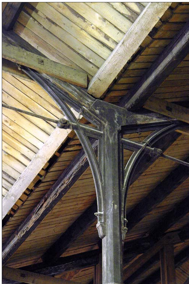
Obr. 65: Lokomotivní remíza – hlavice litinového sloupu pod úžlabím střeš.
