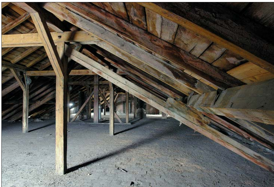
Obr. 55: Krov lakovny – konstrukce nad křídlem.
