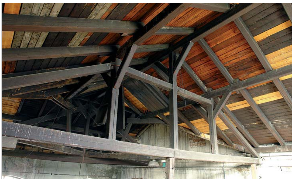
Obr. 59: Západní vestavba u lakovny – jižní krov.
