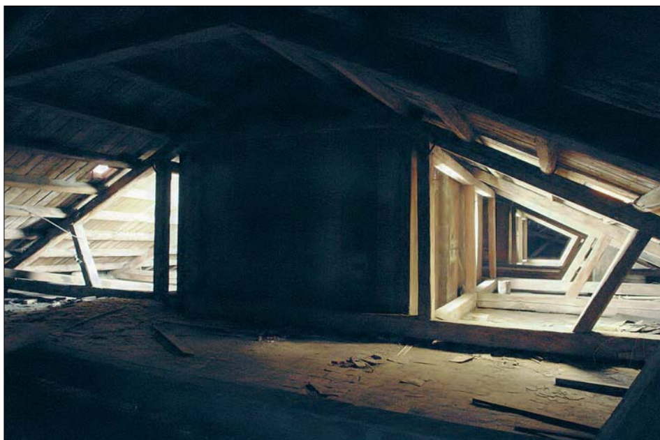
Obr. 39: Severní část přístavby k budově strojních dělen – krov se světlíky.
