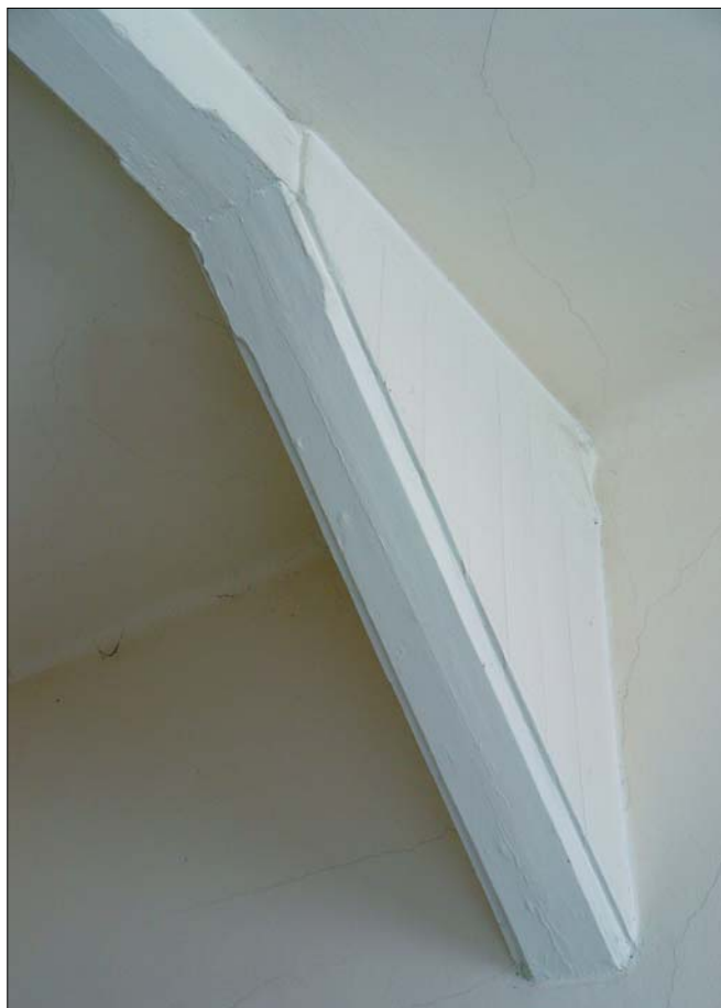
Obr. 52: Lakovna – detail trámové konstrukce z trojlodního členění prostoru patra.
