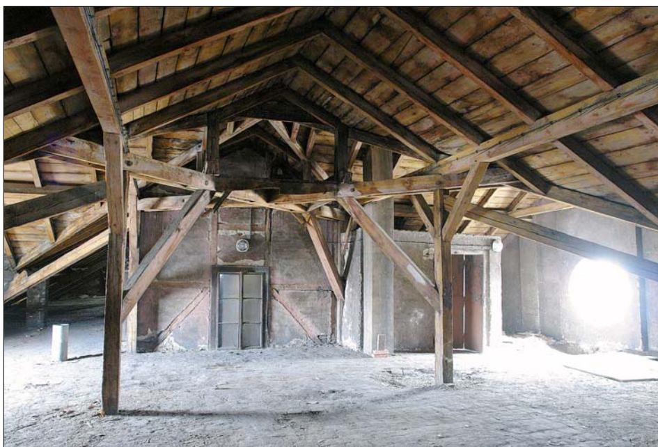
Obr. 56: Krov lakovny – konstrukce nad střední částí budovy se světlíkem a dveřmi u schodiště.
