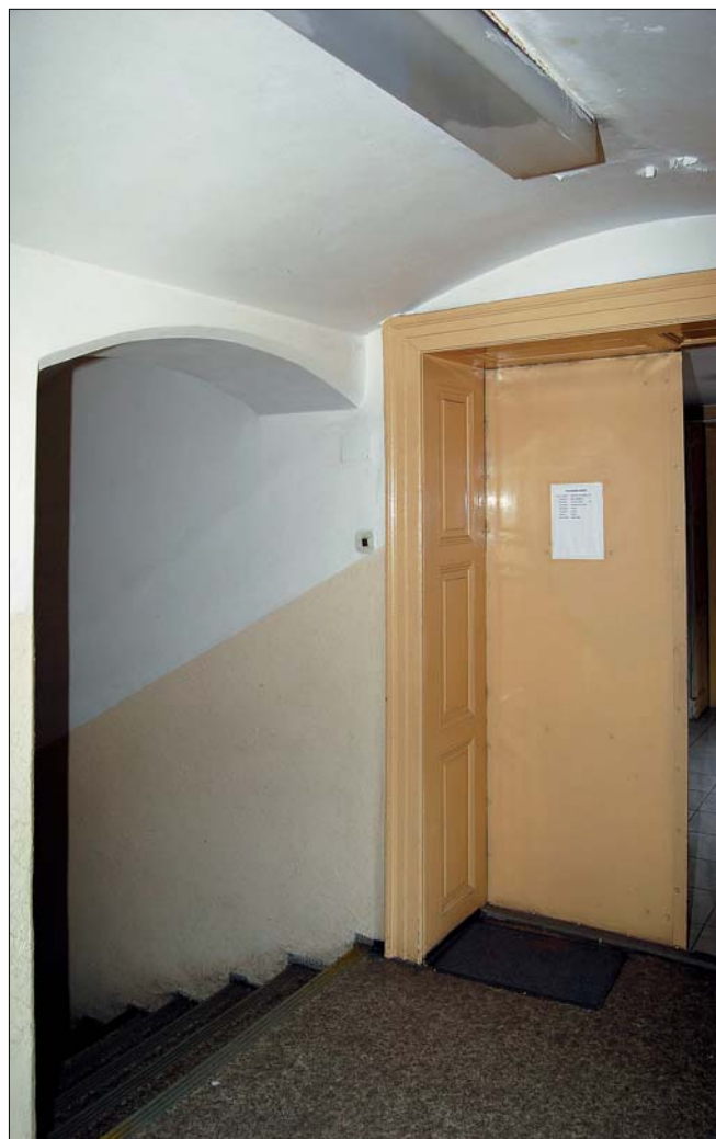
Obr. 41: Jižní část přístavby k budově strojních dílen – původní dveře u schodů v mezipatře (foto P. Dostál).
