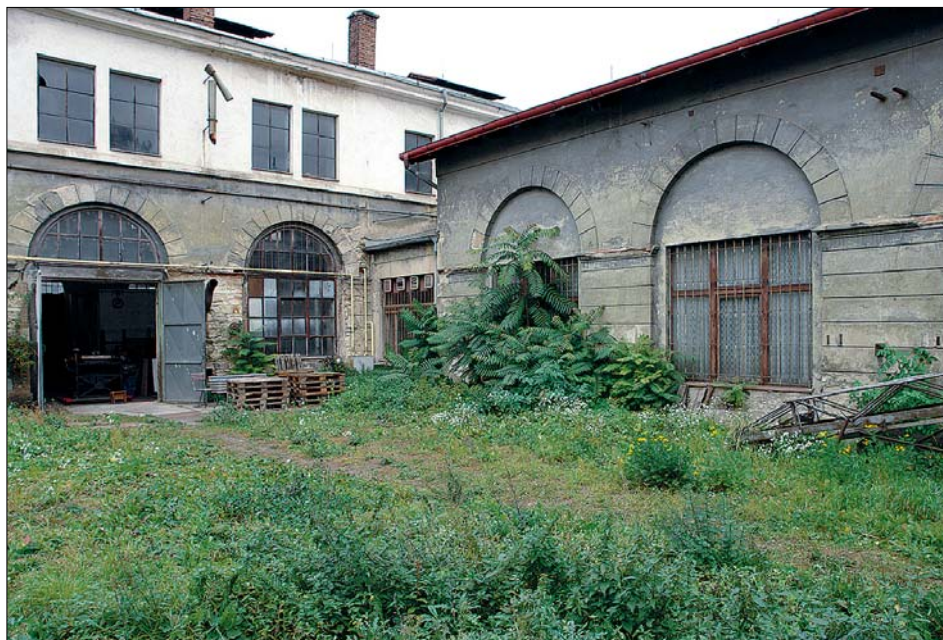
Obr. 9: Budova strojních dílen – část jižního průčelí (vlevo) a přístavba haly někdejšího bucharu.
