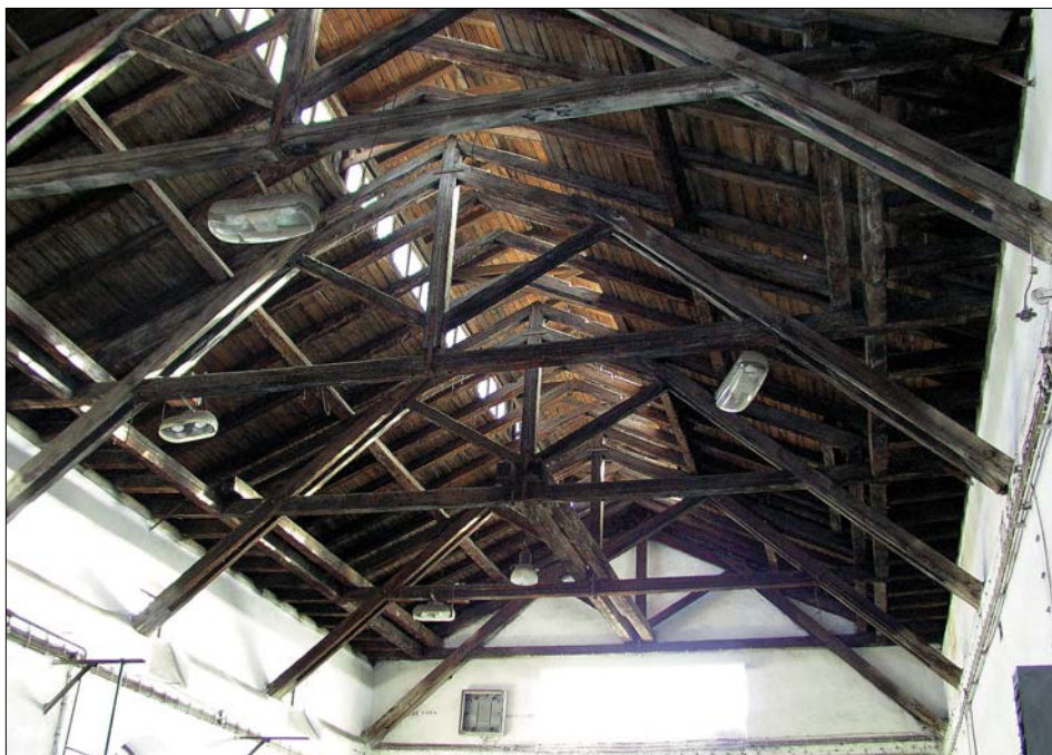
Obr. 68: Zbořená východní lokomotivní remíza – krov nad užší severní částí budovy (stav v roce 2003).
