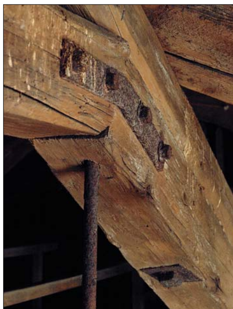
Obr. 26: Budova strojních dílen – detail ocelové výbavy vazníku v krovu nad střední částí objektu.
