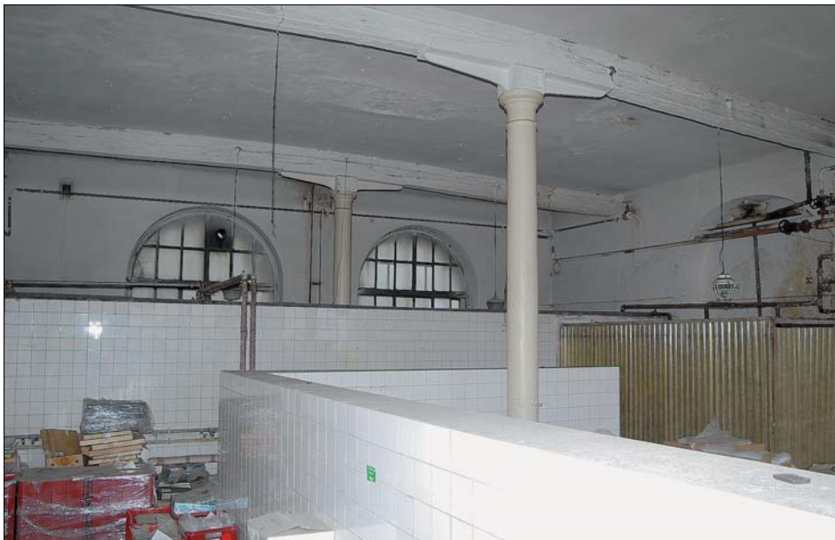
Obr. 17: Východní část budovy strojních dílen – dvoulodní hala s novodobou vestavbou (foto P. Dostál).
