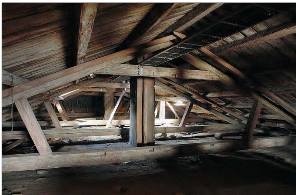
Obr. 43: Jižní část přístavby k budově strojních dílen – prostor vazníkového krovu.
