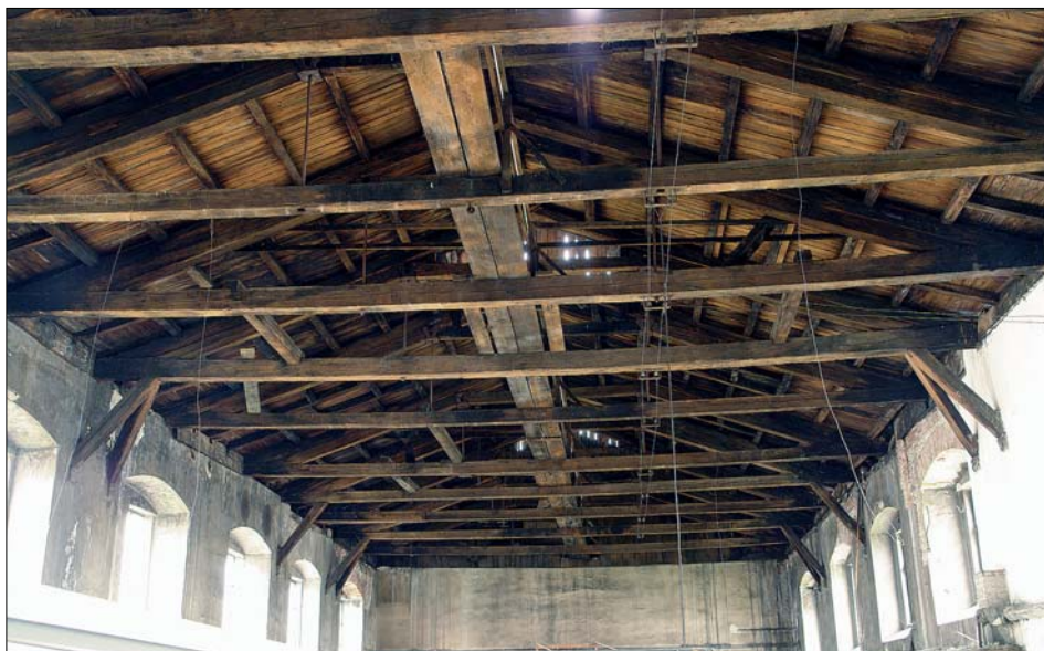
Obr. 24: Budova strojních dílen – krov nad západním křídlem objektu.
