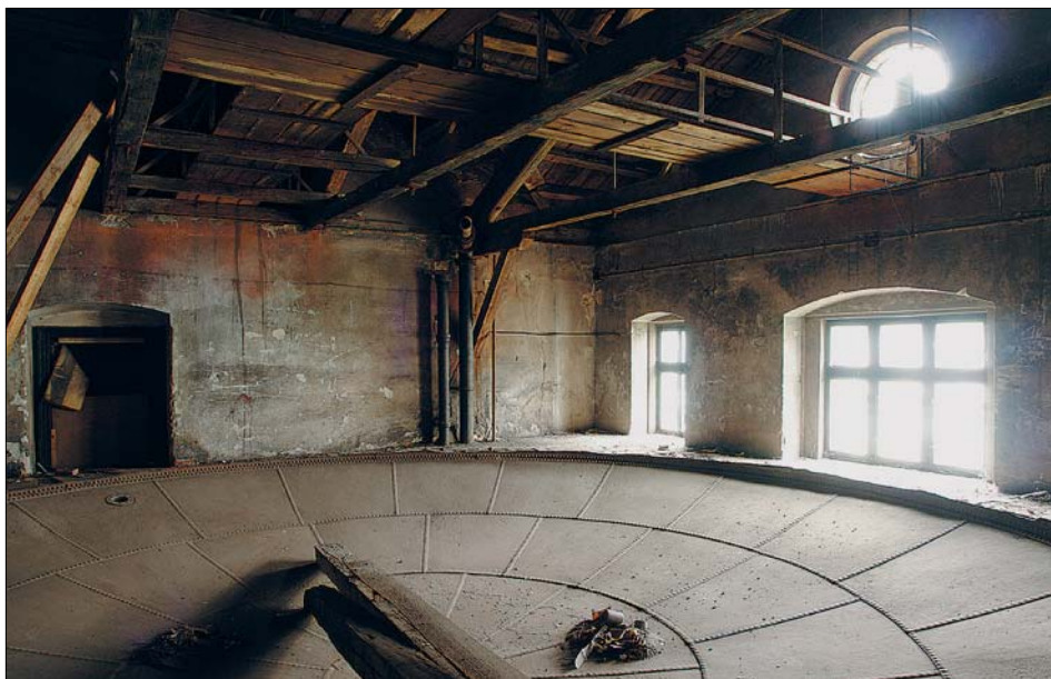
Obr. 11: Budova strojních dílen – dno někdejší vodní nádrže v patře nad vstupní halou.
