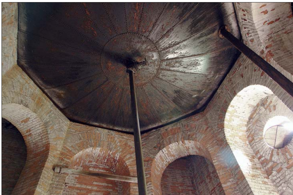
Obr. 32: Arkádové podpory a dno vodní nádrže ve vodojemu nádražního areálu v Praze - Bubnech.
