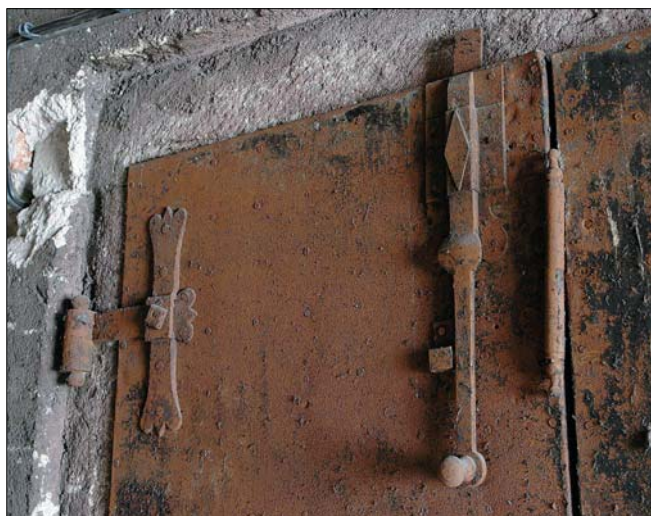
Obr. 53: Lakovna – detail kování a oplechování dveří ve vstupu do krovu.
