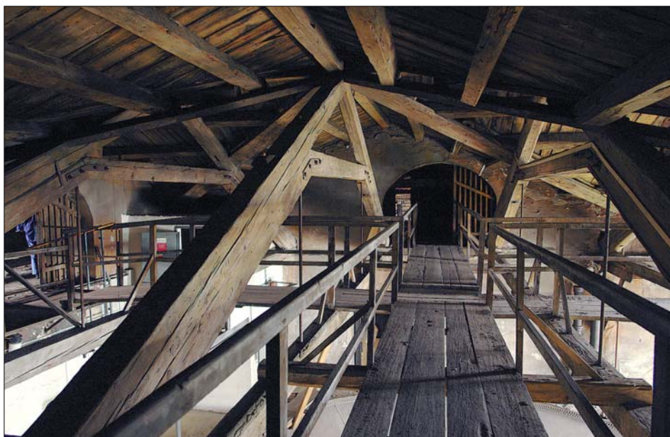
Obr. 25: Budova strojních dílen – krov nad někdejší vodojemem ve střední části objektu.
