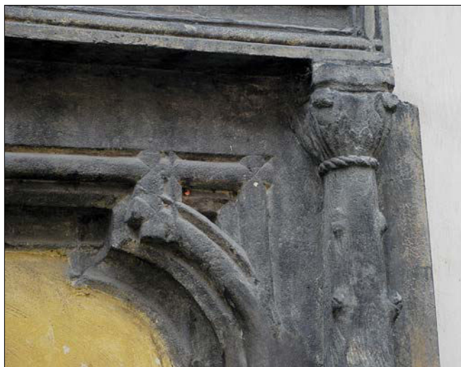
Obr. 8: Česká Lípa, augustiniánský klášter, severní zeď ambitu lorety, portál z roku 1549. Detail křížení profilace sedlového portálu a vrcholu dřívku sloupu s hlavicí západní poloviny portálu.
