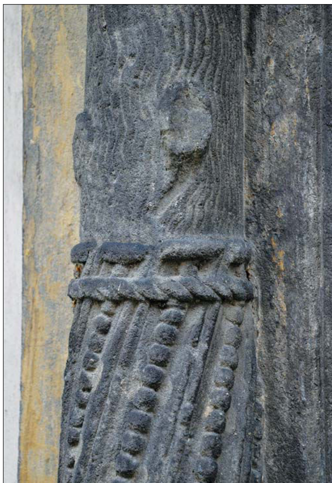
Obr. 9: Česká Lípa, augustiniánský klášter, severní zeď ambitu lorety, portál z roku 1549. Detail zdobení dřívku východního sloupu stáčením perlovcem, převázáním provazcem a motivem astwerku.
