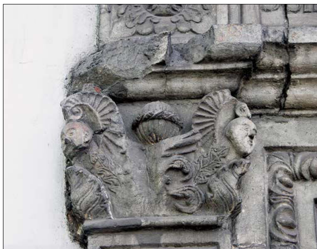
Obr. 43: Chojnów (voj. Dolnoslezské, Polsko), nárožní dům na hlavním náměstí. Detail hlavice pilastru s nárožními hlavičkami velké renesanční okenní edikuly (foto M. Panáček, 2007).
