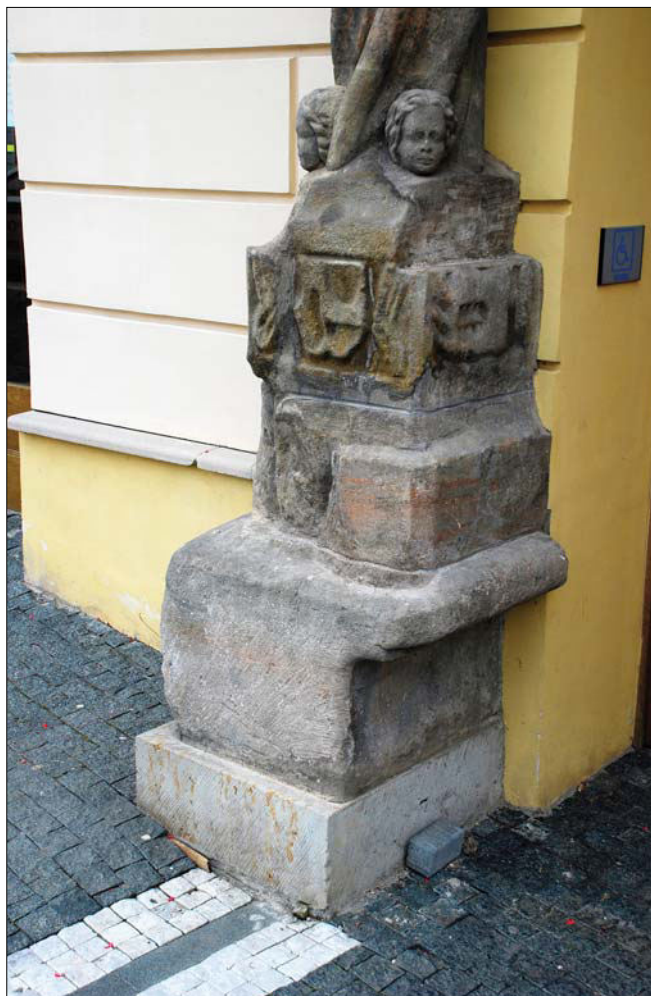
Obr. 20: Česká Lípa, dům čp. 2, portál z roku 1555. Pohled na postament a patku severního sloupu.
