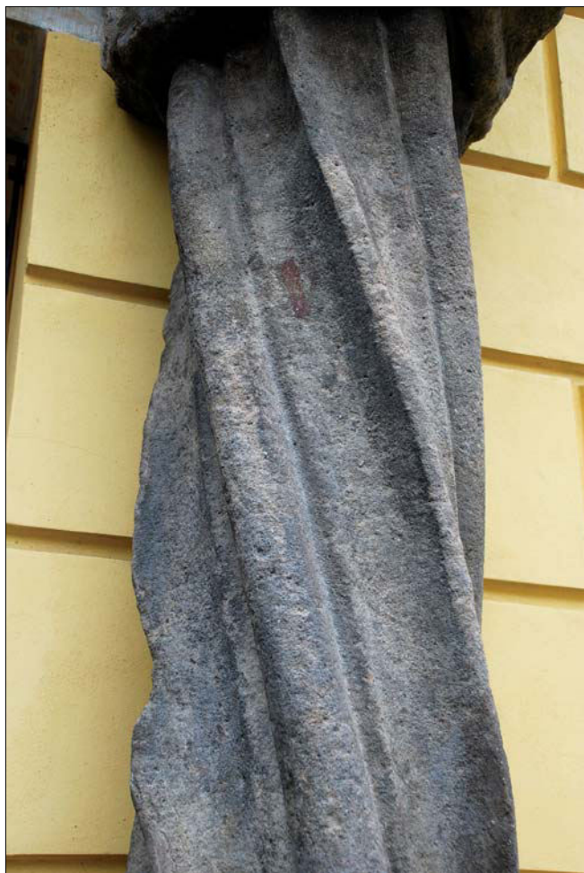
Obr. 23: Česká Lípa, dům čp. 2, portál z roku 1555. Skladba profilace torzovaného dřívku jižního sloupu z velkých výžlabků a výrazných oblých prutů podložených páskou.
