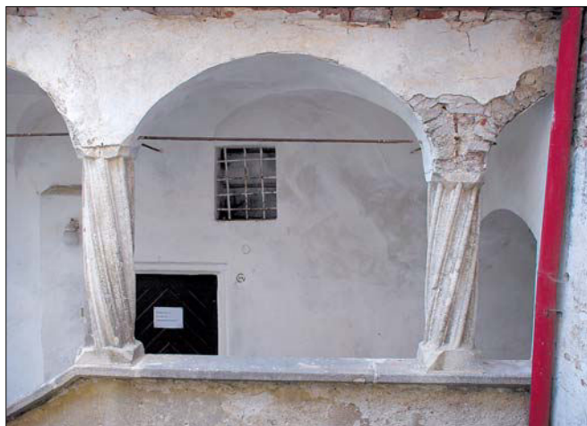
Obr. 40: Police (okr. Třebíč), zámek, schodišťová lodžie západního křídla. Detail tordovaných sloupků nesoucích klenbu a zastřešení lodžie (foto M. Panáček, 2009).
